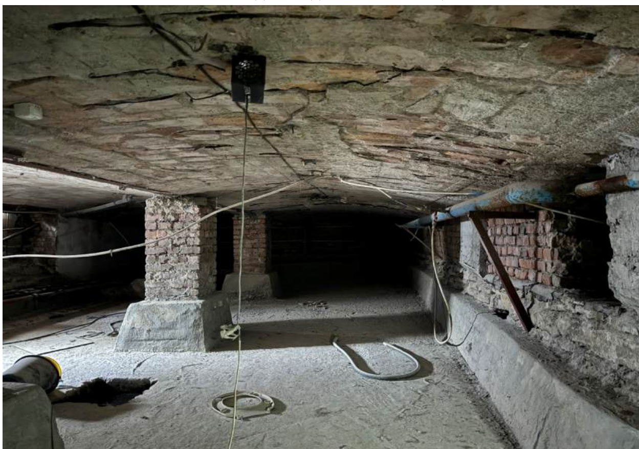
Фото 62. Вид на подвальные помещения.
