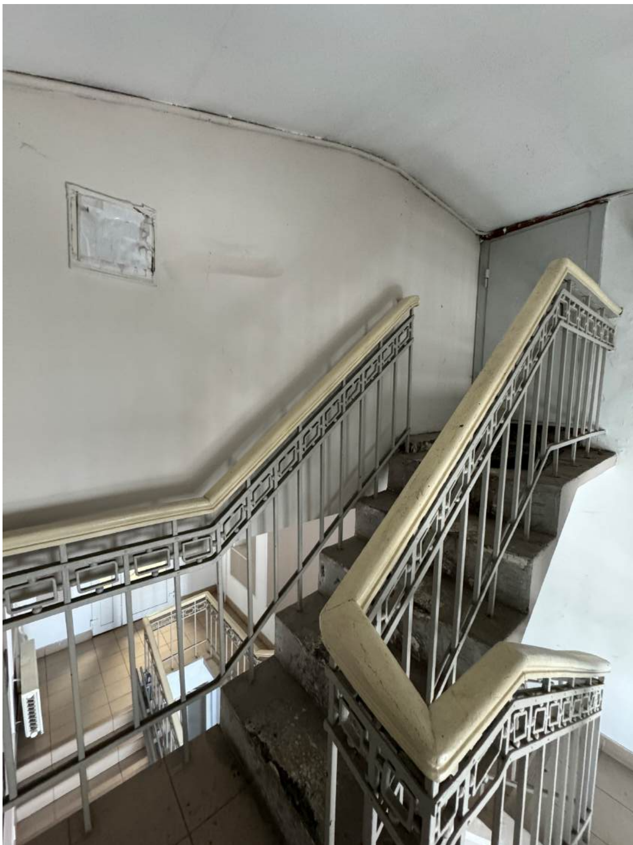
Фото 92. Вид на интерьер лестницы 5-ЛК.
