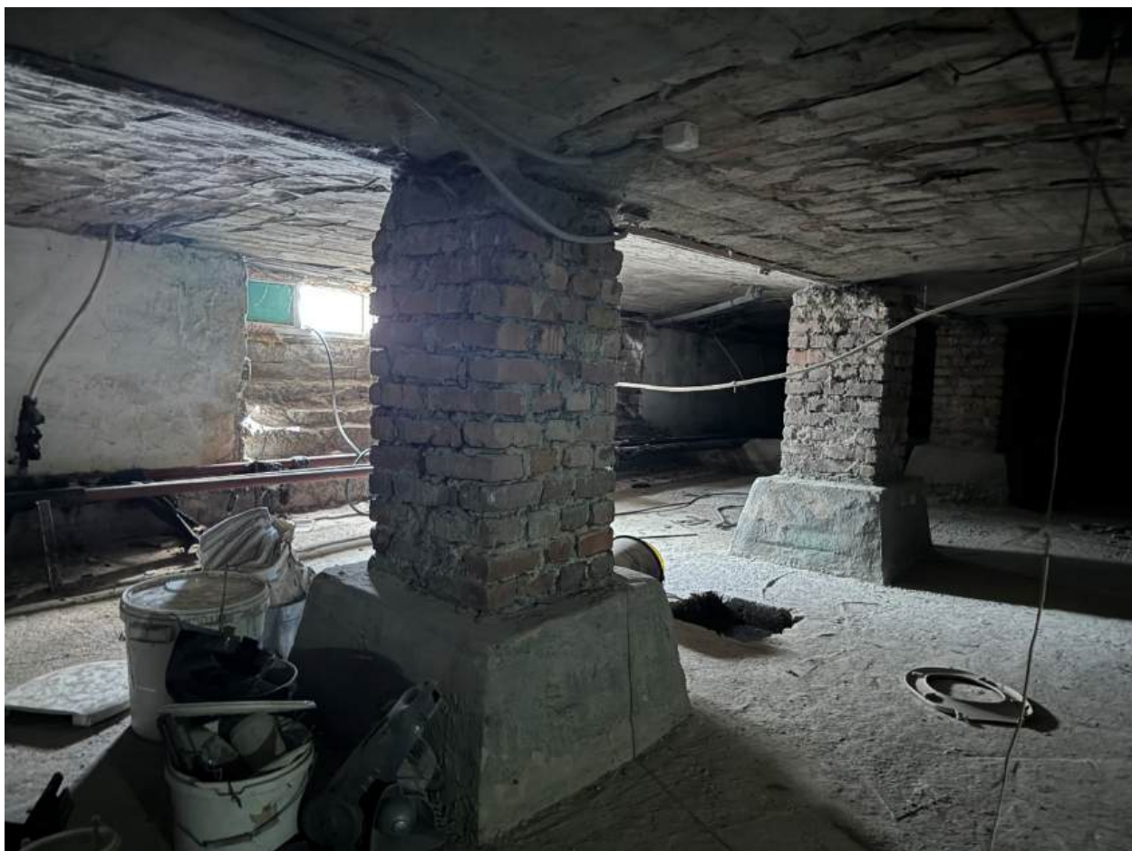
Фото 61. Вид на подвальные помещения.
