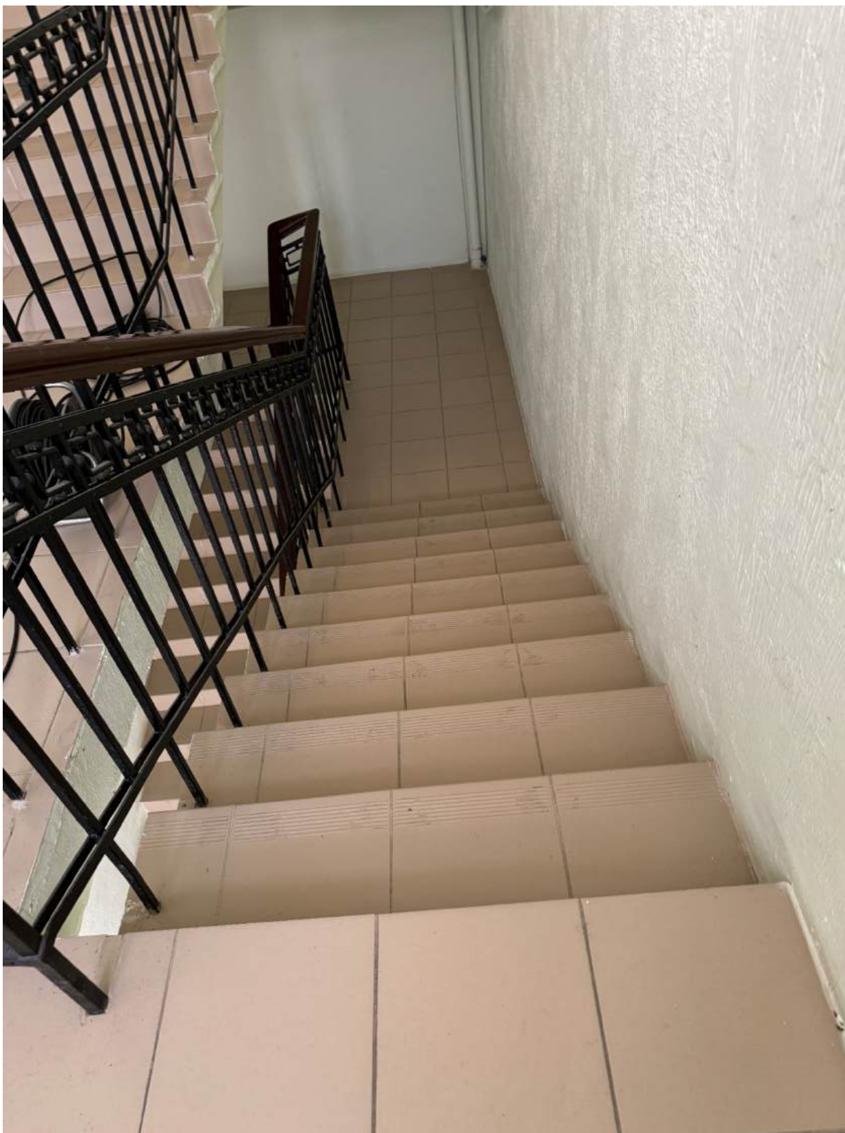
Фото 32. Вид на интерьер лестницы 2-ЛК.
