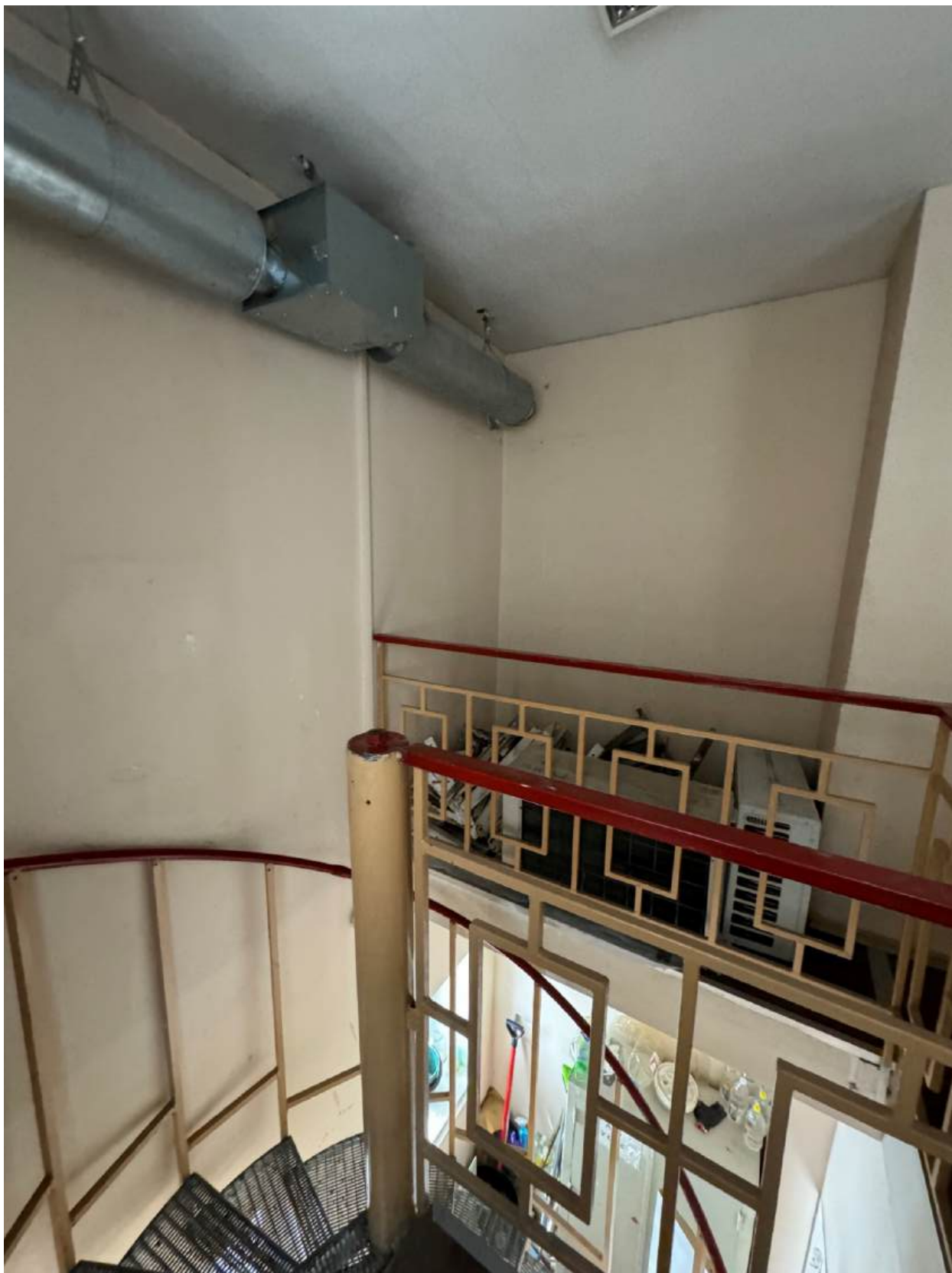
Фото 128. Интерьер и вид на винтовую лестницу помещения.
