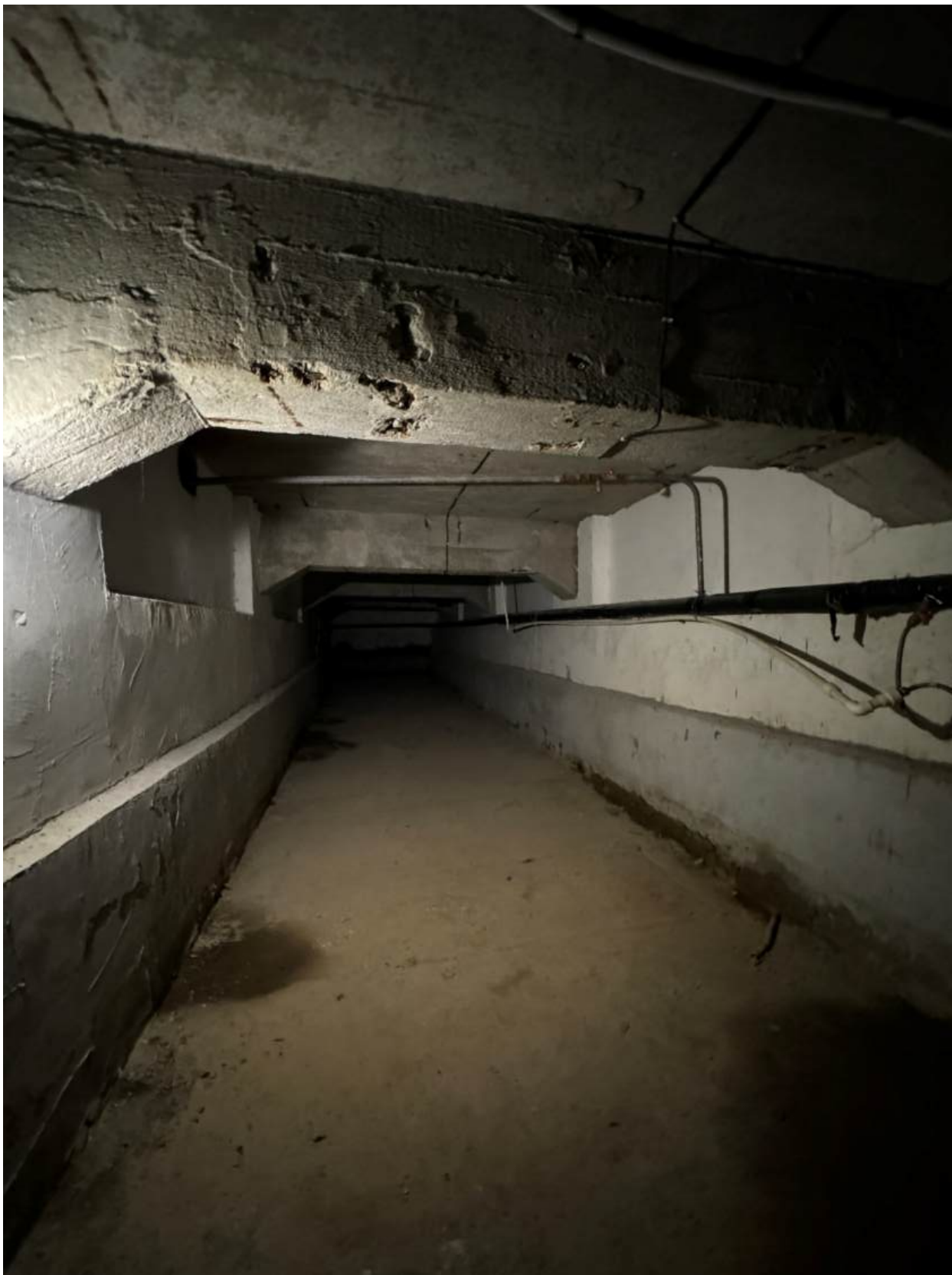
Фото 51. Вид на подвальные помещения.
