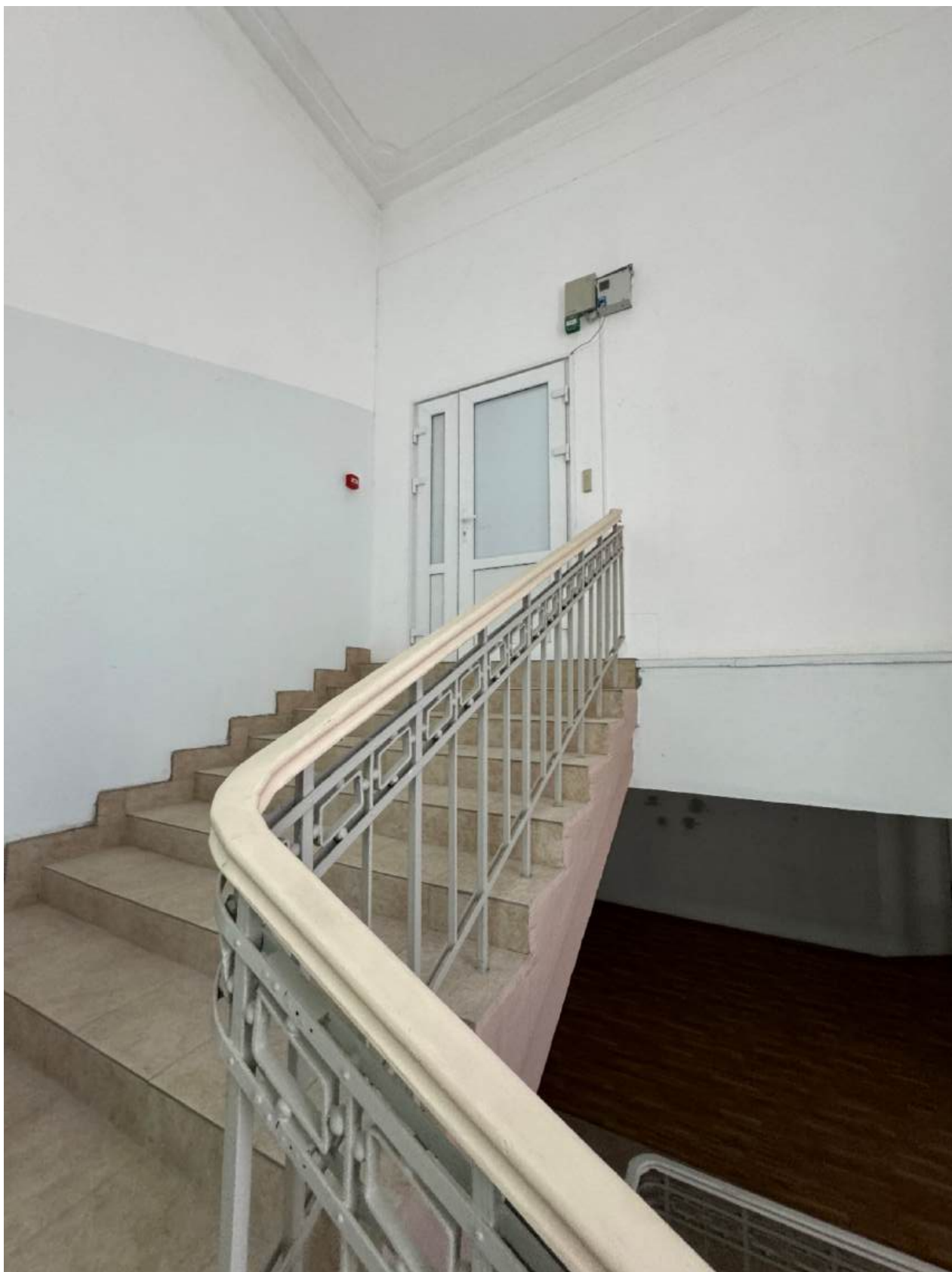
Фото 110. Вид на интерьер лестницы 3-ЛК.
