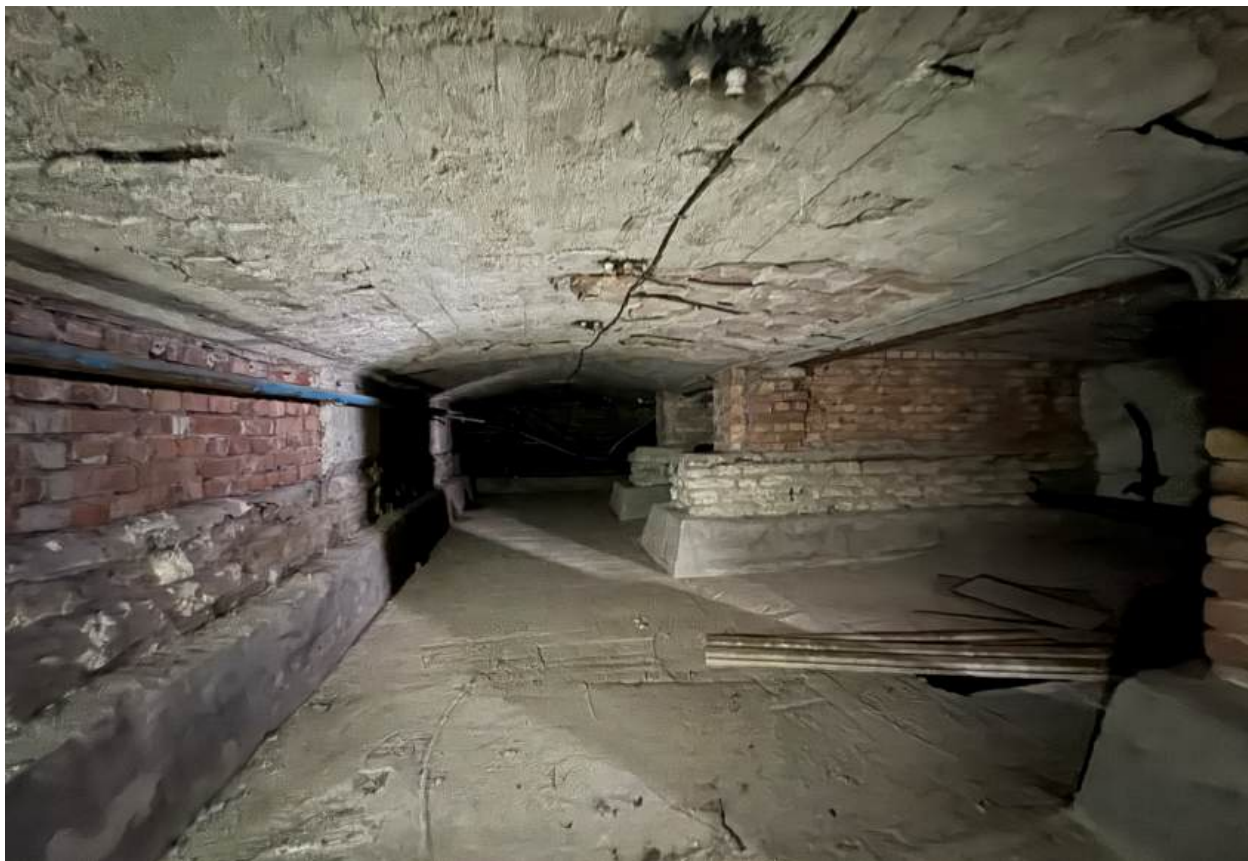
Фото 63. Вид на подвальные помещения.
