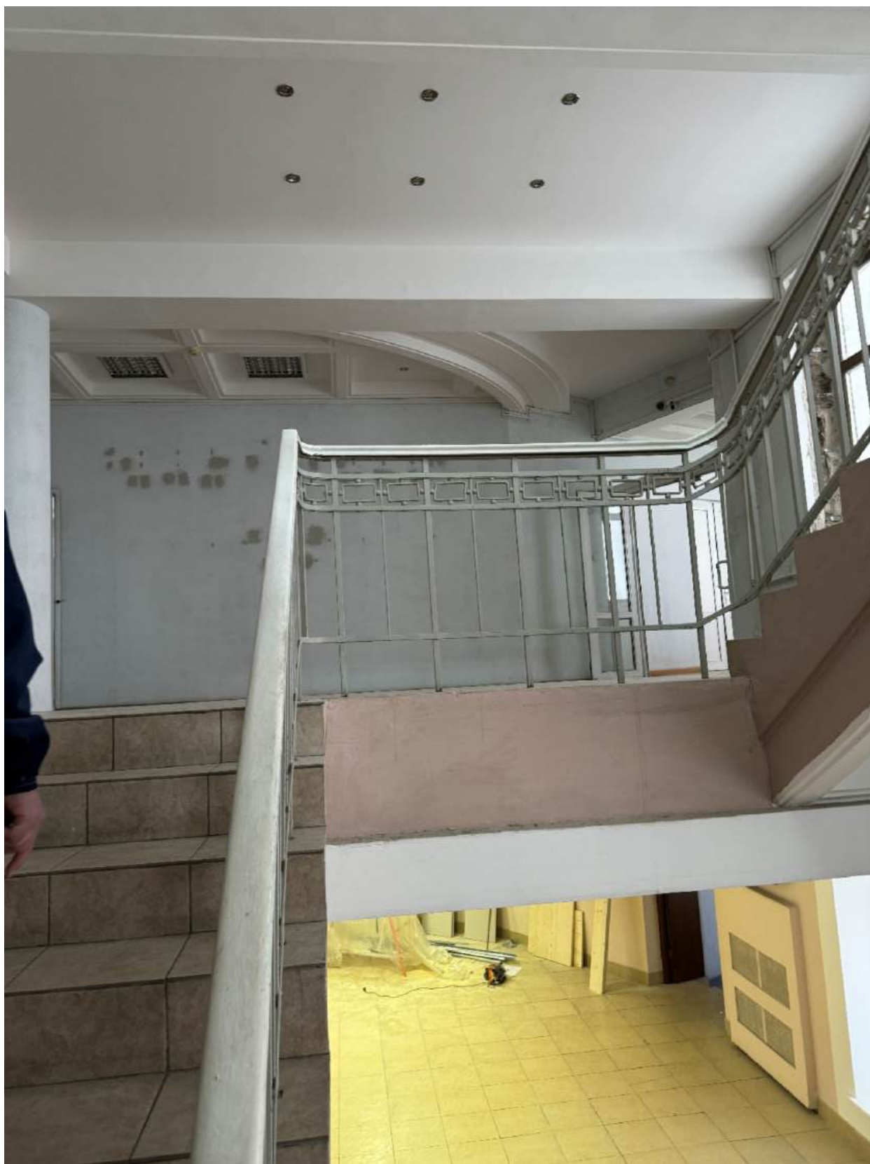
Фото 106. Вид на интерьер лестницы 3-ЛК.
