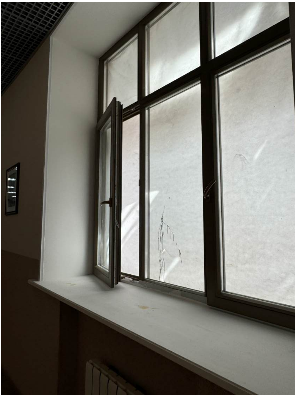
Фото 14. Вид на оконное заполнение.
