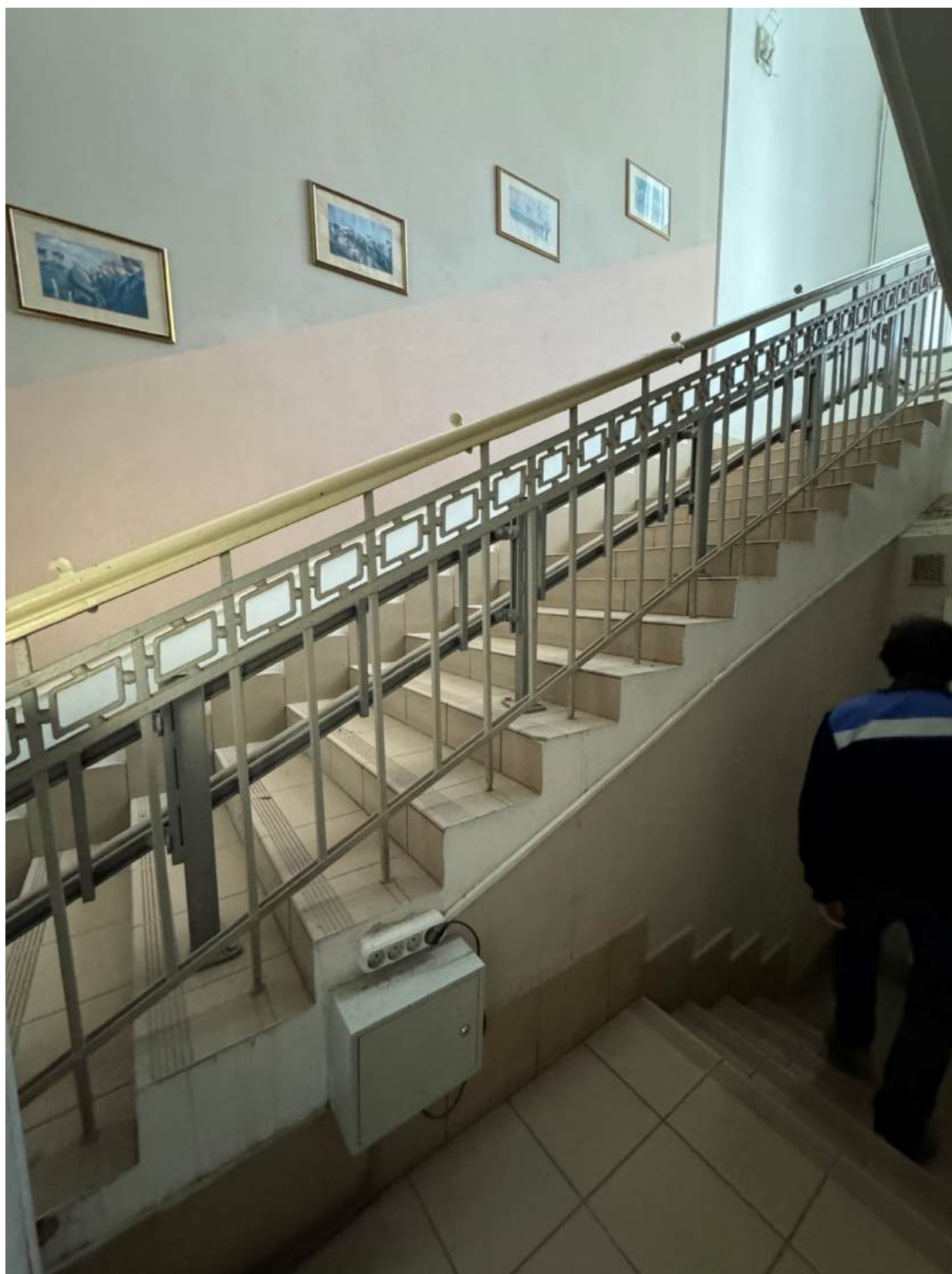
Фото 53. Вид на интерьер лестницы 5-ЛК.
