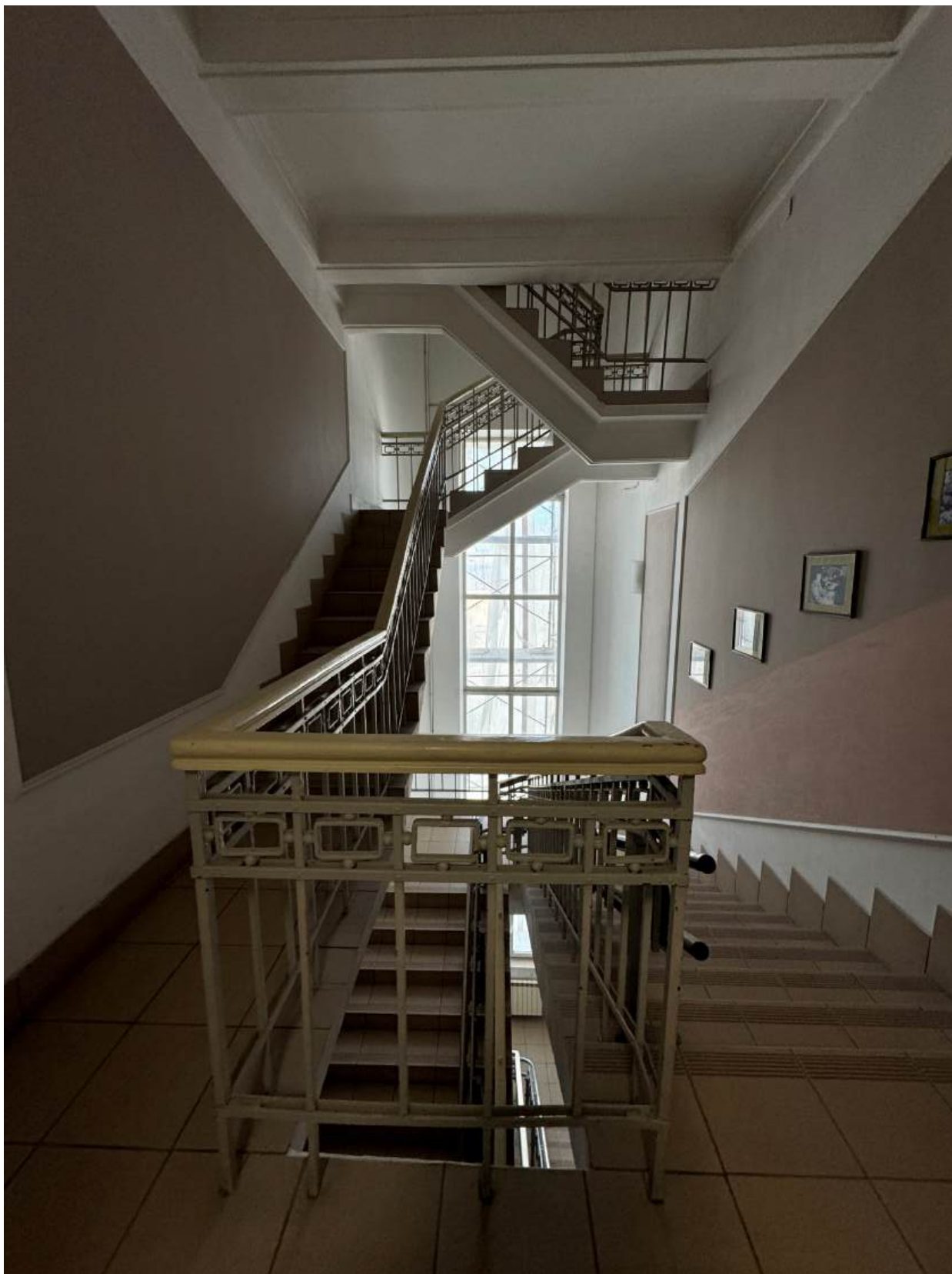
Фото 91. Вид на интерьер лестницы 5-ЛК.
