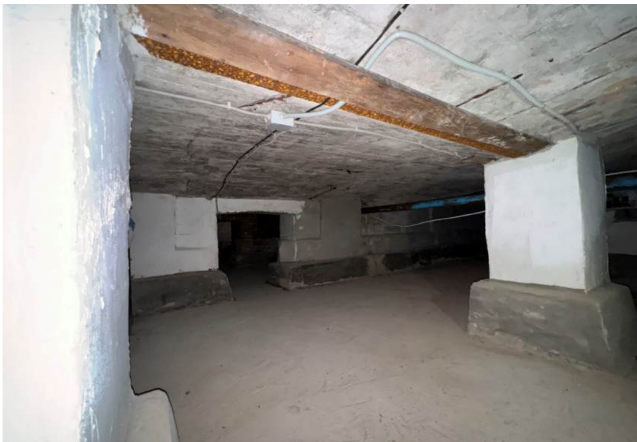
Фото 59. Вид на подвальные помещения.
