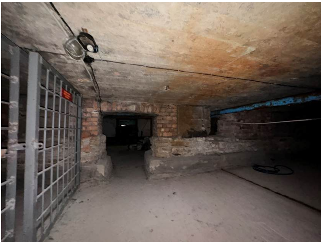
Фото 60. Вид на подвальные помещения.
