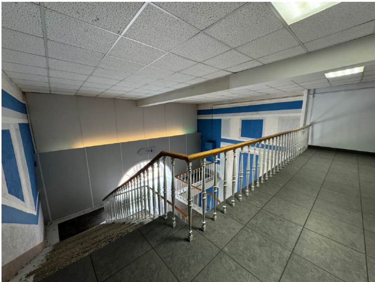
Фото 11. Вид на парадную лестницу объекта культурного наследия.
