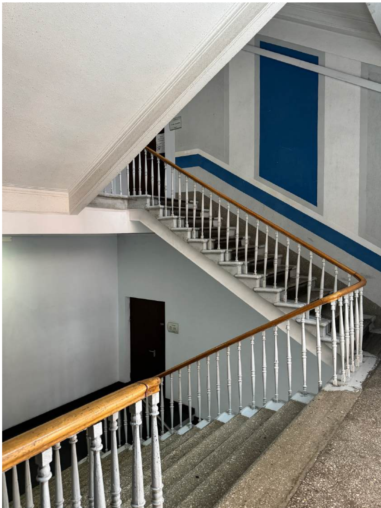
Фото 67. Вид на парадную лестницу объекта культурного наследия.
