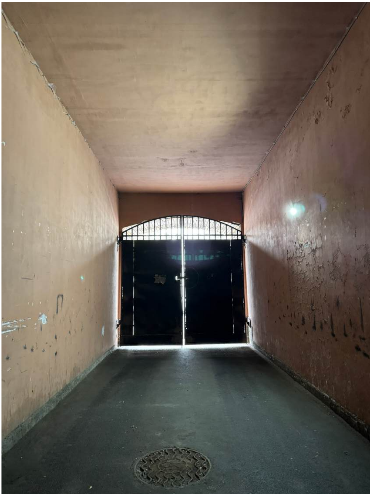
Фото 7. Вид на арку проезда объекта культурного наследия.
