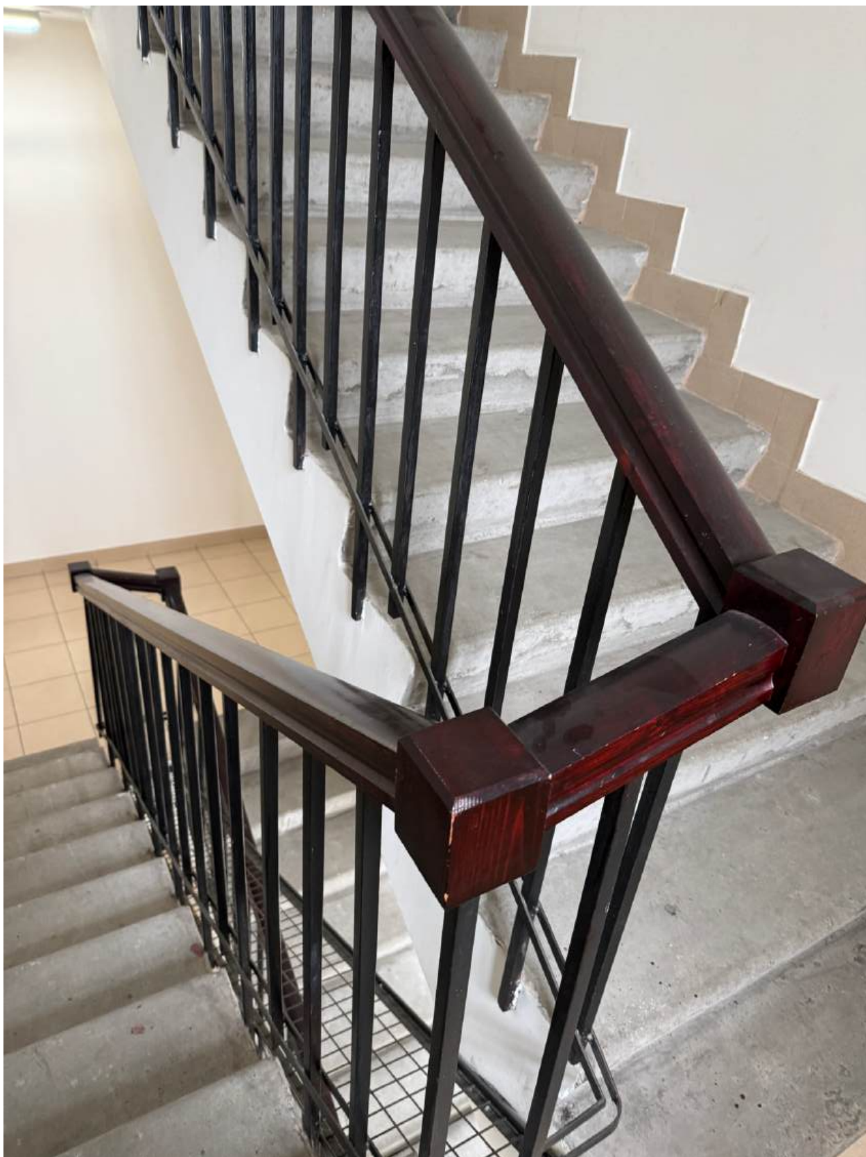
Фото 31. Вид на интерьер лестницы 2ЛК объекта культурного наследия.
