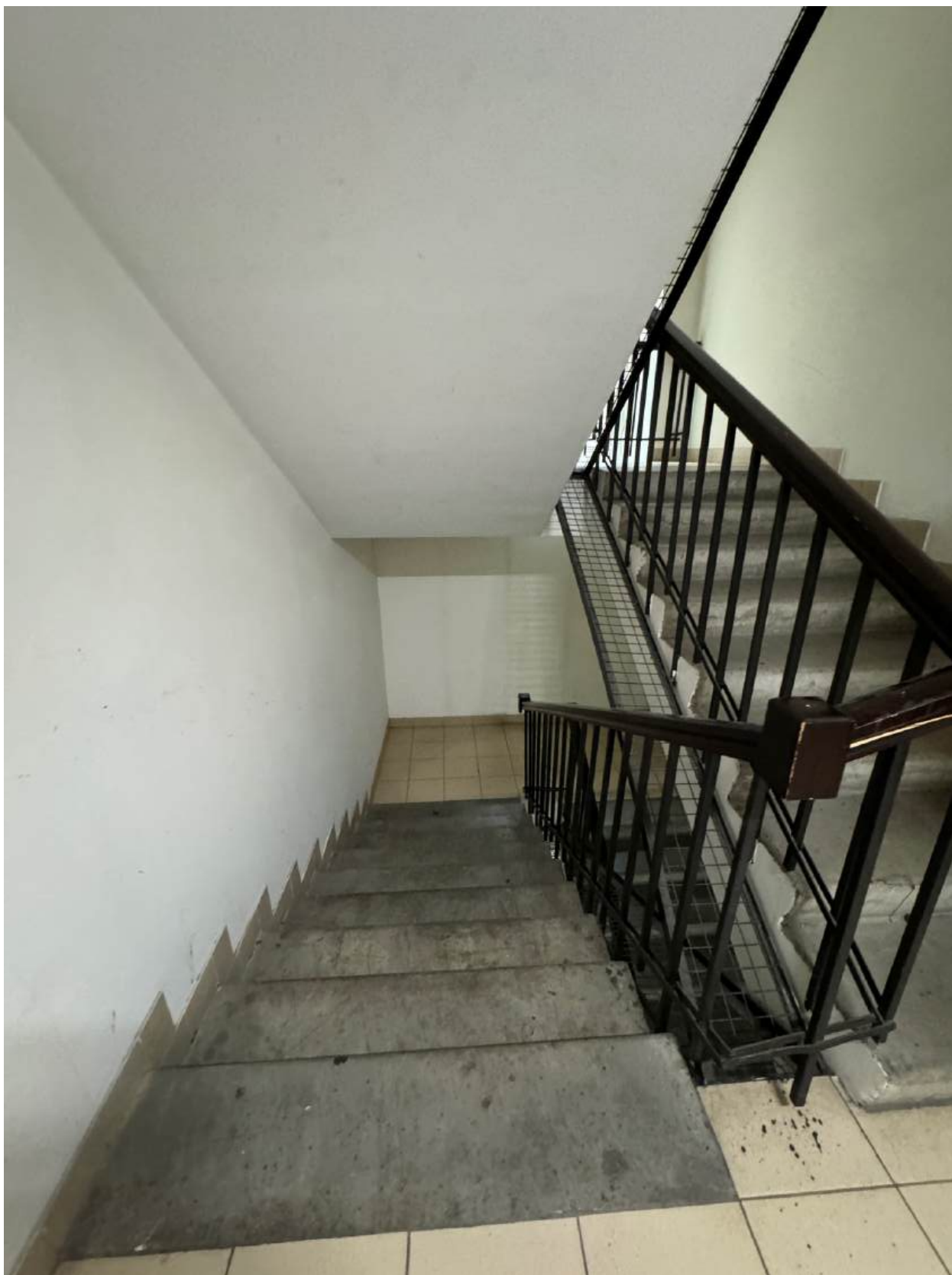
Фото 41. Вид на интерьер лестницы 2ЛК объекта культурного наследия.
