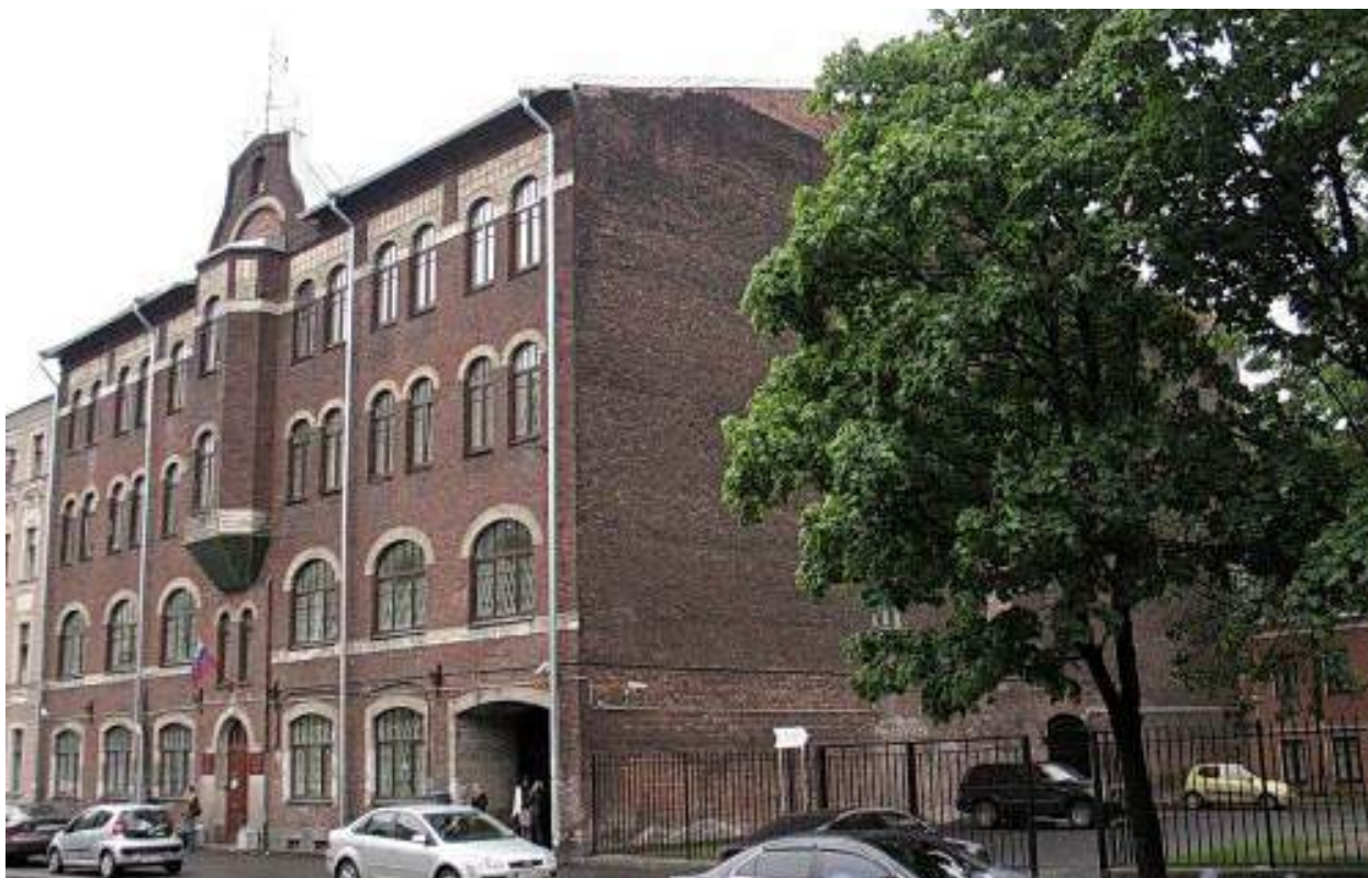
46. Бобруйская ул., д. 4. Фрагмент фасада здания. 2010 г. [Электронный ресурс] URL: https://photo.gradpetra.net/views/13510.html
