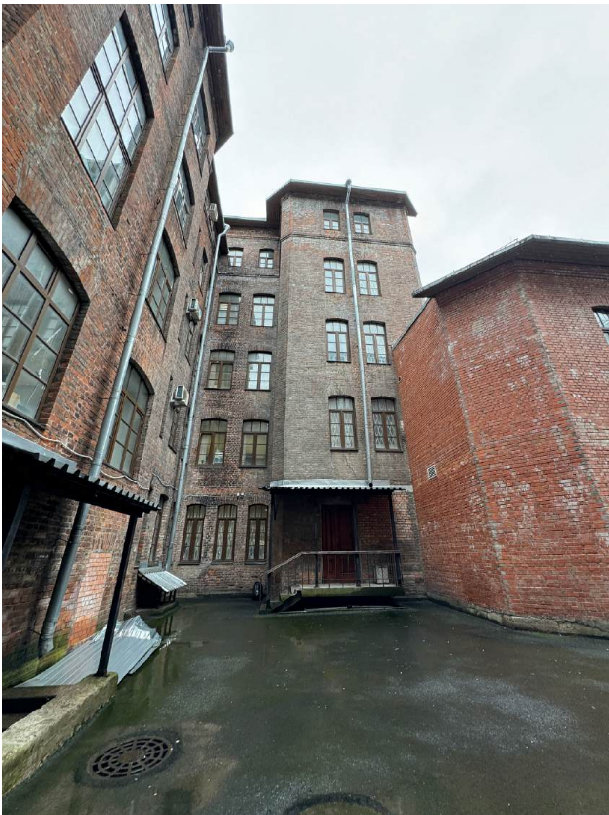
Фото 10. Общий вид дворовых фасадов объекта культурного наследия.
