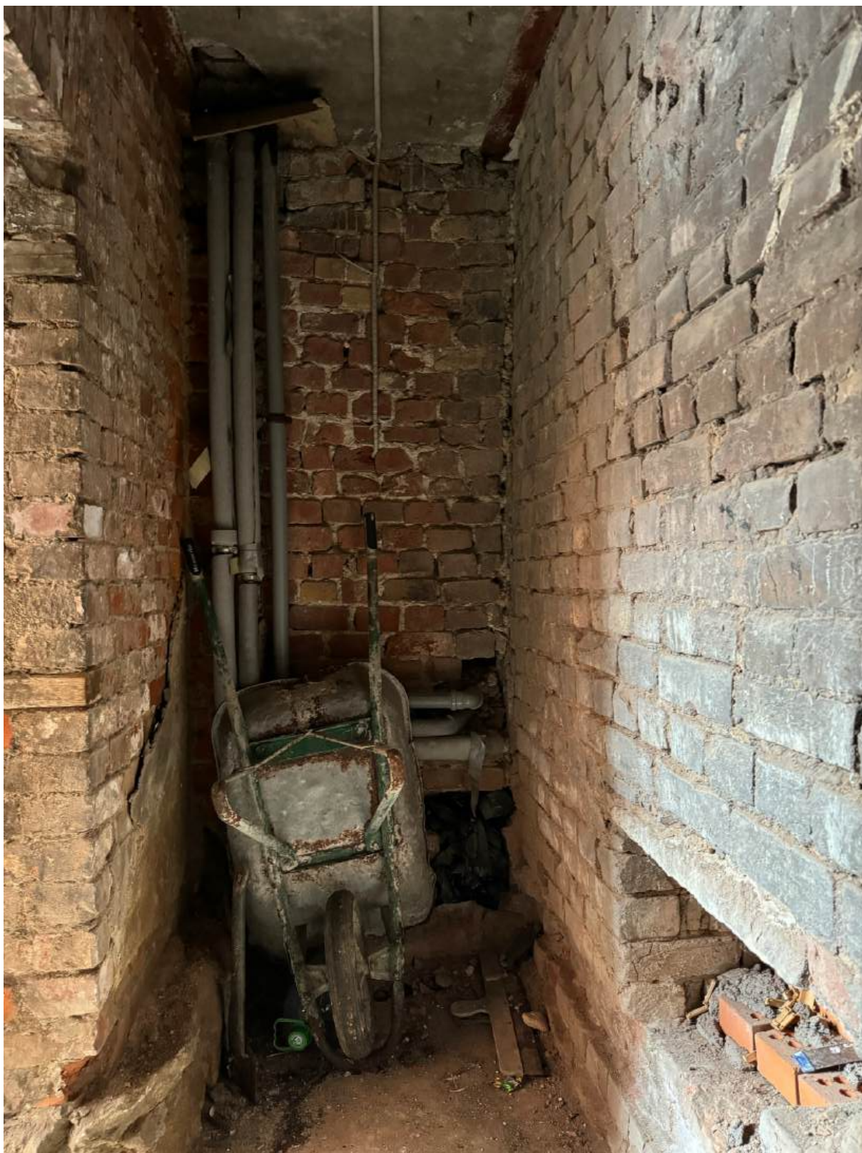
Фото 19. Вид на подвальное помещение объекта культурного наследия.
