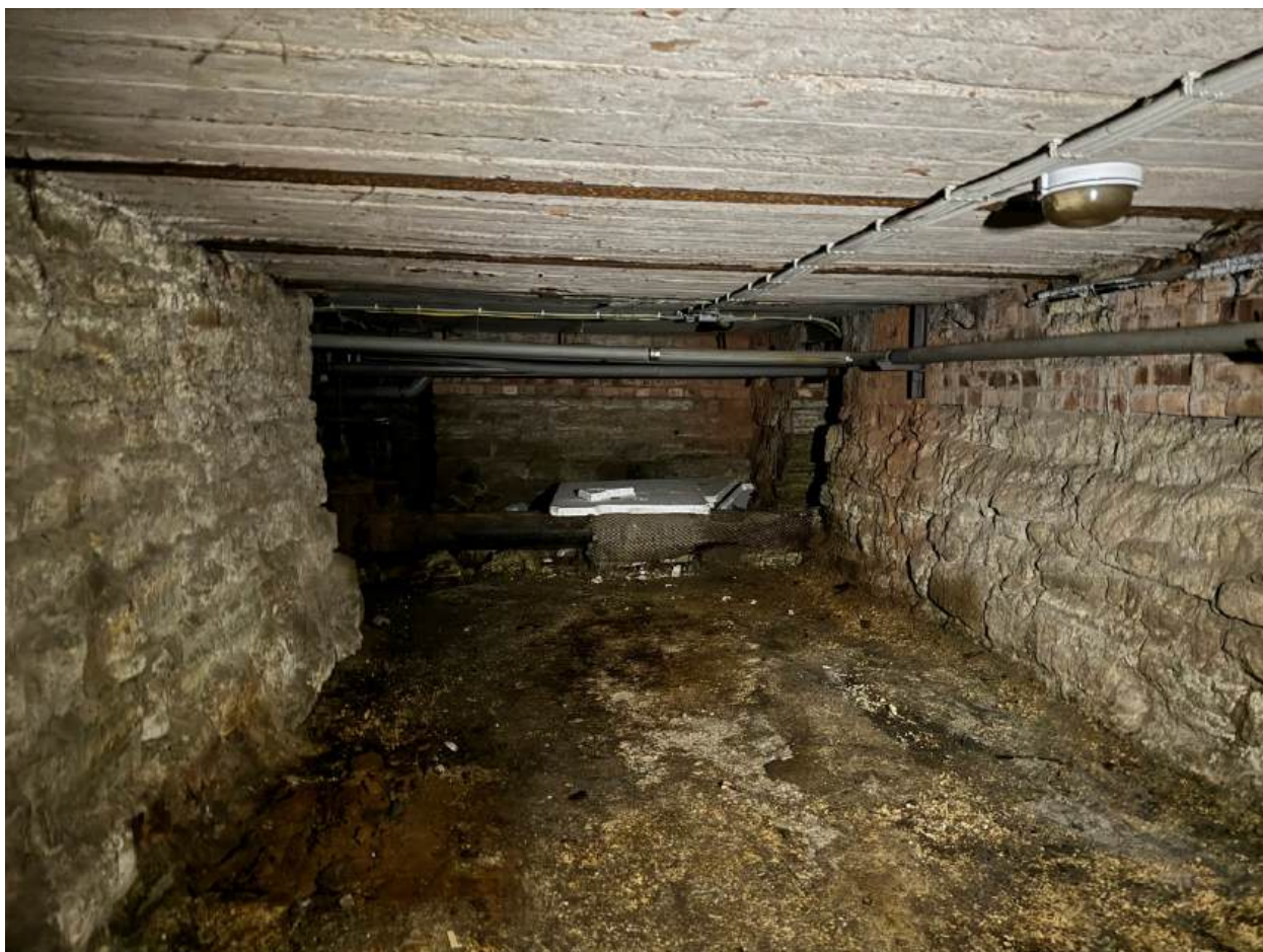
Фото 17. Вид на подвальное помещение объекта культурного наследия.
