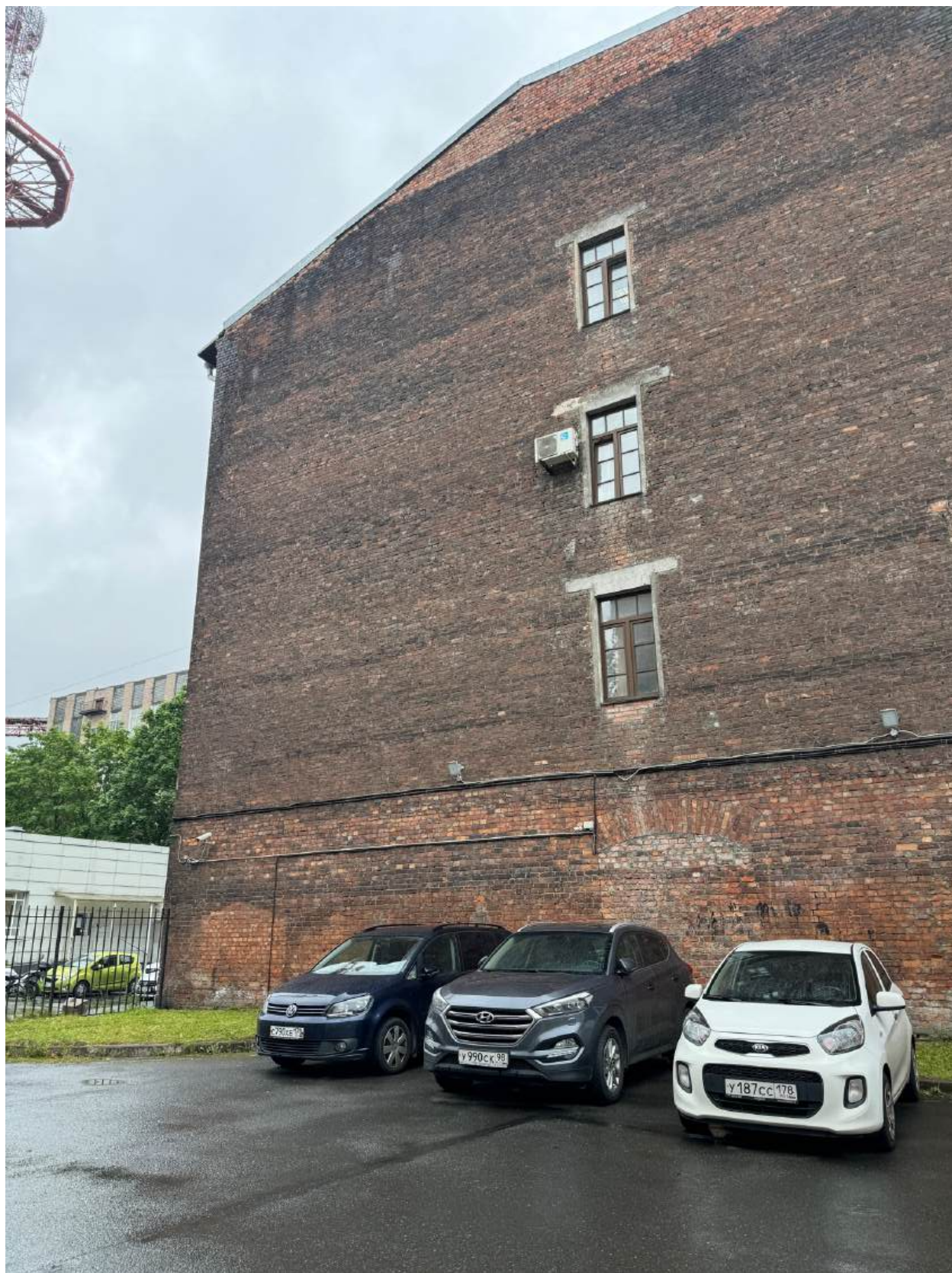
Фото 4. Фрагмент брандмауэрной стены объекта культурного наследия с проезда от Бобруйской улицы.
