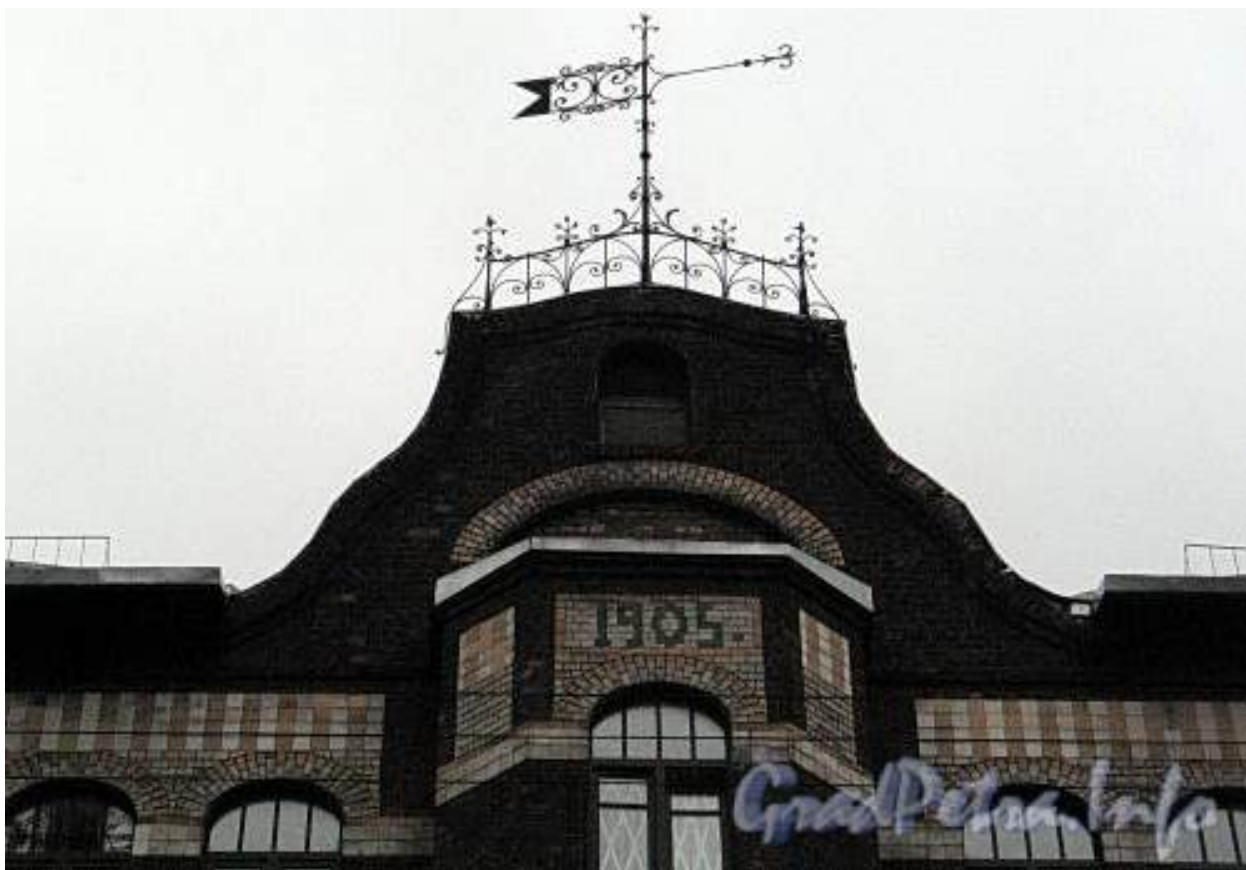
45. Бобруйская ул., д. 4. Фрагмент фасада здания. 2010 г. [Электронный ресурс] URL: https://photo.gradpetra.net/views/13509.html
