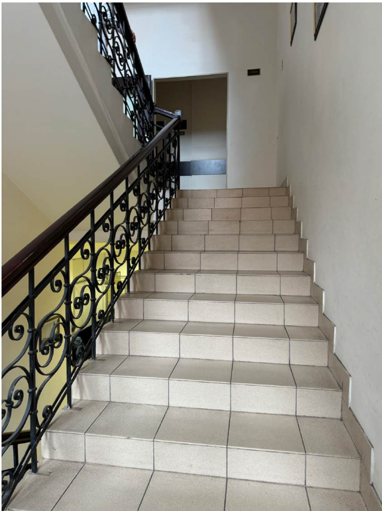
Фото 49. Вид на интерьер лестницы 1ЛК объекта культурного наследия.
