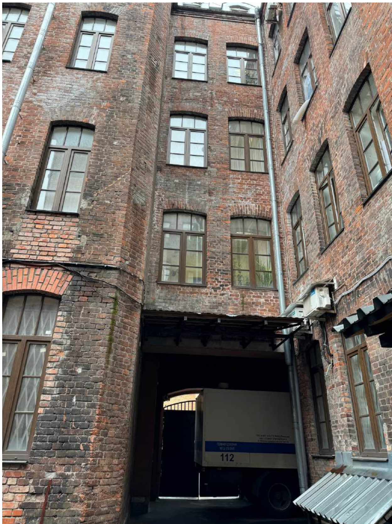
Фото 14. Общий вид дворовых фасадов объекта культурного наследия.
