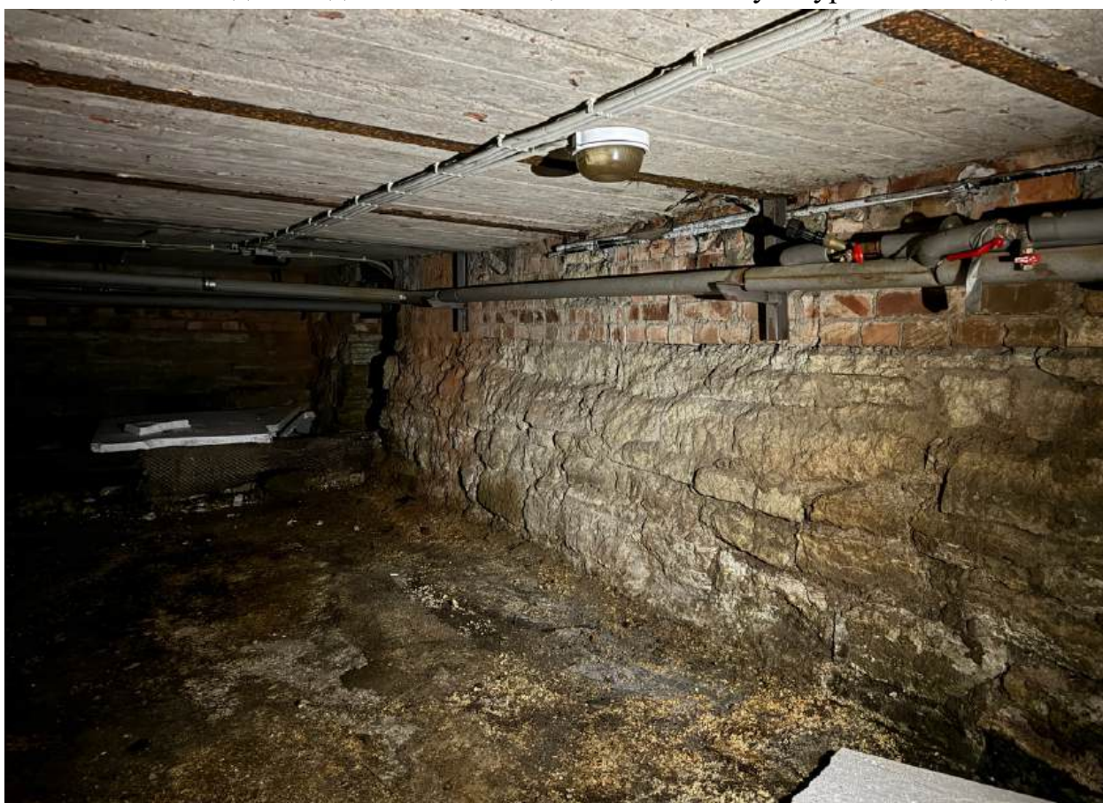
Фото 18. Вид на подвальное помещение объекта культурного наследия.
