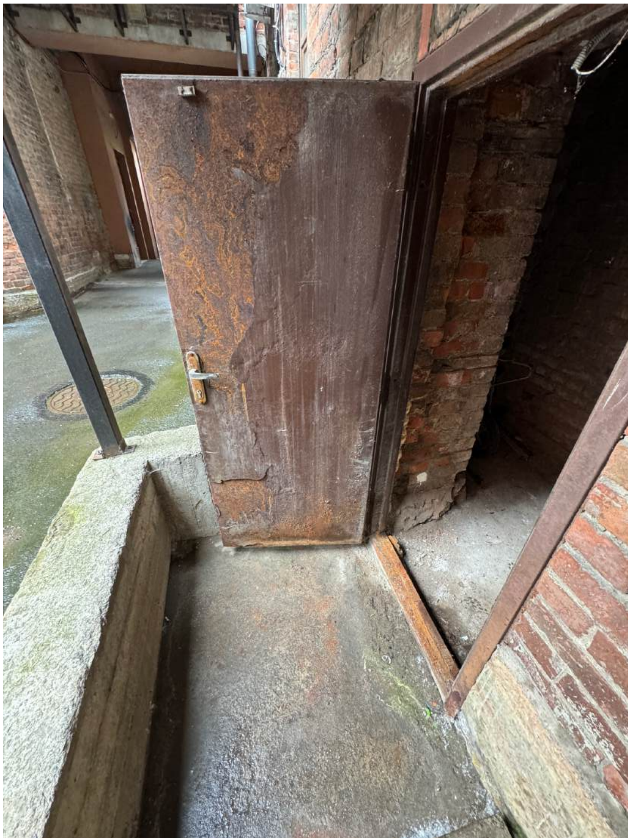
Фото 16. Вход в подвальное помещение объекта культурного наследия.
