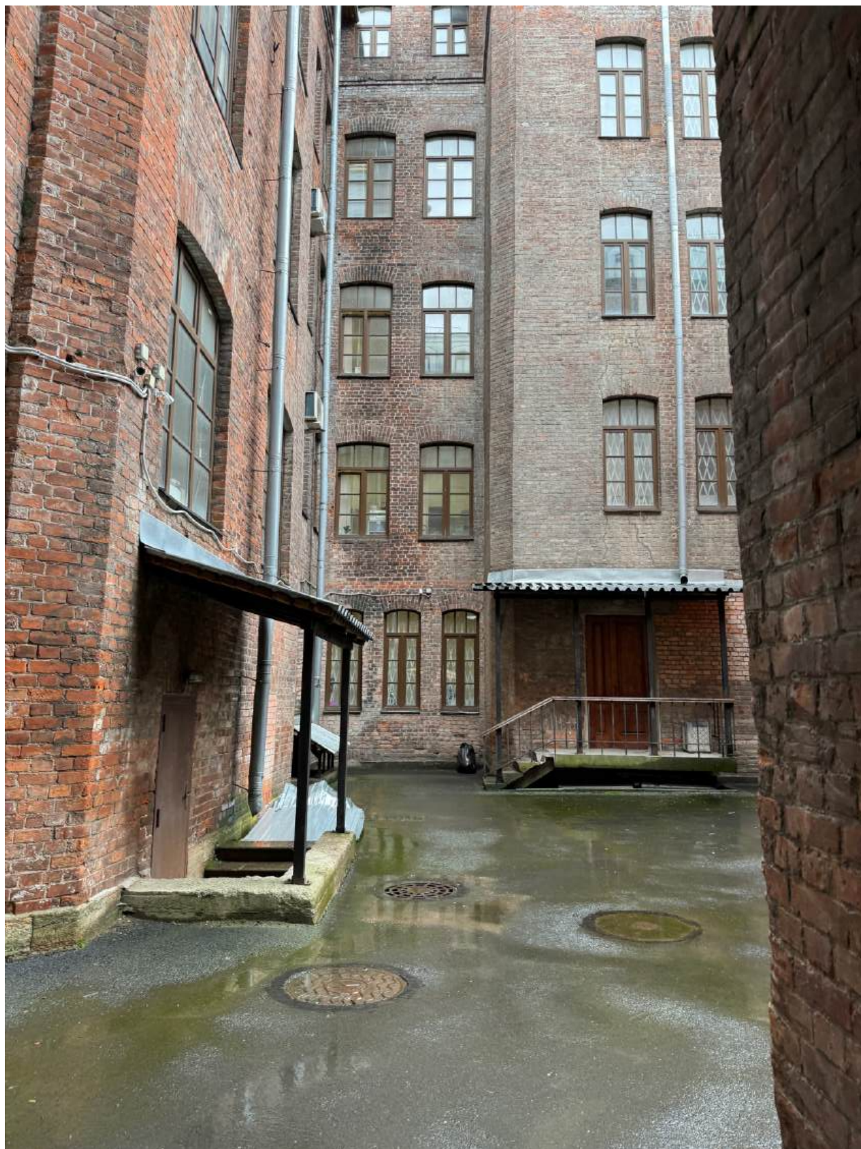
Фото 9. Общий вид дворовых фасадов объекта культурного наследия.
