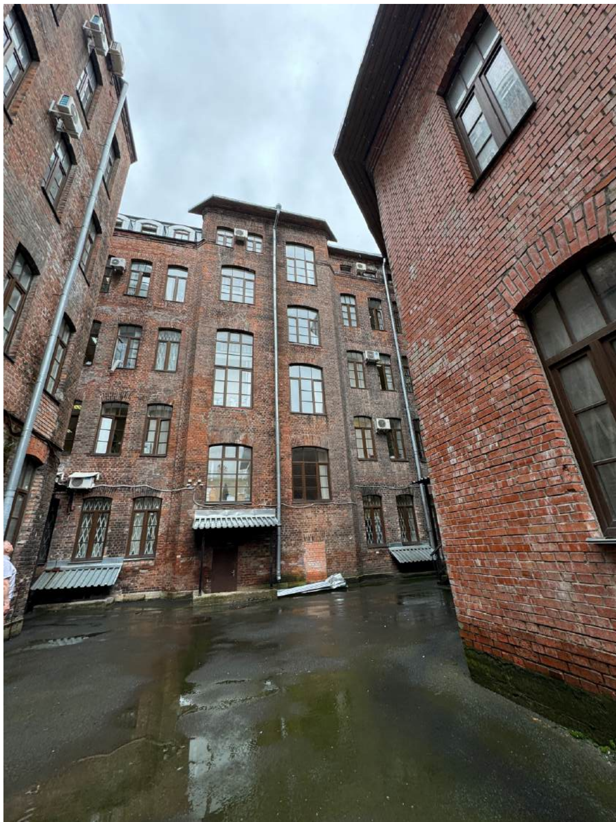
Фото 11. Общий вид дворовых фасадов объекта культурного наследия.
