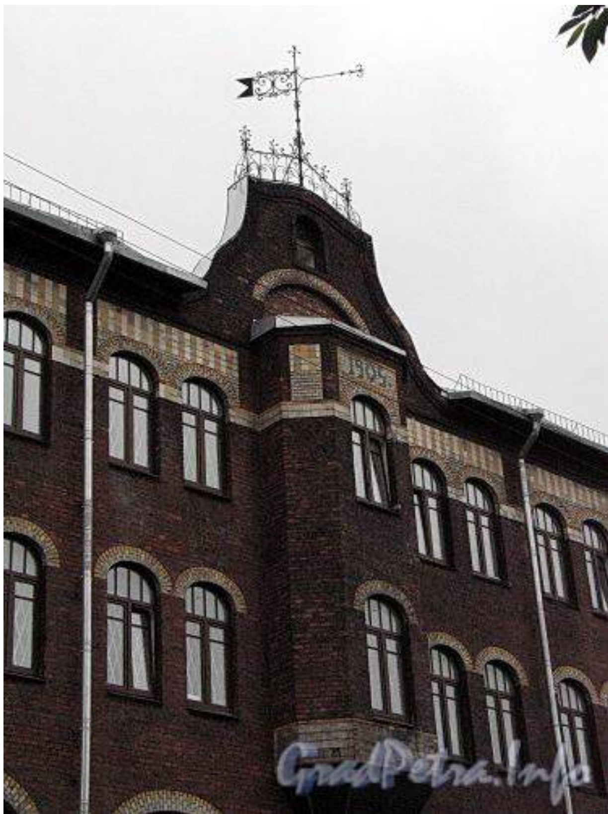
44. Бобруйская ул., д. 4. Фрагмент фасада здания. 2010 г. [Электронный ресурс] URL: https://photo.gradpetra.net/views/13508.html
