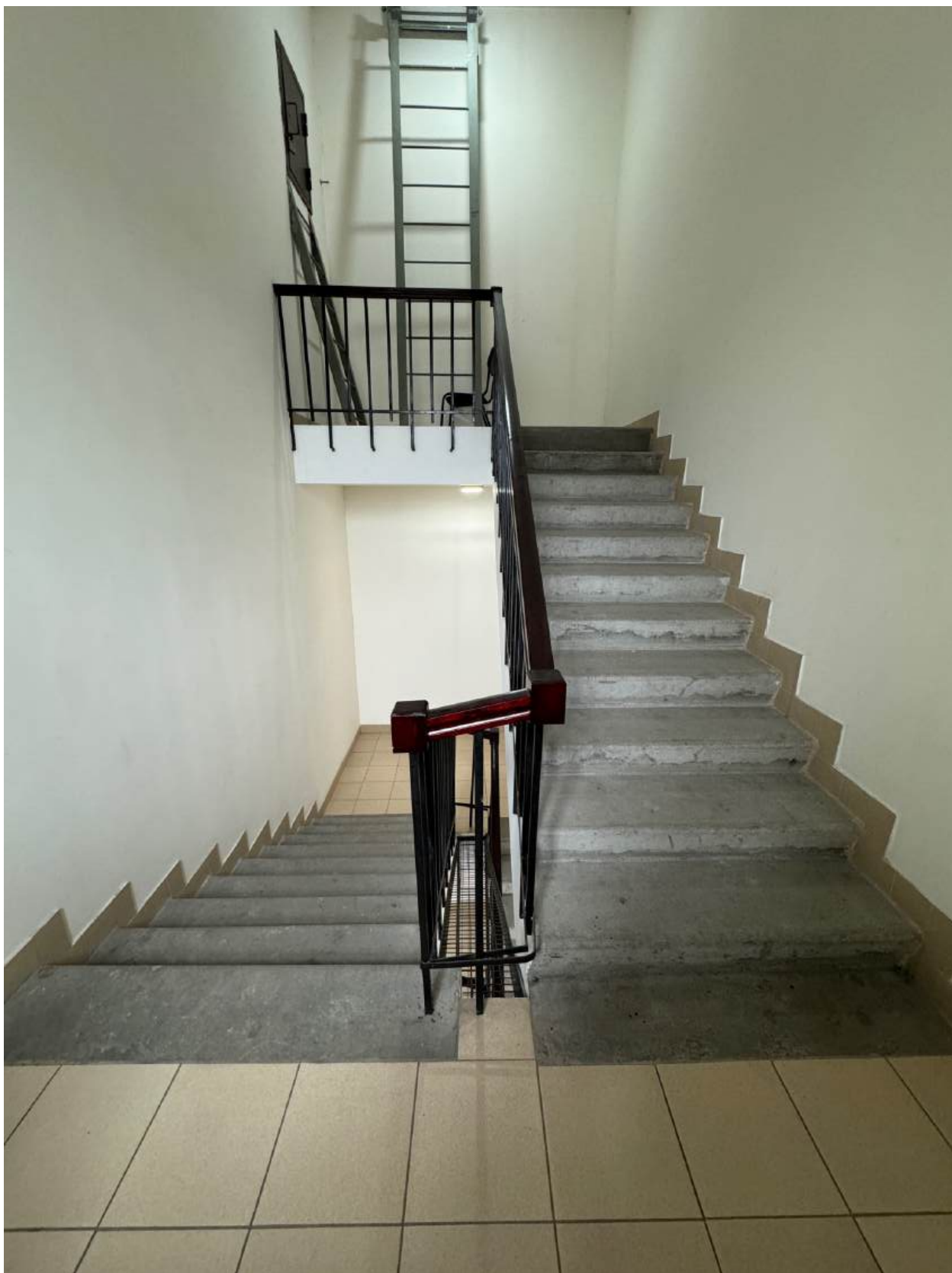
Фото 32. Вид на интерьер лестницы 2ЛК объекта культурного наследия.
