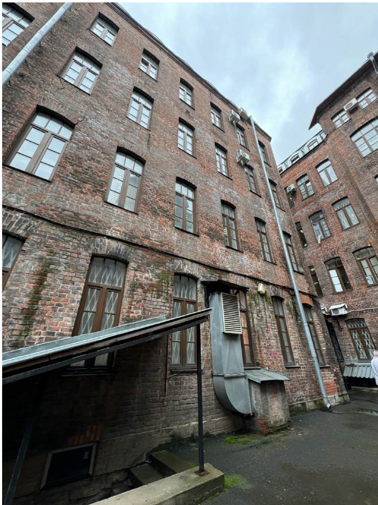
Фото 13. Общий вид дворовых фасадов объекта культурного наследия.
