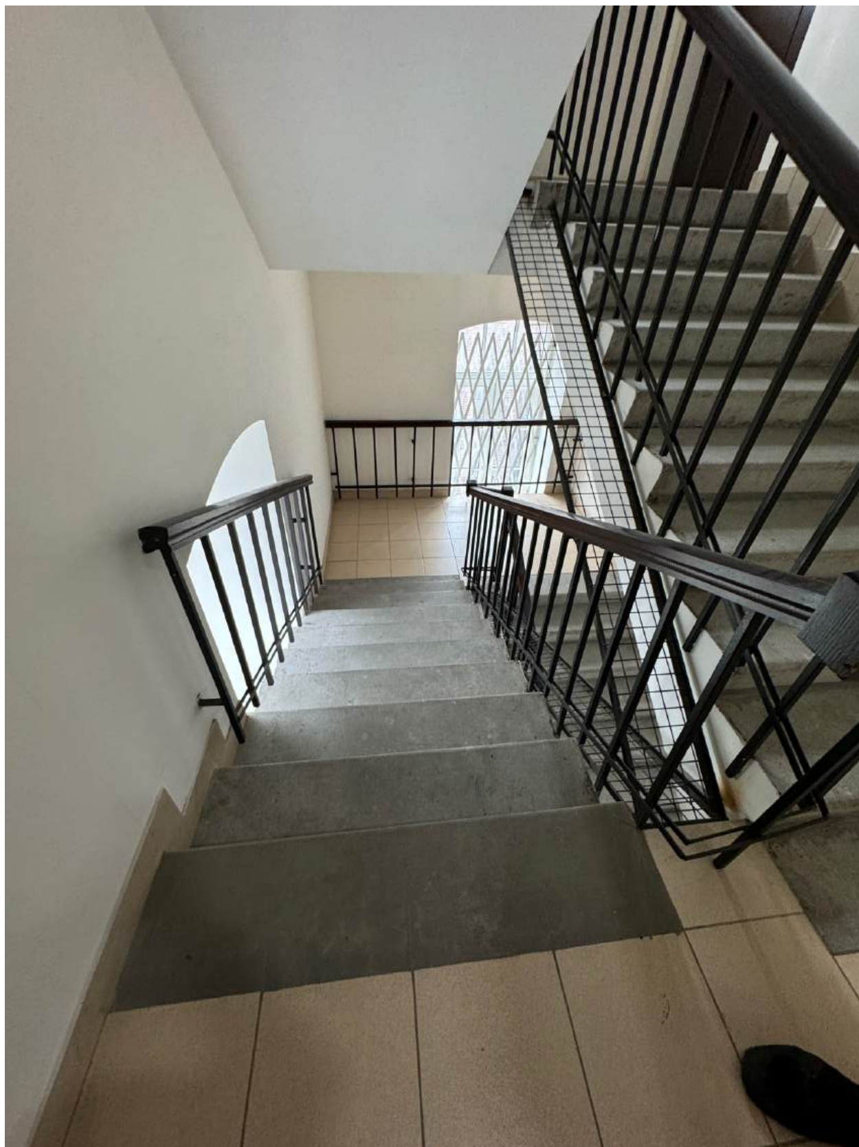
Фото 33. Вид на интерьер лестницы 2ЛК объекта культурного наследия.
