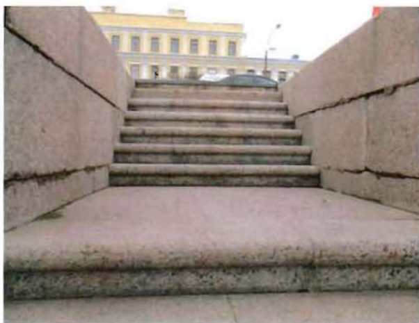
7. Лестницы (две). Вид снизу
