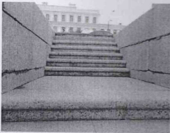
7. Лестницы (две). Вид снизу
