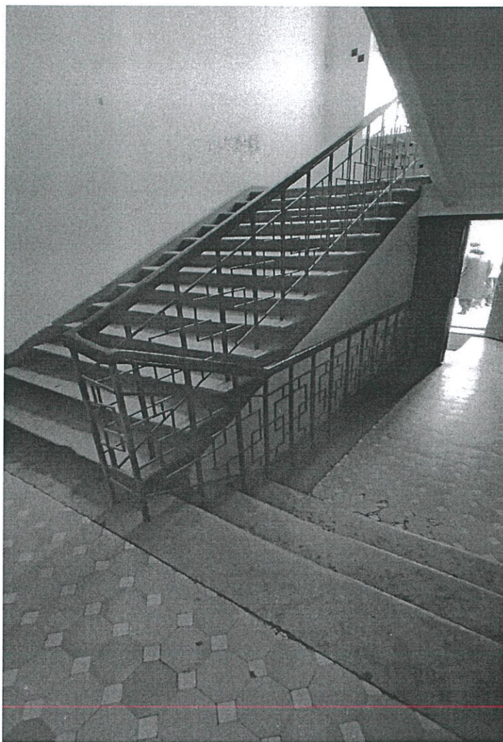
18. Общий вид лестничной клетки в центральной части здания
