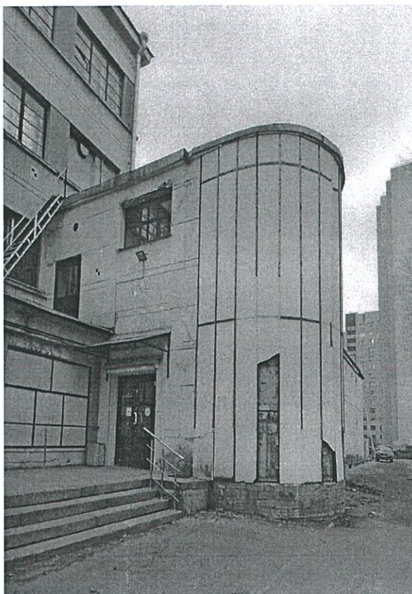
8. Фрагмент южного фасада (эркер).
