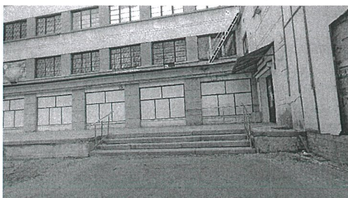
7. Фрагмент южного фасада
