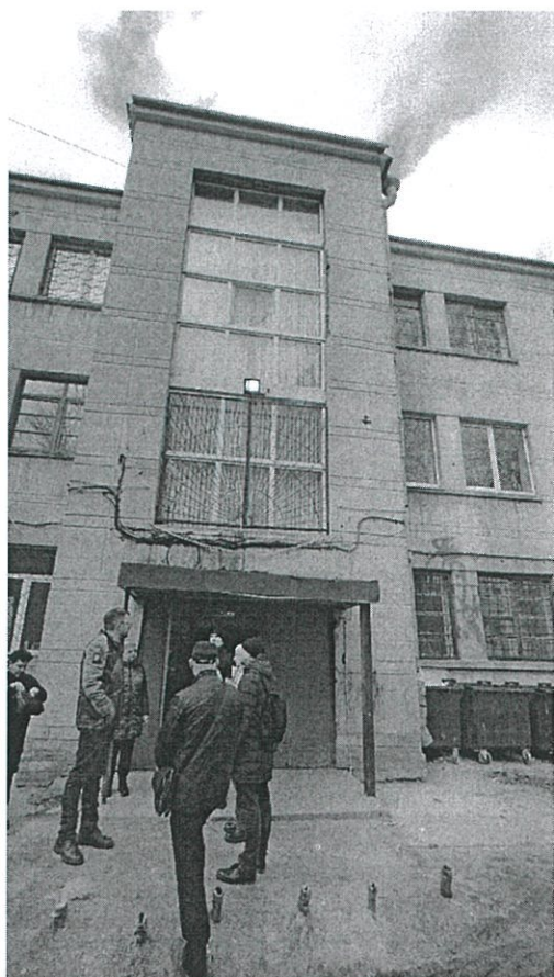
10. Фрагмент дворового фасада (лестничная клетка).
