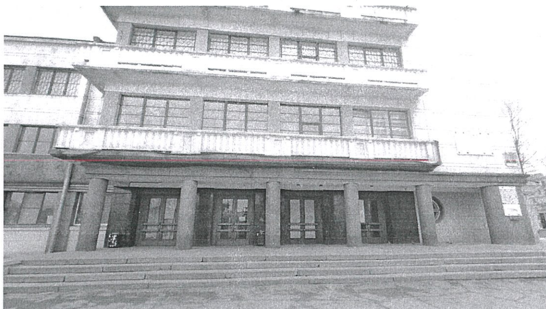
2. Общий вид главного входа Объекта (юго-западная часть здания).
