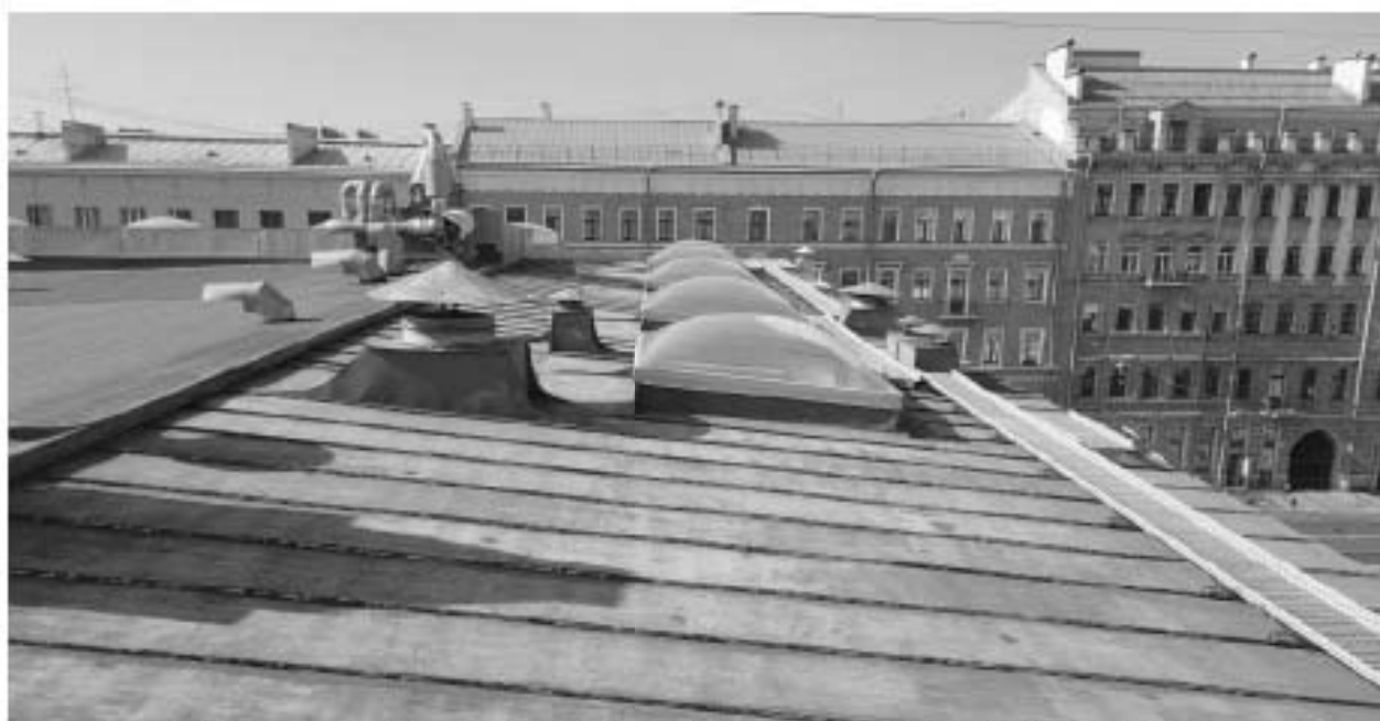
2. ВОКН «Особняк В.В. Долгоруковой (А.И. Шаховского)». Вид крыши со стороны ул. Фурштатской: кровля – кровельная сталь, металлическая обрешетка, оформление мансардных проемов. Дата съемки: 25.08.2025г.
