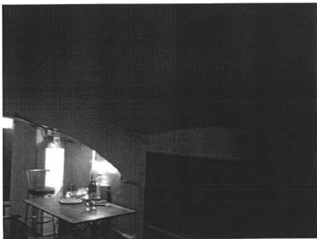
«Особняк В.В. Долгоруковой». Помещение № 16, площадью 21,1м.кв. Сводь коробовые с распалубками. Съемка 19.06.2012. Л.Б.Хабло.
