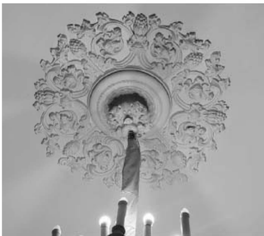
54. ВОКН «Особняк В.В. Долгоруковой (А.И. Шаховского)». Интерьеры 2-го этажа. Центральная лепная розетка на потолке. Дата съемки: 25.08.2025г.
