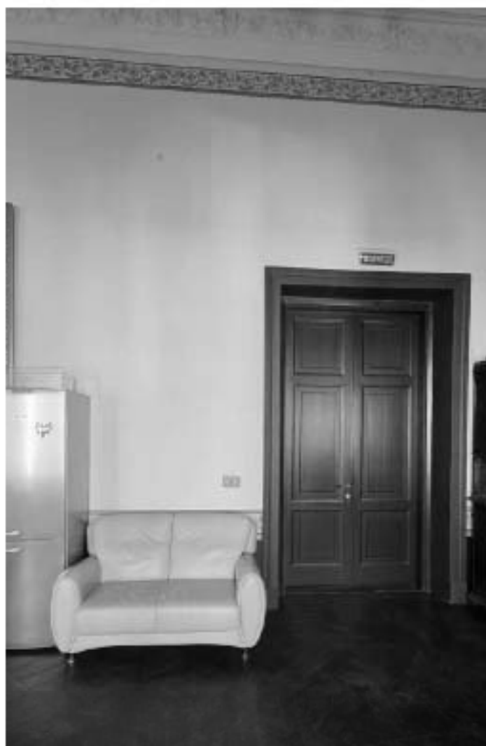
99. ВОКН «Особняк В.В. Долгоруковой (А.И. Шаховского)». Интерьеры 2-го этажа. Полихромная орнаментальная живопись (масляная по штукатурке) верхнего яруса. Дверной проем. Историческое дверное заполнение (дерево), его габариты и конфигурация. Дата съемки: 25.08.2025г.
