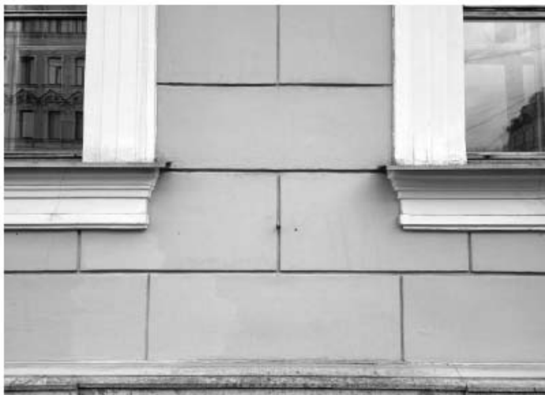
16. ВОКН «Особняк В.В. Долгоруковой (А.И. Шаховского)». Вид материала и характер отделки фасада – штукатурный руст. Фрагмент исторических оконных проемов первого этажа. Дата дополнительной съемки: 22.09.2025г.
