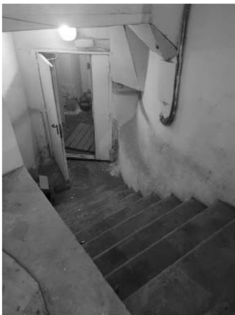
12. ВОКН «Особняк В.В. Долгоруковой (А.И. Шаховского)». Интерьеры 1-го этажа. Историческая лестница в подвал. Дата съемки: 25.08.2025г.
