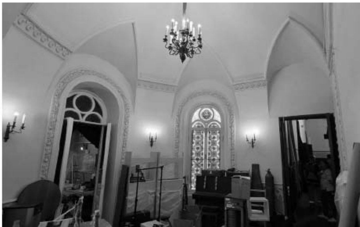
50. ВОКН «Особняк В.В. Долгоруковой (А.И. Шаховского)». Интерьеры 2-го этажа. Помещение со сводом. Орнаментальный пояс в основании свода. Исторические дверные проемы и профилированное лепное обрамление проемов. Дата съемки: 25.08.2025г.
