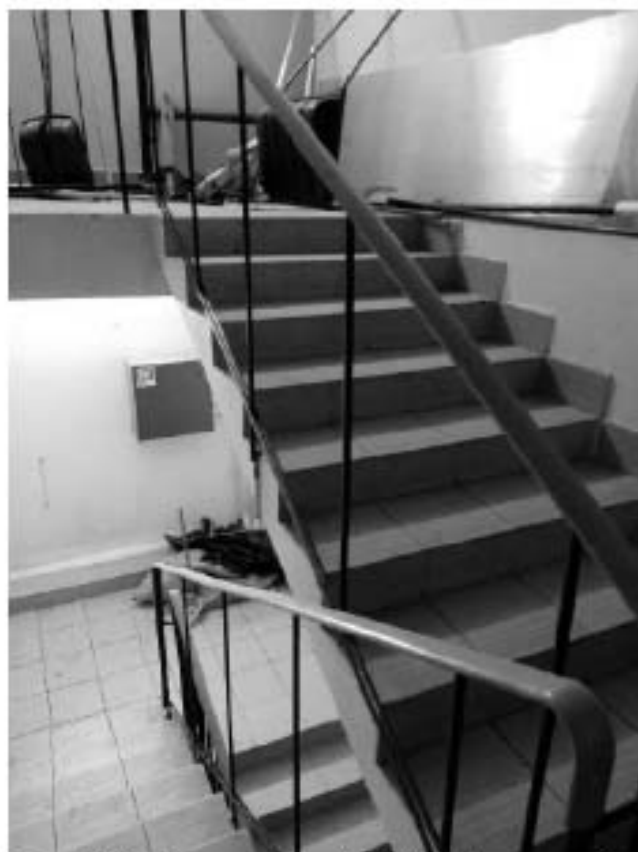
118. ВОКН «Особняк В.В. Долгоруковой (А.И. Шаховского)». Выход на кровлю. Дата съемки: 25.08.2025г.
