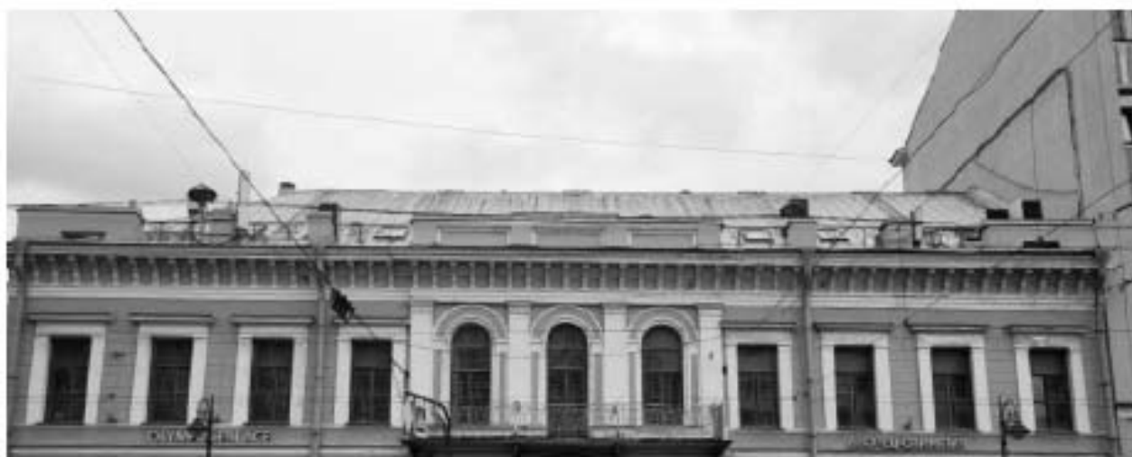
37. ВОКН «Особняк В.В. Долгоруковой (А.И. Шаховского)». Венчающий профилированный карниз с модульонами. Аттиковые стенки, парапетные прямоугольные штукатурные столбики и парапетная решетка. Дата дополнительной съемки: 22.09.2025г.
