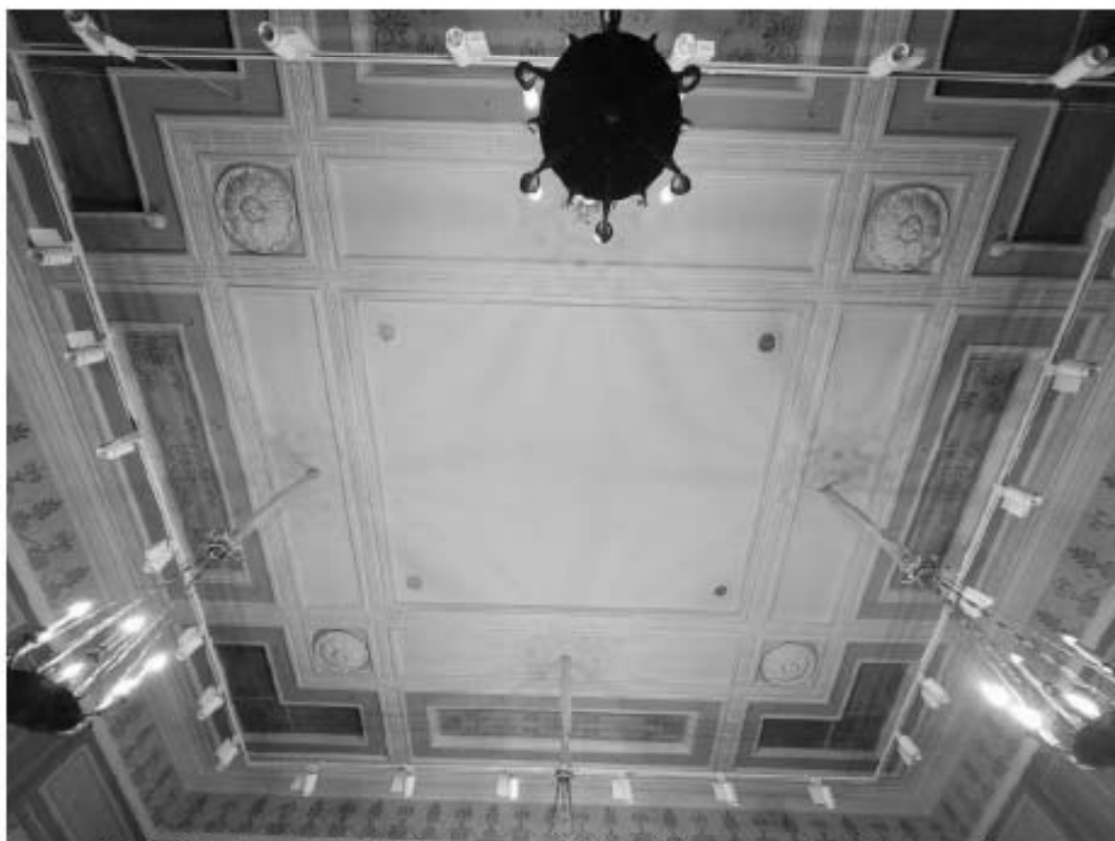
48. ВОКН «Особняк В.В. Долгоруковой (А.И. Шаховского)». Интерьеры 2-го этажа. Месторасположение светового фонаря. Дата съемки: 25.08.2025г.
