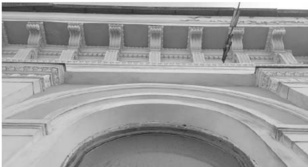
33. ВОКН «Особняк В.В. Долгоруковой (А.И. Шаховского)». Фрагмент венчающего профилированного карниза с модульонами. Фрагмент оформления арочного оконного проема. Дата съемки: 25.08.2025г.
