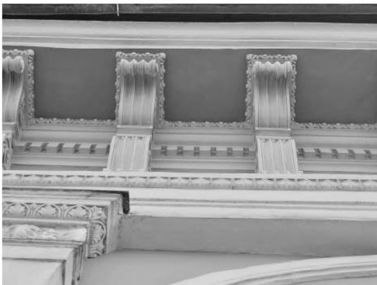
34. ВОКН «Особняк В.В. Долгоруковой (А.И. Шаховского)». Фрагмент венчающего профилированного карниза с модульонами. Дата съемки: 25.08.2025г.
