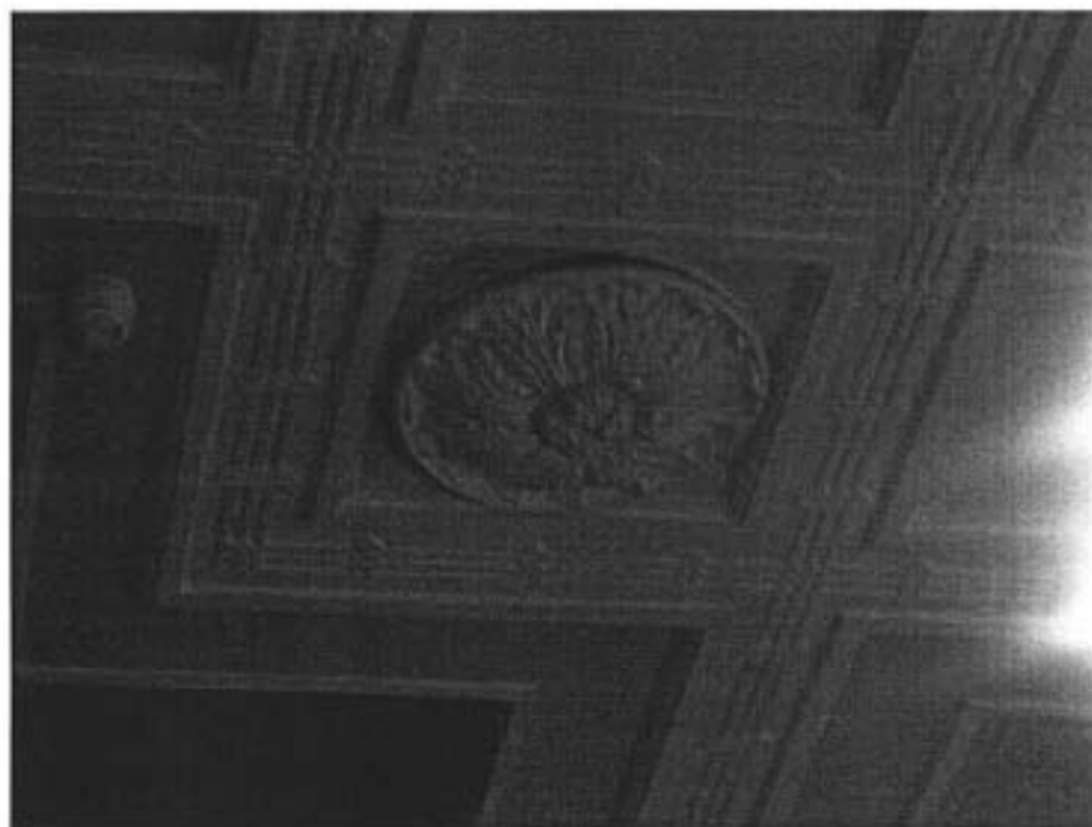
«Особняк В.В. Долгоруковой». Помещение № 148, площадью 73.4 м.кв. Фрагмент плафона потолка. Съемка 19.06.2012. Л.Б.Хабло.
