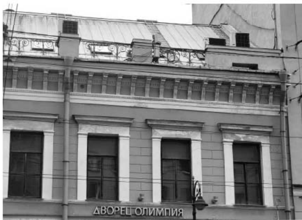
32. ВОКН «Особняк В.В. Долгоруковой (А.И. Шаховского)». Фрагмент венчающего профилированного карниза с модульонами. Аттиковая стенка, парапетные прямоугольные штукатурные столбики и парапетная решетка (металл, ковка, рисунок – листья аканта). Дата дополнительной съемки: 22.09.2025г.
