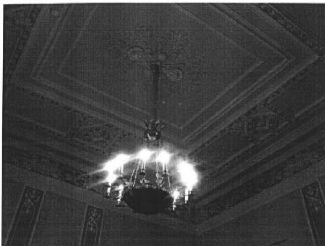
«Особняк В.В. Долгоруковой». Помещение № 145, площадью 39,3 м.кв. Фрагмент плафона потолка. Съемка 19.06.2012. Л.Б.Хабло.
