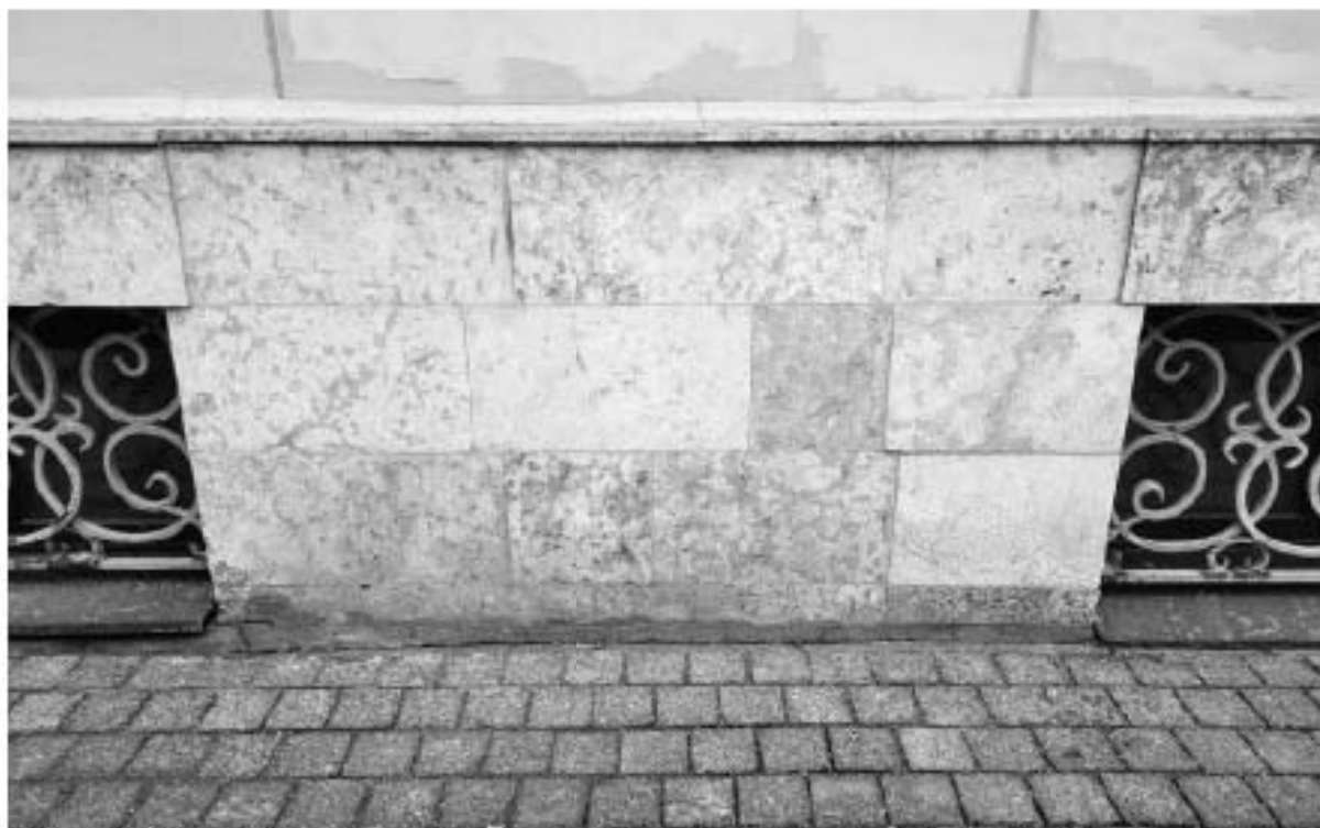
39. ВОКН «Особняк В.В. Долгоруковой (А.И. Шаховского)». Вид материала поколя – известняковая плита. Дата дополнительной съемки: 22.09.2025г.
