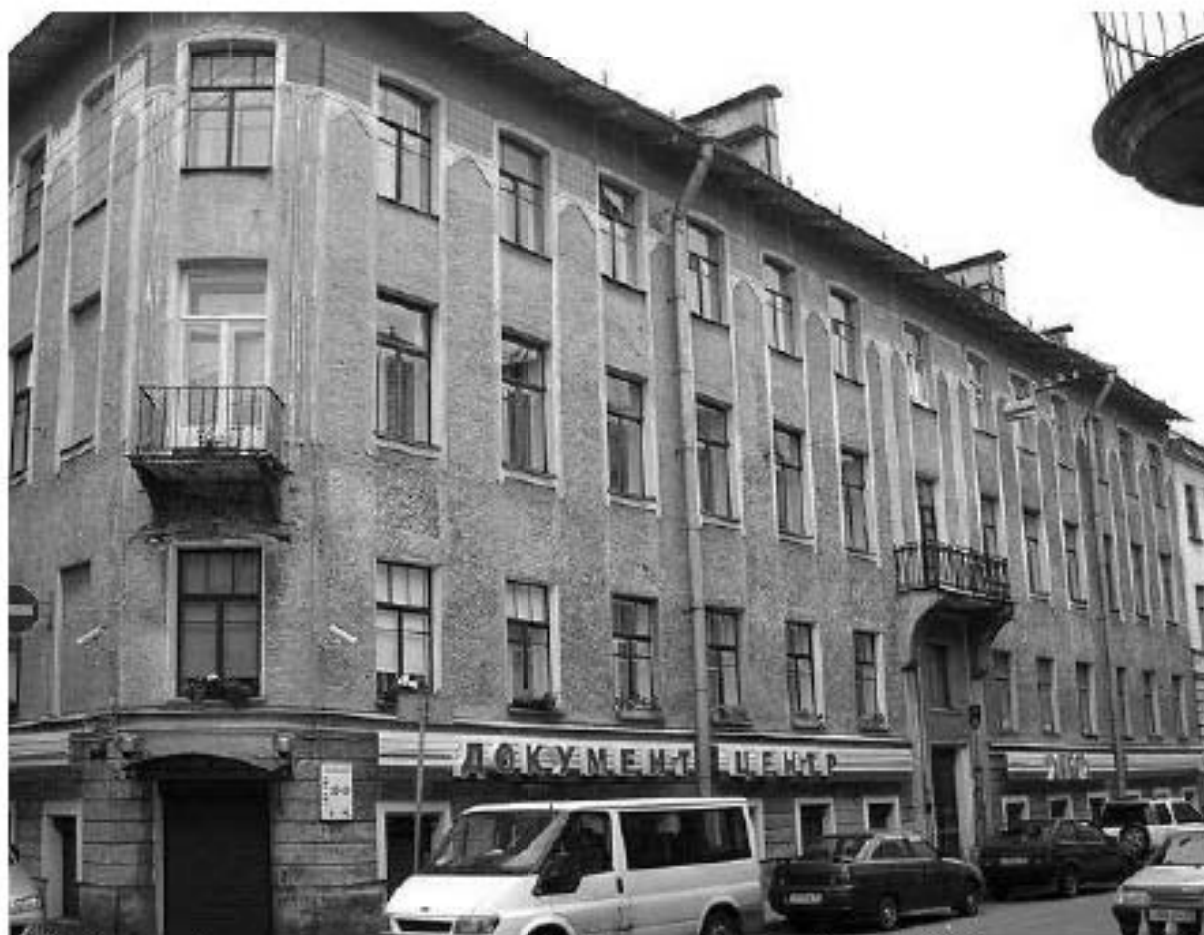
60. Доходный дом по адресу: Санкт-Петербург, Прачечный пер., 8 / Пирогова пер., 17. 2021г. https://www.citywalls.ru/
