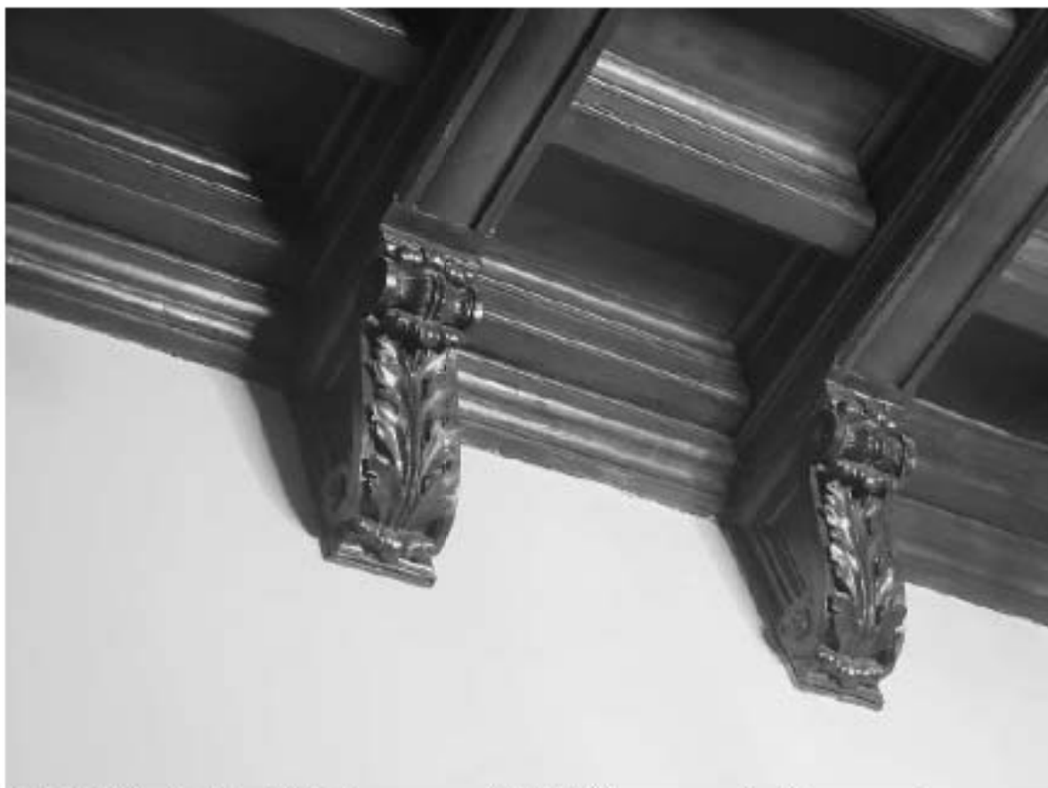
63. ВОКН «Особняк В.В. Долгоруковой (А.И. Шаховского)». Интерьеры 2-го этажа. Профилированный карниз по периметру потолка с кронштейнами. Дата съемки: 25.08.2025г.
