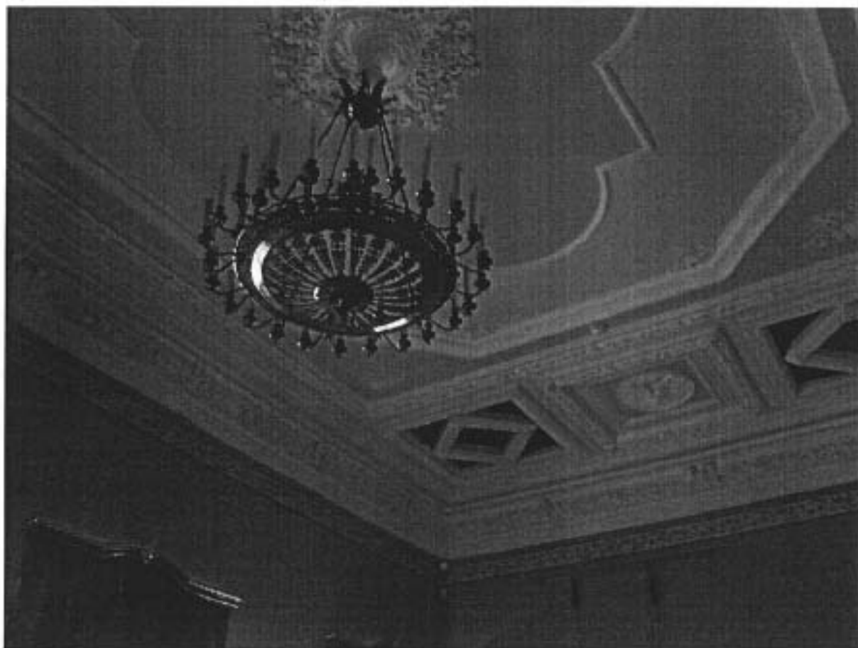
«Особняк В.В. Долгоруковой». Помещение № 147, площадью 60,6 м.кв. Фрагмент плафона потолка. Съемка 19.06.2012. Л.Б.Хабло.
