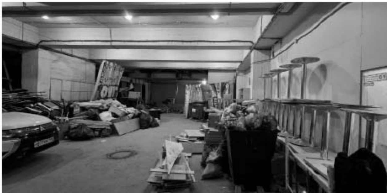
11. ВОКН «Особняк В.В. Долгоруковой (А.И. Шаховского)». Интерьеры 1-го этажа. Служебное помещение. Дата съемки: 25.08.2025г.
