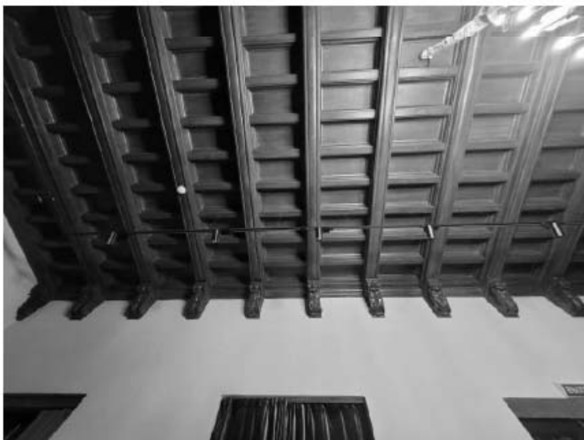
62. ВОКН «Особняк В.В. Долгоруковой (А.И. Шаховского)». Интерьеры 2-го этажа. Кессоны на потолке. Профилированный карниз по периметру потолка с кронштейнами. Дата съемки: 25.08.2025г.
