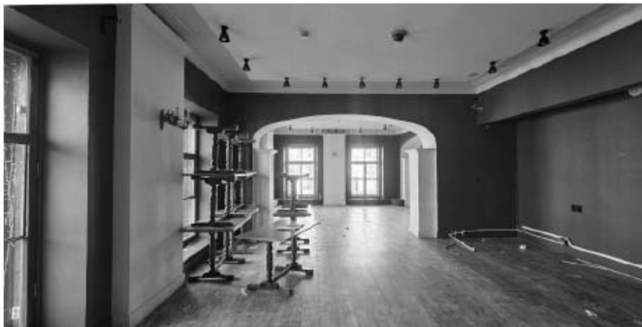
19. ВОКН «Особняк В.В. Долгоруковой (А.И. Шаховского)». Интерьеры 1-го этажа. Историческое месторасположение оконных проемов. Плоские перекрытия. Дата съемки: 25.08.2025г.
