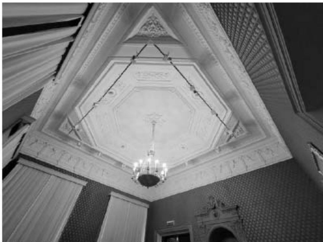
91. ВОКН «Особняк В.В. Долгоруковой (А.И. Шаховского)». Интерьеры 2-го этажа. Платфон потолка. Лепной декор (профилированный карниз). Дата съемки: 25.08.2025г.
