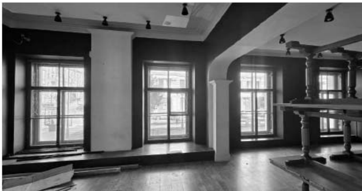
18. ВОКН «Особняк В.В. Долгоруковой (А.И. Шаховского)». Интерьеры 1-го этажа. Историческое месторасположение оконных проемов. Дата съемки: 25.08.2025г.
