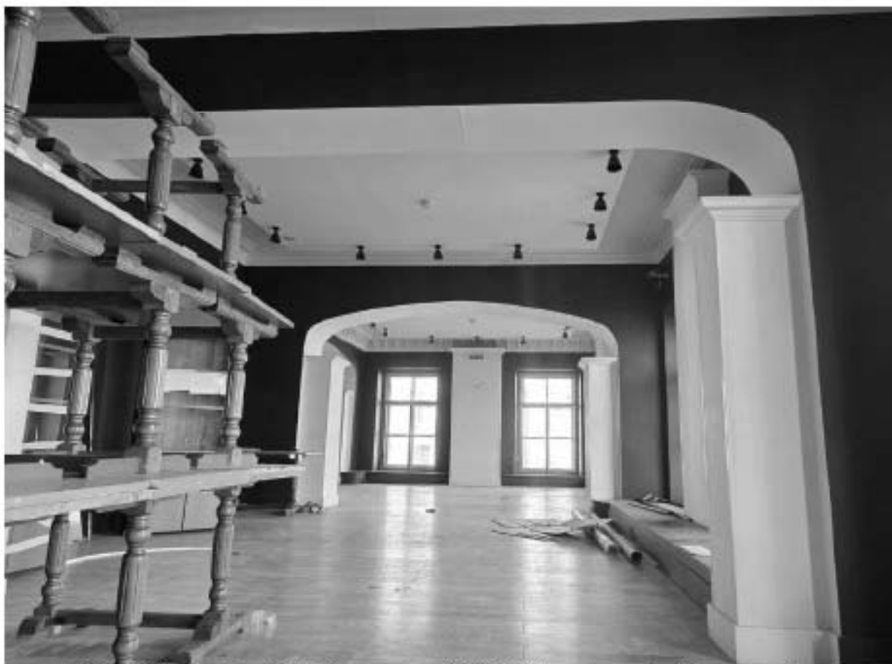
16. ВОКН «Особняк В.В. Долгоруковой (А.И. Шаховского)». Интерьеры 1-го этажа. Историческое месторасположение оконных проемов. Плоские перекрытия. Дата съемки: 25.08.2025г.
