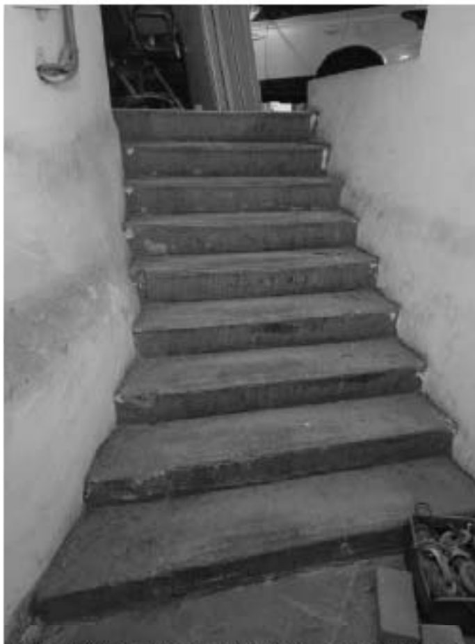
1. ВОКН «Особняк В.В. Долгоруковой (А.И. Шаховского)». Интерьеры подвала. Историческая лестница в подвал. Дата съемки: 25.08.2025г.
