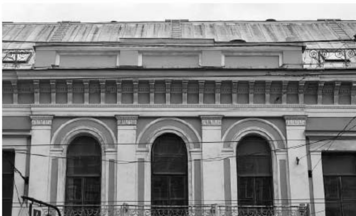
21. ВОКН «Особняк В.В. Долгоруковой (А.И. Шаховского)». Архивольты по центральным трем осям на уровне второго этажа западного лицевого фасада. Аттиковая стенка. Дата дополнительной съемки: 22.09.2025г.
