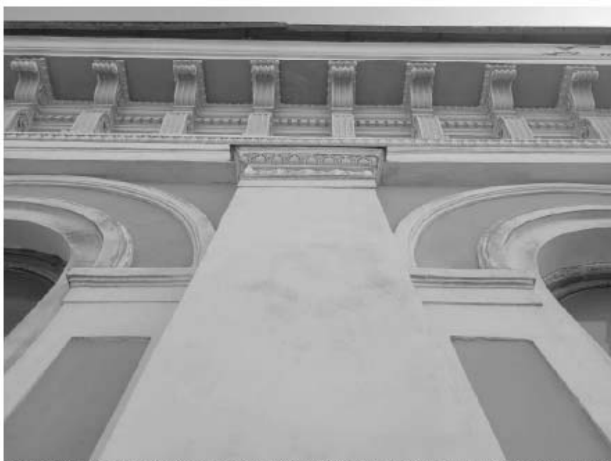
22. ВОКН «Особняк В.В. Долгоруковой (А.И. Шаховского)». Пилястры в межоконных простенках второго этажа центральной части западного фасада. Фрагмент венчающего профилированного карниза с модульонами. Дата съемки: 25.08.2025г.
