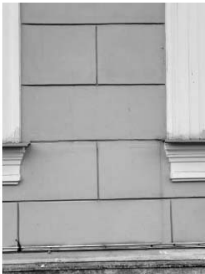
15. ВОКН «Особняк В.В. Долгоруковой (А.И. Шаховского)». Вид материала и характер отделки фасада – штукатурный руст. Историческое колористическое решение фасадов. Дата дополнительной съемки: 22.09.2025г.
