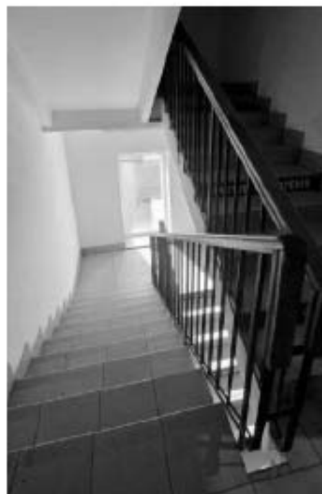
103. ВОКН «Особняк В.В. Долгоруковой (А.И. Шаховского)». Интерьеры 3-го этажа. Лестница со ступенями, облицованными керамической плиткой и ограждением простого рисунка. Дата съемки: 25.08.2025г.
