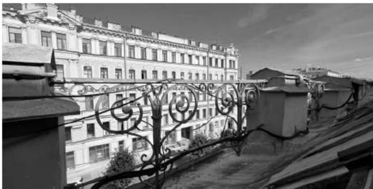
9. ВОКН «Особняк В.В. Долгоруковой (А.И. Шаховского)». Фрагмент карниза – металлическое ограждение ажурного рисунка с парпетными, гладко оштукатуренными, столбиками. Дата съемки: 25.08.2025г.
