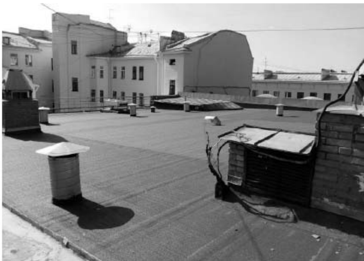
3. ВОКН «Особняк В.В. Долгоруковой (А.И. Шаховского)». Общий вид крыши. Дата съемки: 25.08.2025г.
