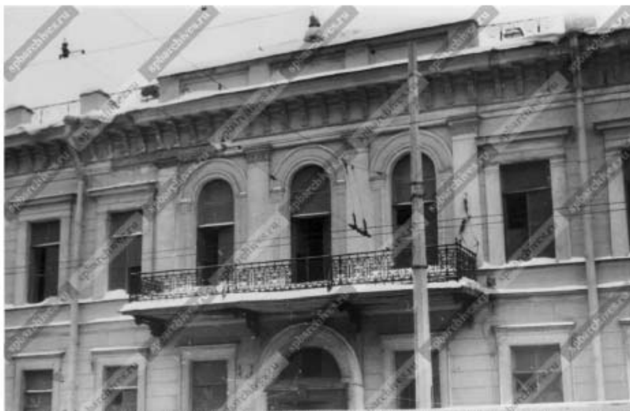
75. Вид со стороны Литейного проспекта части фасада дома № 1/14 во время капитального ремонта (бывший особняк В.В. Долгоруковой, архитектор А.И. Низовцев, 1843–1844гг.). 1985г. ЦГАКФД СПб. Оп. 1АР-154. Ед.хр. 215012.
