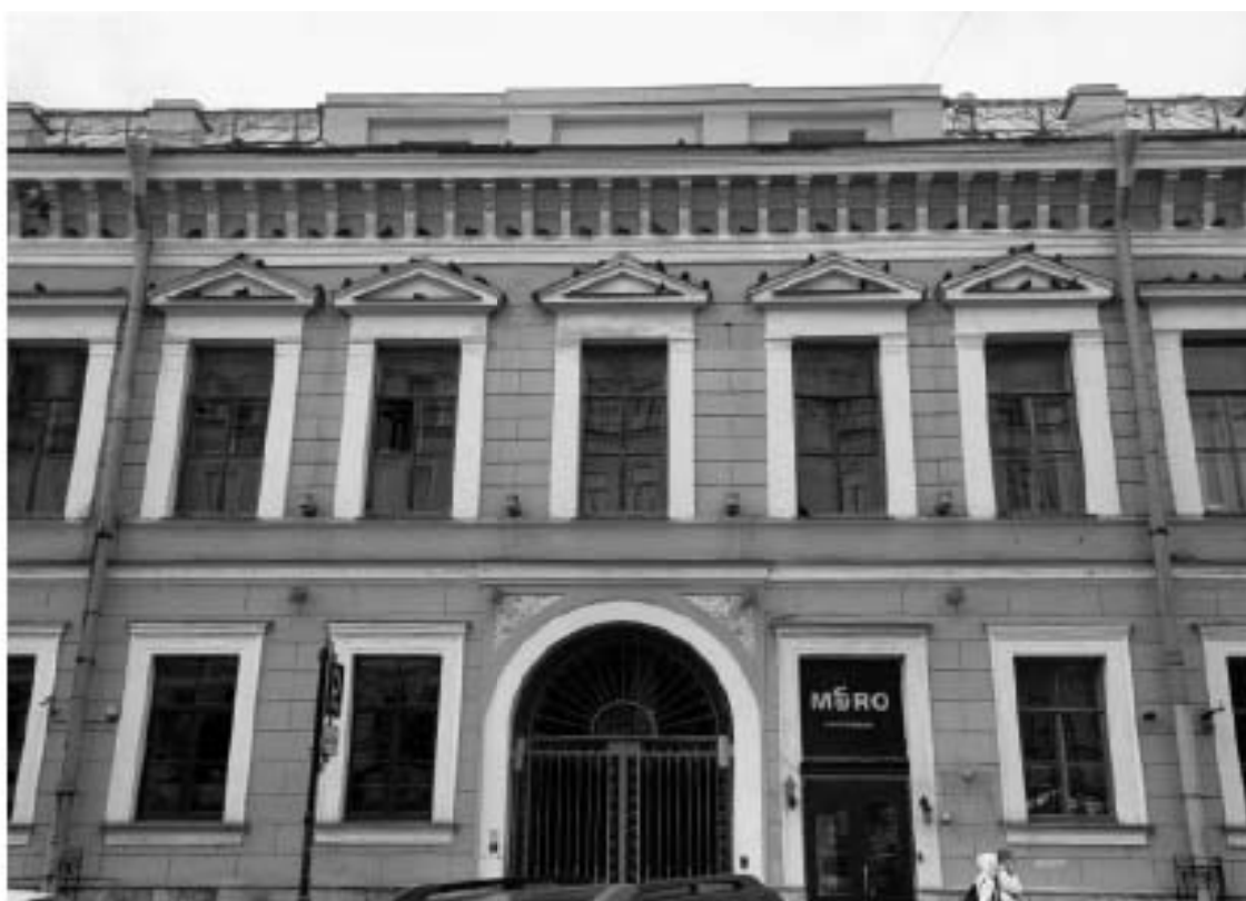
20. ВОКН «Особняк В.В. Долгоруковой (А.И. Шаховского)». Треугольные сандрики по центральным пяти осям на уровне второго этажа северного лицевого фасада. Дата дополнительной съемки: 22.09.2025г.
