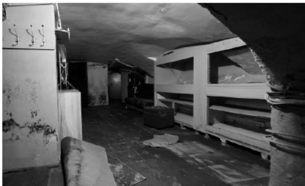
4. ВОКН «Особняк В.В. Долгоруковой (А.И. Шаховского)». Интерьеры подвала. Внутренний конструктивный элемент – свод (цилиндрический на распалубках). Дата съемки: 25.08.2025г.
