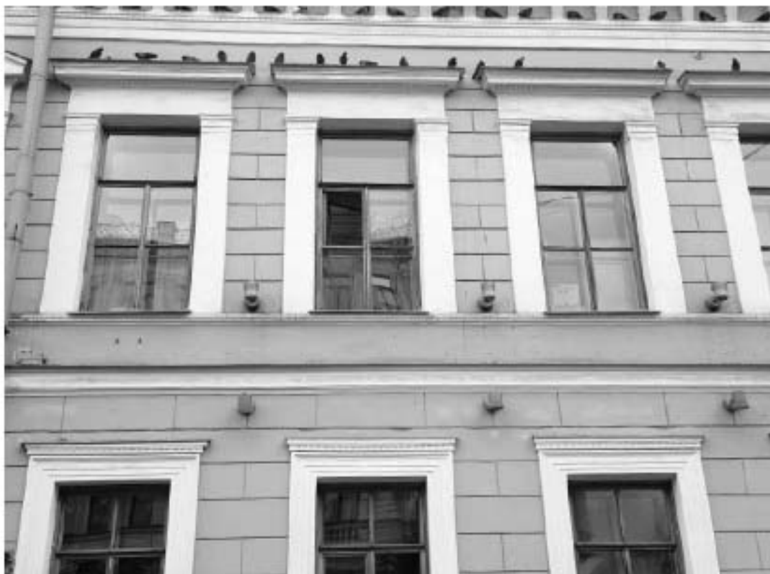
19. ВОКН «Особняк В.В. Долгоруковой (А.И. Шаховского)». Исторические прямоугольные оконные проемы. Профилированные карнизы. Дата дополнительной съемки: 22.09.2025г.
