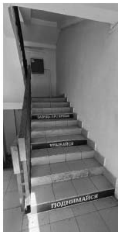
104. ВОКН «Особняк В.В. Долгоруковой (А.И. Шаховского)». Интерьеры 3-го этажа. Лестница со ступенями, облицованными керамической плиткой и ограждением простого рисунка. Дата съемки: 25.08.2025г.
