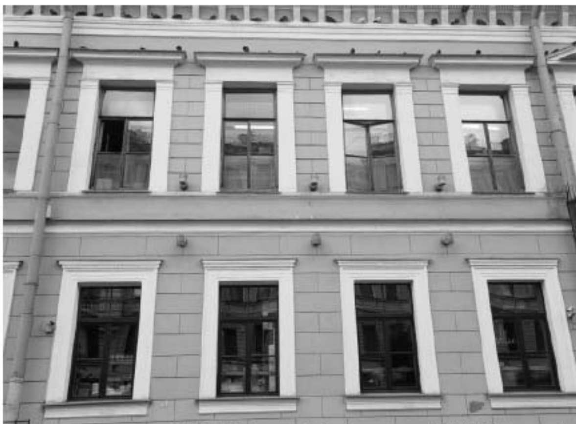
17. ВОКН «Особняк В.В. Долгоруковой (А.И. Шаховского)». Исторические оконные проемы: прямоугольные. Оформление проемов первого этажа – профилированные наличники; второго этажа – гладкие наличники. Дата дополнительной съемки: 22.09.2025г.
