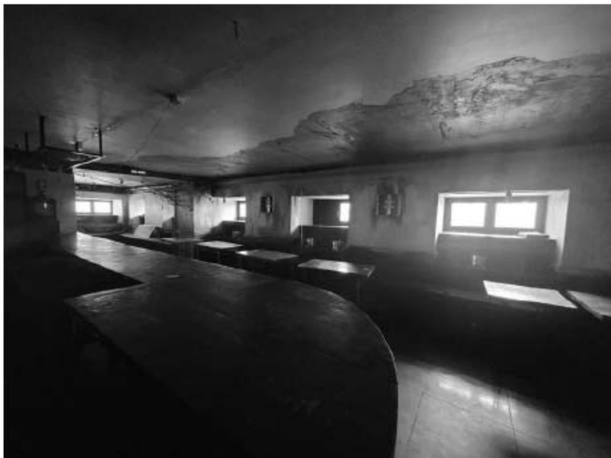
7. ВОКН «Особняк В.В. Долгоруковой (А.И. Шаховского)». Интерьеры подвала. Плоские перекрытия. Исторические оконные проемы. Дата съемки: 25.08.2025г.
