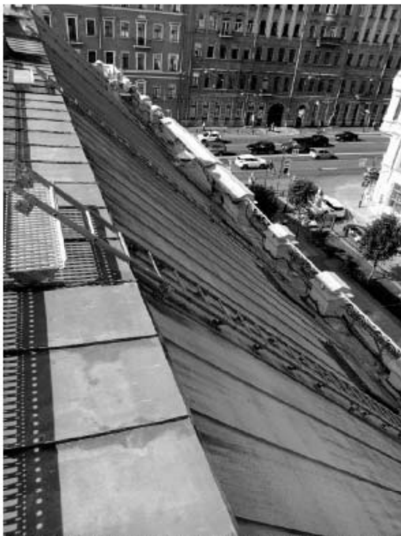
5. ВОКН «Особняк В.В. Долгоруковой (А.И. Шаховского)». Фрагмент крыши со стороны ул. Фурштатской. Дата съемки: 25.08.2025г.
