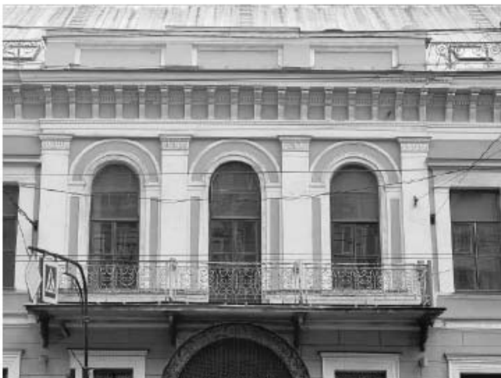
23. ВОКН «Особняк В.В. Долгоруковой (А.И. Шаховского)». Балкон на три оси с ажурным кованным ограждением на металлических кронштейнах на уровне второго этажа центральной части западного фасада. Дата дополнительной съемки: 22.09.2025г.
