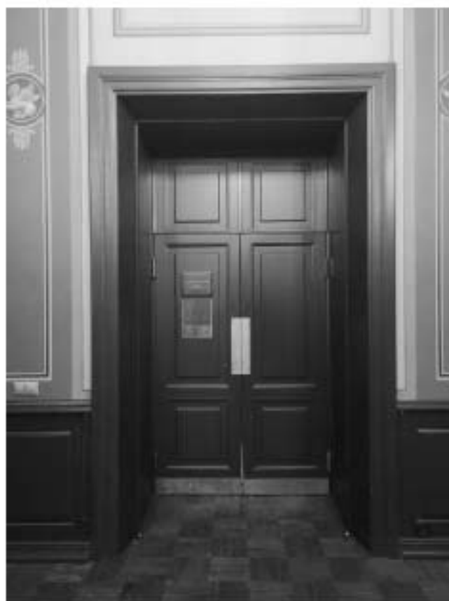
49. ВОКН «Особняк В.В. Долгоруковой (А.И. Шаховского)». Интерьеры 2-го этажа. Дверной проем. Историческое дверное заполнение (дерево), его габариты и конфигурация. Дата съемки: 25.08.2025г.
