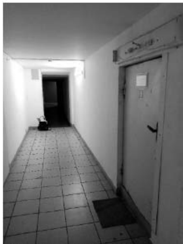
109. ВОКН «Особняк В.В. Долгоруковой (А.И. Шаховского)». Интерьеры 4-го этажа и мансарды. Служебный коридор. Дата съемки: 25.08.2025г.
