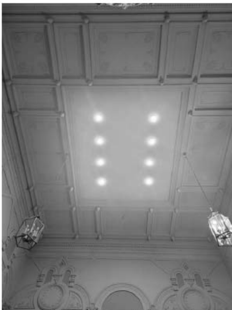
43. ВОКН «Особняк В.В. Долгоруковой (А.И. Шаховского)». Интерьеры 2-го этажа. Месторасположение светового фонаря. Дата съемки: 25.08.2025г.
