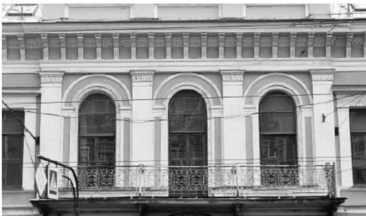
18. ВОКН «Особняк В.В. Долгоруковой (А.И. Шаховского)». Исторические арочные оконные проемы в трех центральных осях западного лицевого фасада. Дата дополнительной съемки: 22.09.2025г.
