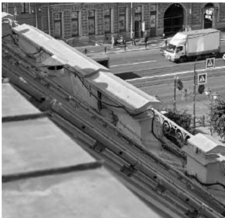
7. ВОКН «Особняк В.В. Долгоруковой (А.И. Шаховского)». Фрагмент карниза – металлическое ограждение ажурного рисунка с парпетными, гладко оштукатуренными, столбиками. Дата съемки: 25.08.2025г.
