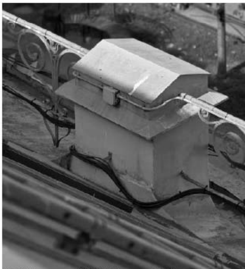
8. ВОКН «Особняк В.В. Долгоруковой (А.И. Шаховского)». Фрагмент карниза – металлическое ограждение ажурного рисунка с парпетным, гладко оштукатуренным, столбиком. Дата съемки: 25.08.2025г.
