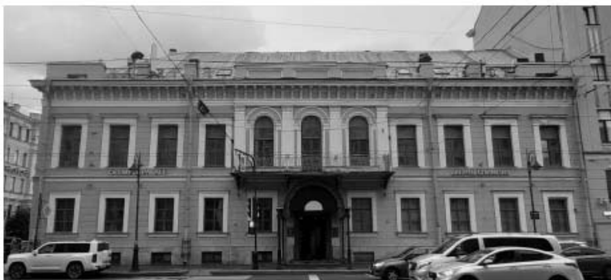
12. ВОКН «Особняк В.В. Долгоруковой (А.И. Шаховского)». Общий вид здания по Литейному проспекту – западный лицевой фасад. Дата дополнительной съемки: 22.09.2025г.
