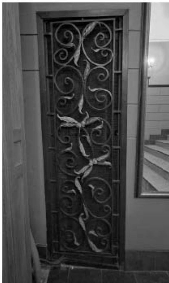
29. ВОКН «Особняк В.В. Долгоруковой (А.И. Шаховского)». Интерьеры 1-го этажа. Вестибюль. Вентрешетка. Дата съемки: 25.08.2025г.
