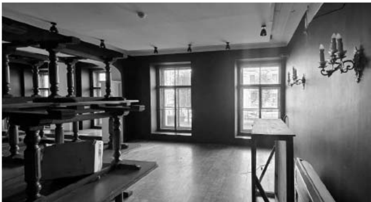
15. ВОКН «Особняк В.В. Долгоруковой (А.И. Шаховского)». Интерьеры 1-го этажа. Историческое месторасположение оконных проемов. Плоские перекрытия. Дата съемки: 25.08.2025г.
