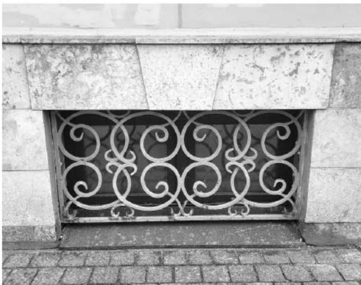
40. ВОКН «Особняк В.В. Долгоруковой (А.И. Шаховского)». Исторические оконные проемы на уровне повольного этажа. Оформление проемов – замковые камни. Дата дополнительной съемки: 22.09.2025г.
