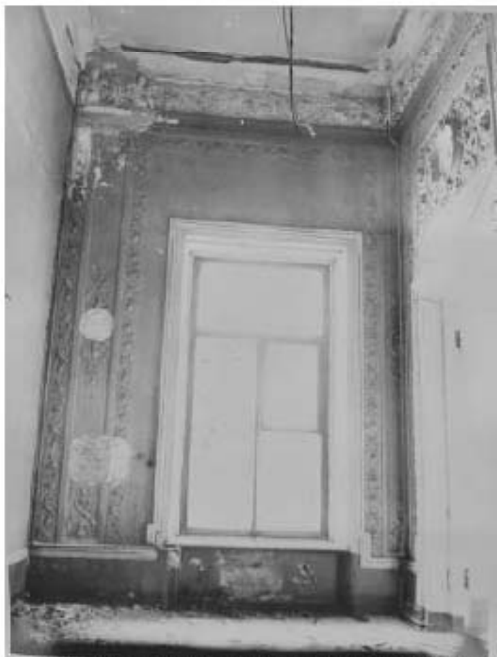
82. Особняк В.В. Долгоруковой (А.И. Шаховского). 2-й этаж. Помещение № 2. Вид на стену по оси А. 1988г. ЦГАНТД СПб. Ф. Р-488. Оп. 314. Д. 60. Л. 6.
