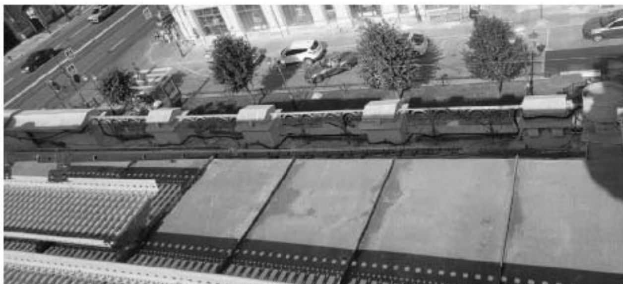
6. ВОКН «Особняк В.В. Долгоруковой (А.И. Шаховского)». Фрагмент крыши со стороны ул. Фурштатской. Фрагмент карниза – металлическое ограждение ажурного рисунка с парпетными, гладко оштукатуренными, столбиками. Дата съемки: 25.08.2025г.
