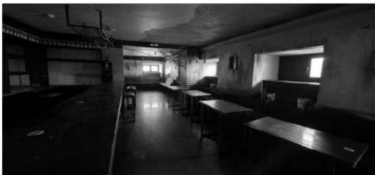
8. ВОКН «Особняк В.В. Долгоруковой (А.И. Шаховского)». Интерьеры подвала. Плоские перекрытия. Исторические оконные проемы. Дата съемки: 25.08.2025г.
