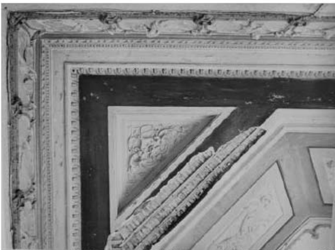
78. Особняк В.В. Долгоруковой (А.И. Шаховского). 2-й этаж. Помещение № 1. Фрагмент плафона между осями Б и Г. 1988г. ЦГАНТД СПб. Ф. Р-488. Оп. 314. Д. 60. Л. 2.
