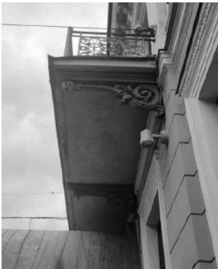
24. ВОКН «Особняк В.В. Долгоруковой (А.И. Шаховского)». Фрагмент балкон с ажурным кованным ограждением на металлических кронштейнах. Дата дополнительной съемки: 22.09.2025г.
