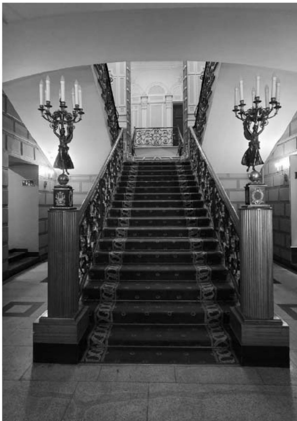
31. ВОКН «Особняк В.В. Долгоруковой (А.И. Шаховского)». Интерьеры 1-го этажа. Парадная лестница со ступенями из известняка и кованными ажурными металлическими ограждениями. Дата съемки: 25.08.2025г.
