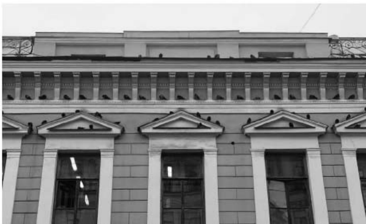
36. ВОКН «Особняк В.В. Долгоруковой (А.И. Шаховского)». Аттиковая стенка, фрагмент парапетной решетки, фрагмент венчающего профилированного карниза с модульонами. Дата дополнительной съемки: 22.09.2025г.
