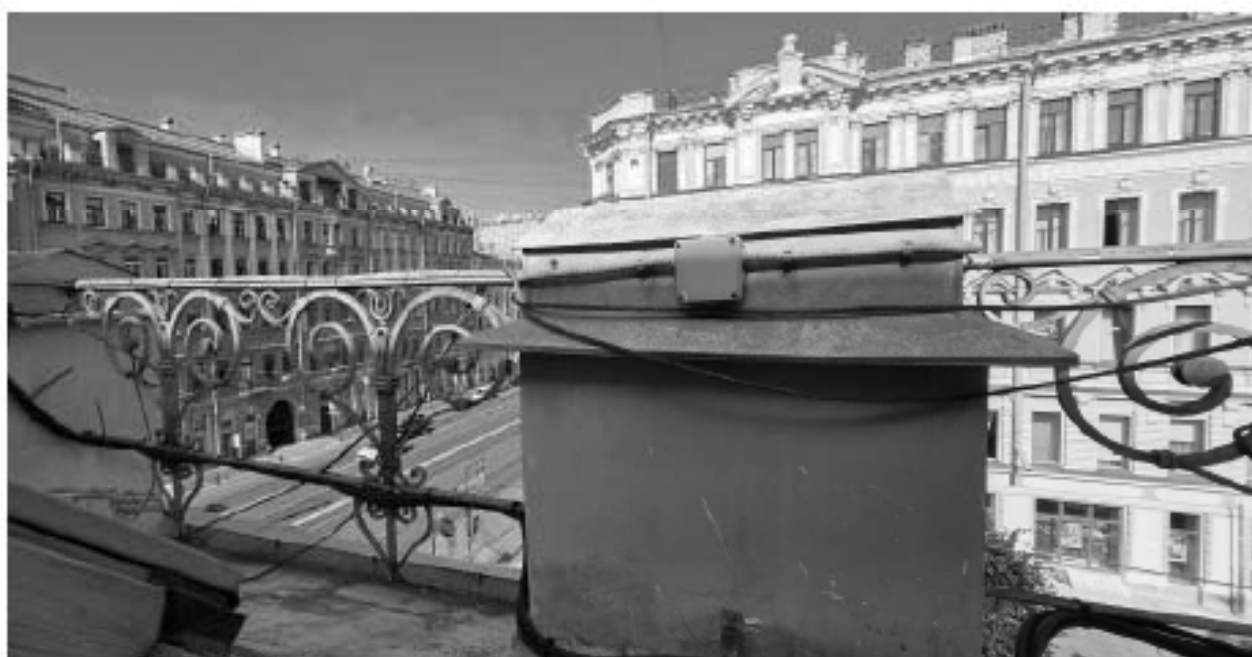
10. ВОКН «Особняк В.В. Долгоруковой (А.И. Шаховского)». Фрагмент карниза – металлическое ограждение ажурного рисунка с парпетными, гладко оштукатуренными, столбиками. Дата съемки: 25.08.2025г.
