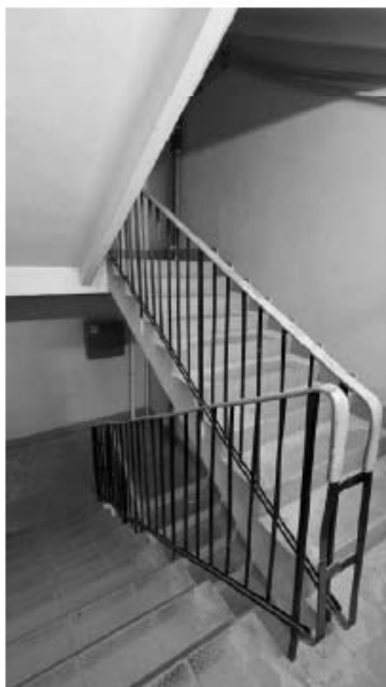
106. ВОКН «Особняк В.В. Долгоруковой (А.И. Шаховского)». Интерьеры 3-го этажа. Лестница со ступенями, облицованными керамической плиткой и ограждением простого рисунка. Дата съемки: 25.08.2025г.
