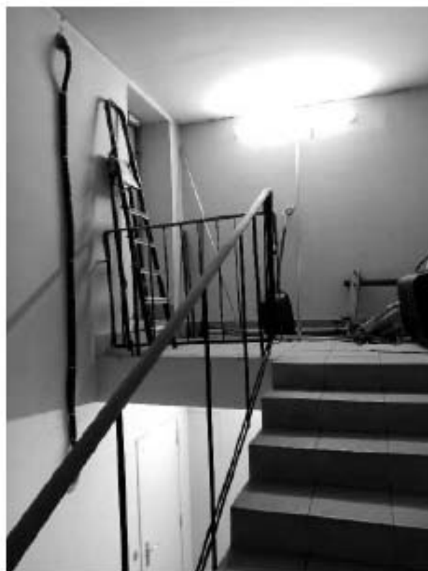
119. ВОКН «Особняк В.В. Долгоруковой (А.И. Шаховского)». Выход на кровлю. Дата съемки: 25.08.2025г.
