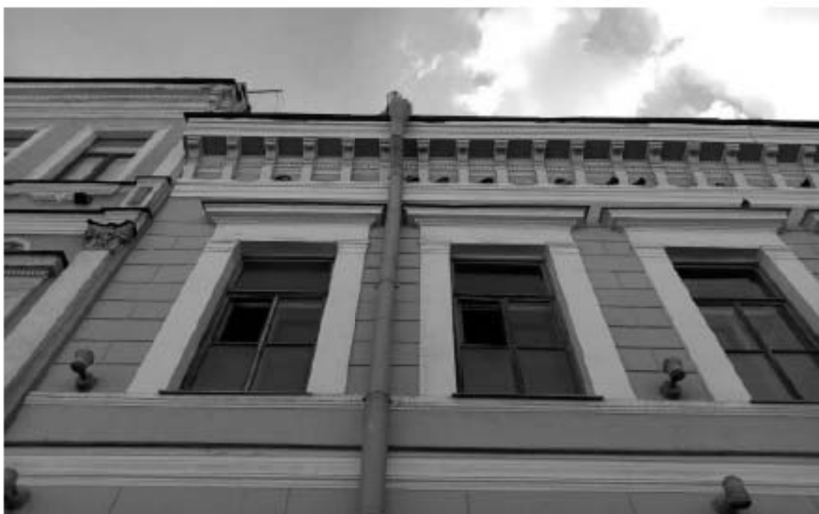
31. ВОКН «Особняк В.В. Долгоруковой (А.И. Шаховского)». Фрагмент венчающего профилированного карниза с модульонами. Оформление оконных проемов гладкими наличниками. Профилированные карнизы. Дата съемки: 25.08.2025г.
