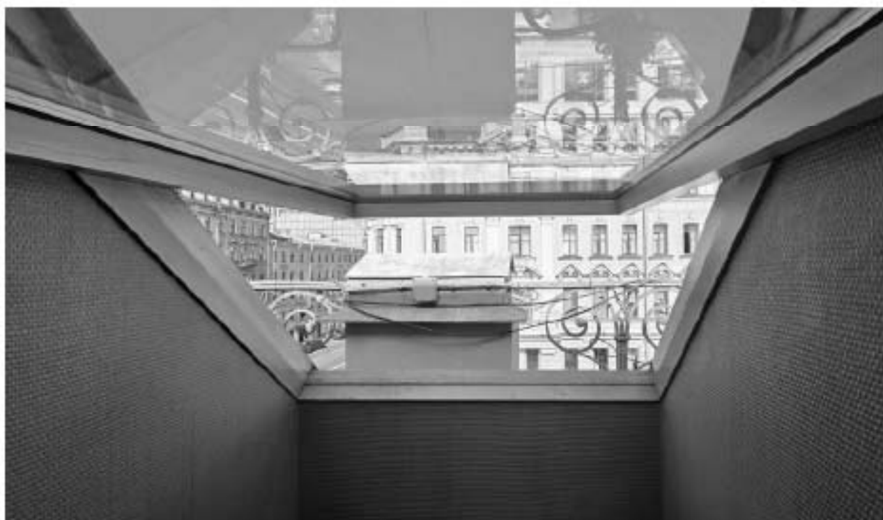
111. ВОКН «Особняк В.В. Долгоруковой (А.И. Шаховского)». Интерьеры 4-го этажа и мансарды. Мансардное окно. Дата съемки: 25.08.2025г.
