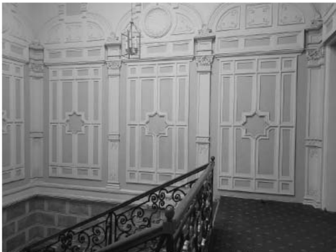
41. ВОКН «Особняк В.В. Долгоруковой (А.И. Шаховского)». Интерьеры 2-го этажа. Пространство парадной лестницы. Лепной декор (пилястры стилизованного ордера, фигурные филенки). Дата съемки: 25.08.2025г.
