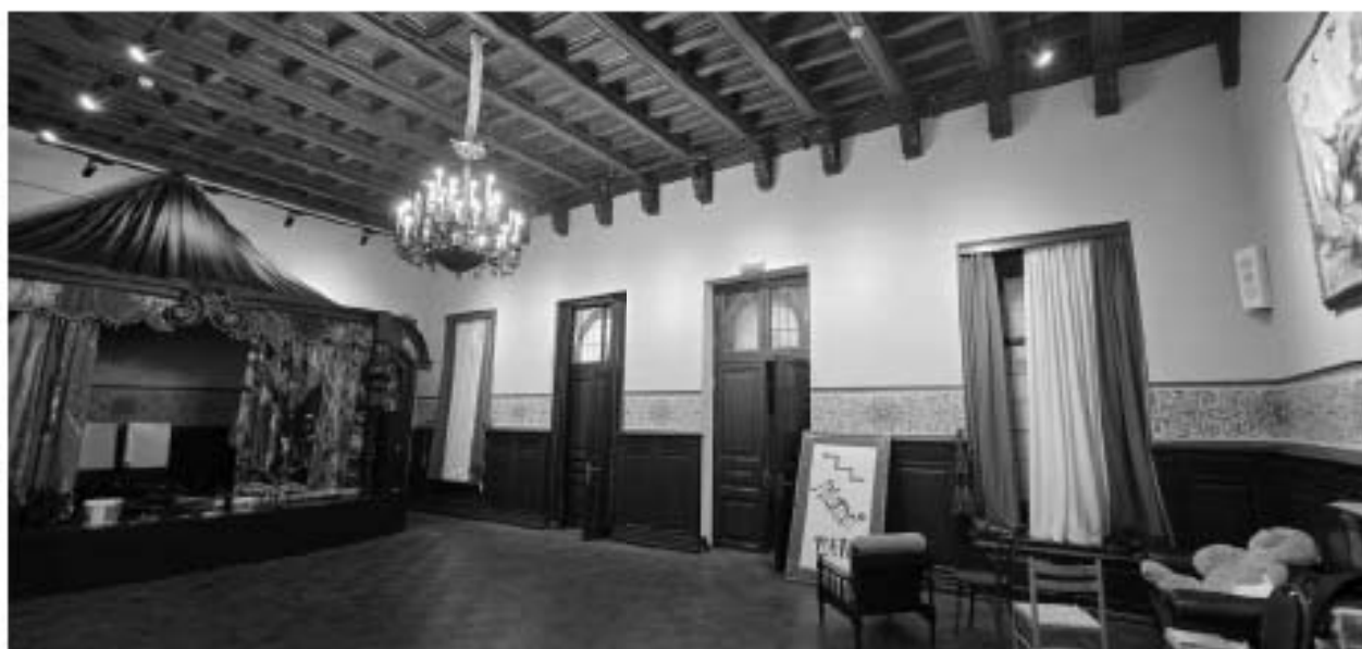
57. ВОКН «Особняк В.В. Долгоруковой (А.И. Шаховского)». Интерьеры 2-го этажа. Общий вид помещения. Деревянный кессонированный потолок. Нижний ярус стен облицован деревянными кессонированными панелями. Дата съемки: 25.08.2025г.
