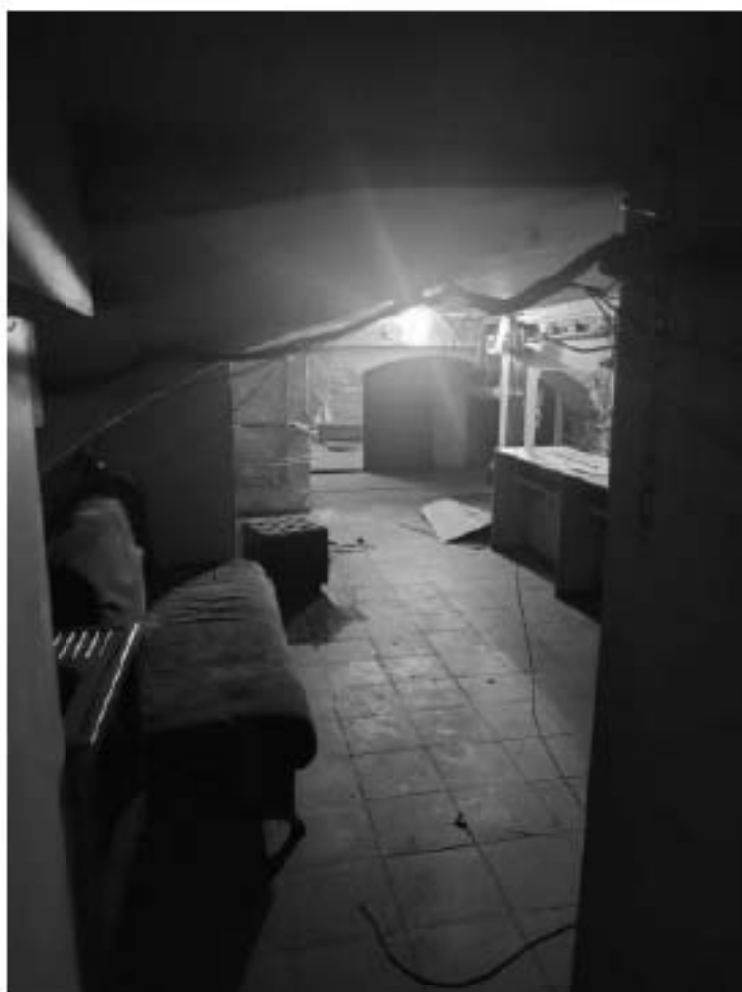
3. ВОКН «Особняк В.В. Долгоруковой (А.И. Шаховского)». Интерьеры подвала. Внутренний конструктивный элемент – свод (цилиндрический на распалубках). Дата съемки: 25.08.2025г.
