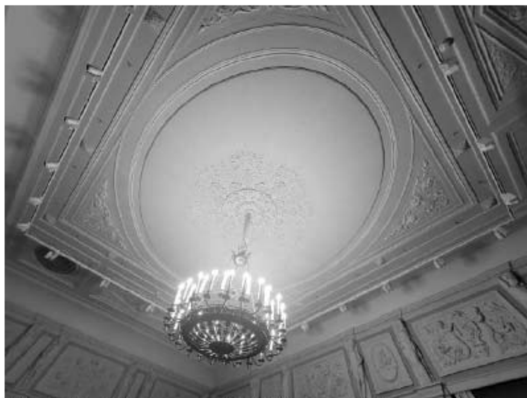
70. ВОКН «Особняк В.В. Долгоруковой (А.И. Шаховского)». Интерьеры 2-го этажа. Плафон потолка. Падуга по периметру потолка. Дата съемки: 25.08.2025г.
