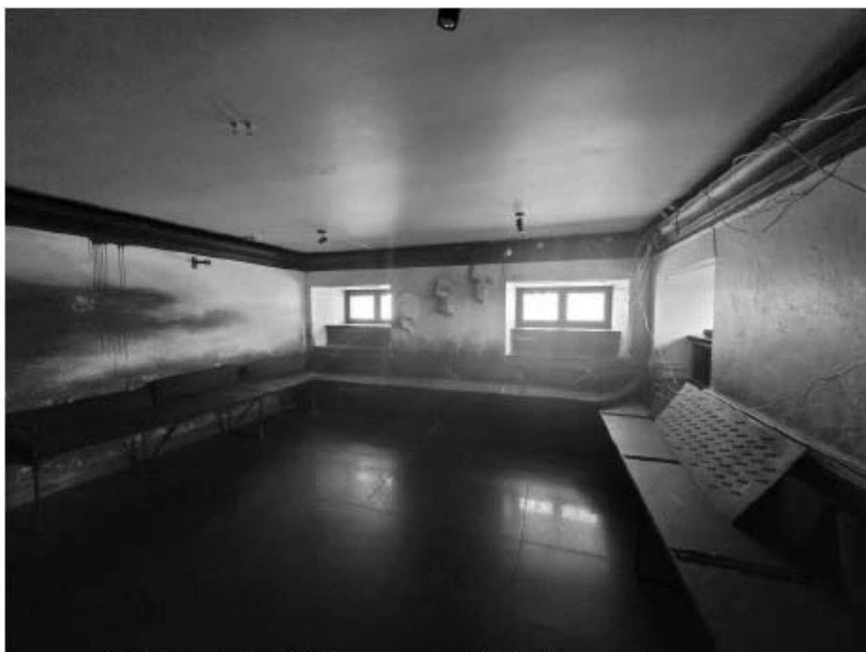
10. ВОКН «Особняк В.В. Долгоруковой (А.И. Шаховского)». Интерьеры подвала. Плоские перекрытия. Исторические оконные проемы. Дата съемки: 25.08.2025г.
