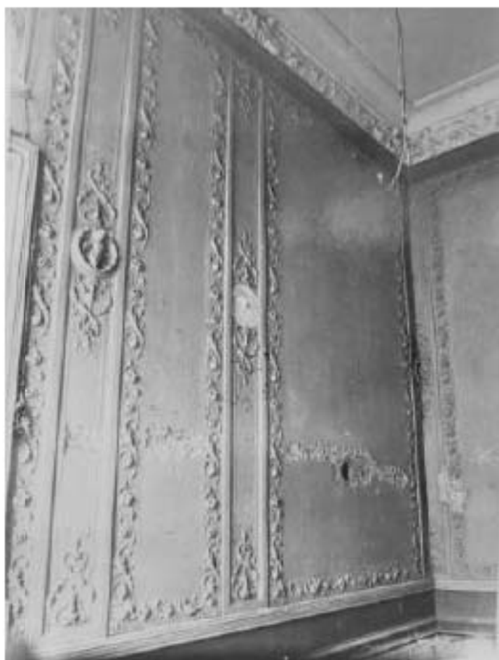
83. Особняк В.В. Долгоруковой (А.И. Шаховского). 2-й этаж. Помещение № 2. Стена по оси 2. 1988г. ЦГАНТД СПб. Ф. Р-488. Оп. 314. Д. 60. Л. 7.
