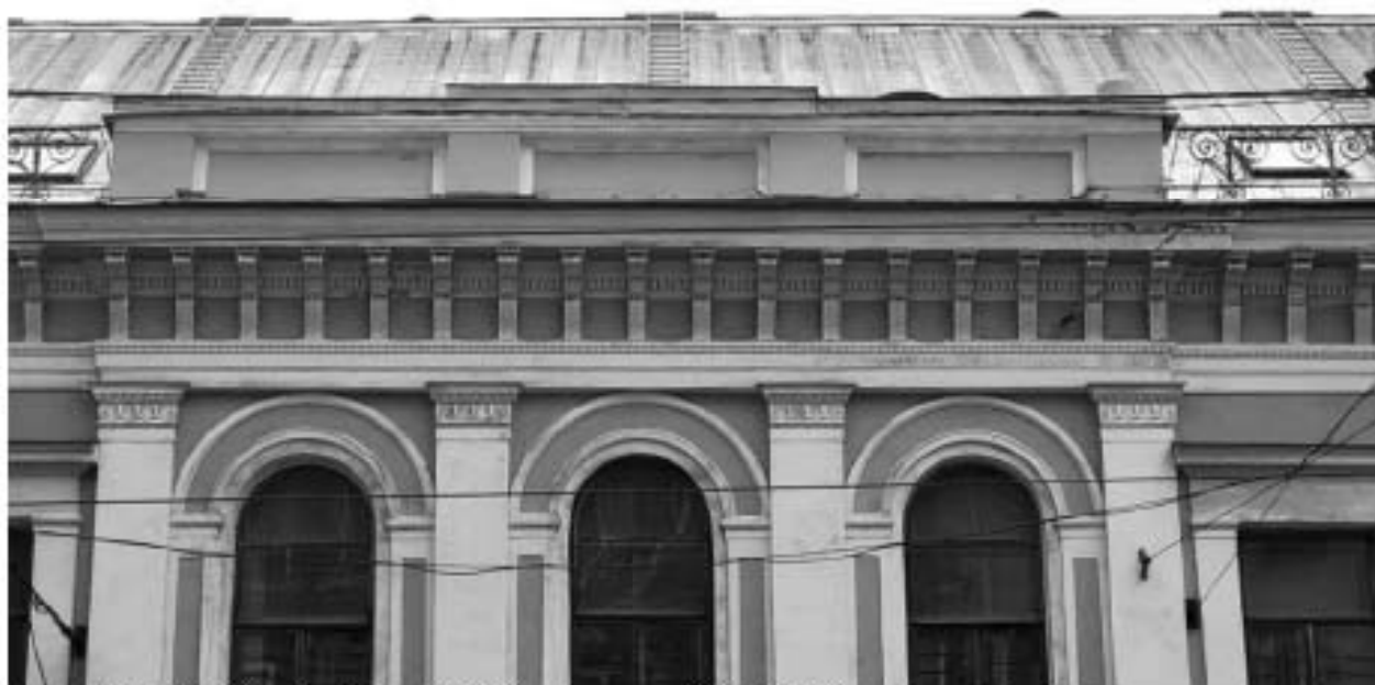
38. ВОКН «Особняк В.В. Долгоруковой (А.И. Шаховского)». Фрагмент венчающего профилированного карниза с модульонами. Аттиковая стенка. Фрагмент парапетной решетки. Дата дополнительной съемки: 22.09.2025г.
