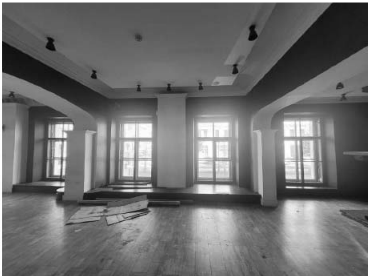
17. ВОКН «Особняк В.В. Долгоруковой (А.И. Шаховского)». Интерьеры 1-го этажа. Историческое месторасположение оконных проемов. Плоские перекрытия. Дата съемки: 25.08.2025г.
