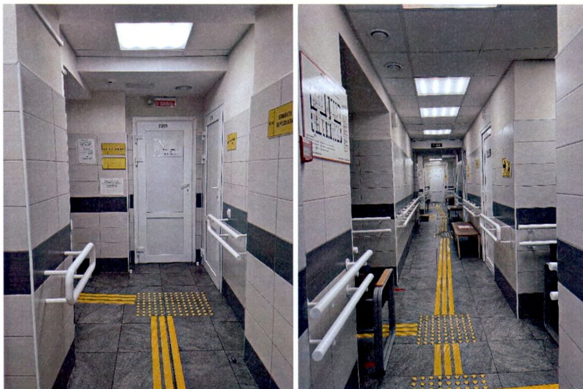
Фото 21, 22. Помещения объекта культурного наследия.
