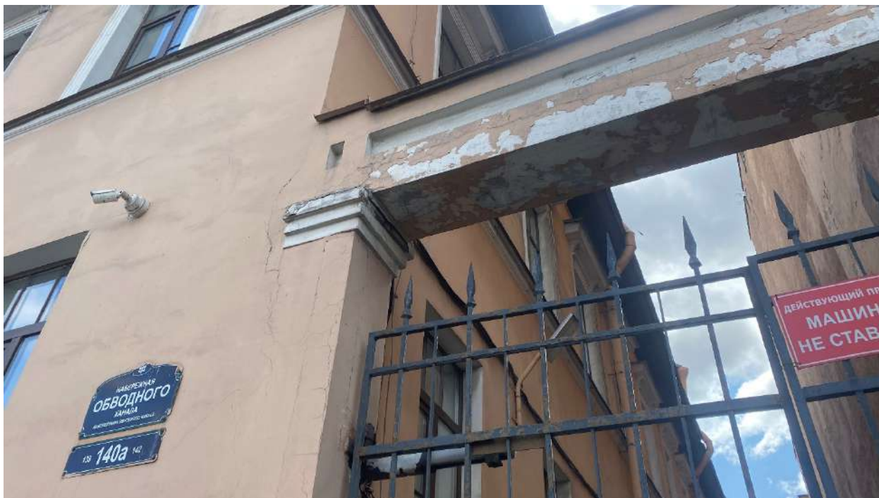
Фото 11. Общее состояние арки. Дата фотофиксации: 26.09.2025г.
