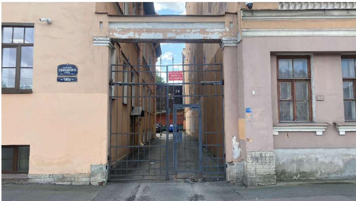
Фото 9. Общее состояние арки. Дата фотофиксации: 26.09.2025г.
