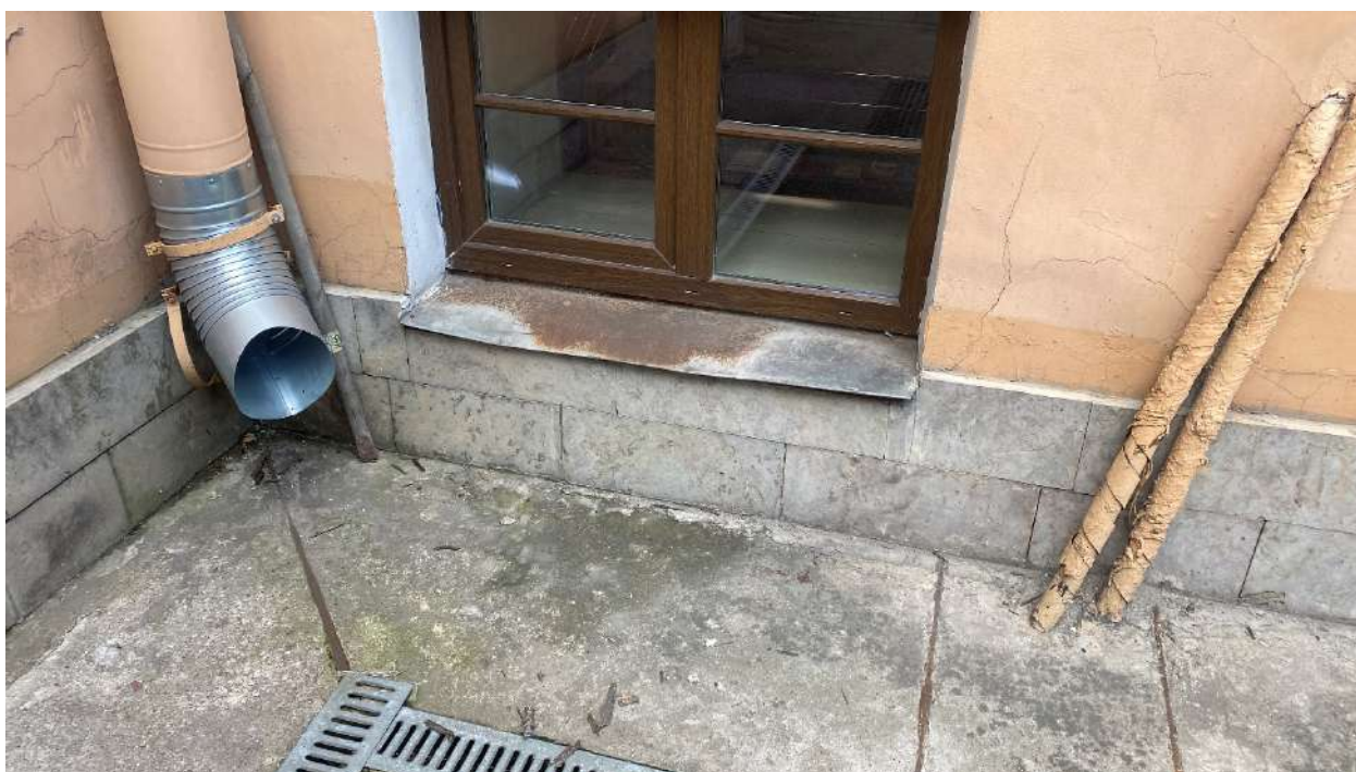
Фото 14. Общее состояние цоколя. Дата фотофиксации: 26.09.2025г.
