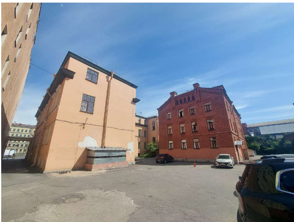
Фото 44. Общие виды на объект. Дата фотофиксации: 26.09.2025г.
