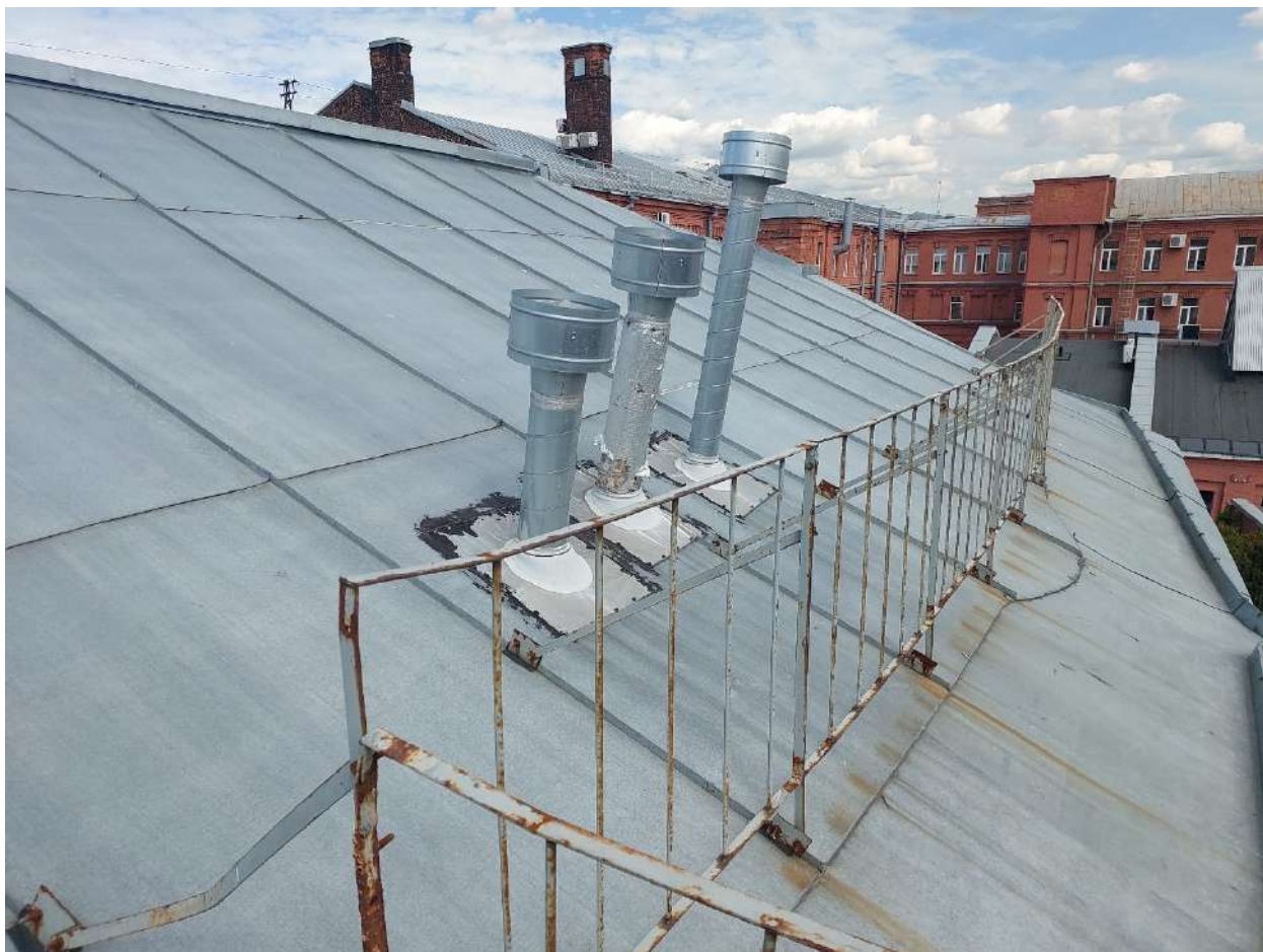
Фото 31. Общее состояния кровельного покрытия дворового корпуса. Дата фотофиксации: 26.09.2025г.
