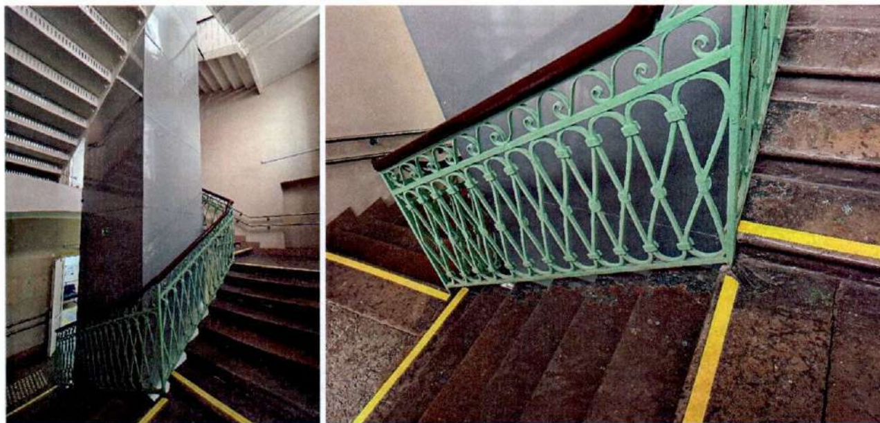
Фото 32, 33. Лестница Л-5 объекта культурного наследия.
