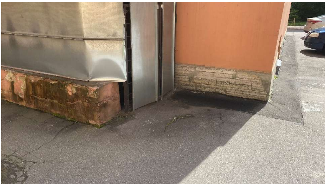
Фото 18. Общее состояние цоколя. Дата фотофиксации: 26.09.2025г.
