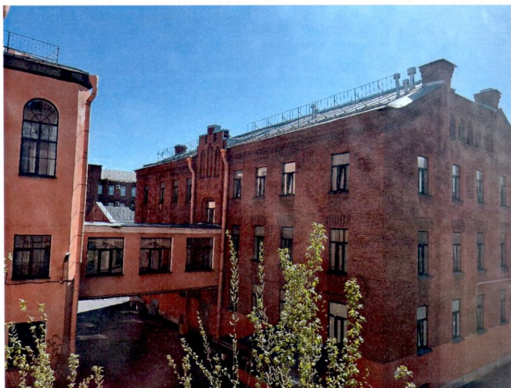
Фото 23. Общий вид на кровлю объекта культурного наследия.
