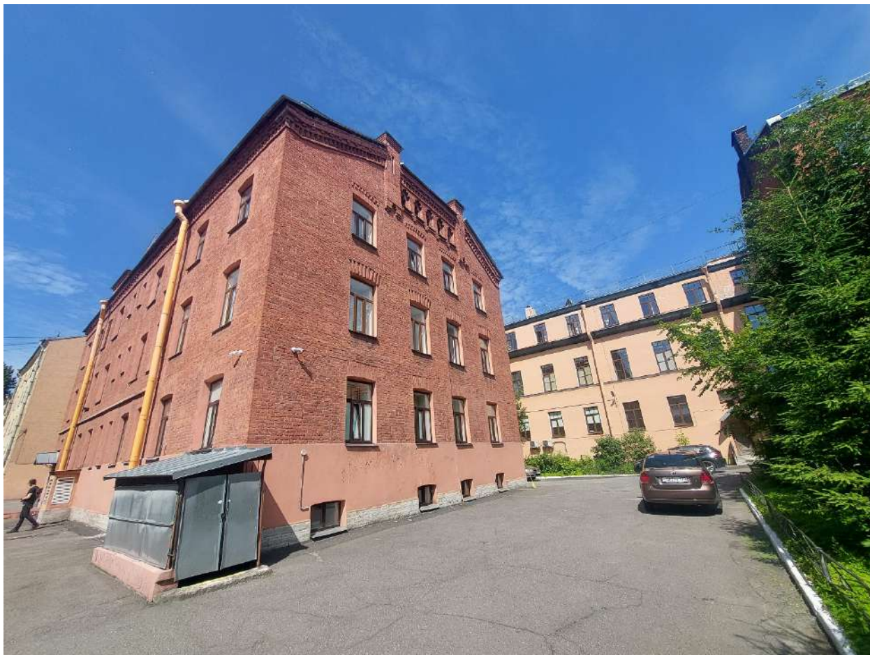
Фото 43. Общие виды на объект. Дата фотофиксации: 26.09.2025г.
