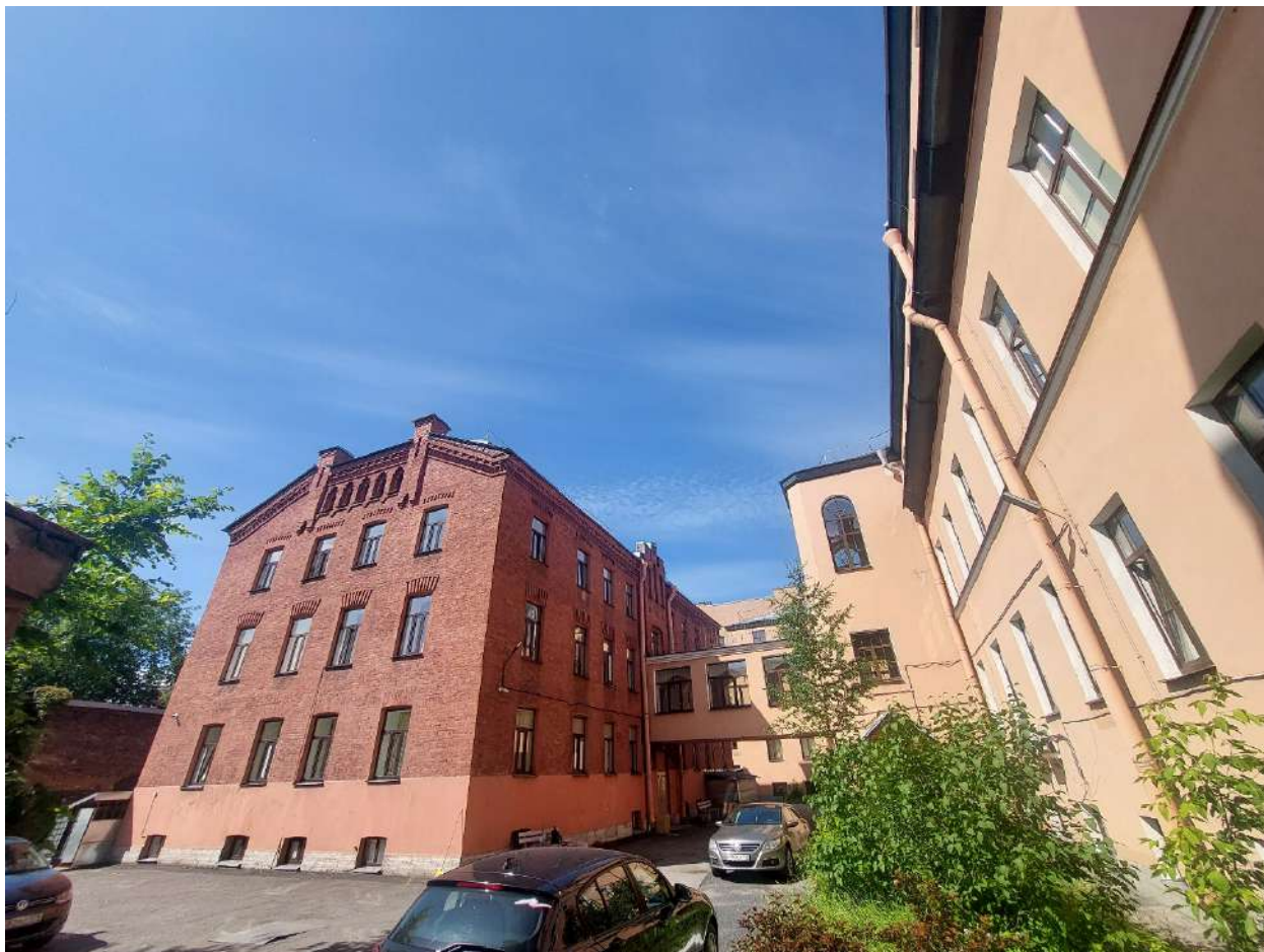
Фото 45. Общие виды на объект. Дата фотофиксации: 26.09.2025г.
