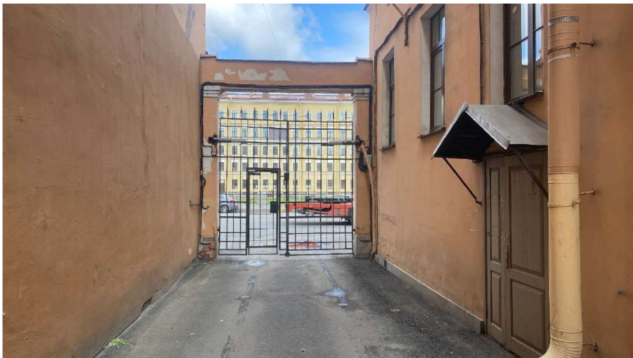
Фото 13. Общие виды на объект. Дата фотофиксации: 26.09.2025г.
