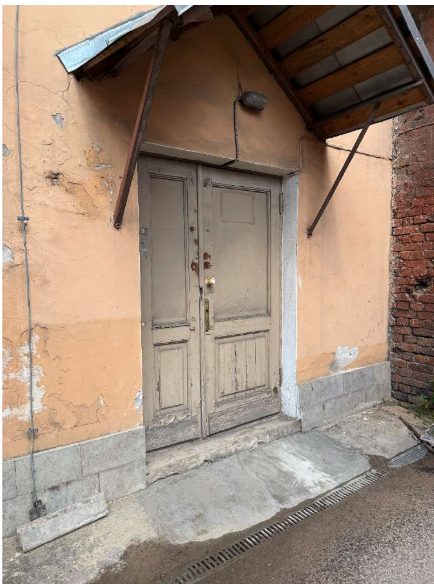
Фото 19. Дверное заполнение на фасаде. Дата фотофиксации: 26.09.2025г.
