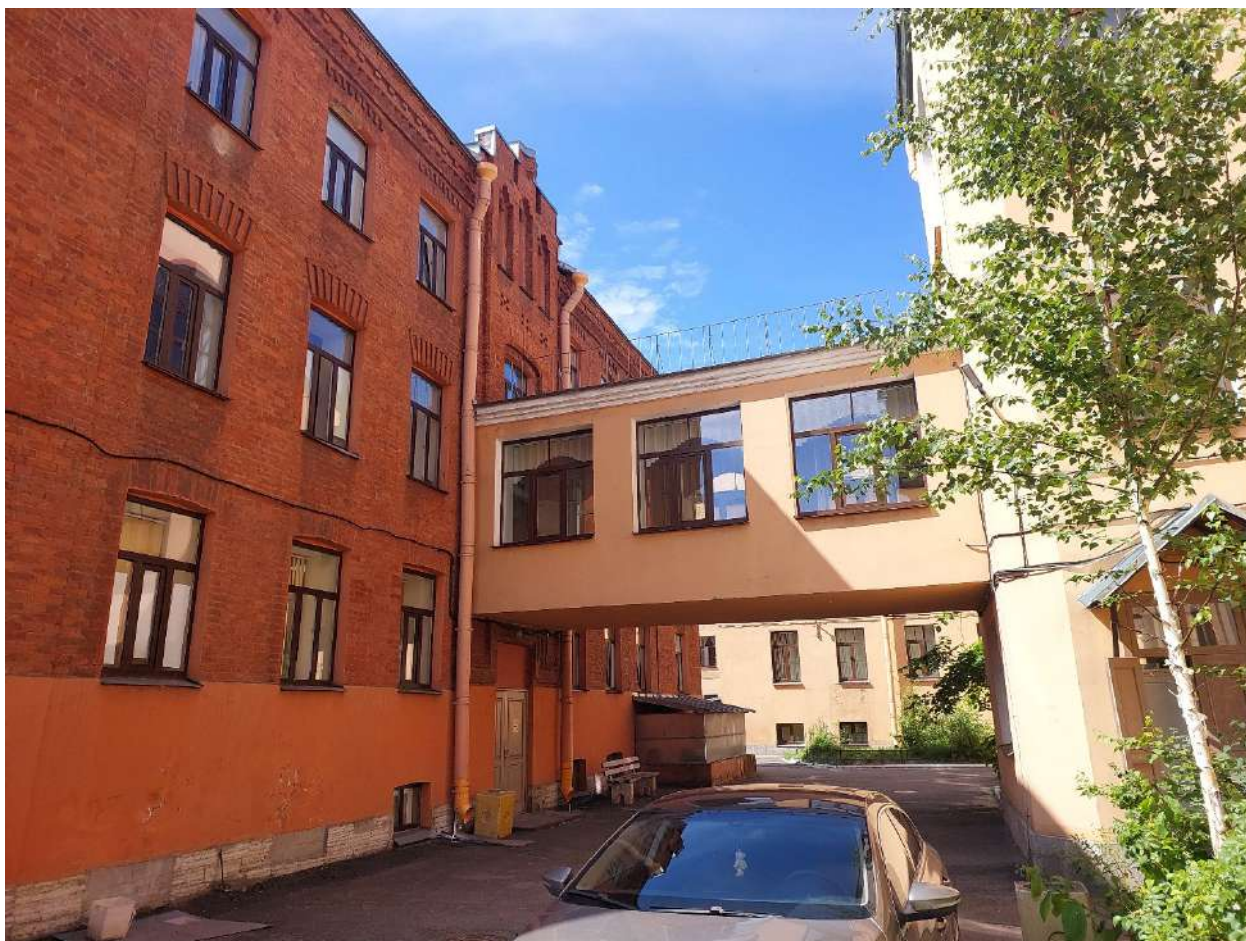
Фото 41. Общий вид на дворовой корпус объекта. Дата фотофиксации: 26.09.2025г.
