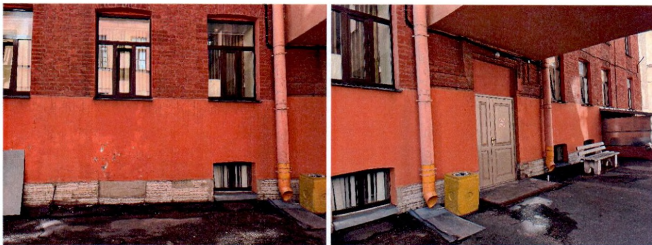
Фото 2, 3. Фрагменты северного фасада объекта культурного наследия.
