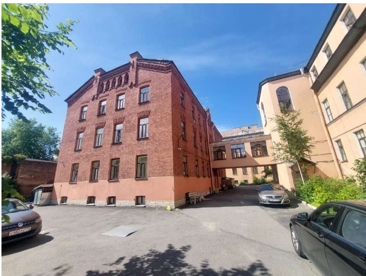
Фото 42. Общие виды на объект. Дата фотофиксации: 26.09.2025г.
