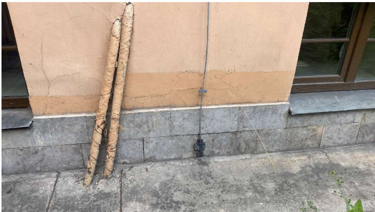
Фото 15. Общее состояние цоколя. Дата фотофиксации: 26.09.2025г.
