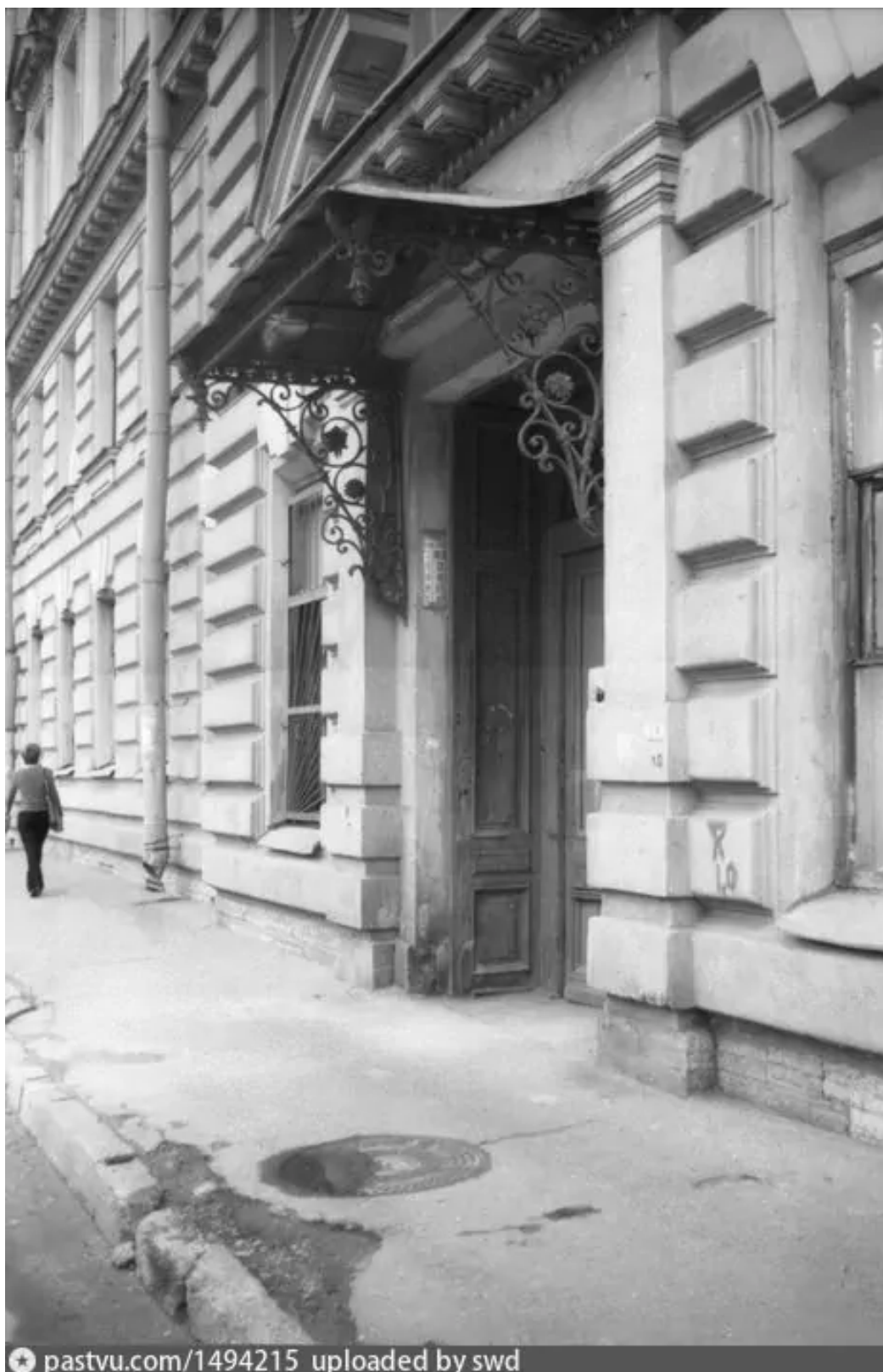
58. Набережная канала Грибоедова, 71. Доходный дом Ратькова-Рожнова. Лицевой фасад по набережной канала Грибоедова. Портал парадного входа (правый). Вид с показом кронштейнов металлического козырька. Фотография. Автор фото – Доспехов Сергей Владимирович. 2000 г. // Источник: https://pastvu.com/p/1494215 (дата обращения: 13.06.2024).
