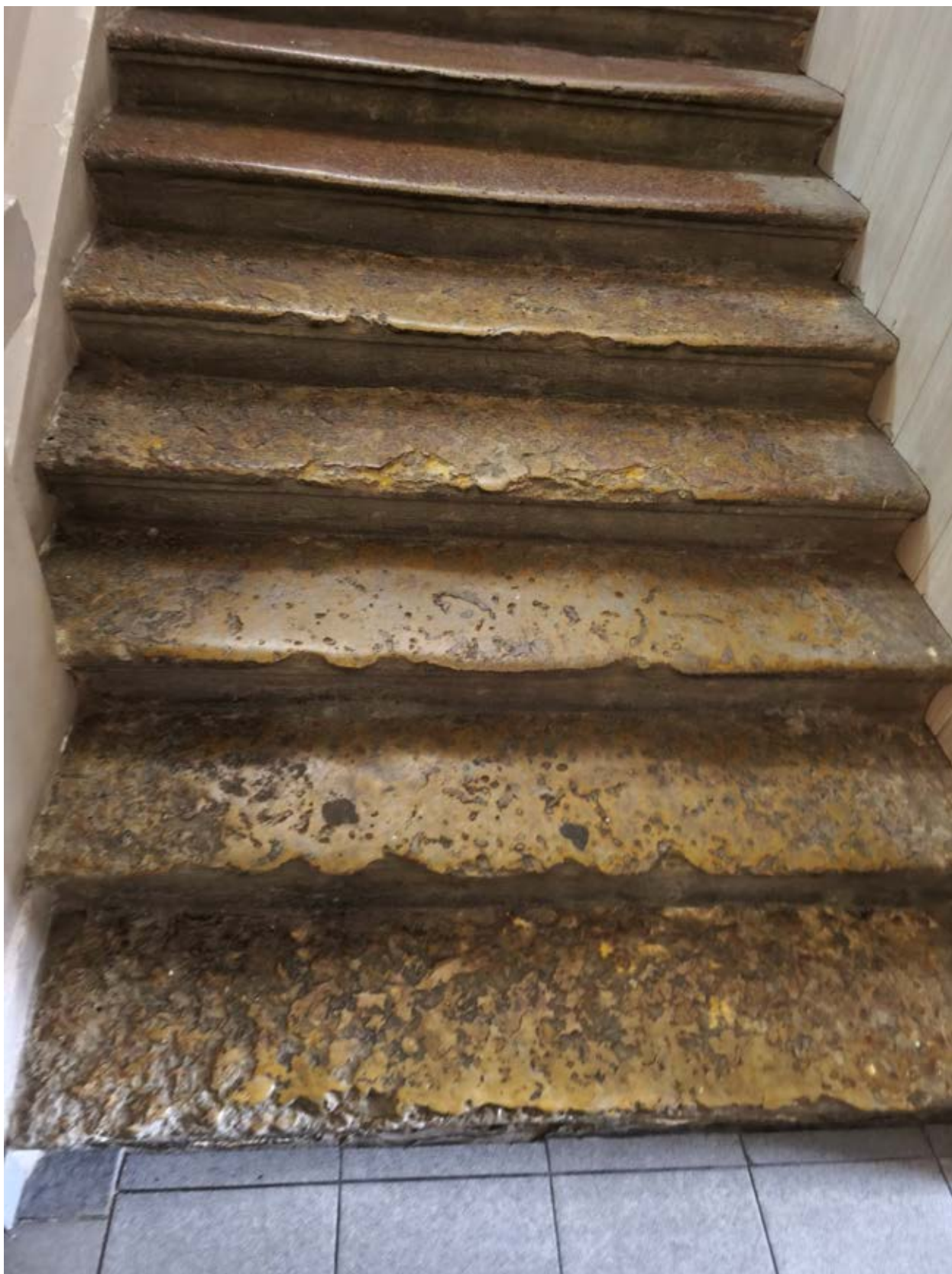
Фото 12. Фрагмент главной лестницы. Дефекты ступеней;
