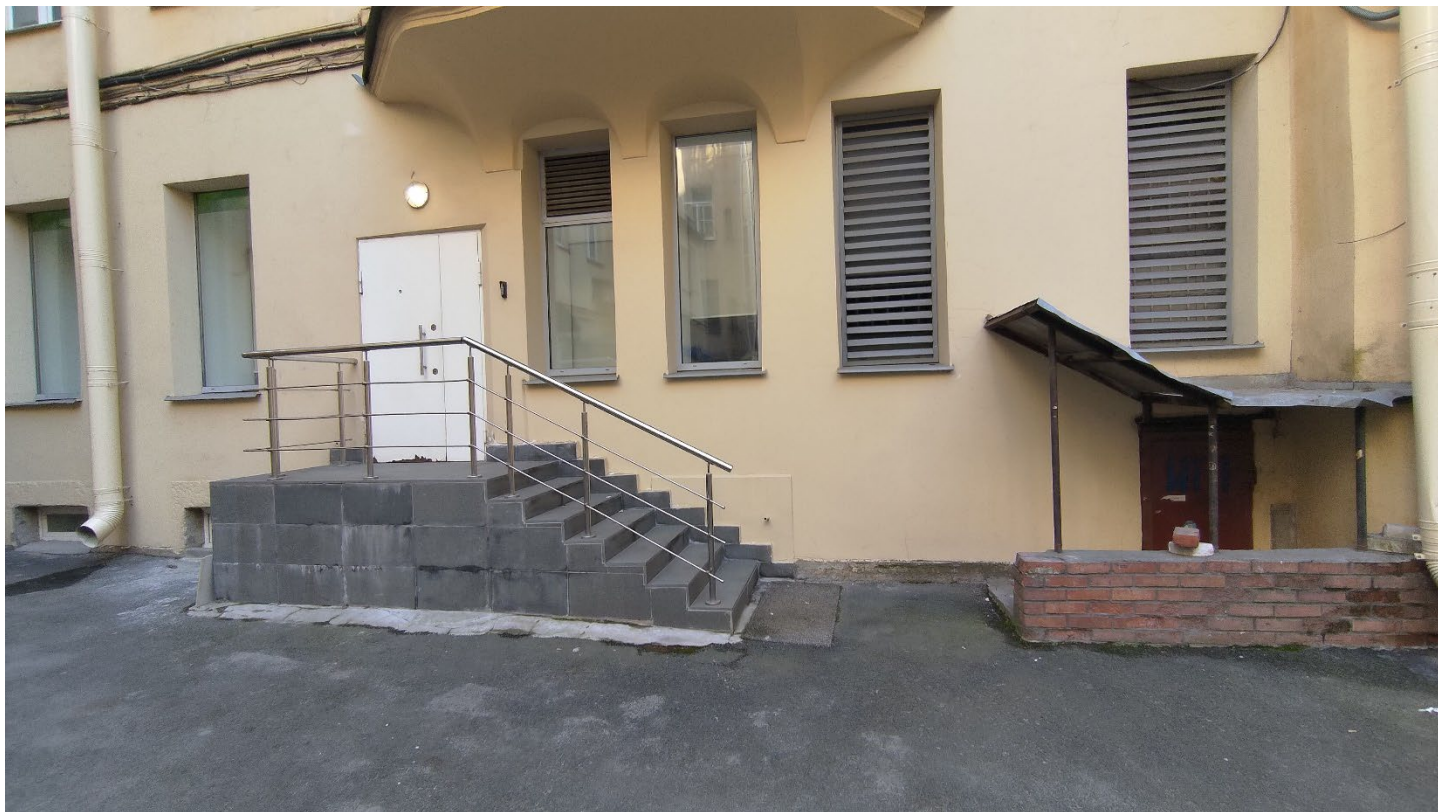
Фото 5. Дворовый фасад, фрагмент. Дата фотофиксации: 09.04.25
