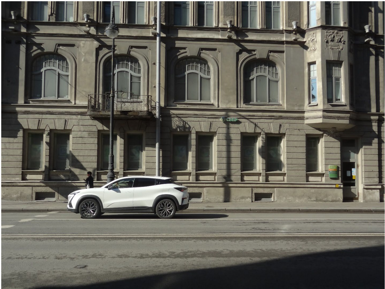
Фото 3. Оконные заполнения в уровне первого этажа с северной стороны. Общий вид. Дата фотофиксации: 09.04.25
