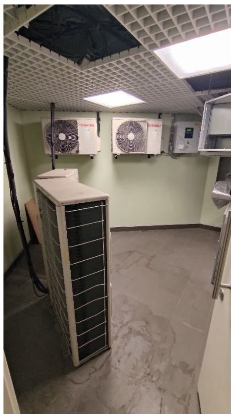
Фото 18. Помещение 23. Общий вид. Дата фотофиксации: 09.04.25
