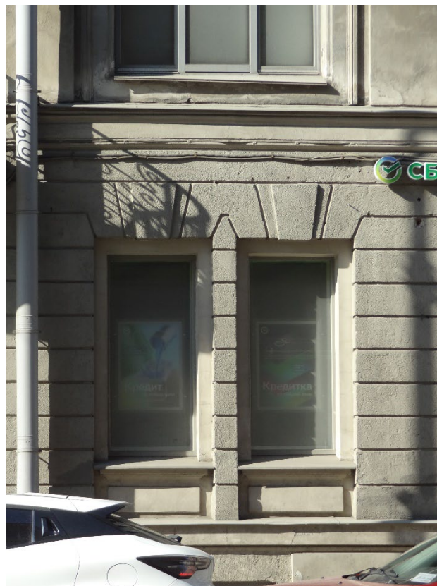
Фото 4. Оконные проемы лицевого фасада. Дата фотофиксации: 09.04.25
