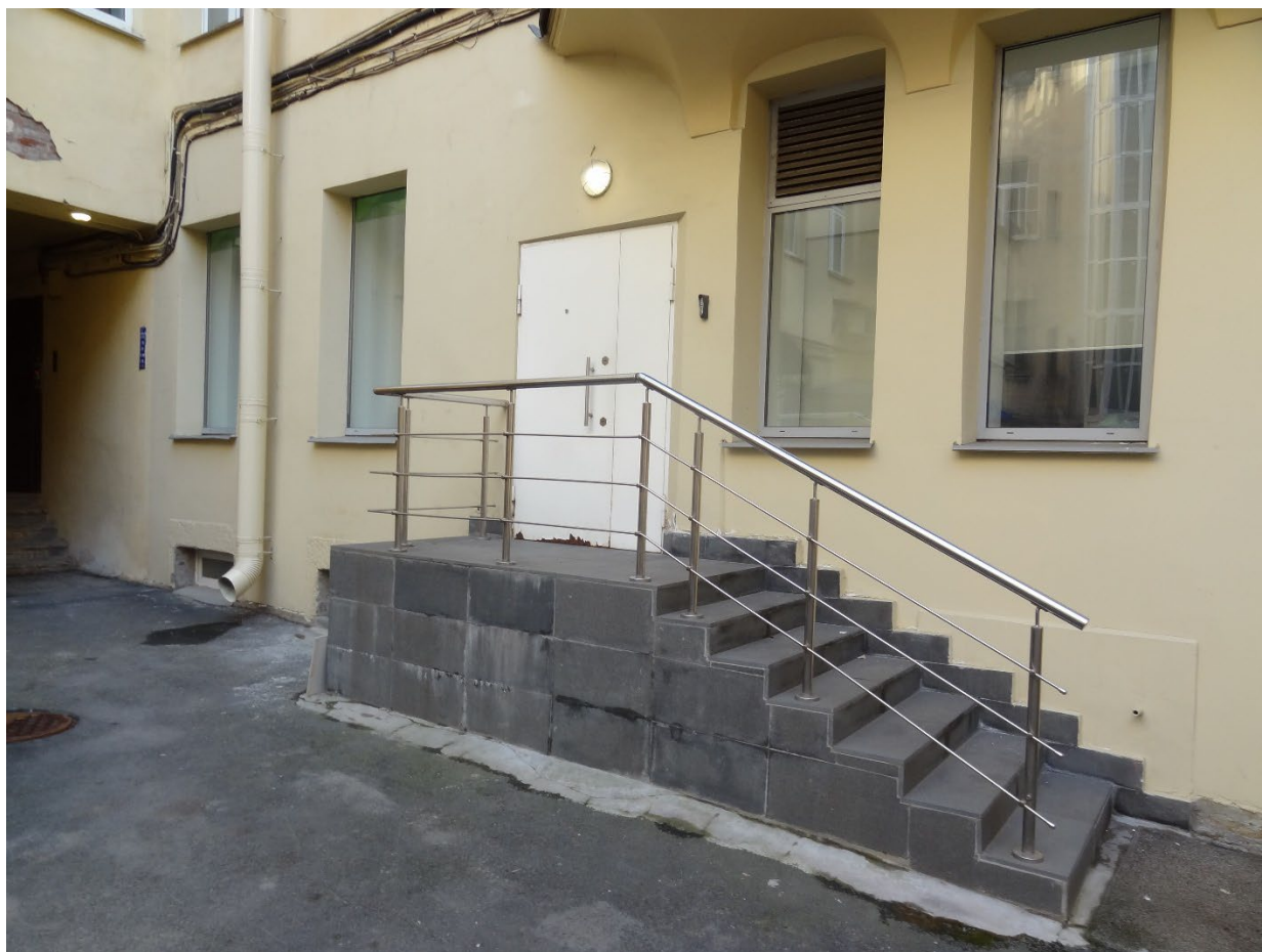
Фото 6. Крыльцо дворового фасада. Общий вид. Дата фотофиксации: 09.04.25
