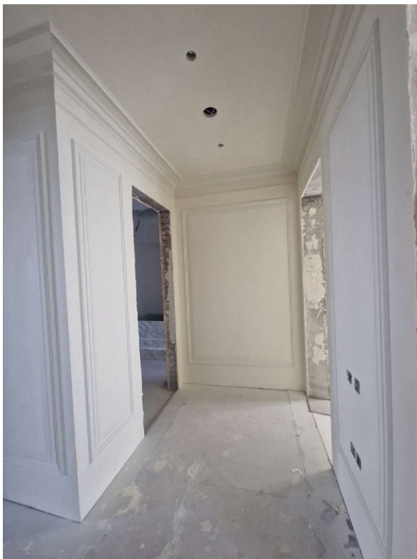
Фото 5. Общий вид на часть рассматриваемого помещения в границах объекта культурного наследия
