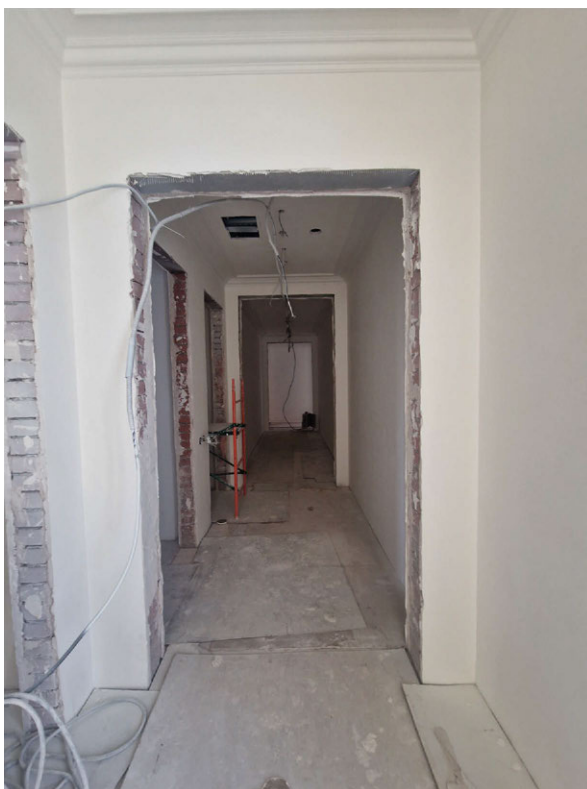
Фото 25. Общий вид на часть рассматриваемого помещения в границах объекта культурного наследия
