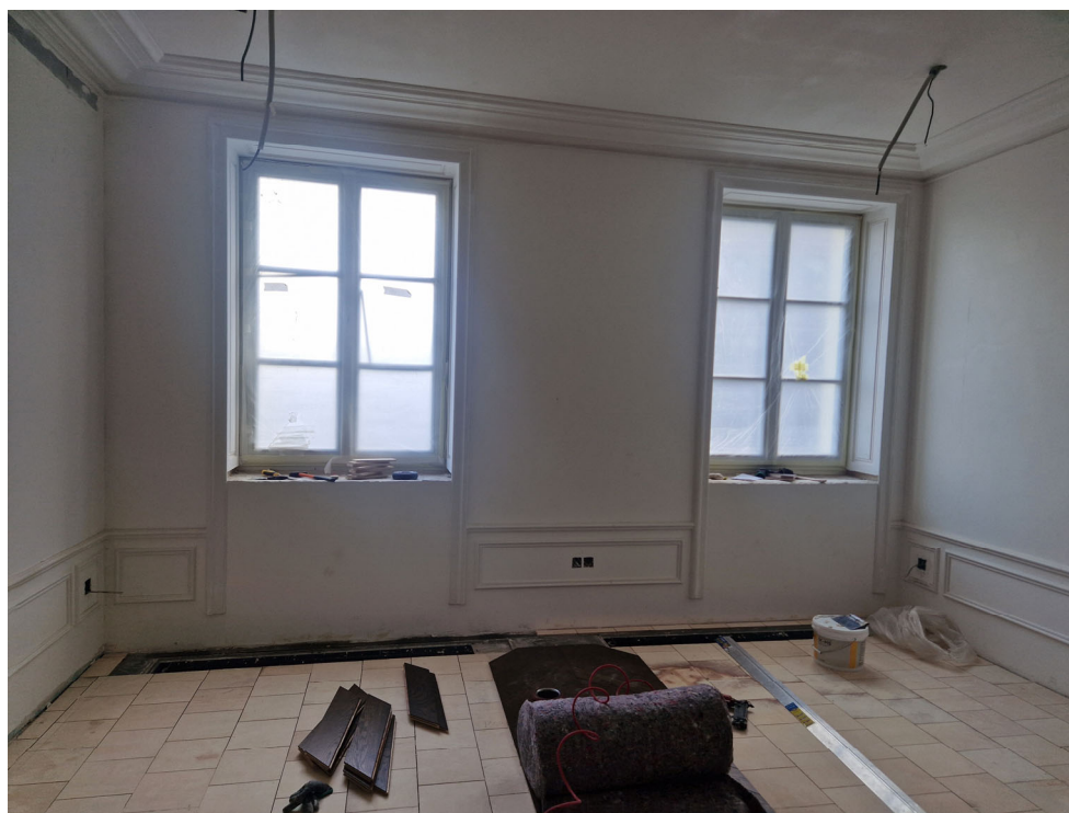
Фото 64. Общий вид на часть рассматриваемого помещения в границах объекта культурного наследия
