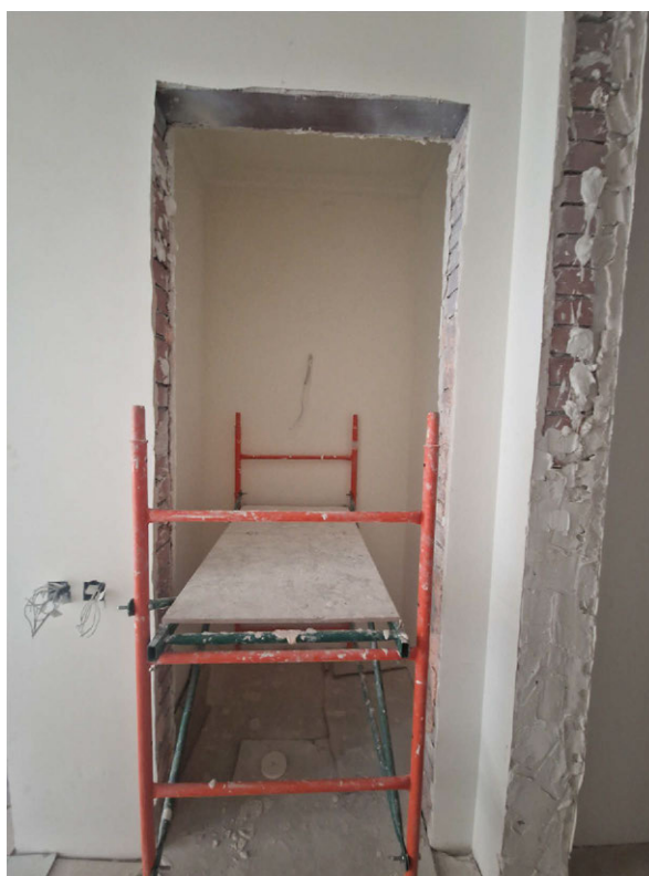
Фото 28. Общий вид на часть рассматриваемого помещения в границах объекта культурного наследия
