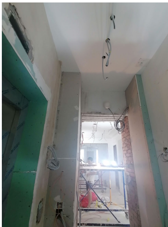
Фото 54. Общий вид на часть рассматриваемого помещения в границах объекта культурного наследия
