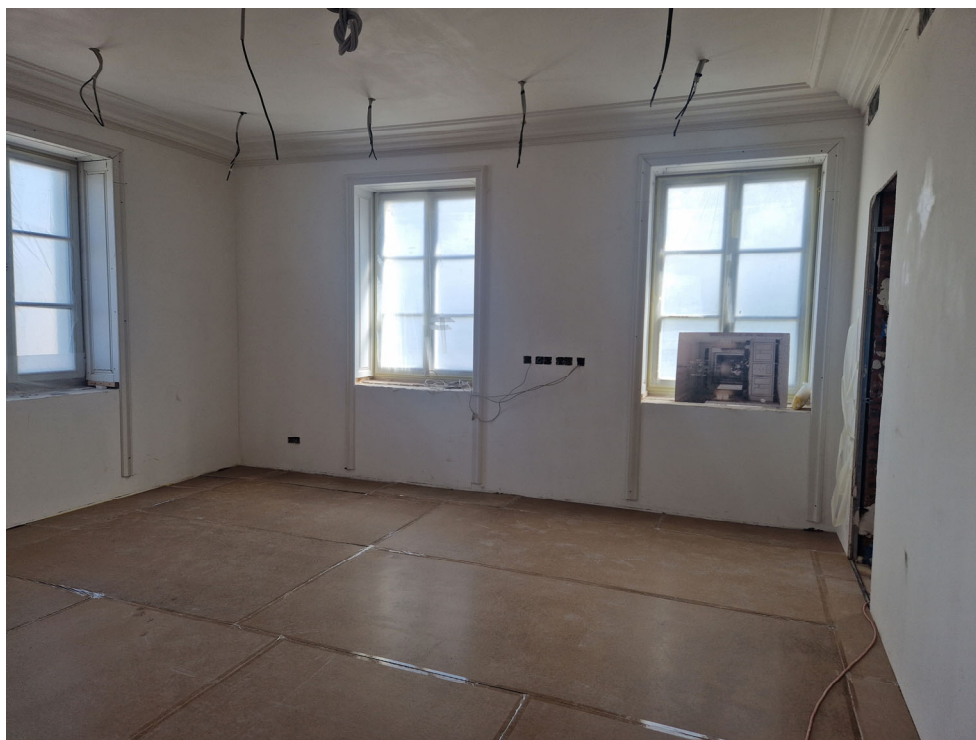
Фото 47. Общий вид на часть рассматриваемого помещения в границах объекта культурного наследия
