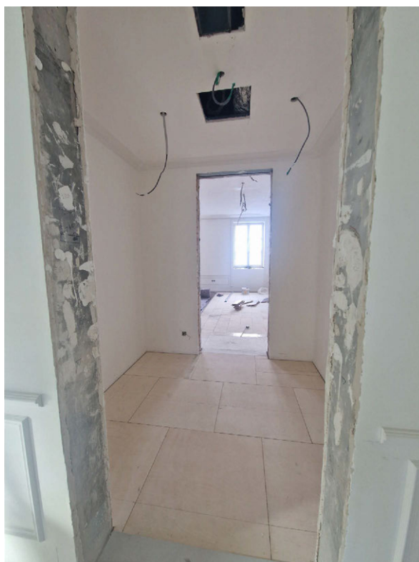
Фото 70. Общий вид на часть рассматриваемого помещения в границах объекта культурного наследия
