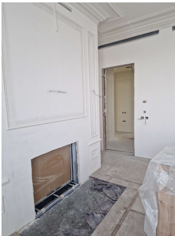
Фото 9. Общий вид на часть рассматриваемого помещения в границах объекта культурного наследия
