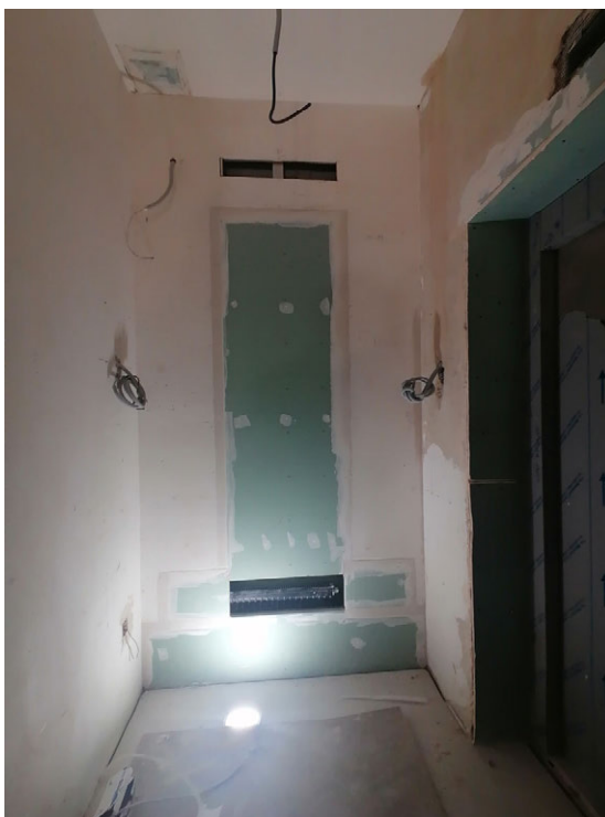
Фото 55. Общий вид на часть рассматриваемого помещения в границах объекта культурного наследия
