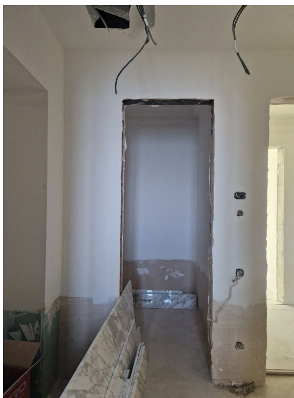
Фото 12. Общий вид на часть рассматриваемого помещения в границах объекта культурного наследия
