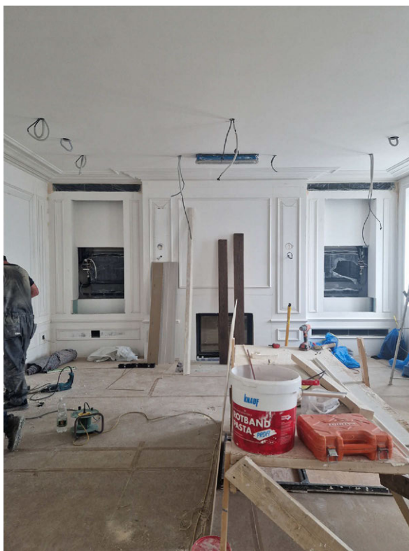
Фото 61. Общий вид на часть рассматриваемого помещения в границах объекта культурного наследия
