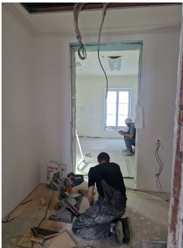
Фото 67. Общий вид на часть рассматриваемого помещения в границах объекта культурного наследия
