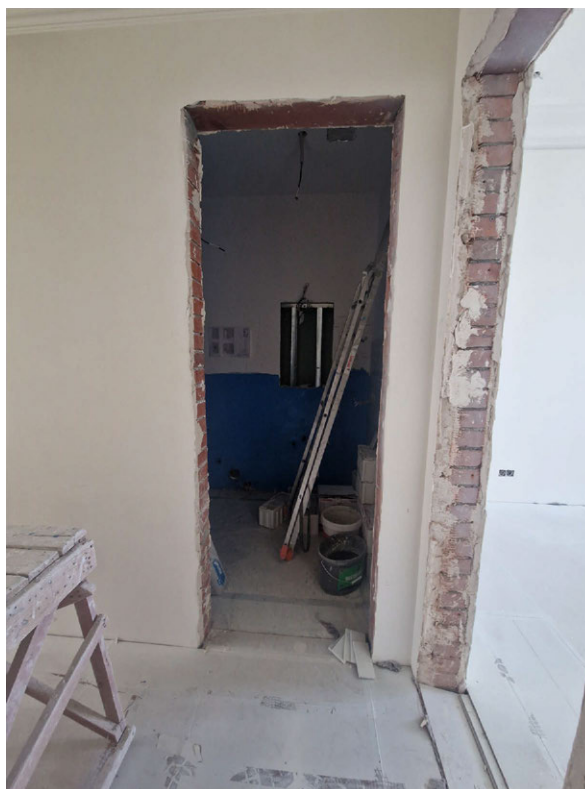
Фото 31. Общий вид на часть рассматриваемого помещения в границах объекта культурного наследия
