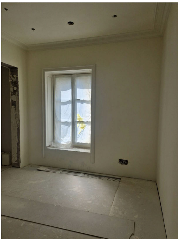
Фото 19. Общий вид на часть рассматриваемого помещения в границах объекта культурного наследия
