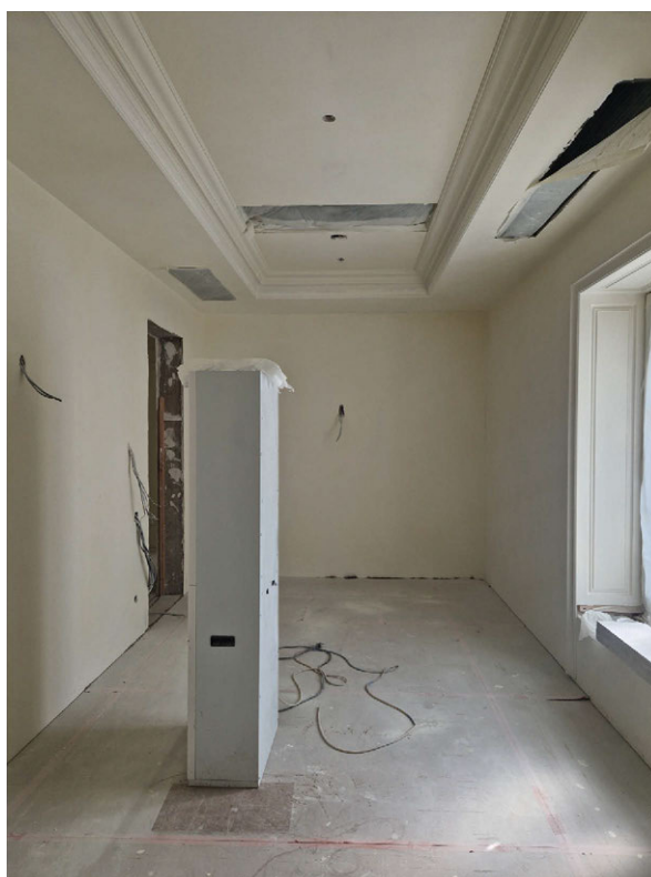
Фото 2. Общий вид на часть рассматриваемого помещения в границах объекта культурного наследия
