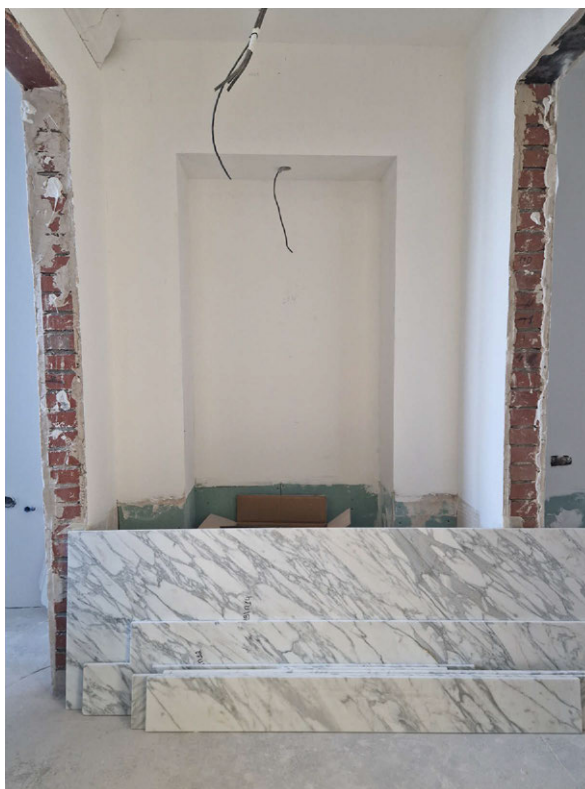
Фото 11. Общий вид на часть рассматриваемого помещения в границах объекта культурного наследия
