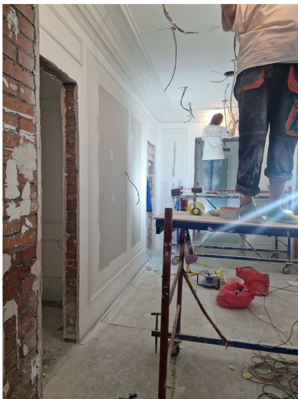
Фото 57. Общий вид на часть рассматриваемого помещения в границах объекта культурного наследия
