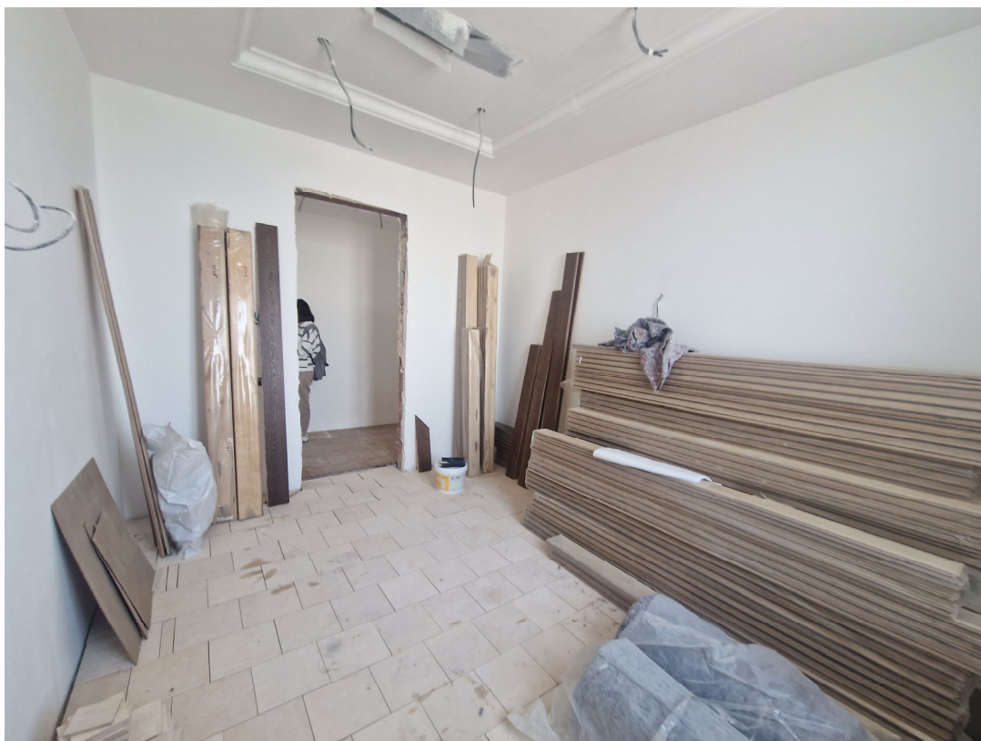
Фото 45. Общий вид на часть рассматриваемого помещения в границах объекта культурного наследия
