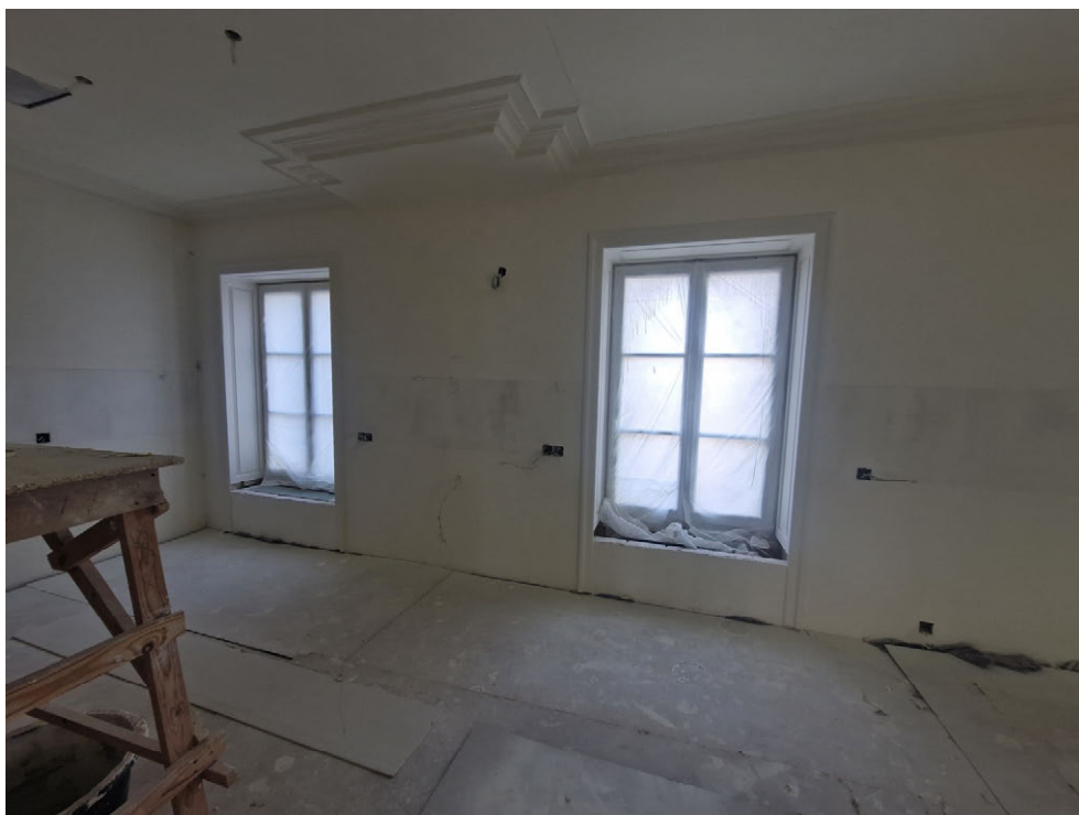
Фото 69. Общий вид на часть рассматриваемого помещения в границах объекта культурного наследия
