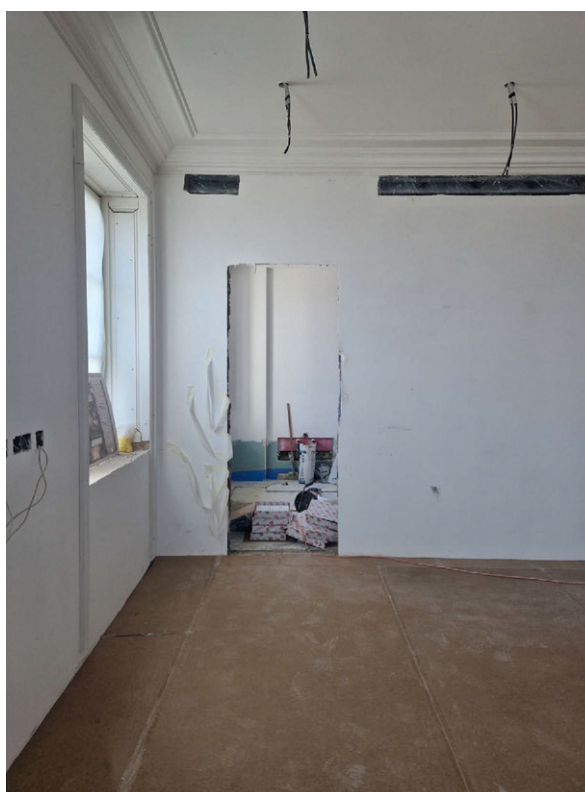
Фото 48. Общий вид на часть рассматриваемого помещения в границах объекта культурного наследия
