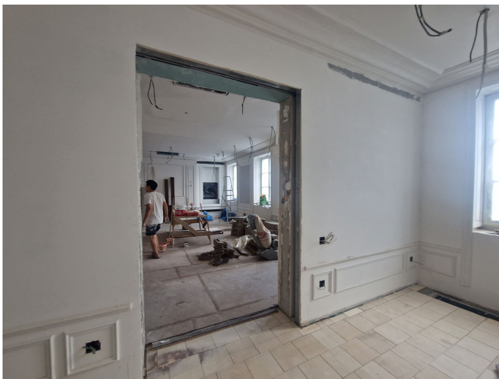
Фото 66. Общий вид на часть рассматриваемого помещения в границах объекта культурного наследия
