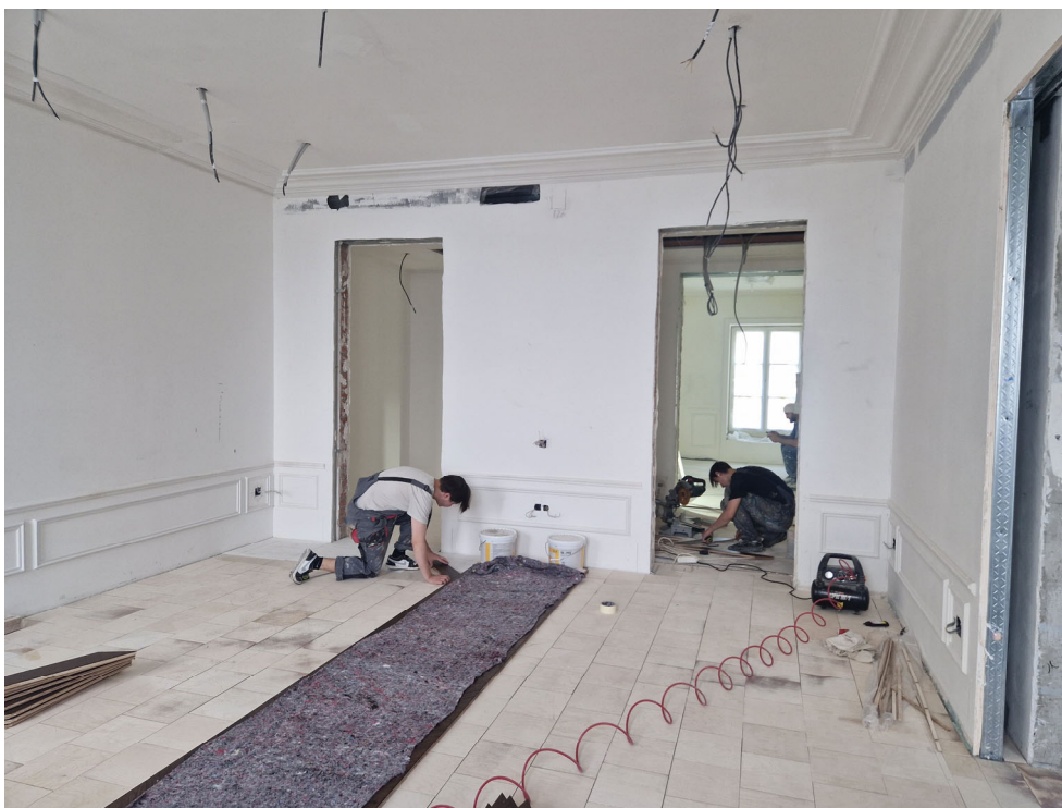
Фото 65. Общий вид на часть рассматриваемого помещения в границах объекта культурного наследия
