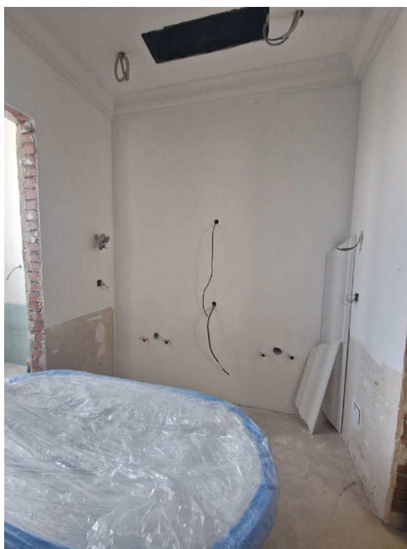
Фото 14. Общий вид на часть рассматриваемого помещения в границах объекта культурного наследия
