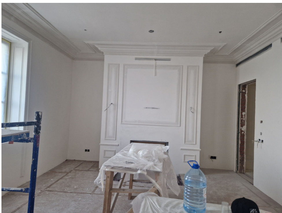
Фото 8. Общий вид на часть рассматриваемого помещения в границах объекта культурного наследия
