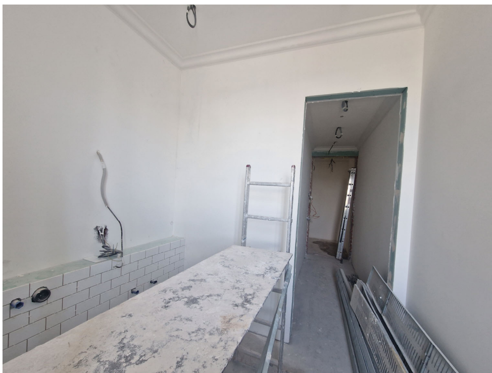
Фото 38. Общий вид на часть рассматриваемого помещения в границах объекта культурного наследия
