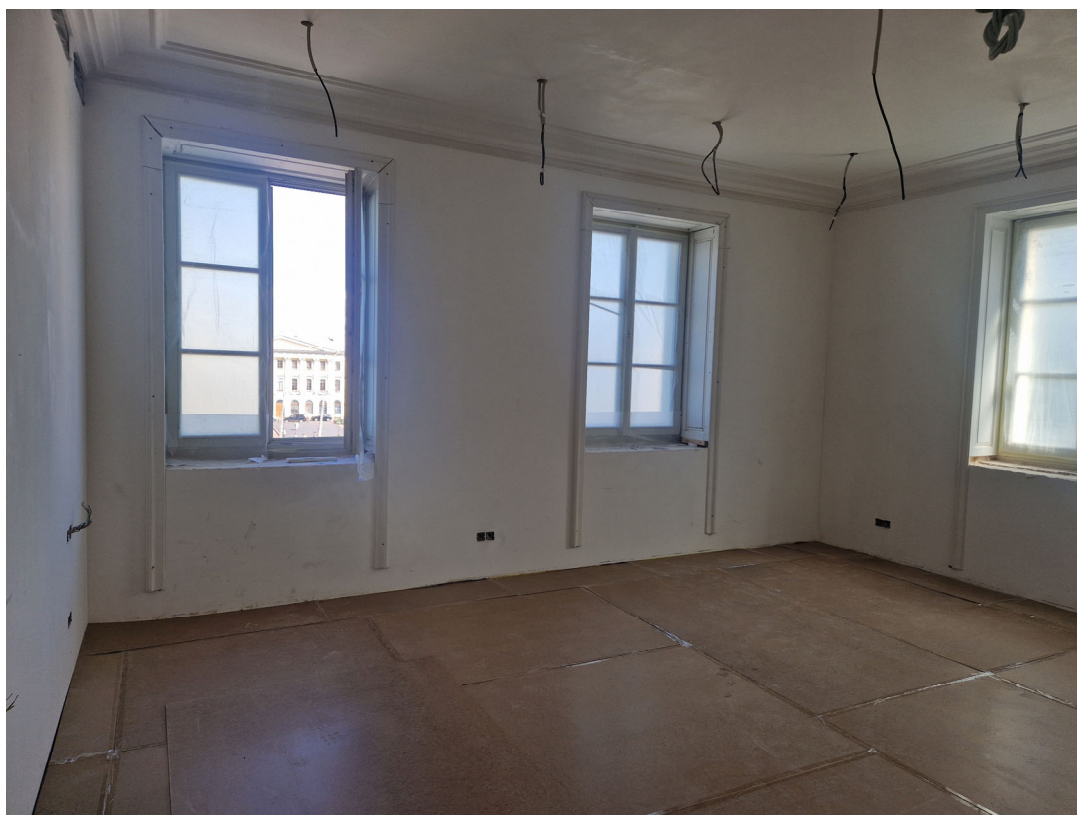
Фото 46. Общий вид на часть рассматриваемого помещения в границах объекта культурного наследия
