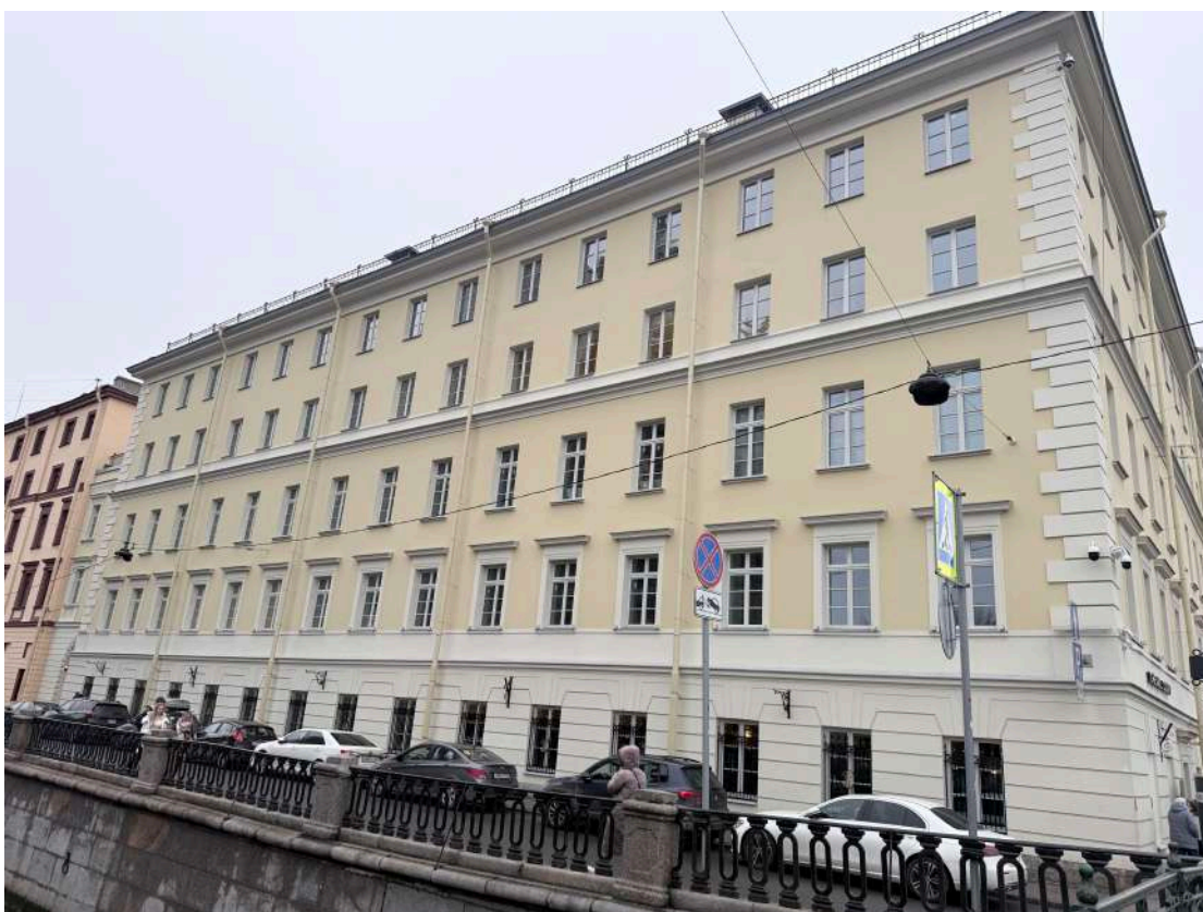
Фото 2. Общій вид об'єкта. Дата фотофіксації: 17.11.2025
