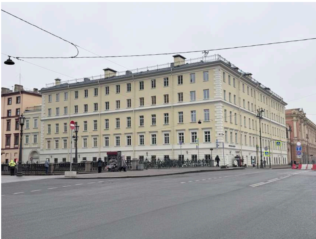
Фото 1. Общій вид об'єкта. Дата фотофіксації: 17.11.2025
