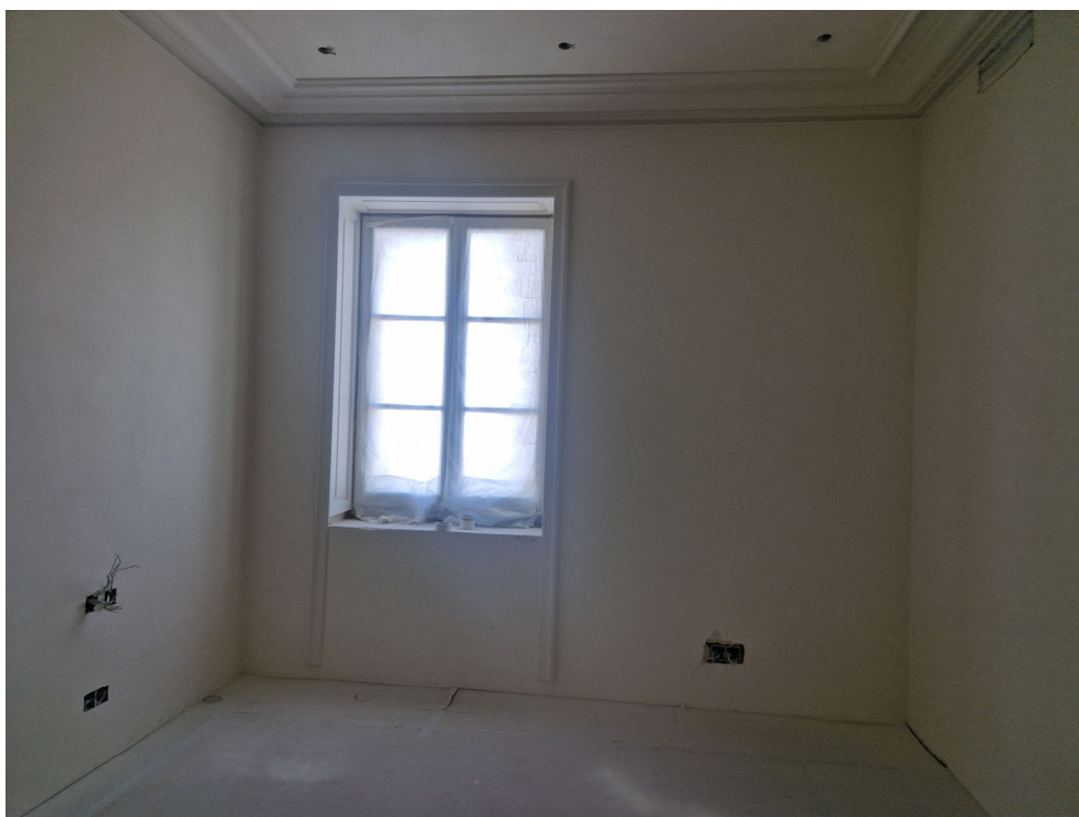
Фото 34. Общий вид на часть рассматриваемого помещения в границах объекта культурного наследия
