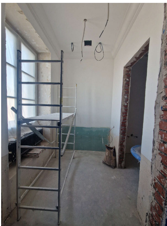
Фото 16. Общий вид на часть рассматриваемого помещения в границах объекта культурного наследия
