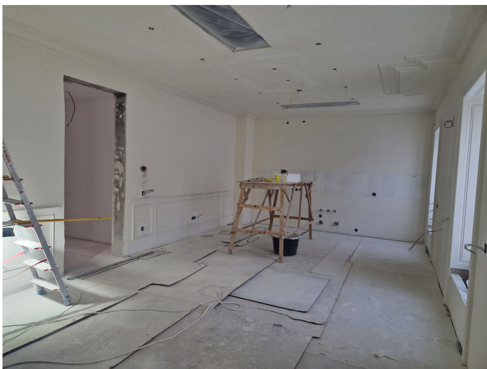
Фото 68. Общий вид на часть рассматриваемого помещения в границах объекта культурного наследия
