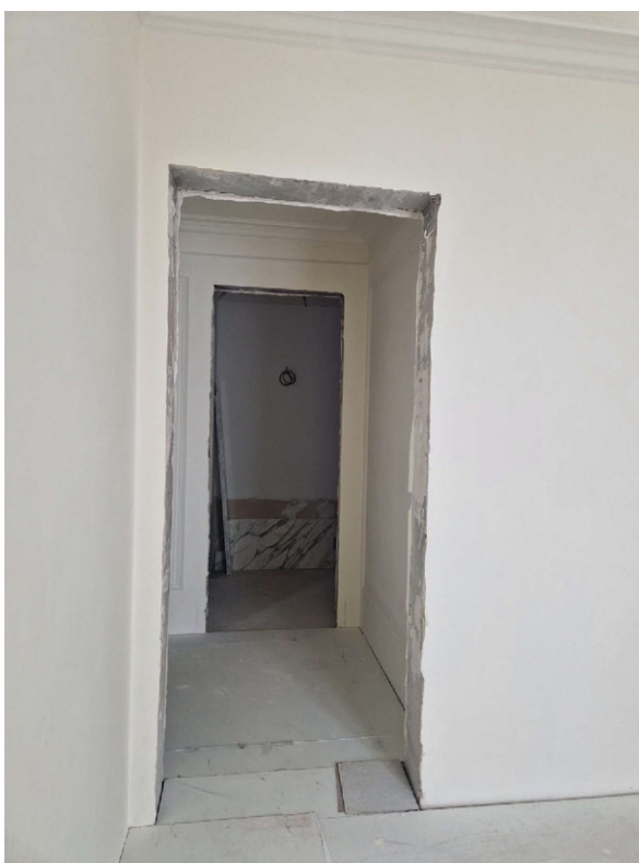
Фото 20. Общий вид на часть рассматриваемого помещения в границах объекта культурного наследия
