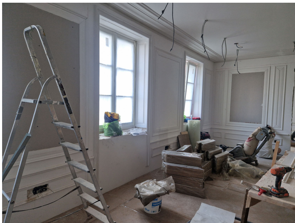
Фото 62. Общий вид на часть рассматриваемого помещения в границах объекта культурного наследия
