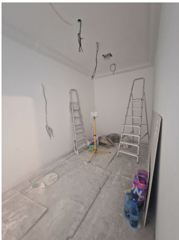
Фото 59. Общий вид на часть рассматриваемого помещения в границах объекта культурного наследия
