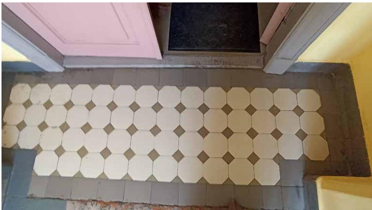
137. Мансардный этаж. Лестничная клетка № 43, покрытие пола метлахской плиткой.
