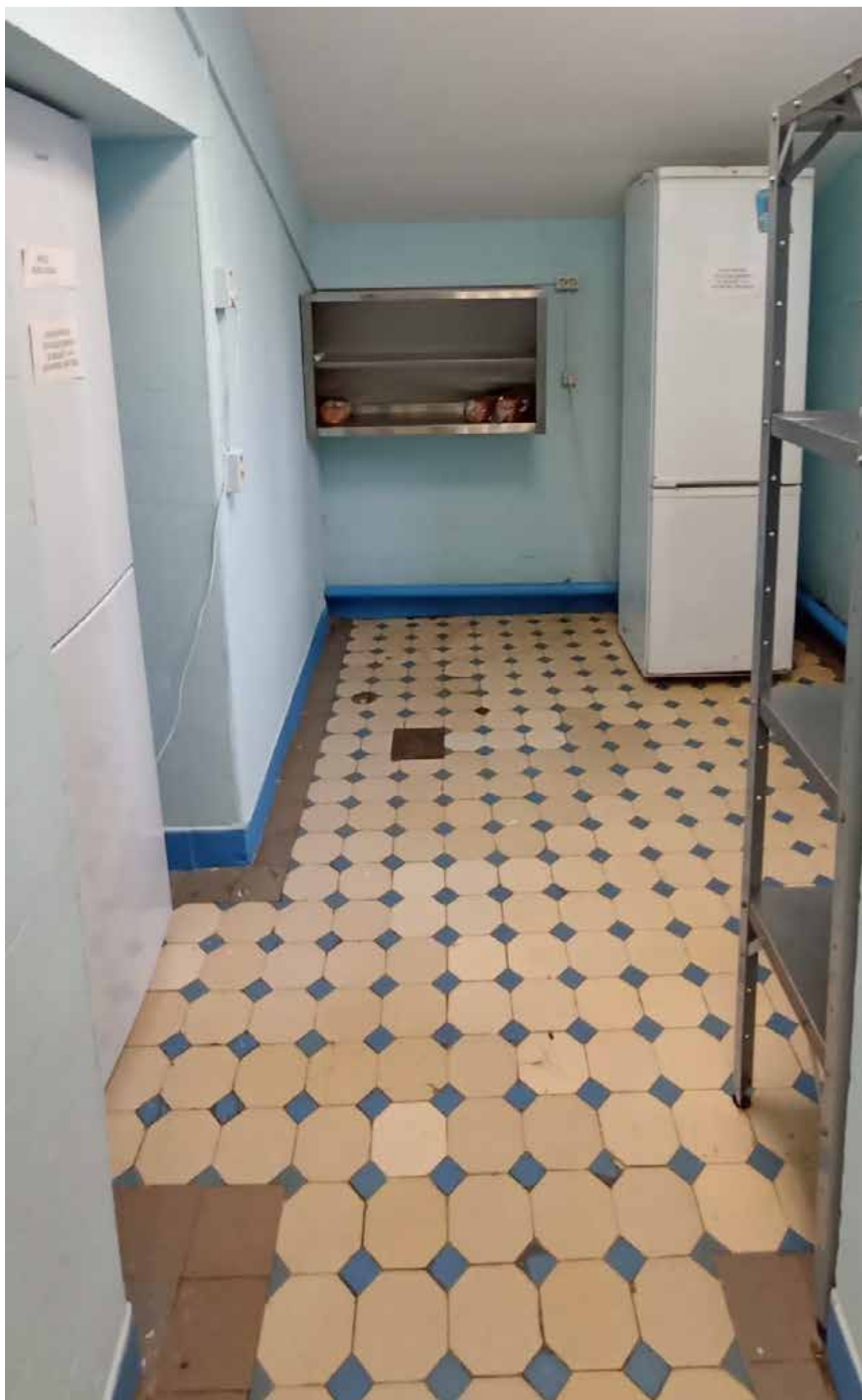
38. Цокольный этаж. Пом. 17.
