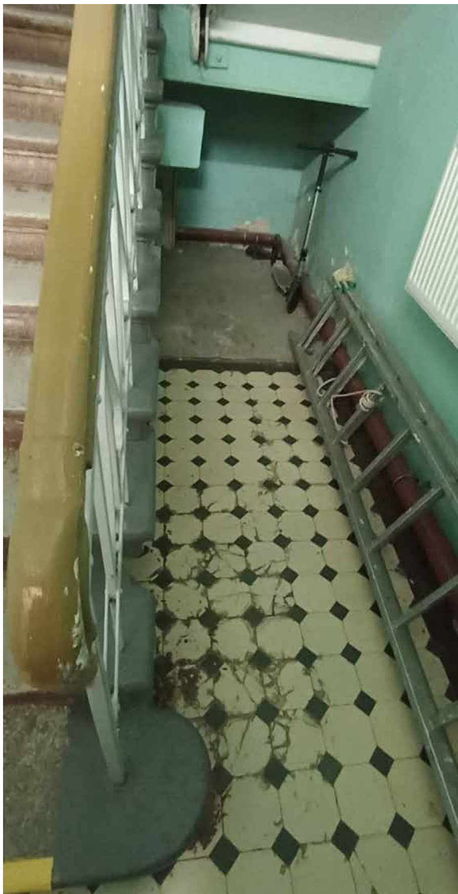
27. Цокольный этаж. Пом. 20. Лестничная клетка.
