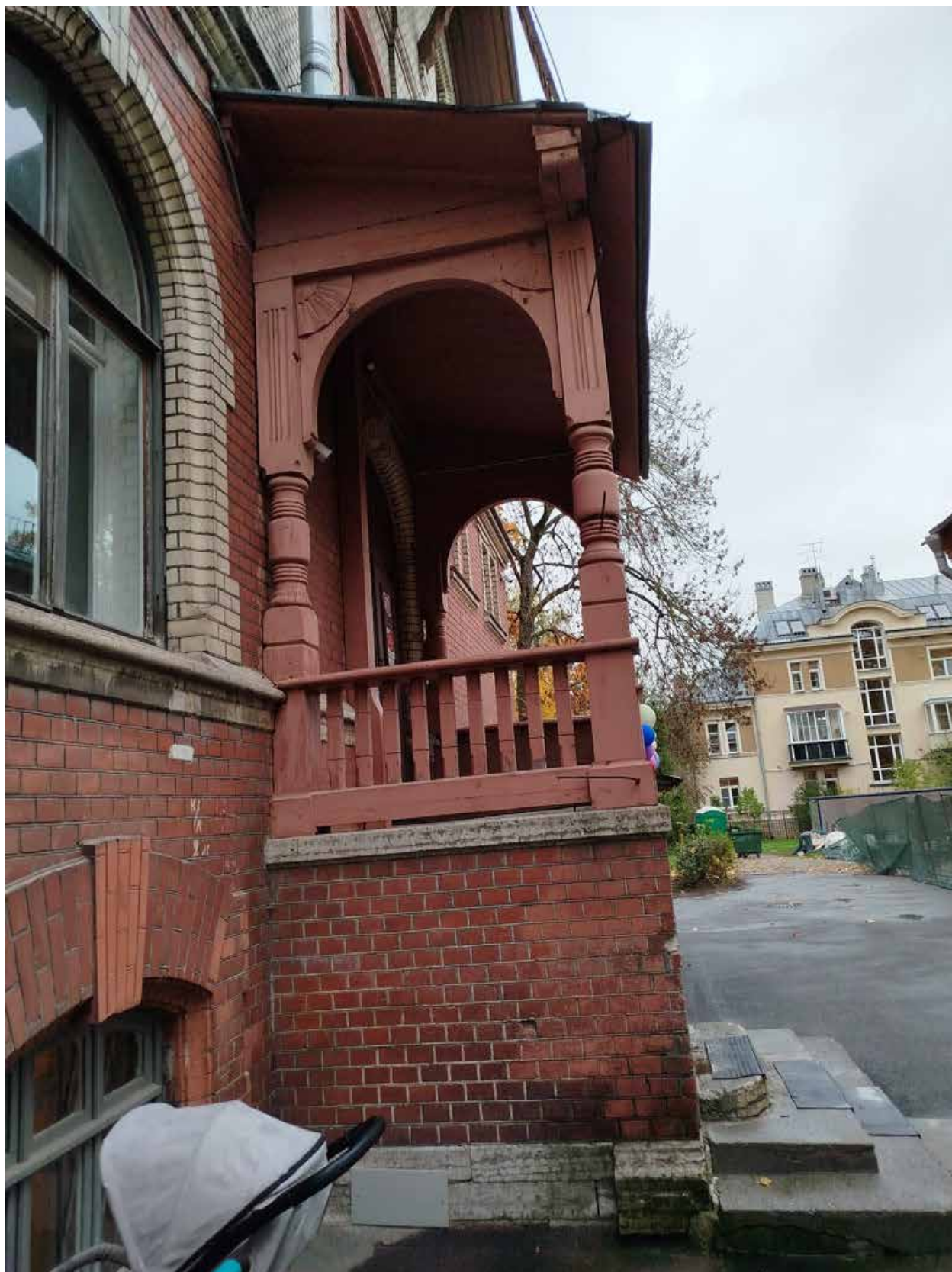
16. Вид на крыльцо южного фасада с запада.
