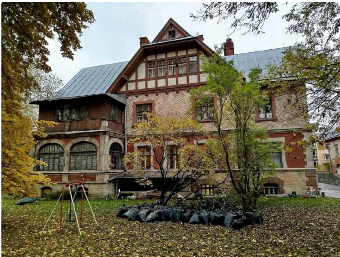
18. Вид на западный фасад.
