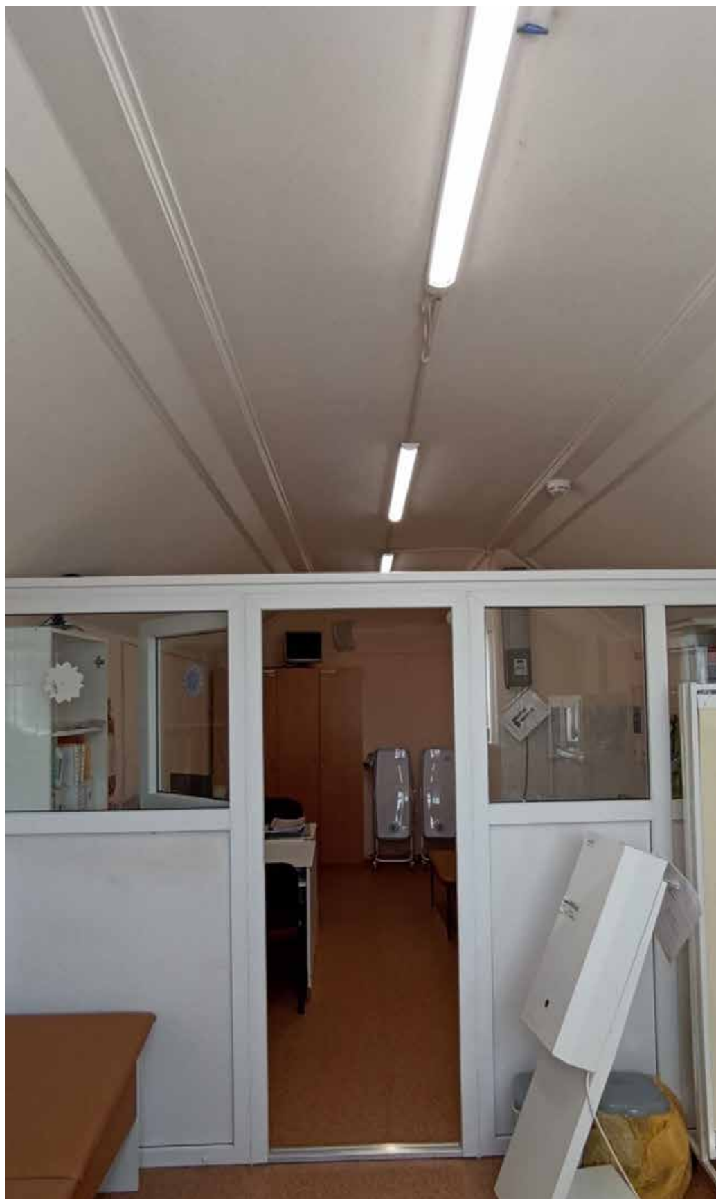
133. Мансардный этаж. Пом. 31, 31.1.
