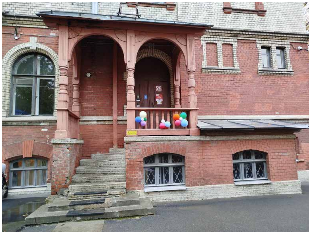
13. Вид на крыльцо южного фасада.
