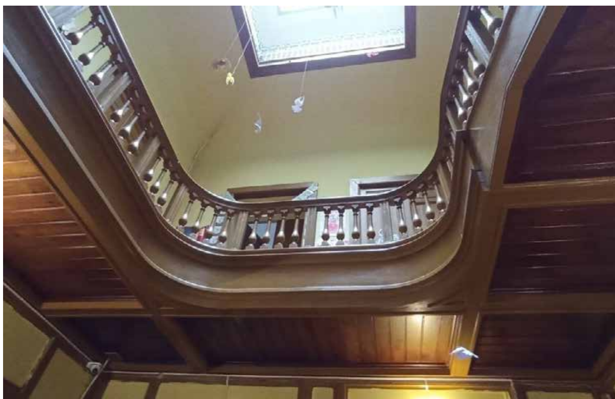
62. 1 этаж. Пом. 8, холл.
