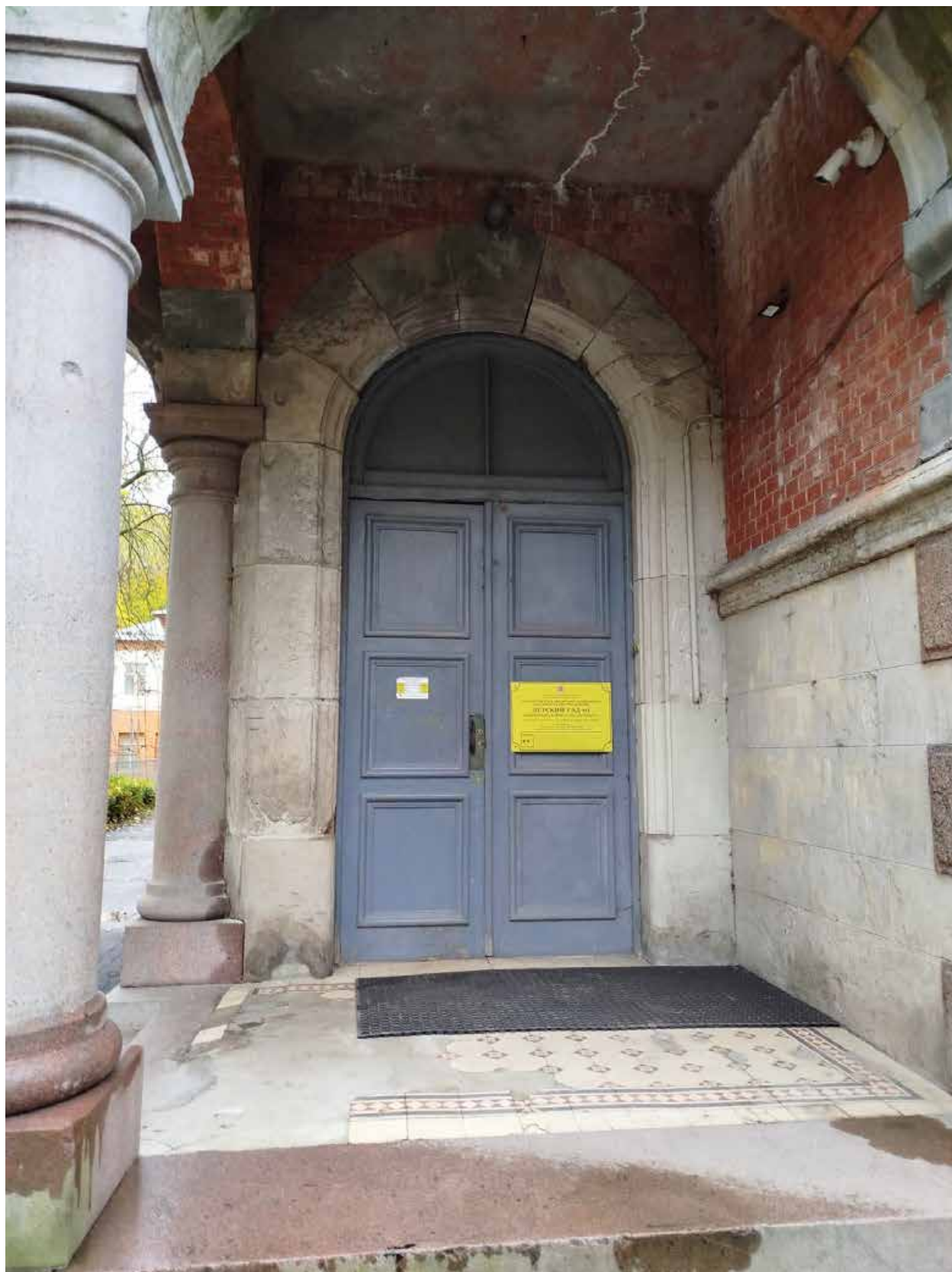
4. Входная группа в восточной части северного фасада.
