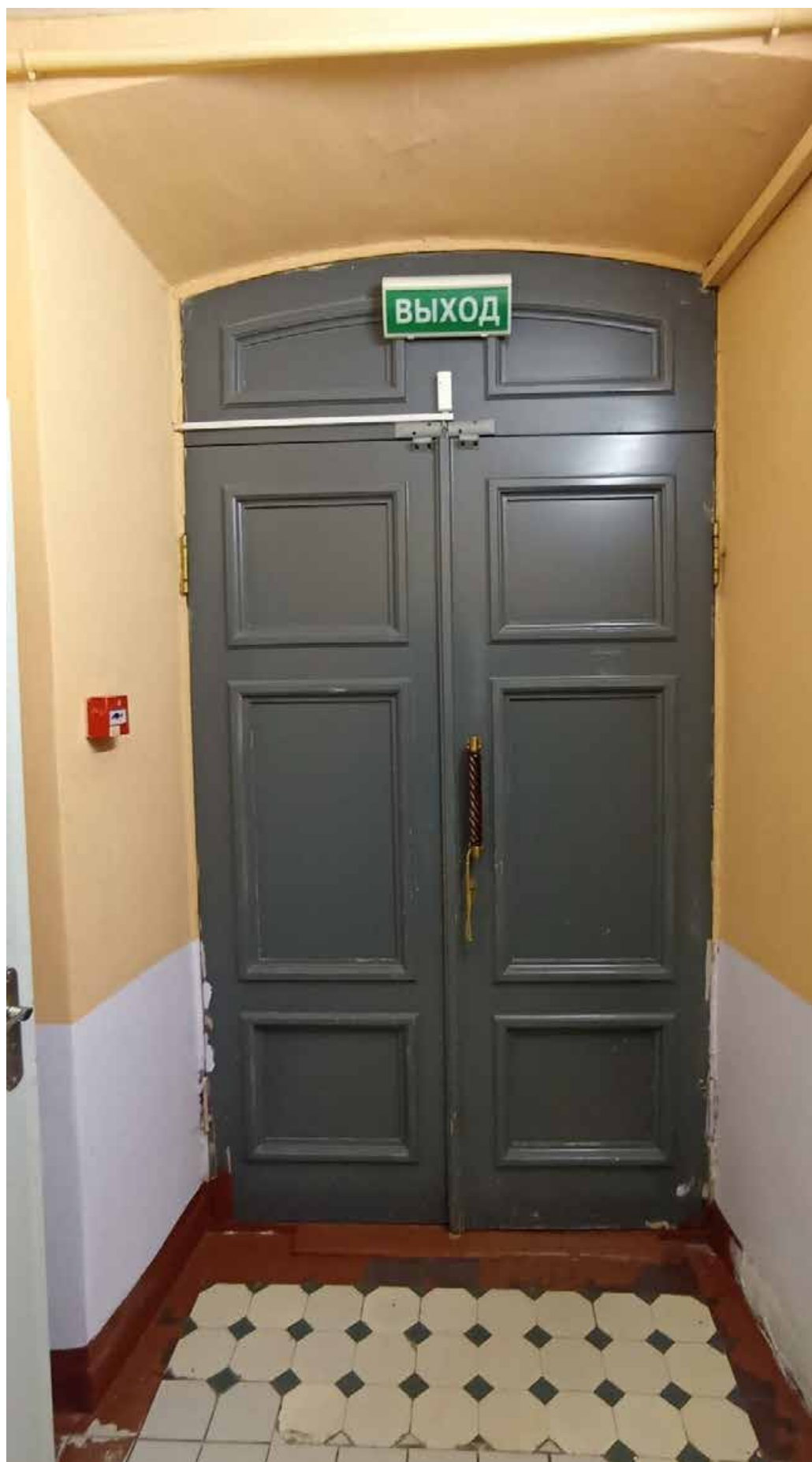
24. Цокольный этаж. Пом. 20. Лестничная клетка.
