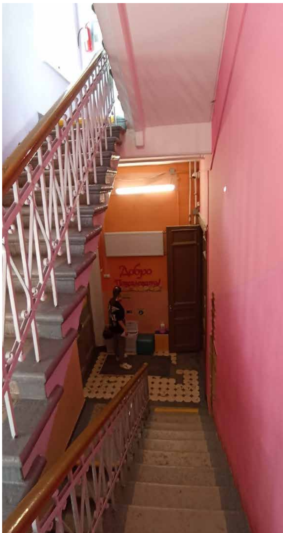
47. Между 1 и 2 этажами. Лестничная клетка. Пом. 12
