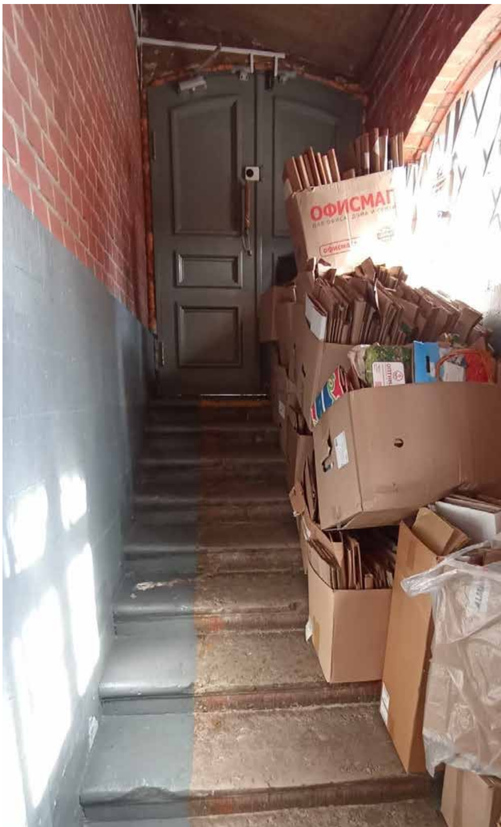
23. Цокольный этаж. Лестница в подвал. Пом. 0.
