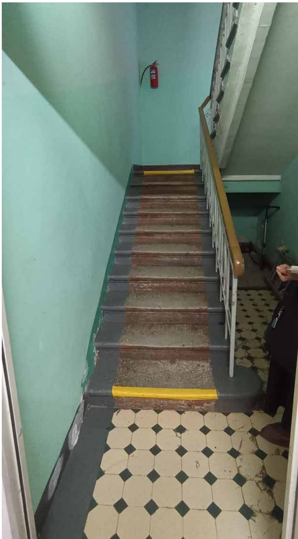
26. Цокольный этаж. Пом. 20. Лестничная клетка.
