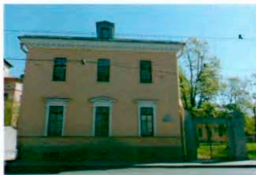
18. Лицевой (западный) фасад здания.
