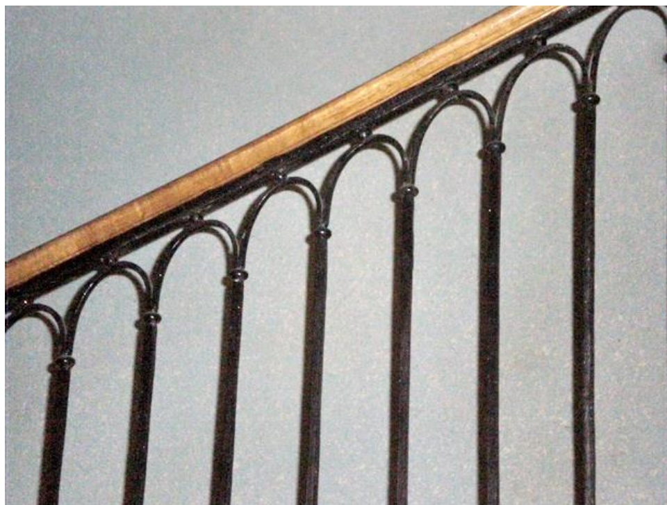
Илл.40. Историческая каменная лестница. Фрагмент ограждения. 26.02.2011г. Орлово-Новосильцевская богадельня. Корпус по адресу: СПб, пр. Энгельса, д.1, стр.2. До реставрации 2013-2017 гг.
