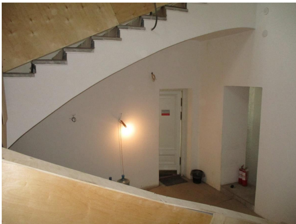
Фото 13. Орлово-Новосильцевская богадельня, пр. Энгельса, д.1, стр.2. Лестничная клетка в осях 7-8/Г-Е. Средний марш и подлестничное пространство. 29.06.2020г.
