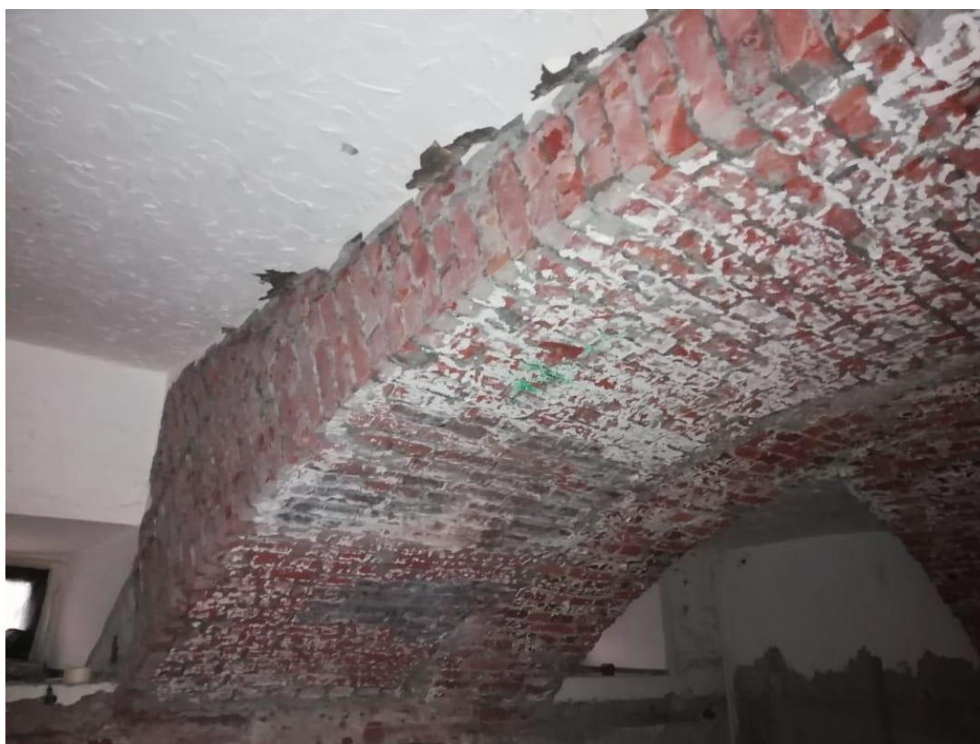
Фото 25. Орлово-Новосильцевская богадельня, пр. Энгельса, д.1, стр.2. Подвал в осях 7-8/Г-Е. Общий вид зоны опирания главной арки на кирпичную стену по оси Е. 30.06.2020г.
