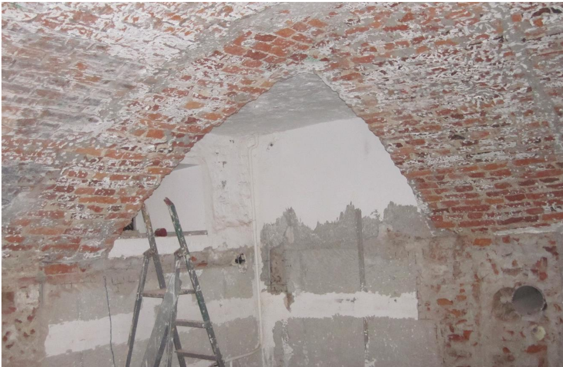
Фото 31. Орлово-Новсылцевская богадельня, пр. Энгельса, д.1, стр.2. Подвал в осях 7-8/Г-Е. Пересечение стены по осям «Е» и «8». 30.06.2020г.
