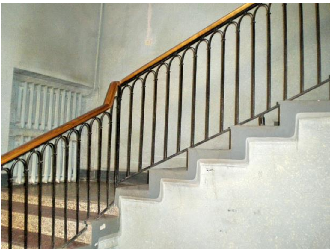
Илл.39. Историческая каменная лестница. Ограждение лестничных маршей. 26.02.2011г. Орлово-Новосильцевская богадельня. Корпус по адресу: СПб, пр. Энгельса, д.1, стр.2. До реставрации 2013-2017 гг.
