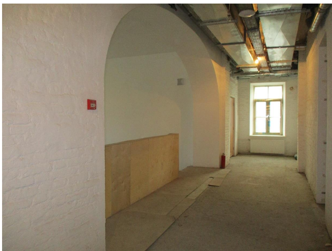
Фото 23. Орлово-Новосильцевская богадельня, пр. Энгельса, д.1, стр.2. Лестничная клетка в осях 7-8/Г-Е. Коридор 2-го этажа и арочный проем лестничной клетки. 7-8/Е. 29.06.2020 г.
