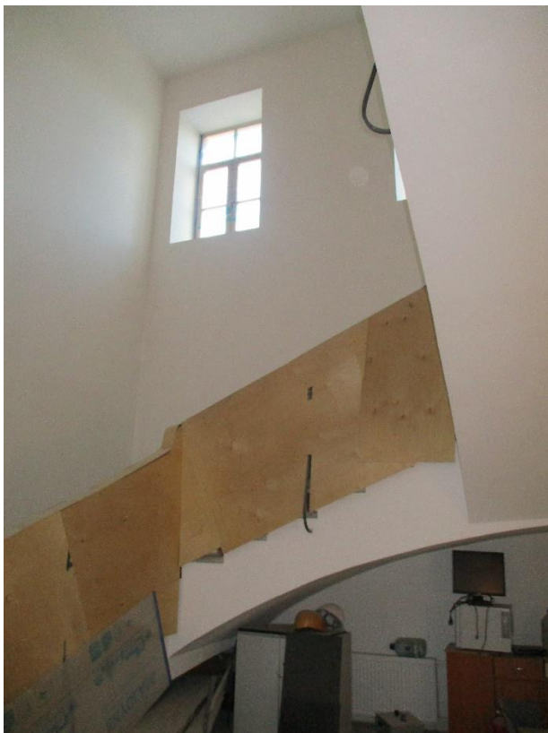
Фото 17. Орлово-Новосильцевская богадельня, пр. Энгельса, д.1, стр.2. Лестничная клетка в осях 7-8/Г-Е. Вид на средний марш. 29.06.2020 г.
