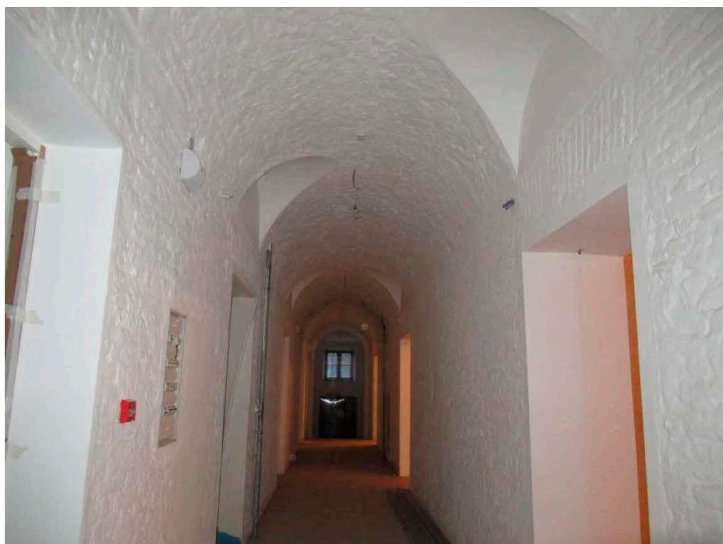
Фото 6. Орлово-Новсылецевская богадельня, пр. Энгельса, д.1, стр.2. Центральный коридор в осях В-Г/2-9. 29.06.2020 г.
