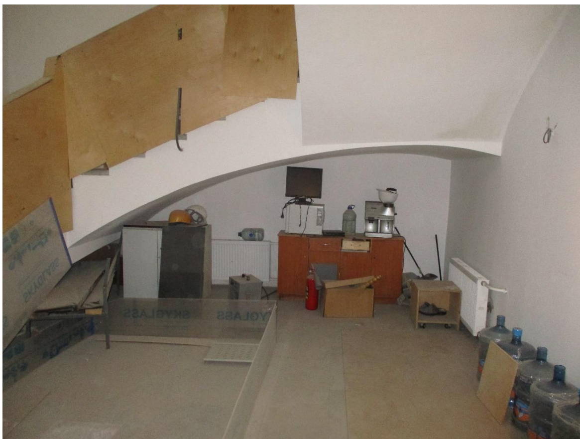
Фото 11. Орлово-Новосильцевская богадельня, пр. Энгельса, д.1, стр.2. Лестничная клетка в осях 7-8/Г-Е. Средний марш и подлестничное пространство. 29.06.2020 г.
