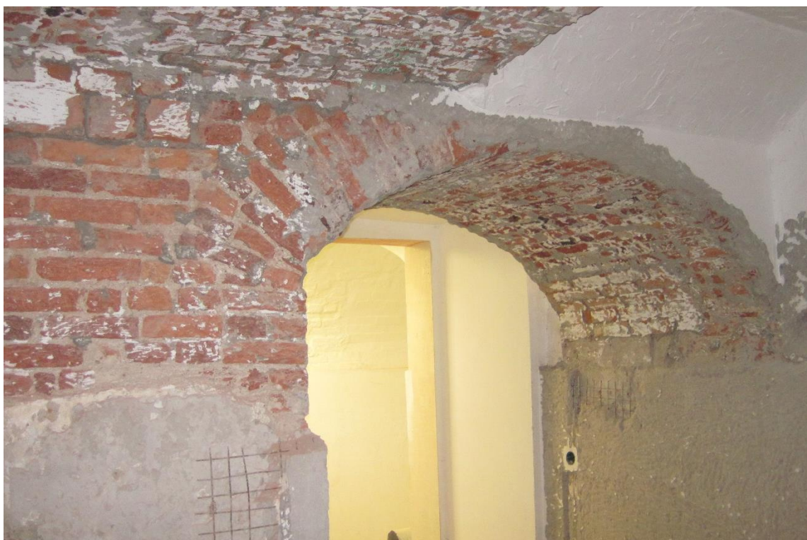
Фото 26. Орлово-Новосильцевская богадельня, пр. Энгельса, д.1, стр.2. Подвал в осях 7-8/Г-Е. Вид на арку. 30.06.2020г.
