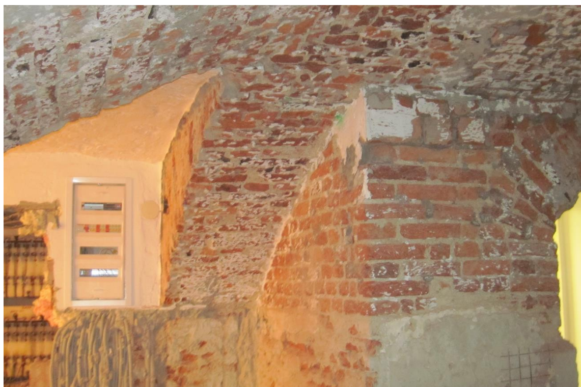
Фото 27. Орлово-Новосильцевская богадельня, пр. Энгельса, д.1, стр.2. Подвал в осях 7-8/Г-Е. Вид на кирпичную стену по оси 7-8. 30.06.2020г.
