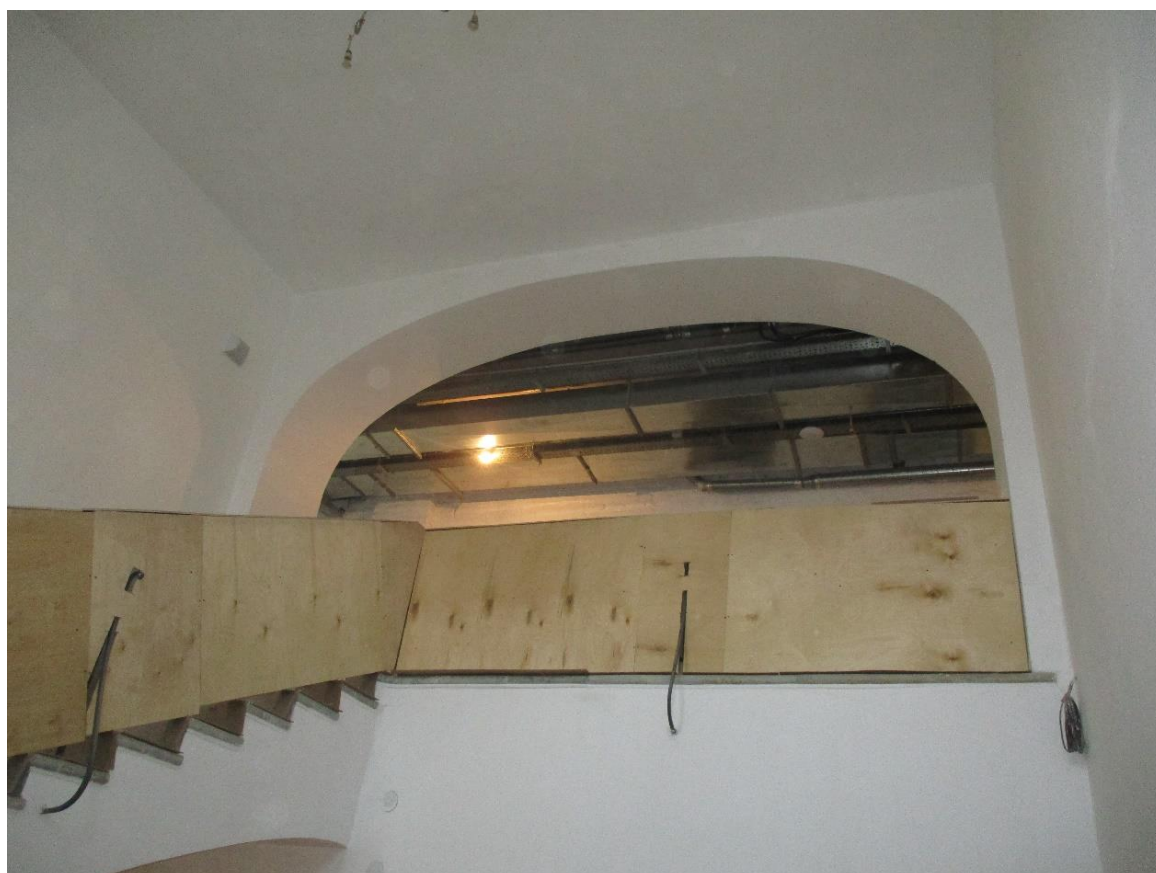
Фото 16. Орлово-Новосильцевская богадельня, пр. Энгельса, д.1, стр.2. Лестничная клетка в осях 7-8/Г-Е. Общий вид на арочный проем 2-го этажа. 29.06.2020 г.
