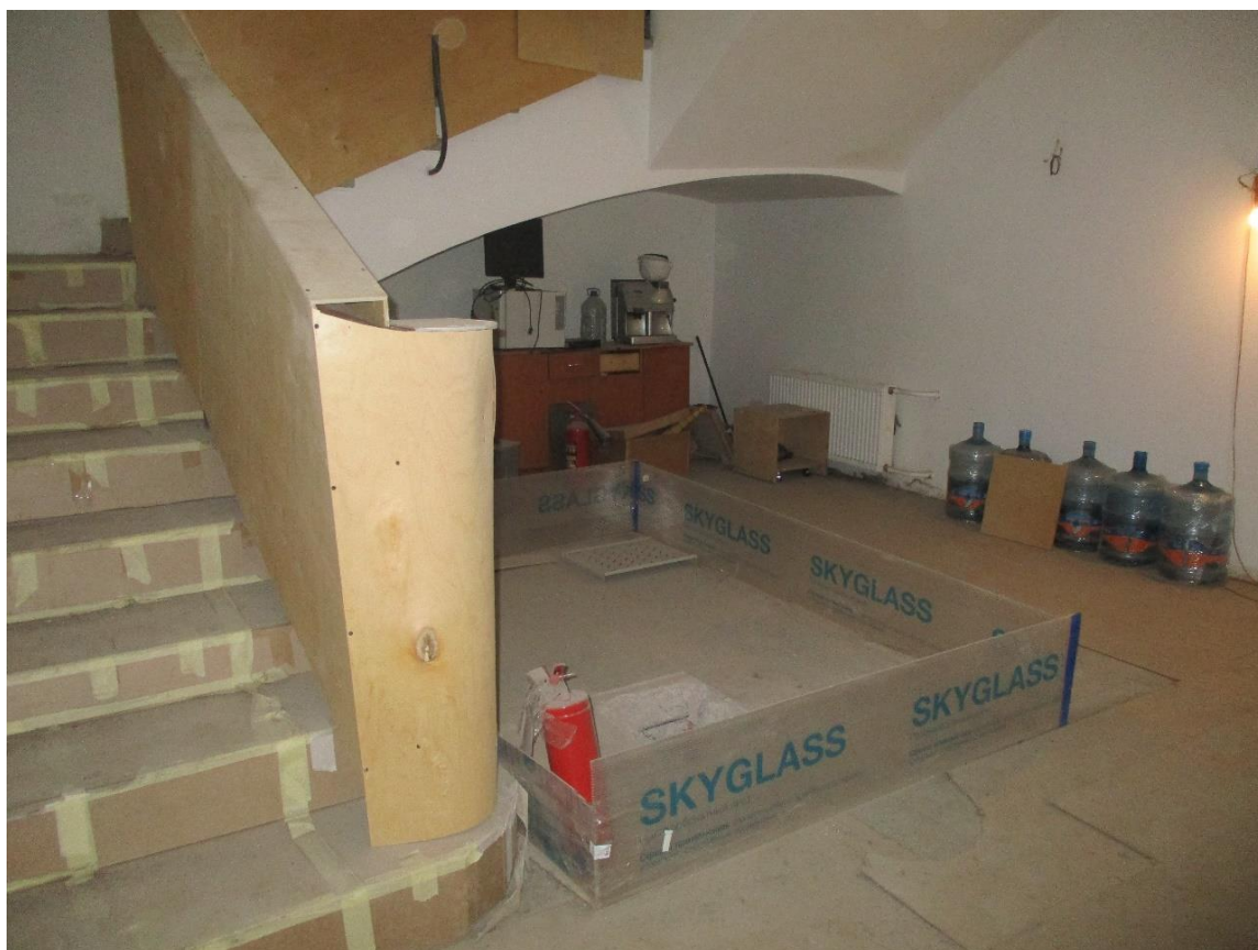
Фото 9. Орлово-Новосильцевская богадельня, пр. Энгельса, д.1, стр.2. Лестничная клетка в осях 7-8/Г-Е. Нижний марш и подлестничное пространство. 29.06.2020 г.
