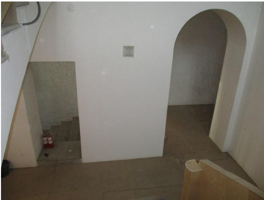
Фото 7. Орлово-Новсылцевская богадельня, пр. Энгельса, д.1, стр.2. Лестничная клетка в осях 7-8/Г-Е. Вход из центрального коридора (7-8/Г). 29.06.2020 г.
