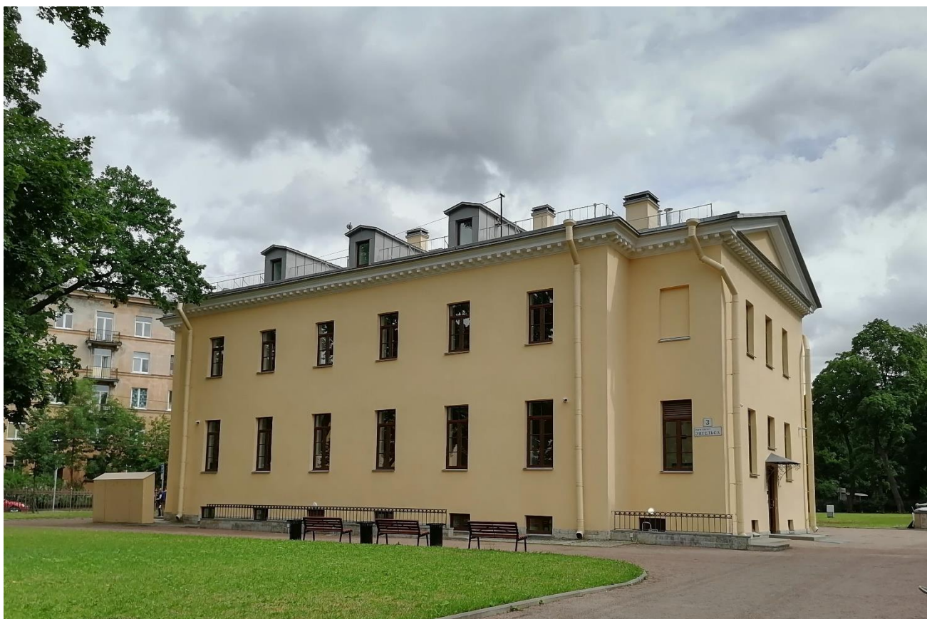
Фото 3. Орлово-Новсылъцевская богадельня, пр. Энгельса, д.1, стр.2. Западный фасад. 30.06.2020 г.
