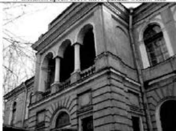
9. Северный фасад. Фрагмент.
