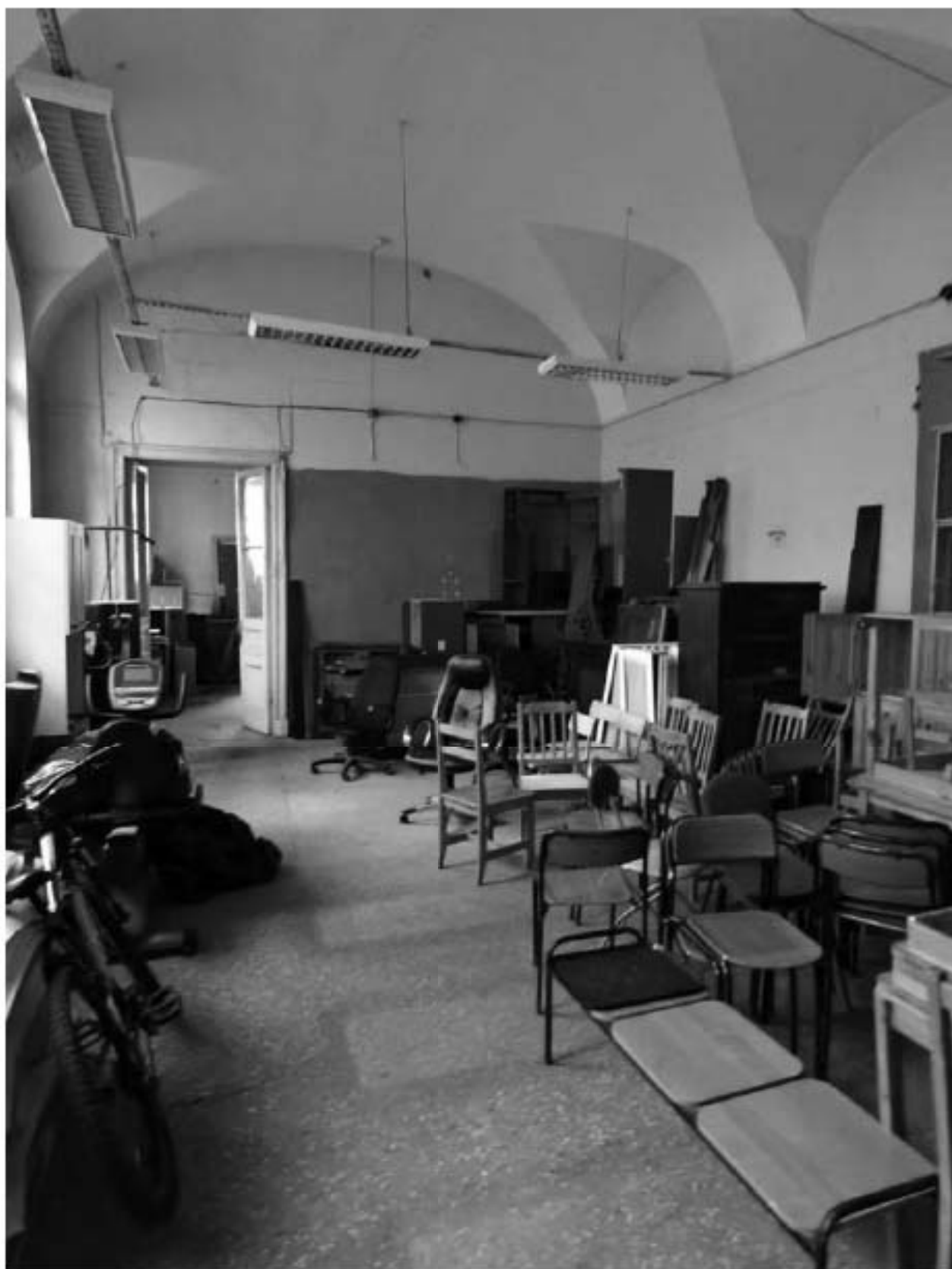
Фото 17. Помещение с левой стороны при входе в здание ОКН.
