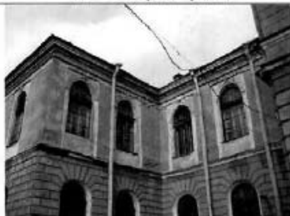
13. Западный фасад. Фрагмент.
