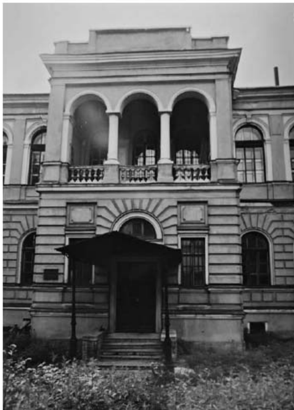
52. Духовная академия. Библиотека. Центральная часть северного фасада. Вид с севера. 1999 г.
