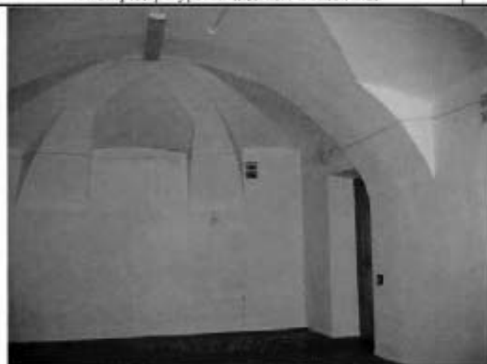
16. Помещение 1-го этажа. Общий вид.
