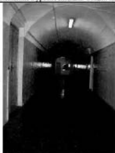
17. Коридор 1-го этажа. Общий вид.
