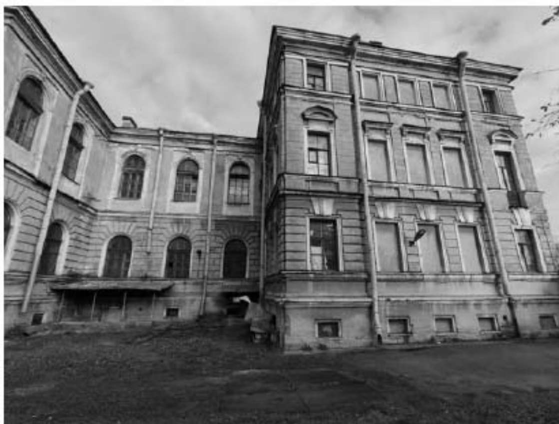
Фото 8. Фрагмент западного фасада ОКН
