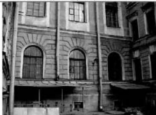
12. Западный фасад. Фрагмент.
