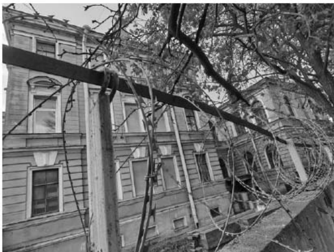
Фото 7. Восточный фасад ОКН
