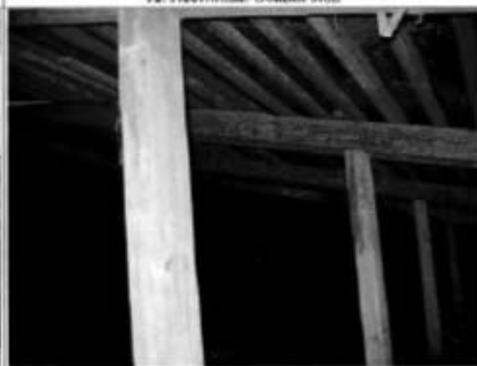
14. Конструкция крыши. Общий вид.
