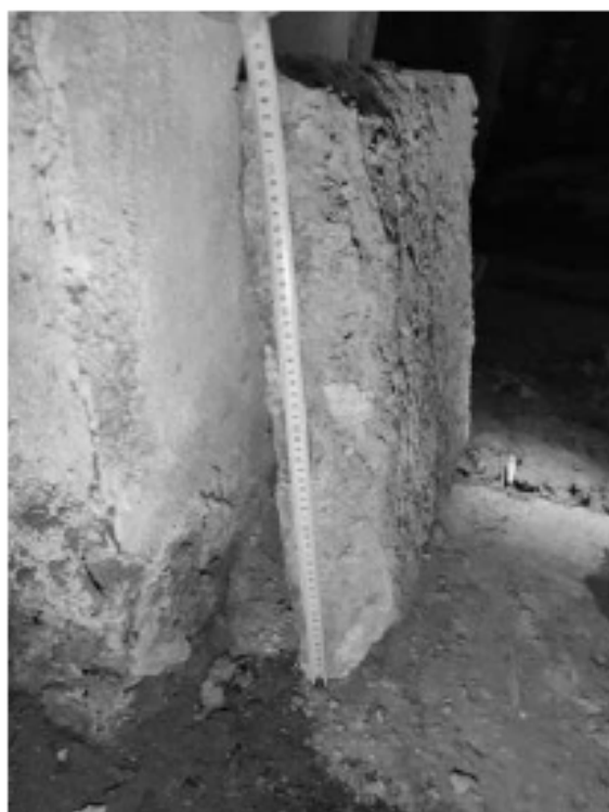
Рис. 14 Каменная плита пола подвала
