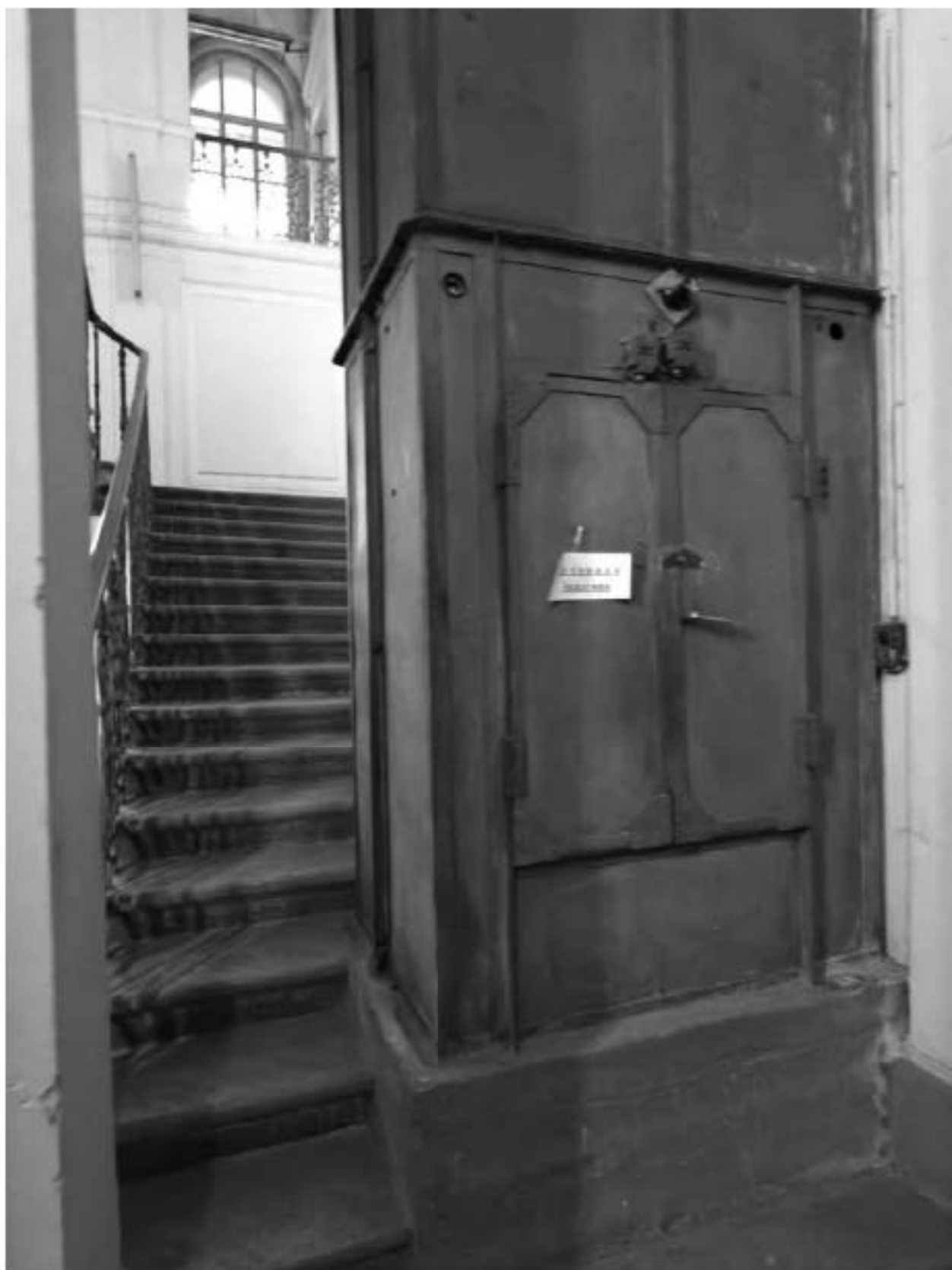
Фото 21. Лестница на второй этаж с подъемным устройством.
