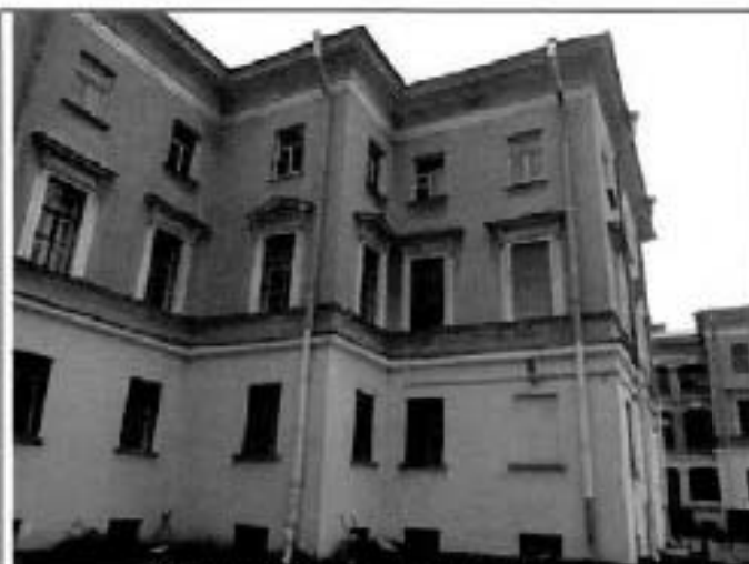
12. Дворовые фасады северного флигеля.
