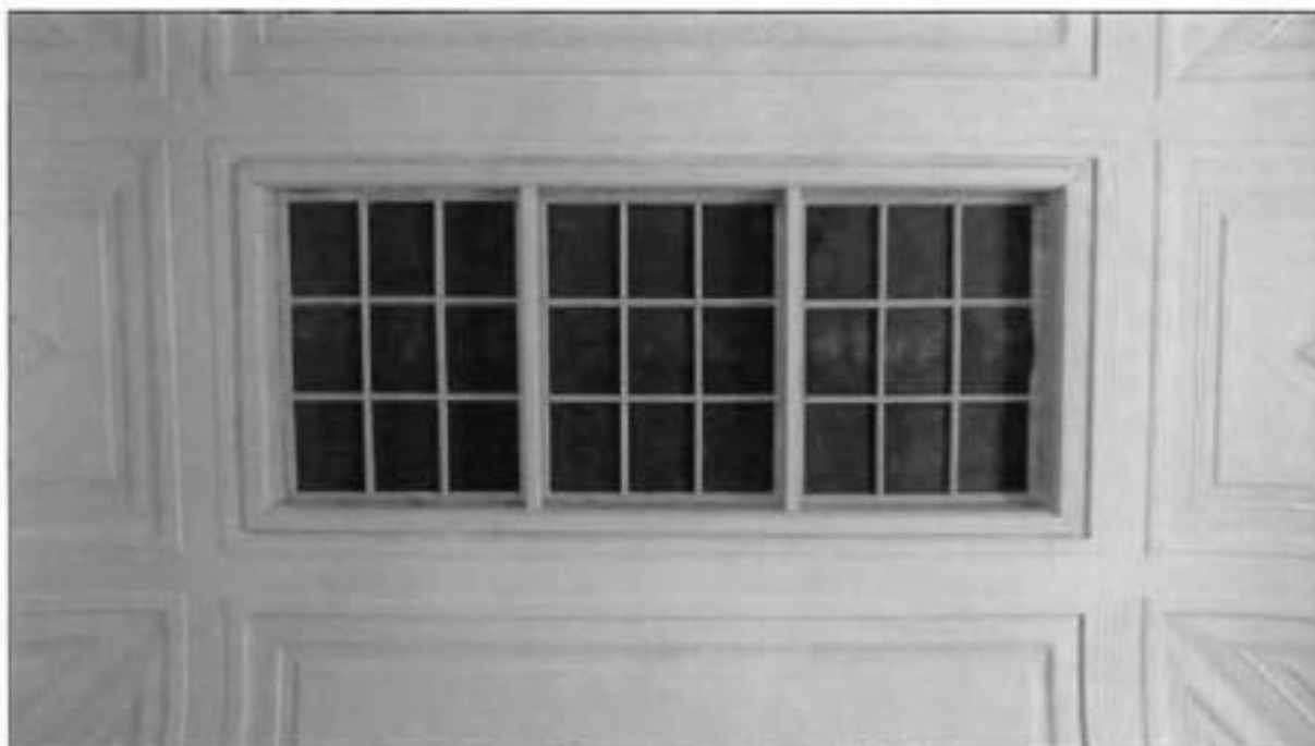
9. Световой фонарь над парадной лестницей (пом. 1-Н (48)).
