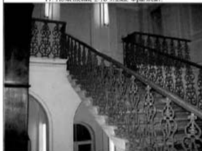
19. Лестница северной части здания. Общий вид.
