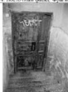
6. Входной проем восточного фасада. Общий вид.
