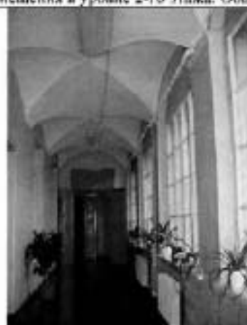
27. Коридор и уровне 2-го этажа. Общий вид.
