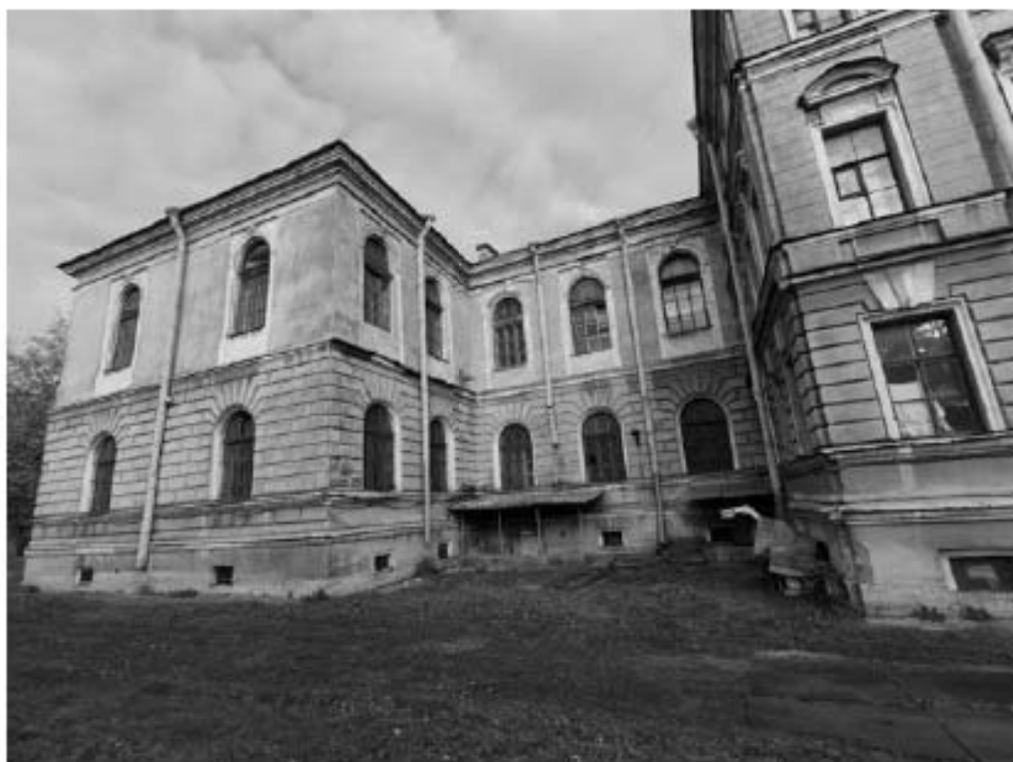
Фото 9. Фрагмент западного фасада ОКН.
