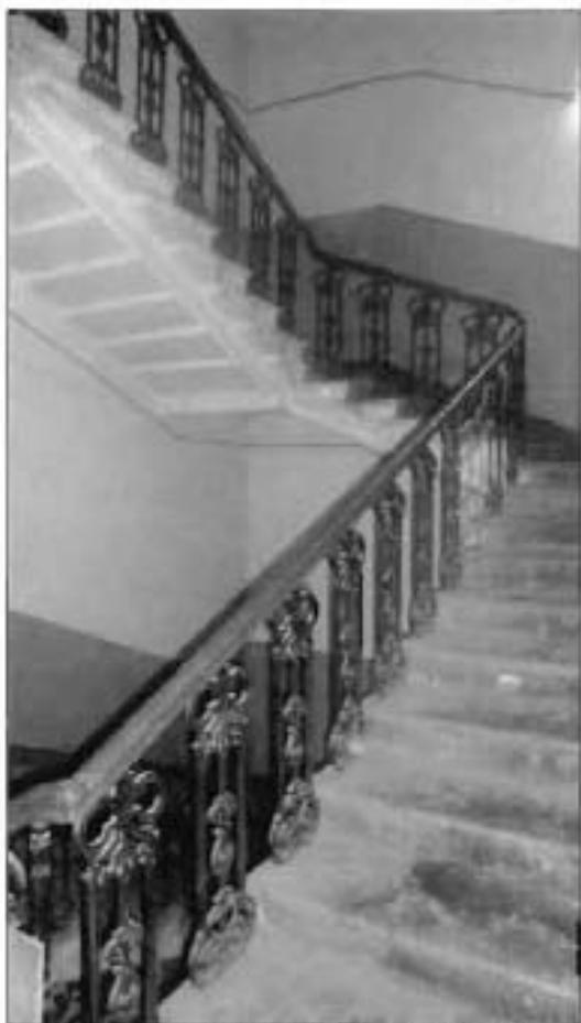
7. Лестница в южной части здания. Л-1.
