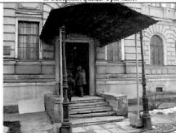
10. Входная группа северного фасада. Общий вид.
