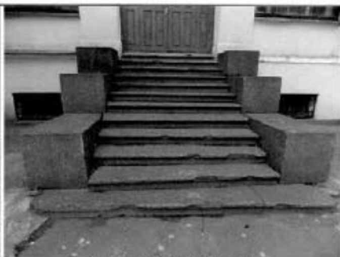
13. Дворовые фасады. Крыльца.
