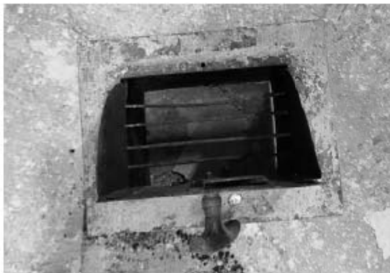
Рис 7. Вентиляционный лючок интерьера библиотеки
