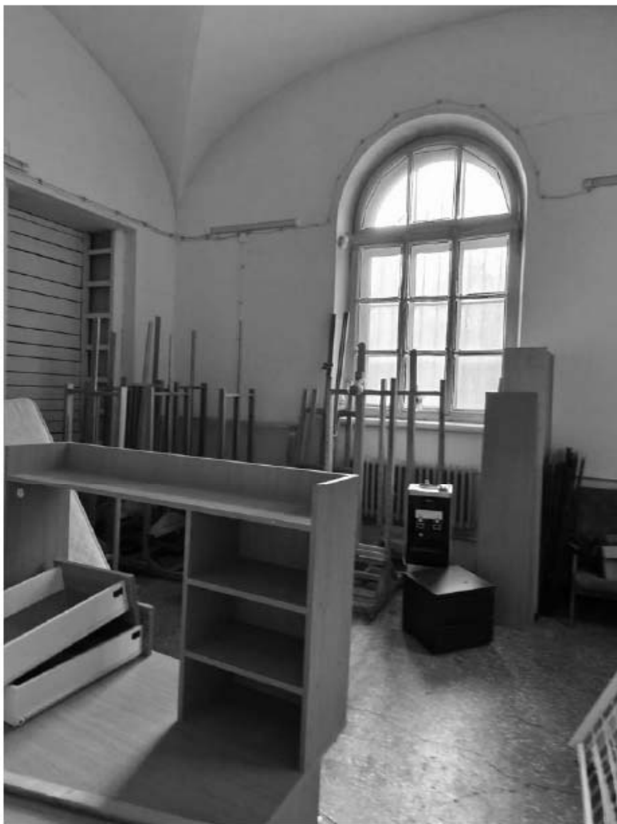
Фото 19. Помещение на первом этаже здания ОКН.
