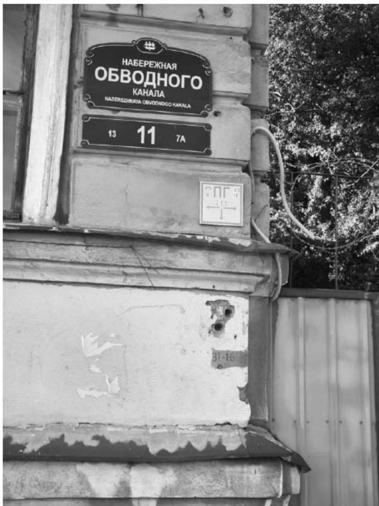
Фото 3. Фрагмент южного фасада ОКН (фрагмент).
