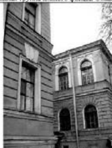
4. Восточный фасад. Фрагмент.
