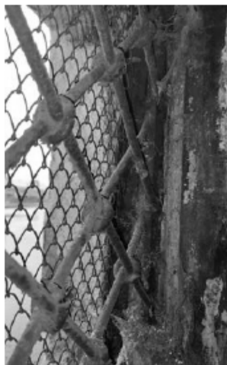
Рис. 15 Металлическая решётка оконных проёмов подвала
