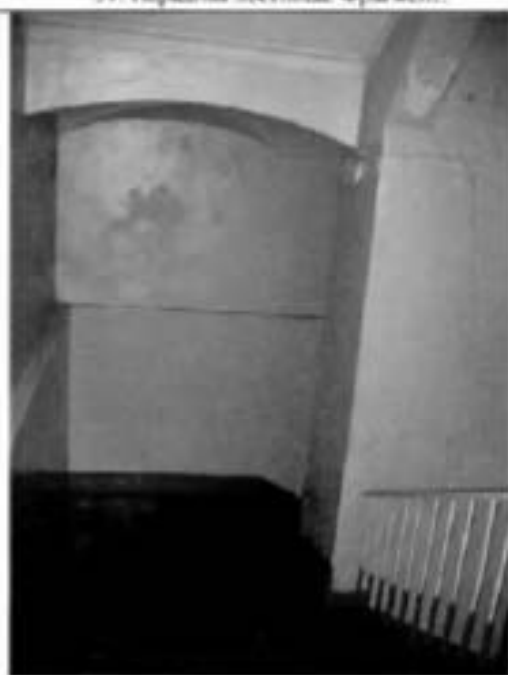
39. Лестница в южном крыле. Фрагмент.
