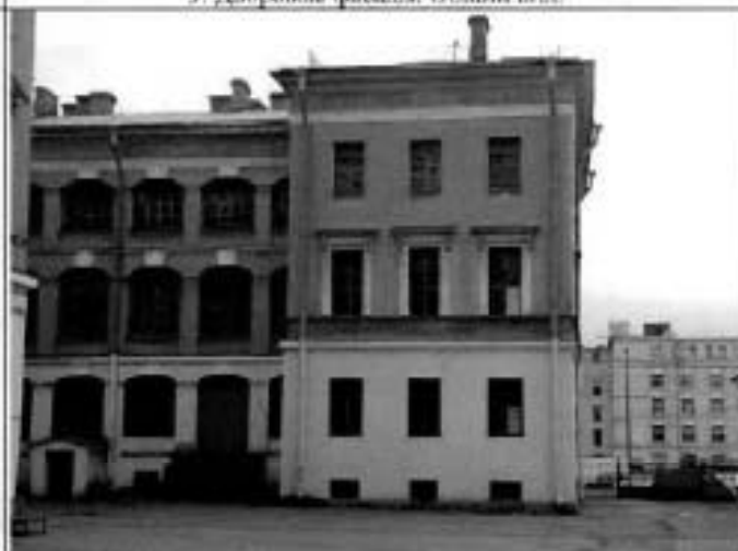
11. Дворовые фасады южного флигеля. Общий вид.
