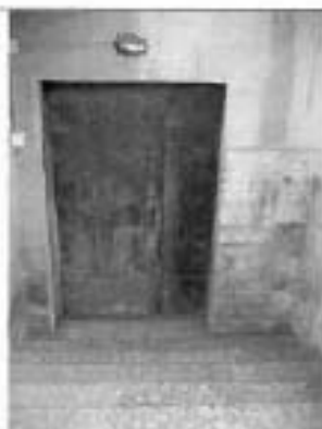
7. Входной проем восточного фасада. Общий вид.
