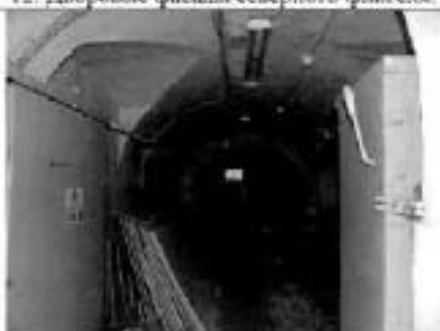
14. Коридор в уровне подвала. Общий вид.
