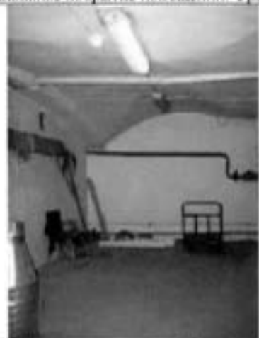
25. Помещение подвала. Общий вид.
