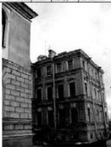
11. Западный фасад. Фрагмент.
