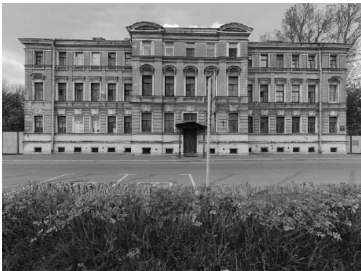
Фото 4. Южный фасад ОКН.
