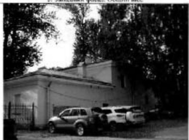
7. Северный фасад. Общий вид.
