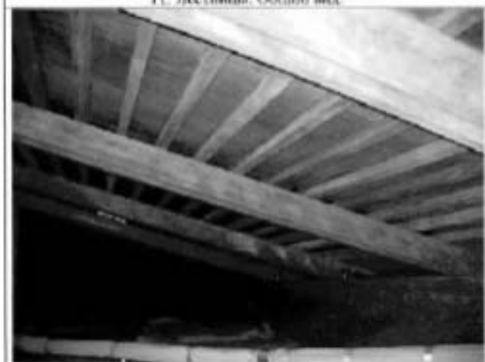
13. Конструкция крыши. Общий вид.
