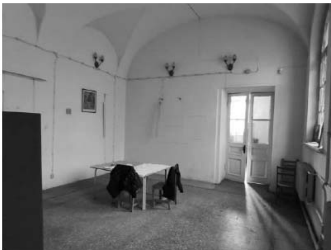
Фото 18. Помещение с правой стороны при входе в здание ОКН.
