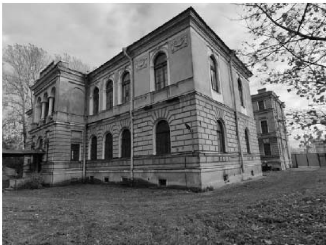
Фото 10. Северо-западный угол здания ОКН.
