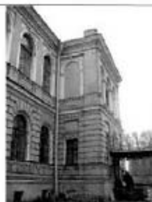
8. Северный фасад. Фрагмент.
