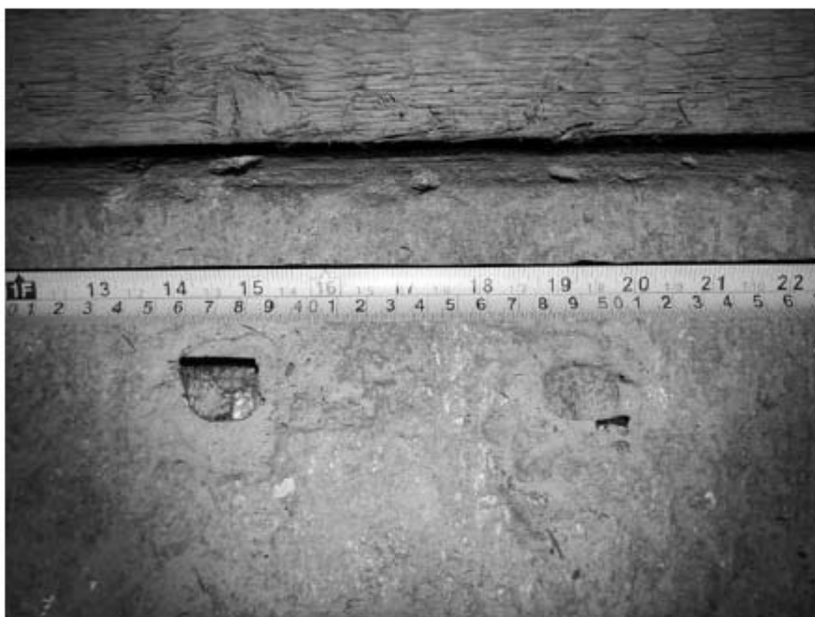
Рис 10. Следы металлического ограждения лестницы в подвал
