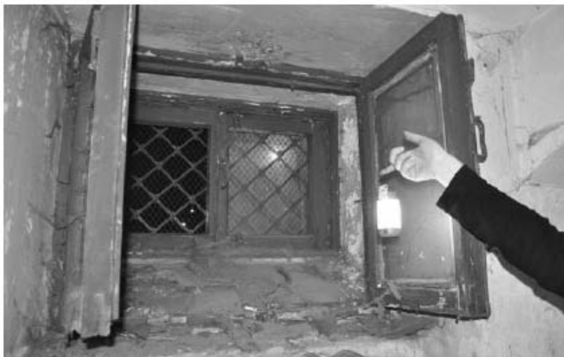
Рис 13. Окно подвального этажа. Коробки и внутренняя рама первоначальные, внешняя рама, предположительно, более поздняя
