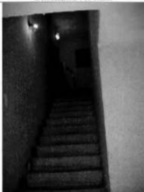
10. Лестница. Общий вид.
