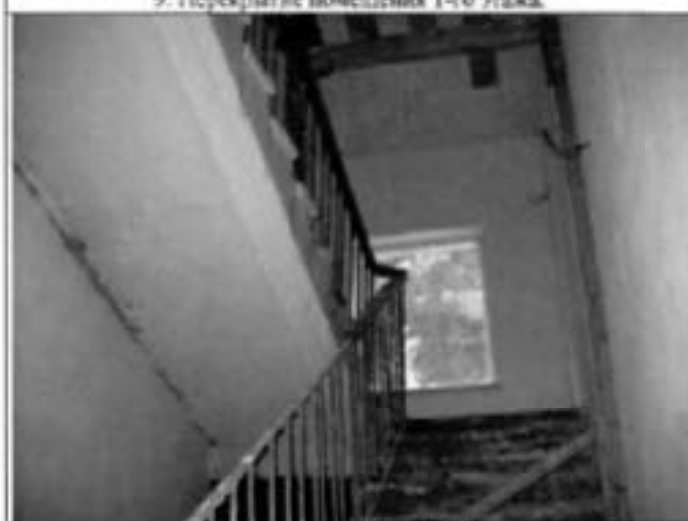
11. Лестница. Общий вид.
