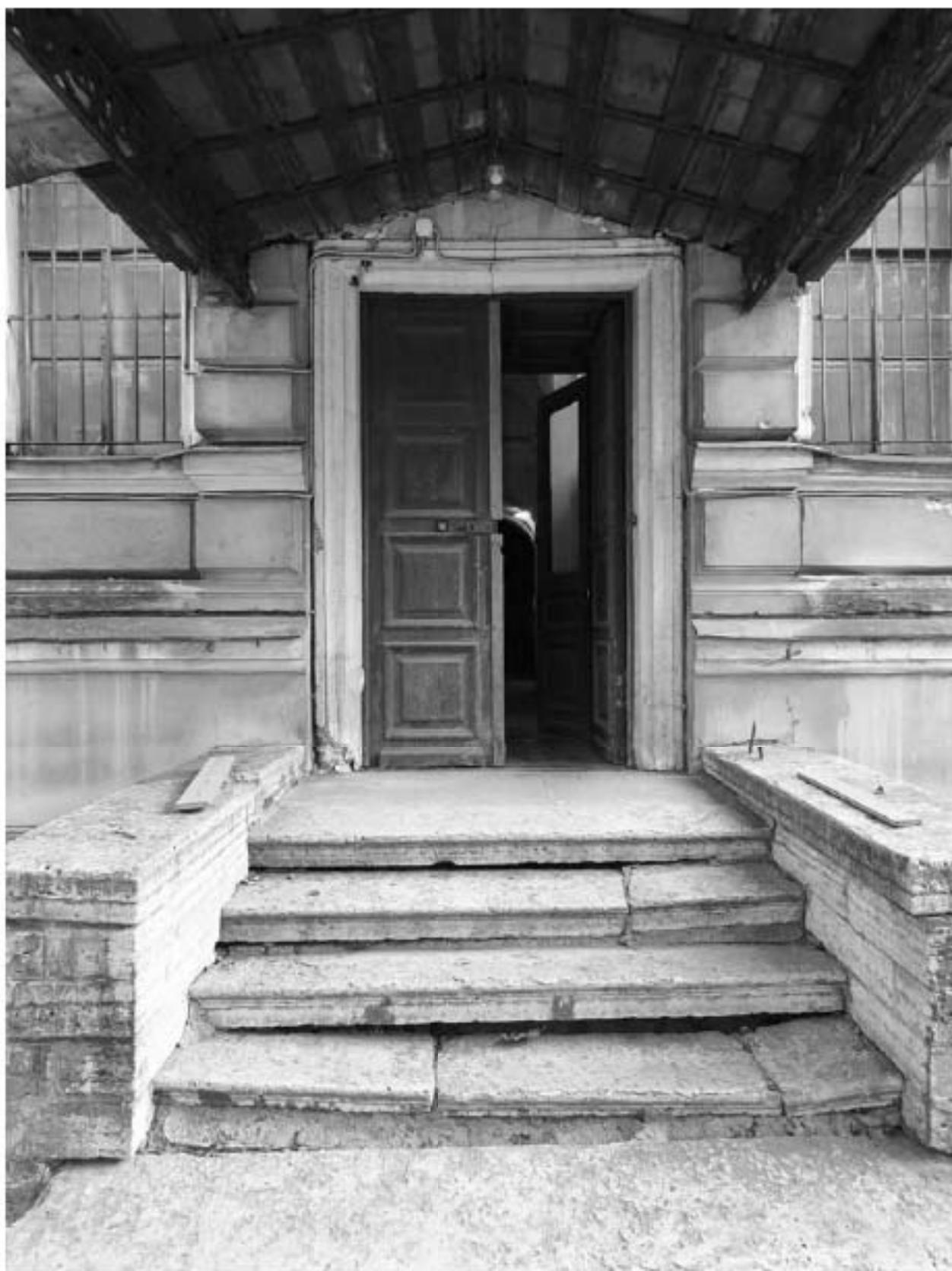
Фото 14. Северный вход в задние ОКН.
