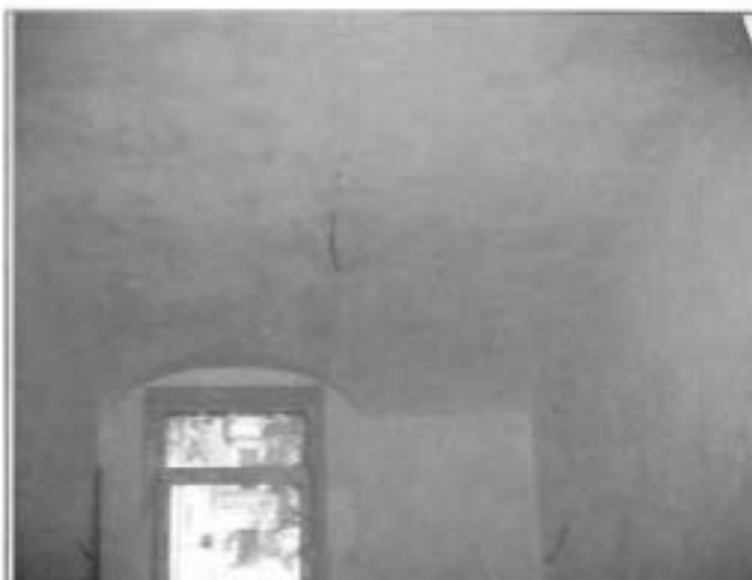
9. Перекритие помещений 1-го этажа.
