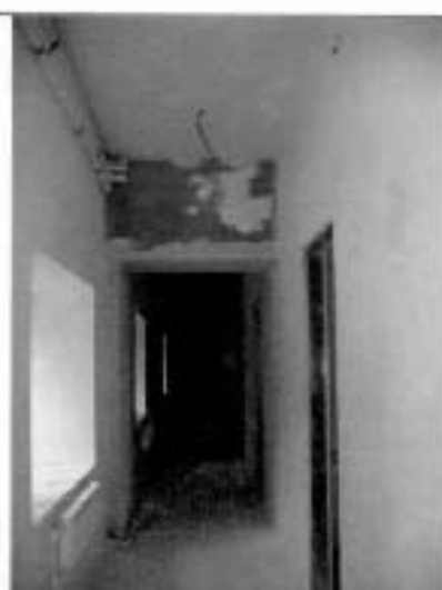
10. Коридор 2-го этажа. Общий вид.
