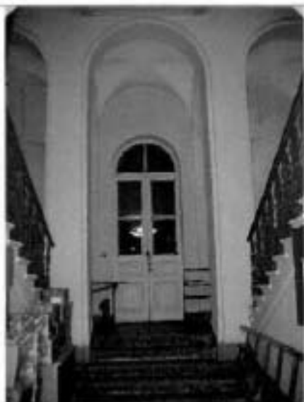
21. Помещение 1-го этажа. Фрагмент.
