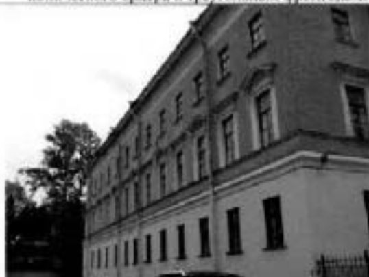
6. Северный фасад. Общий вид.
