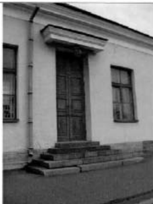
7. Дверное заполнение. Южный фасад.
