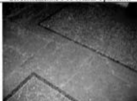
23. Напольное покрытие помещений. Фрагмент.
