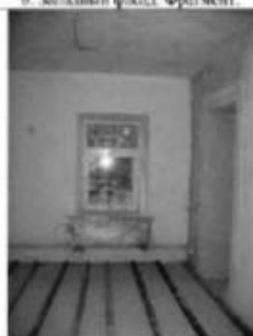
8. Помещение 1-го этажа. Общий вид.
