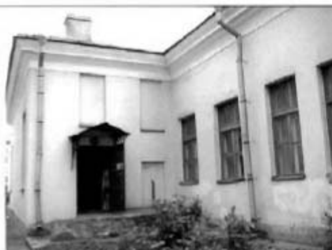
2. Фрагмент восточного фасада.
