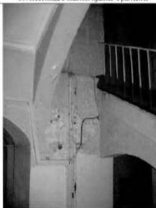
41. Лестница в южном крыле. Фрагмент.
