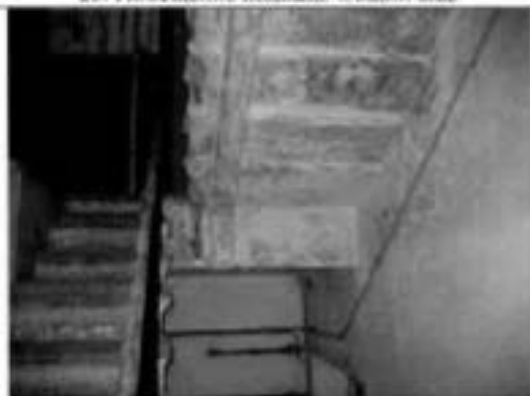
27. Лестница в западной части здания. Общий вид.
