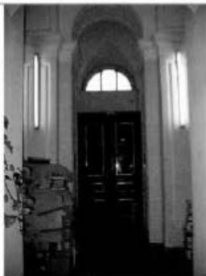
22. Помещение 1-го этажа. Фрагмент.
