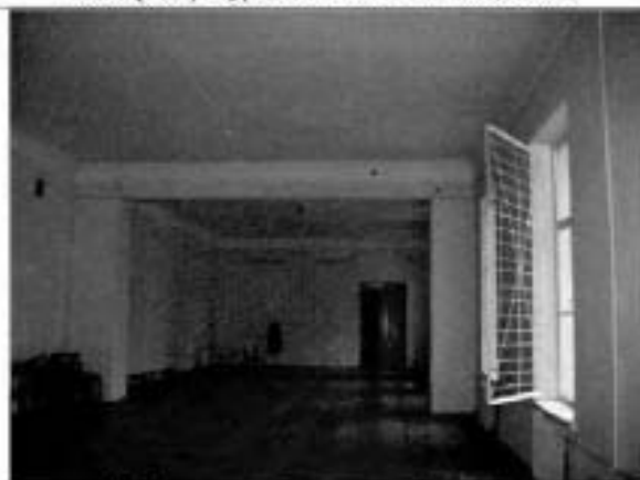
28. Помещение 2-го этажа. Общий вид.
