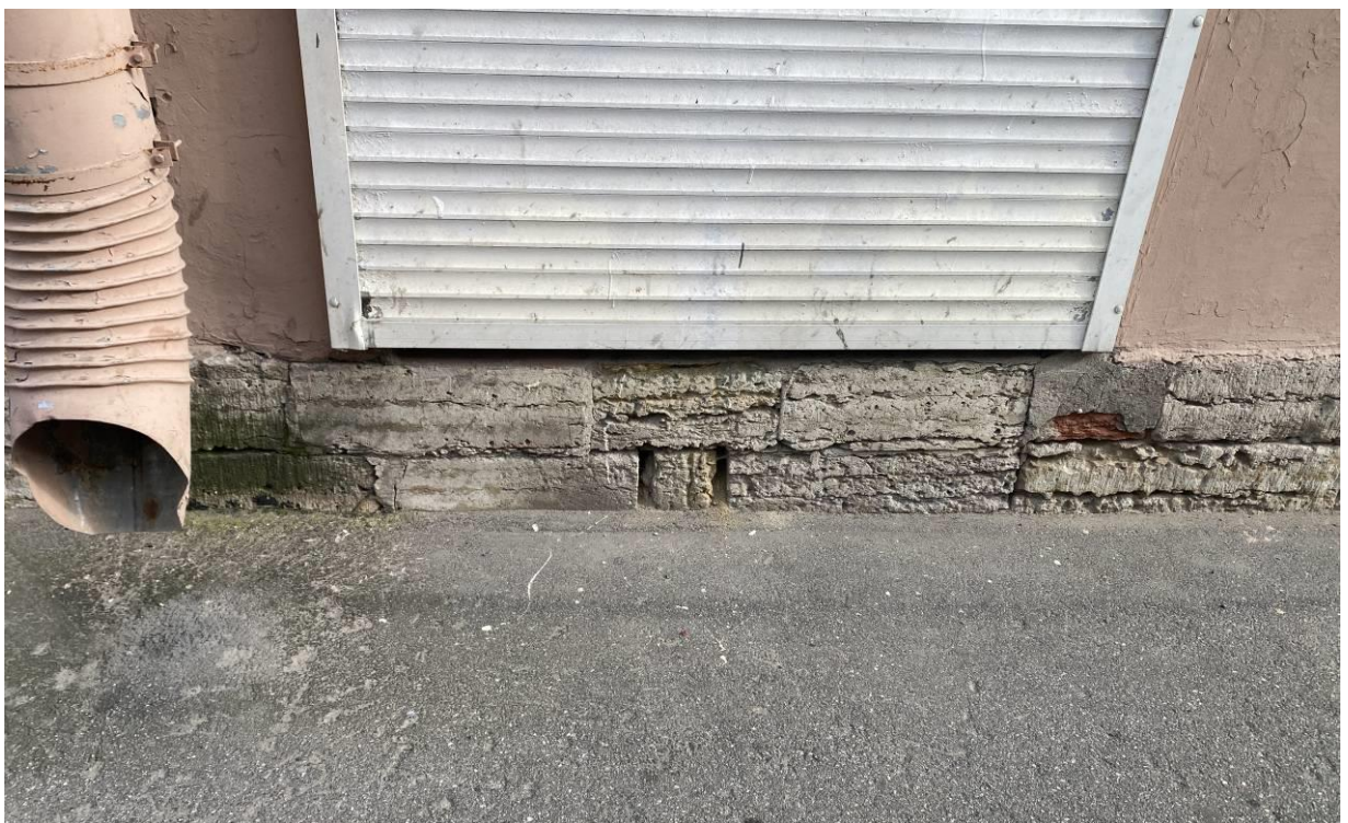
8. Лицевой фасад по Казанской ул. Фрагмент отделки цоколя на месте заложённого дверного проёма по второй световой оси.
