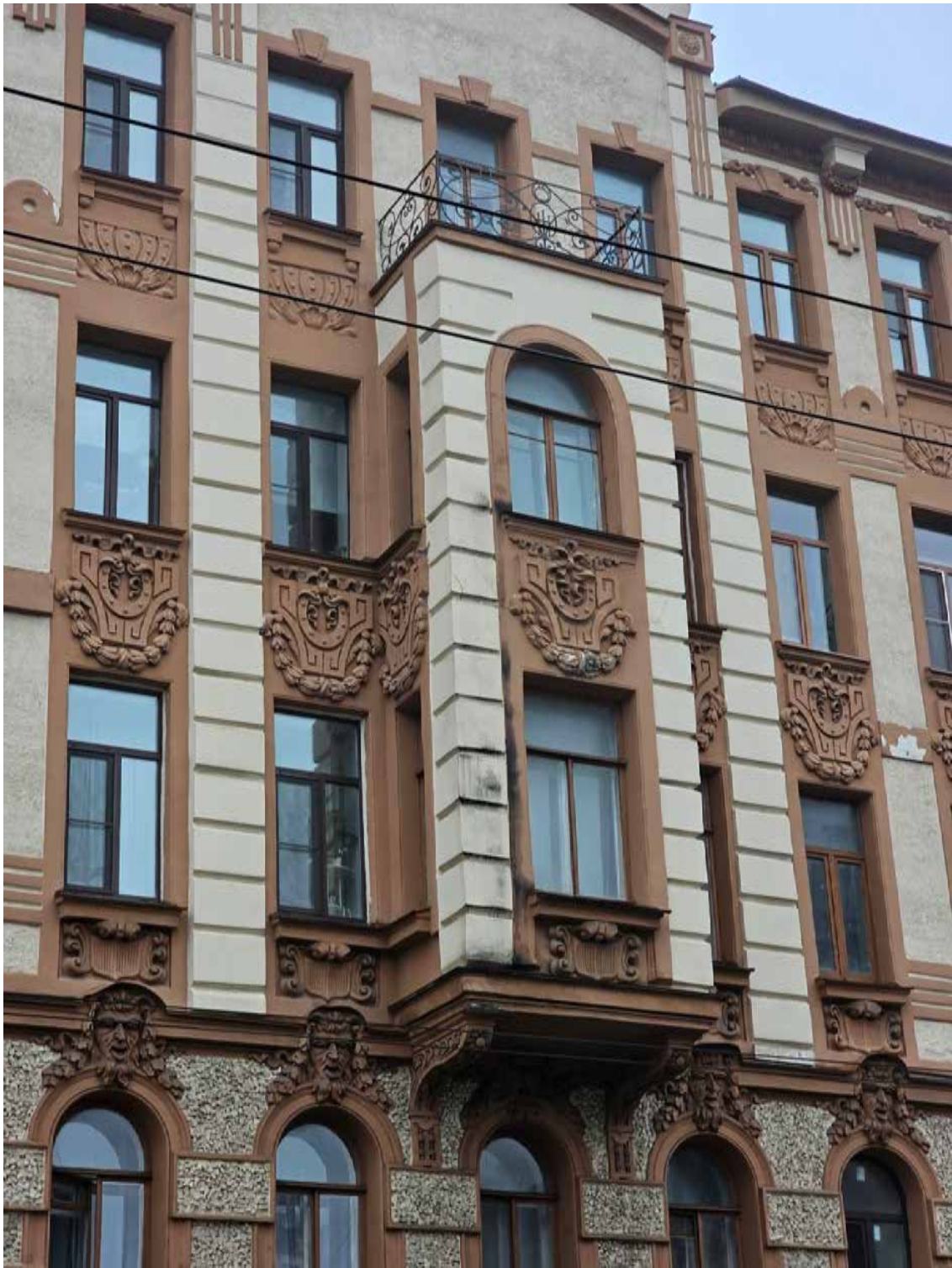
10. Выявленный объект культурного наследия «Дом И.Д. Агафонова», по адресу: г. Санкт-Петербург, Каменноостровский пр., д. 59, лит. А. Фрагмент юго-западного лицевого фасада. Эркер на орнаментированных кронштейнах в уровне 3-4-го этажей центральной части фасада. Дата съёмки: 03.11.2025.
