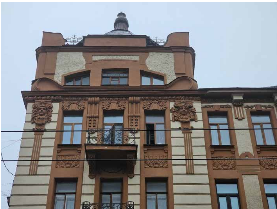
12. Выявленный объект культурного наследия «Дом И.Д. Агафонова», по адресу: г. Санкт-Петербург, Каменноостровский пр., д. 59, лит. А. Фрагмент юго-западного лицевого фасада. Ограждение угловой башни парапетом в виде глухих оштукатуренных тумб, соединенных коваными решетками. Дата съёмки: 03.11.2025.
