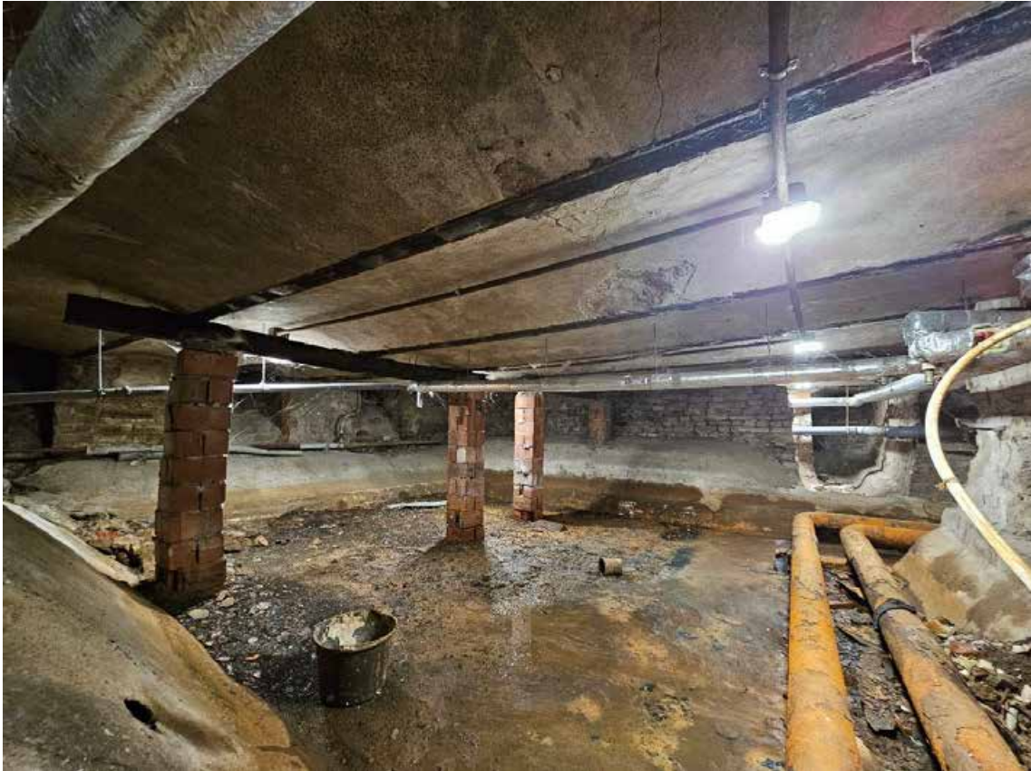
34. Выявленный объект культурного наследия «Дом И.Д. Агафонова», по адресу: г. Санкт-Петербург, Каменноостровский пр., д. 59, лит. А. Общий вид пом. Бн3 (1) в уровне подвала. Надподвальное перекрытие – бетонные своды по металлическим балкам. Дата съёмки: 03.11.2025.
