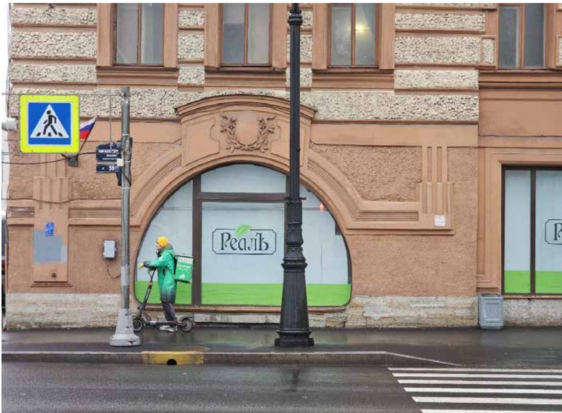
3. Выявленный объект культурного наследия «Дом И.Д. Агафонова», по адресу: г. Санкт-Петербург, Каменноостровский пр., д. 59, лит. А. Фрагмент юго-западного лицевого фасада. Витринный оконный проём 1-го этажа, оформленный профилированной штукатурной тягой и стилизованным замковым камнем с лепным декором в виде картуша. Дата съёмки: 03.11.2025.
