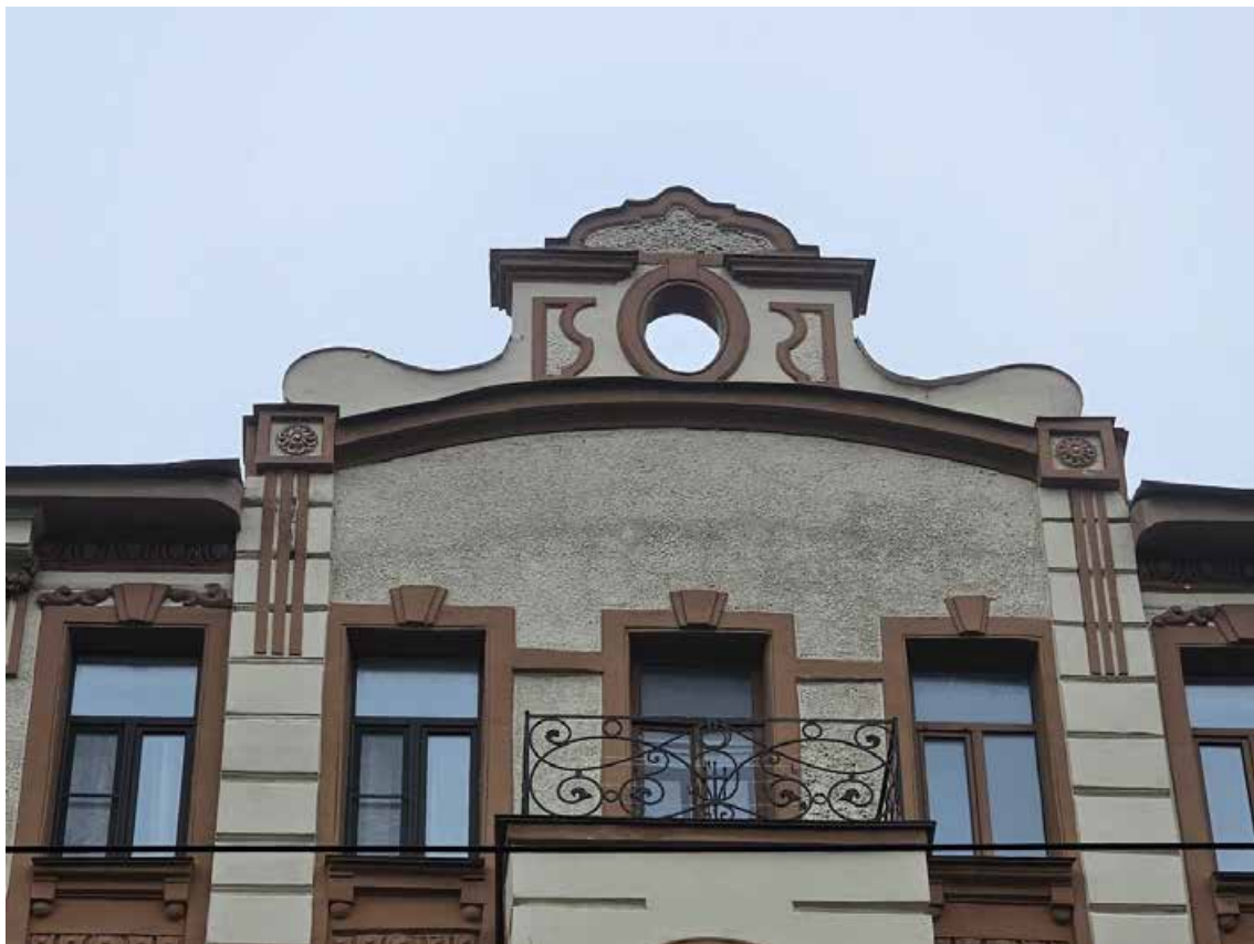
11. Выявленный объект культурного наследия «Дом И.Д. Агафонова», по адресу: г. Санкт-Петербург, Каменноостровский пр., д. 59, лит. А. Фрагмент юго-западного лицевого фасада. Криволинейный щипец с аттиком с овальным проемом в завершении центральной части фасада. Дата съёмки: 03.11.2025.
