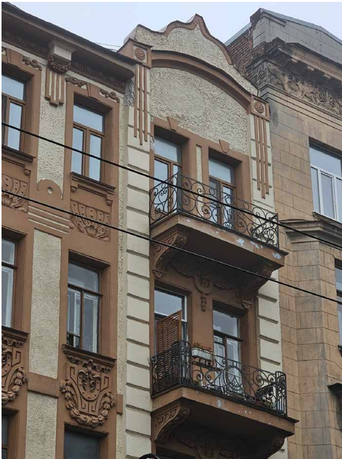
9. Выявленный объект культурного наследия «Дом И.Д. Агафонова», по адресу: г. Санкт-Петербург, Каменноостровский пр., д. 59, лит. А. Фрагмент юго-западного лицевого фасада. Балконы на оштукатуренных кронштейнах с орнаментированным ограждением кованого железа, расположенные по 17-18-й световым осям в уровне 4-го и 5-го этажей. Криволинейный щипец с килевидным завершением. Дата съёмки: 03.11.2025.
