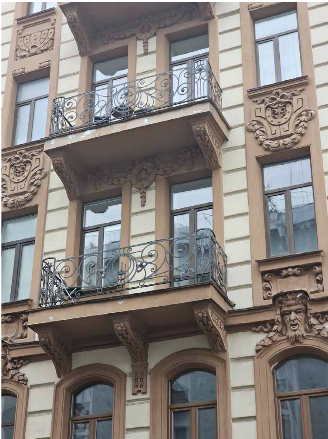
23. Выявленный объект культурного наследия «Дом И.Д. Агафонова», по адресу: г. Санкт-Петербург, Каменноостровский пр., д. 59, лит. А. Фрагмент северо-западного лицевого фасада по улице Чапыгина. Балконы на оштукатуренных кронштейнах с орнаментированным ограждением кованого железа, расположенные по 25-26-й световым осям в уровне 3-го и 4-го этажей. Дата съёмки: 03.11.2025.
