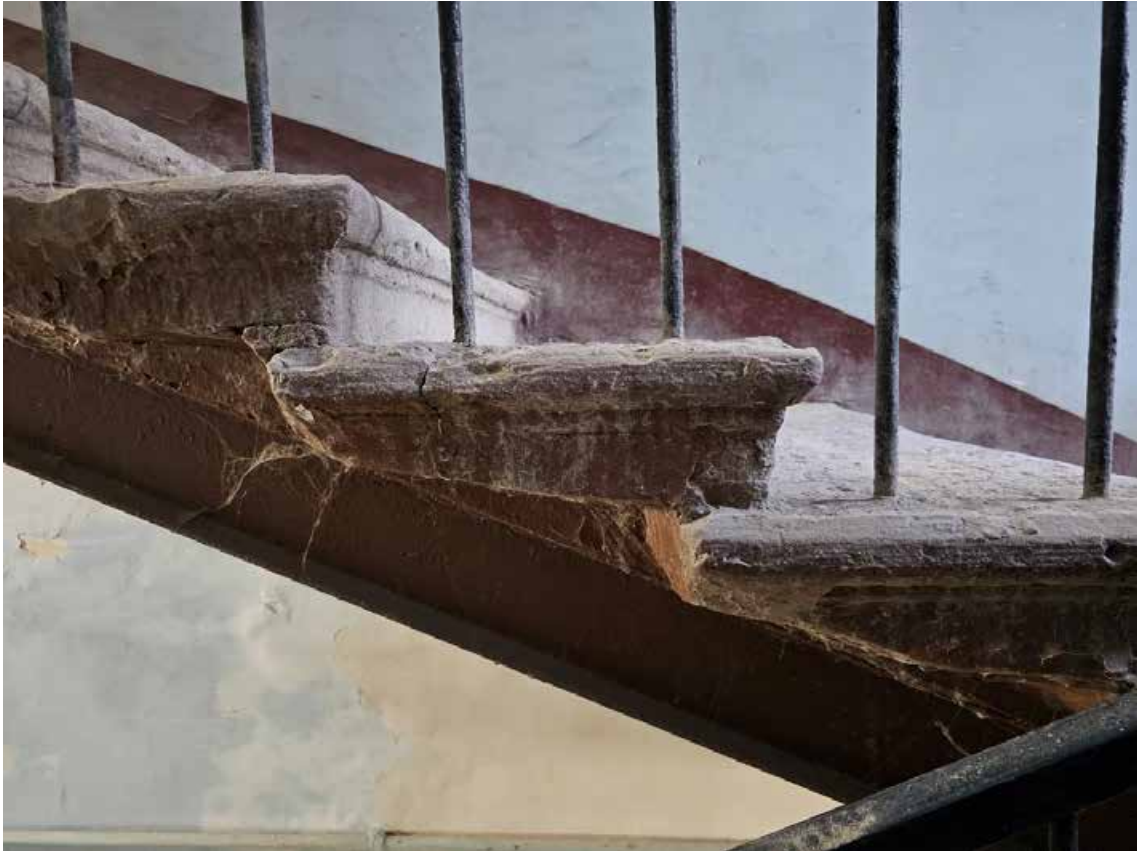
47.Выявленный объект культурного наследия «Дом И.Д. Агафонова», по адресу: г. Санкт-Петербург, Каменноостровский пр., д. 59, лит. А. Профиль ступеней 2-го марша лестницы б/н, расположенной в центральной части лицевого корпуса по Каменноостровскому пр. Дата съёмки: 03.11.2025.
