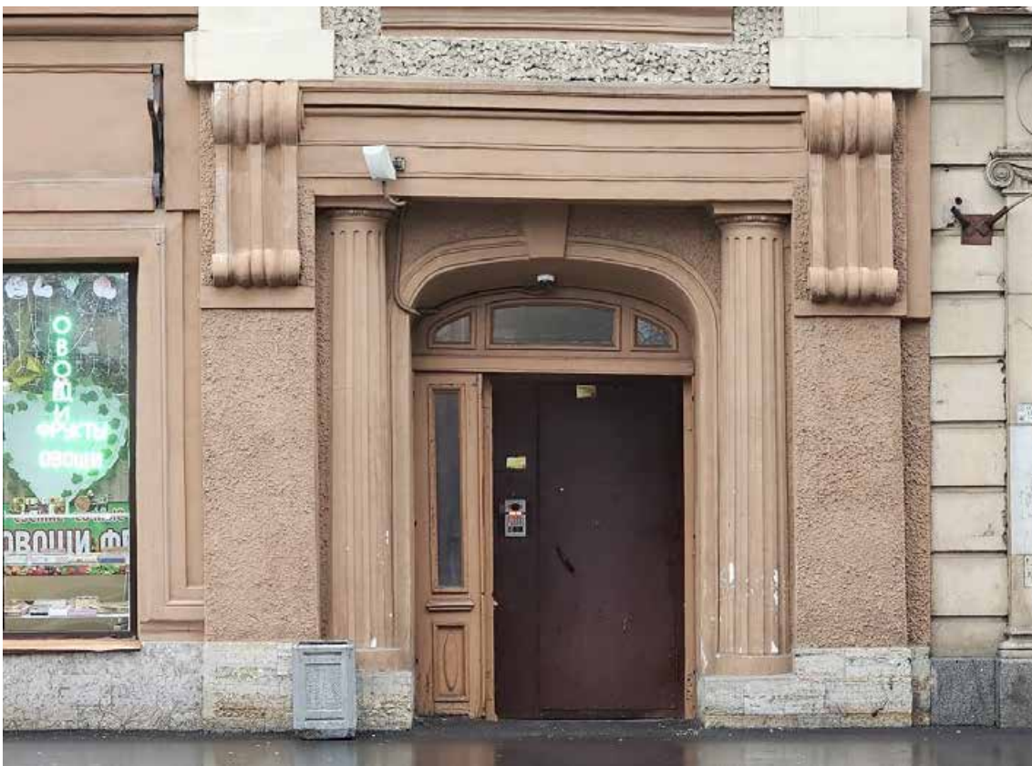
4. Выявленный объект культурного наследия «Дом И.Д. Агафонова», по адресу: г. Санкт-Петербург, Каменноостровский пр., д. 59, лит. А. Фрагмент юго-западного лицевого фасада. Оформление исторического дверного проема 1-го этажа в виде портала с 3/4 каннелированными колоннами. Дата съёмки: 03.11.2025.
