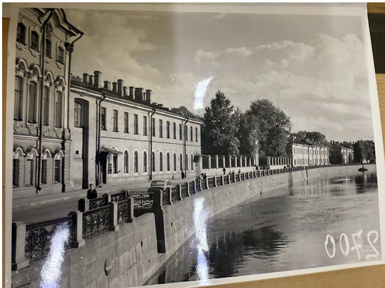
Рис. 106. Государственный педагогический институт имени А. И. Герцена (б. дворец К. Г. Разумовского, наб. реки Мойки, 48). Фото 1995 года. Источник: Сектор хранения документированной информации Управление организационного обеспечения и контроля КГИОП (архив КГИОП). Фототека охраны памятников, ф №11.
