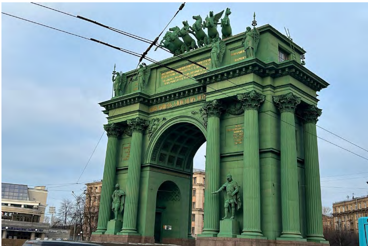
Рис. 40. Нарвские триумфальные ворота в Санкт-Петербурге. Источник: https://dzen.ru/a/ZgjnayTtu0iLLNs
