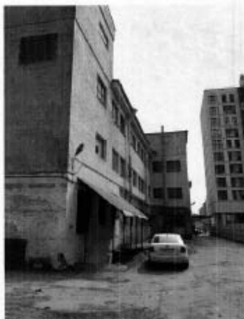
9. Фрагмент юго-западного фасада объекта культурного наследия.
