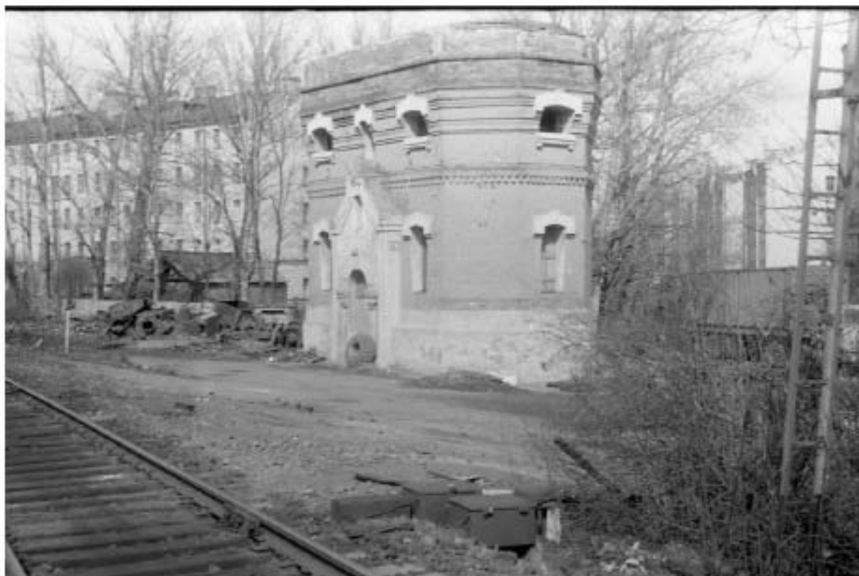
Илл. 28. Водокачальня товарной станции Московско-Виндаво-Рыбинской железной дороги. Фото 1992 г. http://www.pastvu.com
