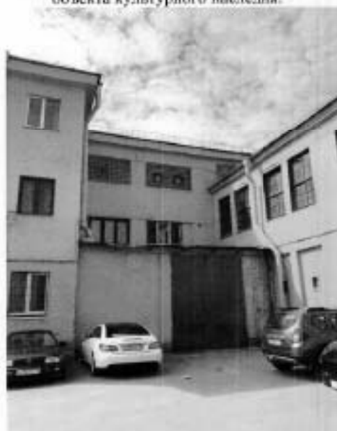
6. Фрагмент северо-восточного фасада объекта культурного наследия.
