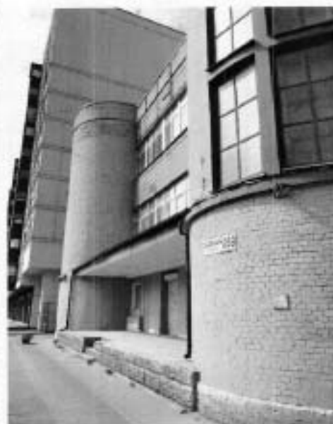
5. Фрагмент юго-восточного фасада объекта культурного наследия.
