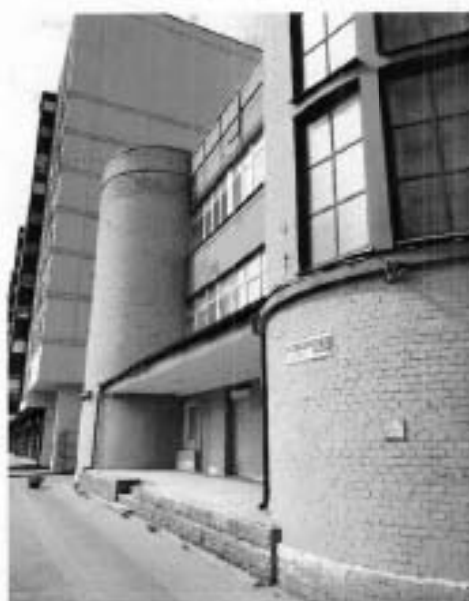
4. Фрагмент юго-восточного фасада объекта культурного наследия.
