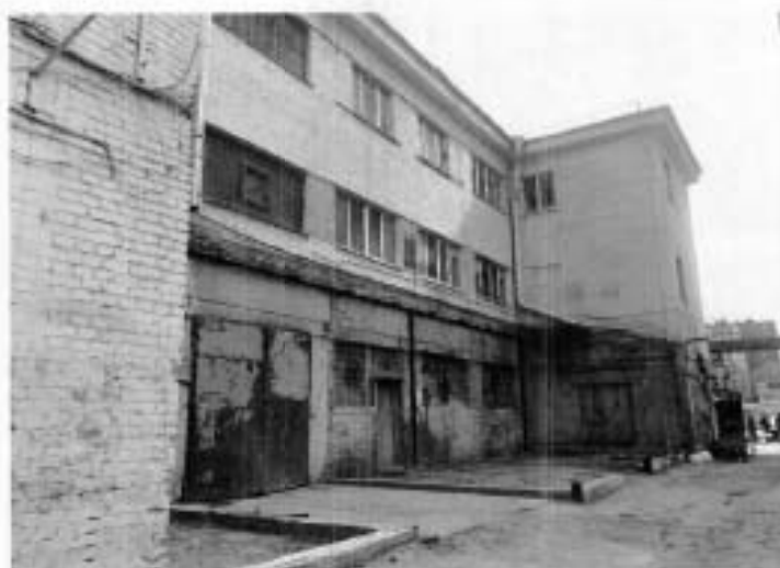
8. Фрагмент юго-западного фасада объекта культурного наследия.
