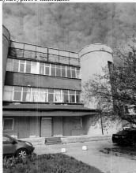
3. Фрагмент северо-восточного фасада объекта культурного наследия.
