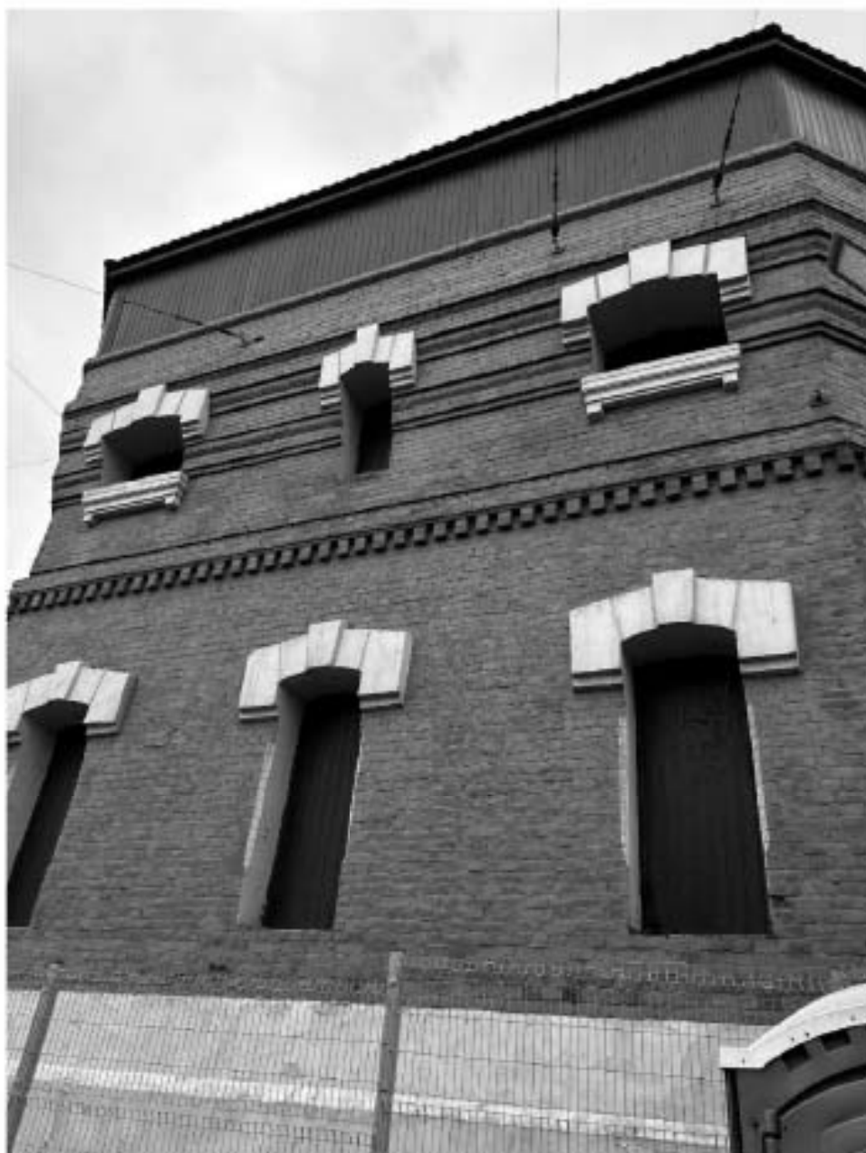
51. Вид на объект культурного наследия «Водокачалня товарной станции Московско-Виндаво-Рыбинской железной дороги», расположенный по адресу: г. Санкт-Петербург, Боровая ул., д. 63, лит. А
