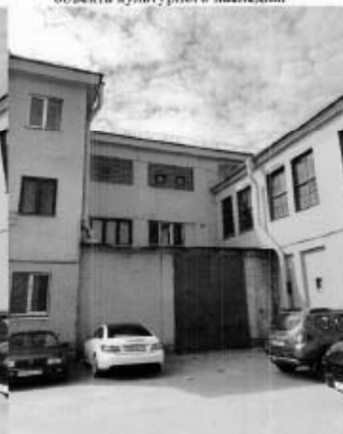
7. Фрагмент северо-восточного фасада объекта культурного наследия.
