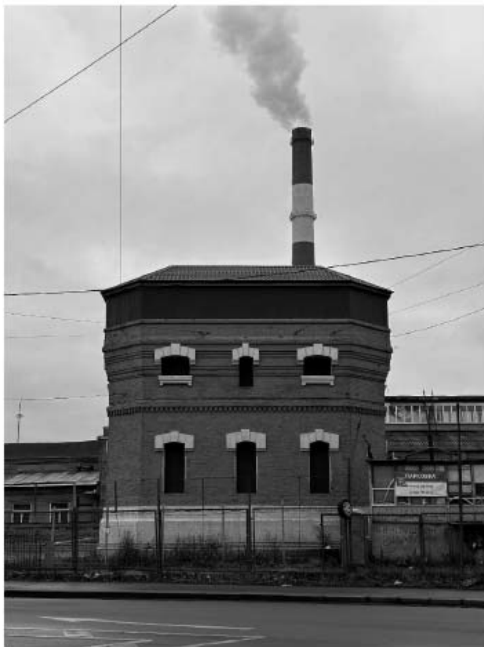
47. Вид на объект культурного наследия «Водокачалня товарной станции Московско-Виндаво-Рыбинской железной дороги», расположенный по адресу: г. Санкт-Петербург, Боровая ул., д. 63, лит. А
