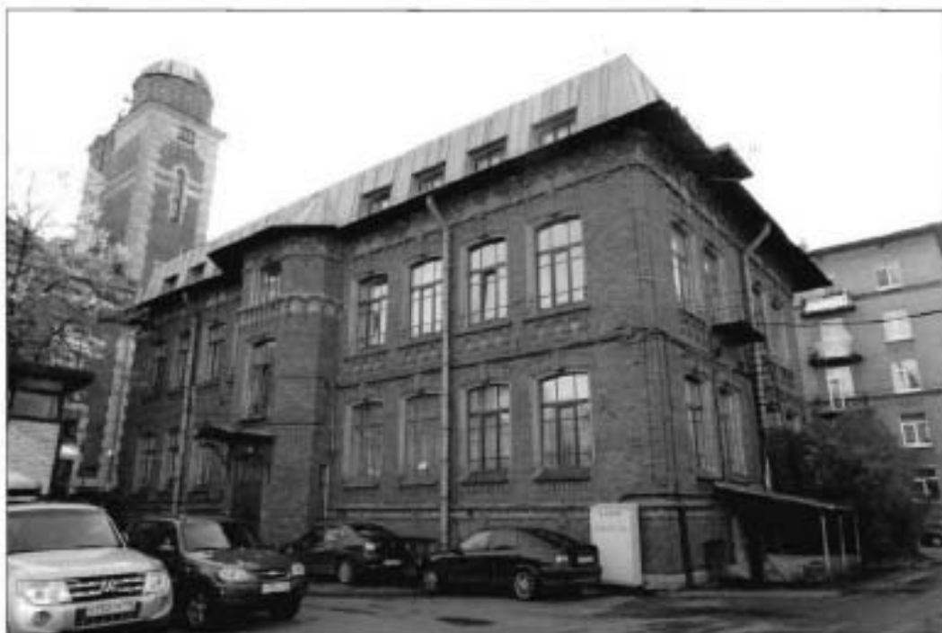
2. Общий вид с северо-запада.
