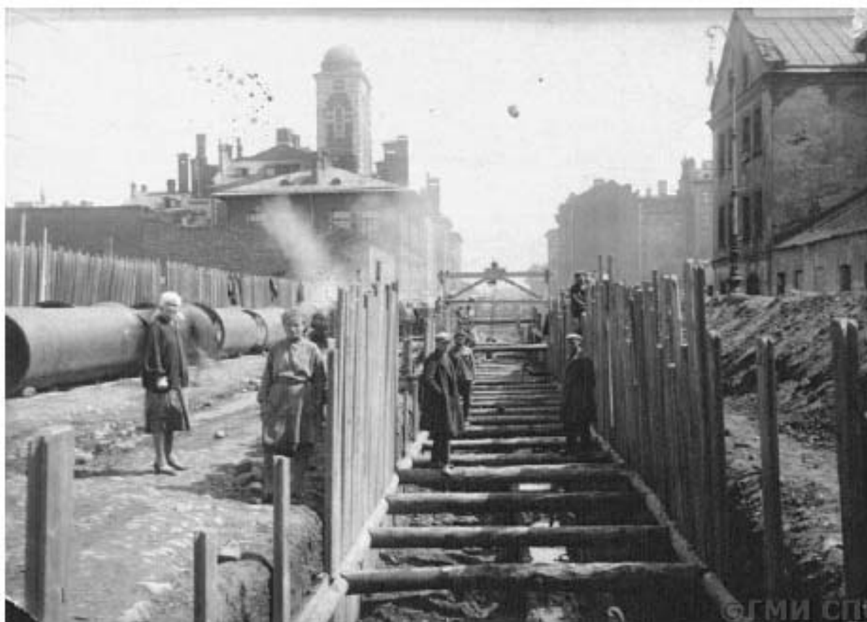
Илл. 10. Прокладка канализационных труб на Прилукской улице. Прилукская улица у дома № 22. Фото 1931 г. http://www.pastvu.com
