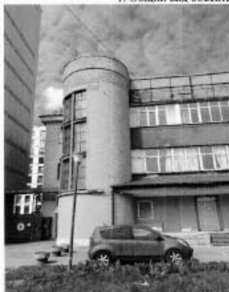
2. Фрагмент юго-восточного фасада объекта культурного наследия.
