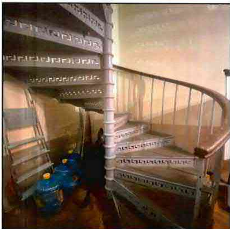
13. Кованная металлическая винтовая лестница в помещении 34-Н(14).
