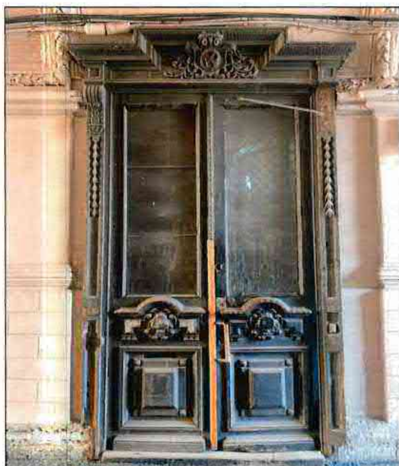
8. Деревянные двери с декоративным навершием, раскрепованным резным деревянным паличником и растительным резным орнаментом.
