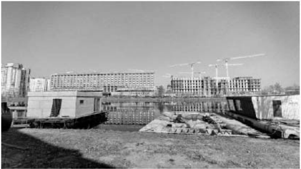
Фото 7. Объект культурного наследия федерального значения «Галерная гавань Гребного порта» (Санкт-Петербург, Шкиперский проток ул., 14-а, 20; 21, корп. 1; 23, корп. 2; 25). Бассейн большой. Общий вид с западной стороны.
