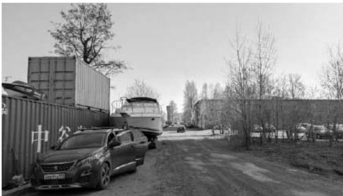
Фото 3. Объект культурного наследия федерального значения «Галерная гавань Гребного порта» (Санкт-Петербург, Шкиперский проток ул., 14-а, 20; 21, корп. 1; 23, корп. 2; 25). Бассейн большой. Общий вид с северной стороны.
