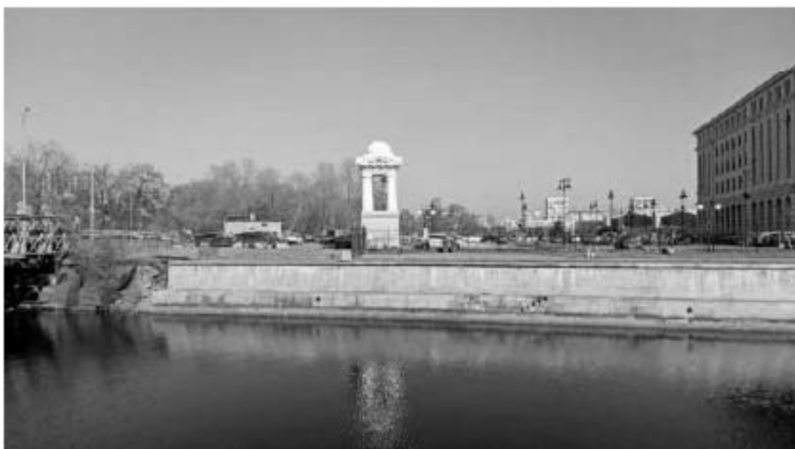
Фото 10. Объект культурного наследия федерального значения «Галерная гавань Гребного порта» (Санкт-Петербург, Шкиперский проток ул., 14-а, 20; 21, корп. 1; 23, корп. 2; 25). Канал входной. Общий вид с западной стороны.
