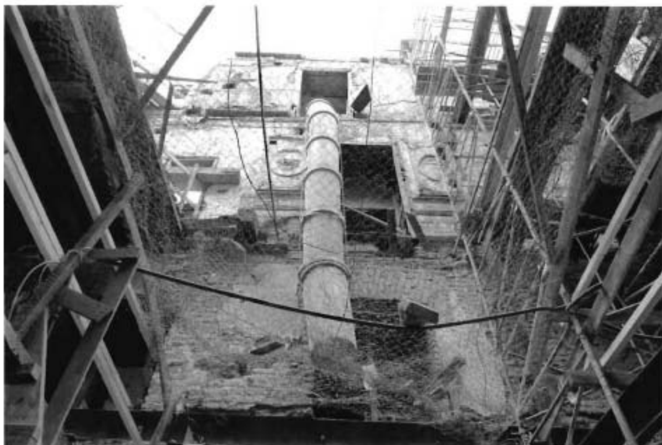
4. Стена объема лестничной клетки объекта культурного наследия.
