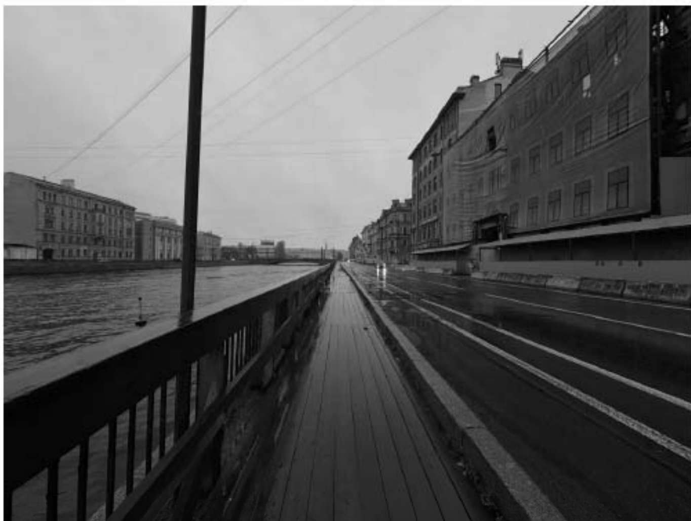
Фот.4. Вид на участок производства работ на правом берегу набережной реки Фонтанки, объект культурного наследия федерального значения «Набережные со спусками», объект культурного наследия регионального значения «Дом А.Я. Шагина (Зыковы)», где располагалась редакция журнала «Русская старина», выявленный объект культурного наследия «Дом Зыковы»
