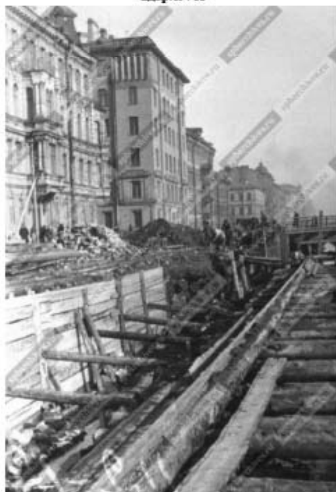
Илл. 24. Ремонт набережной на реке Фонтанке у Египетского моста. 1936 г., автор фото Федосеев В.Г., ЦГАКФФД СПб. Фотодокументы. Опись 1АР-18. Едхр.32481
