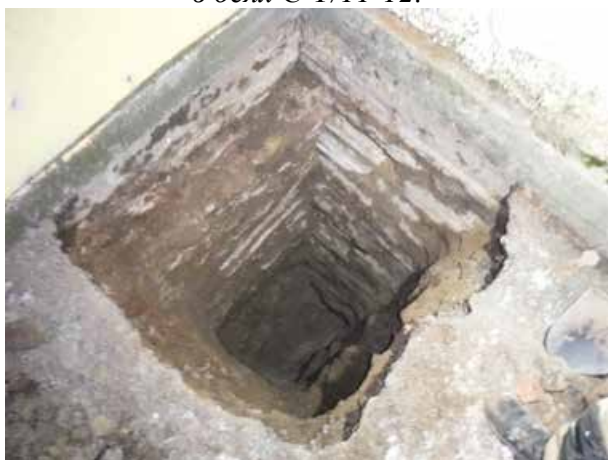
Илл.25 - Шурф №3. Ленточный бутовый фундамент под кирпичные стены в осях Е-И/9-10.
