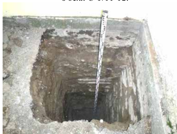
Илл.26 - Шурф №3. Ленточный бутовый фундамент под кирпичные стены в осях Е-И/9-10.
