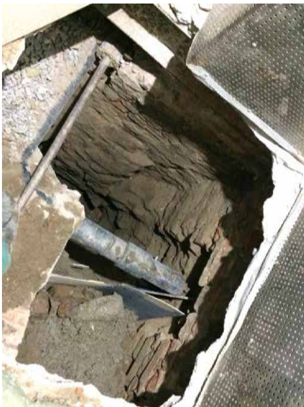
Илл.21 - Шурф №1. Ленточный бутовый фундамент под кирпичные стены в осях С-Т/4-5.
