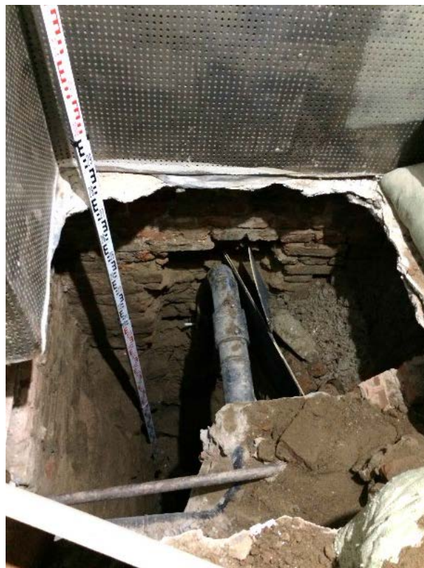
Илл.22 - Шурф №1. Ленточный бутовый фундамент под кирпичные стены в осях С-Т/4-5.
