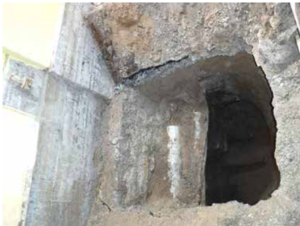
Илл.23 - Шурф №2. Ленточный бутовый фундамент под кирпичные стены в осях С-Т/11-12.
