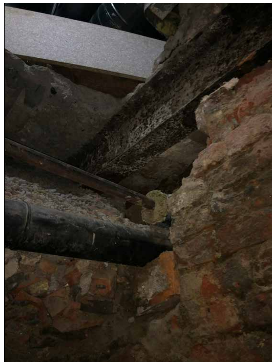
Металлические балки в направлении разреза 1-1
