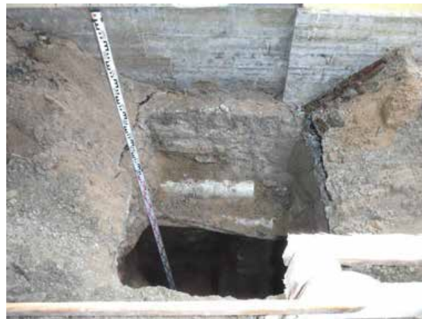
Илл.24 - Шурф №2. Ленточный бутовый фундамент под кирпичные стены в осях С-Т/11-12.
