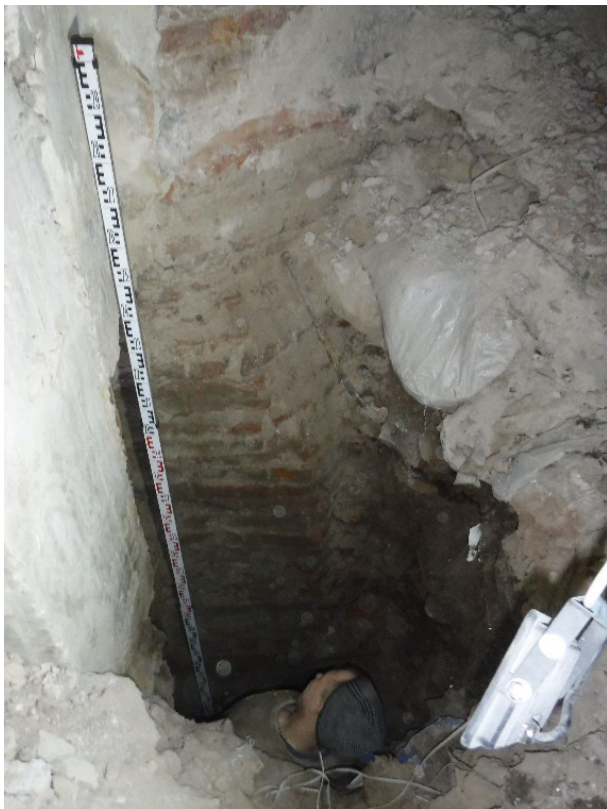
Илл.27 - Шурф №4. Леночный бутовый фундамент под кирпичные стены в осях В-Д/8-9.
