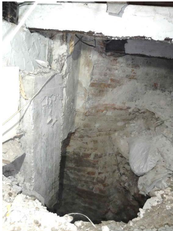
Илл.28 - Шурф №4. Леночный бутовый фундамент под кирпичные стены в осях В-Д/8-9.
