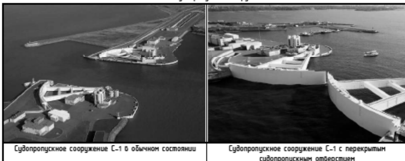
Рис. 1. Судопропускное сооружение С-1
