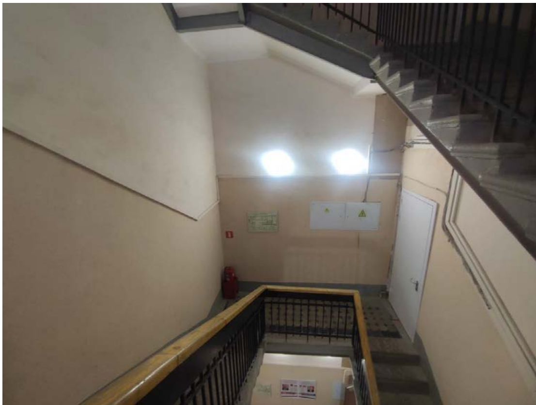
Фото №63 Лестничная клетка 2-3 этаж.
