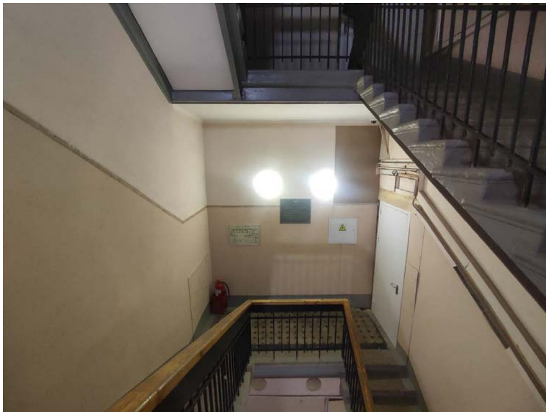
Фото №61 Лестничная клетка 4-5 этаж.
