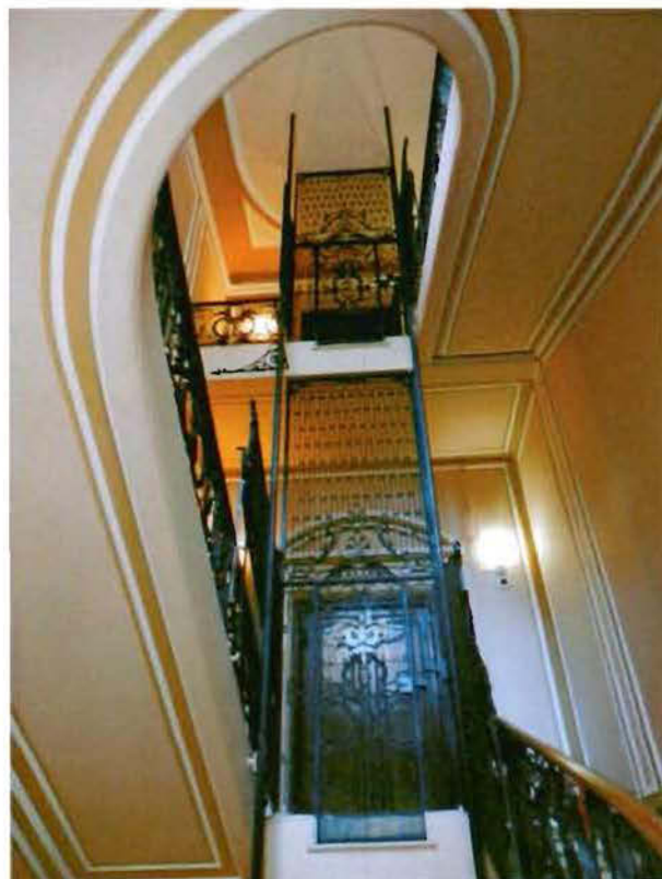
13. Кованое ограждение шахты лифта
