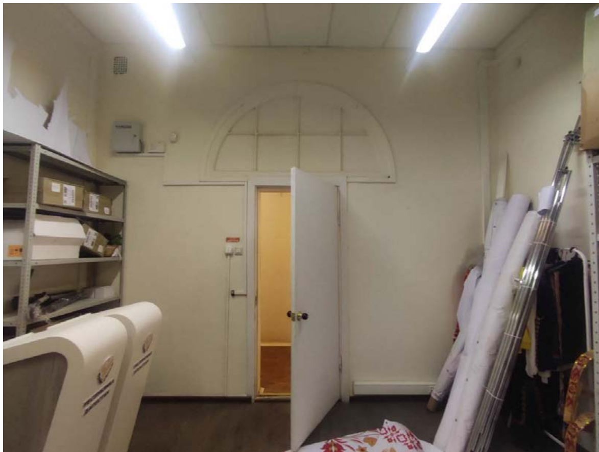
Фото №7 Интерьер пом. 12.
