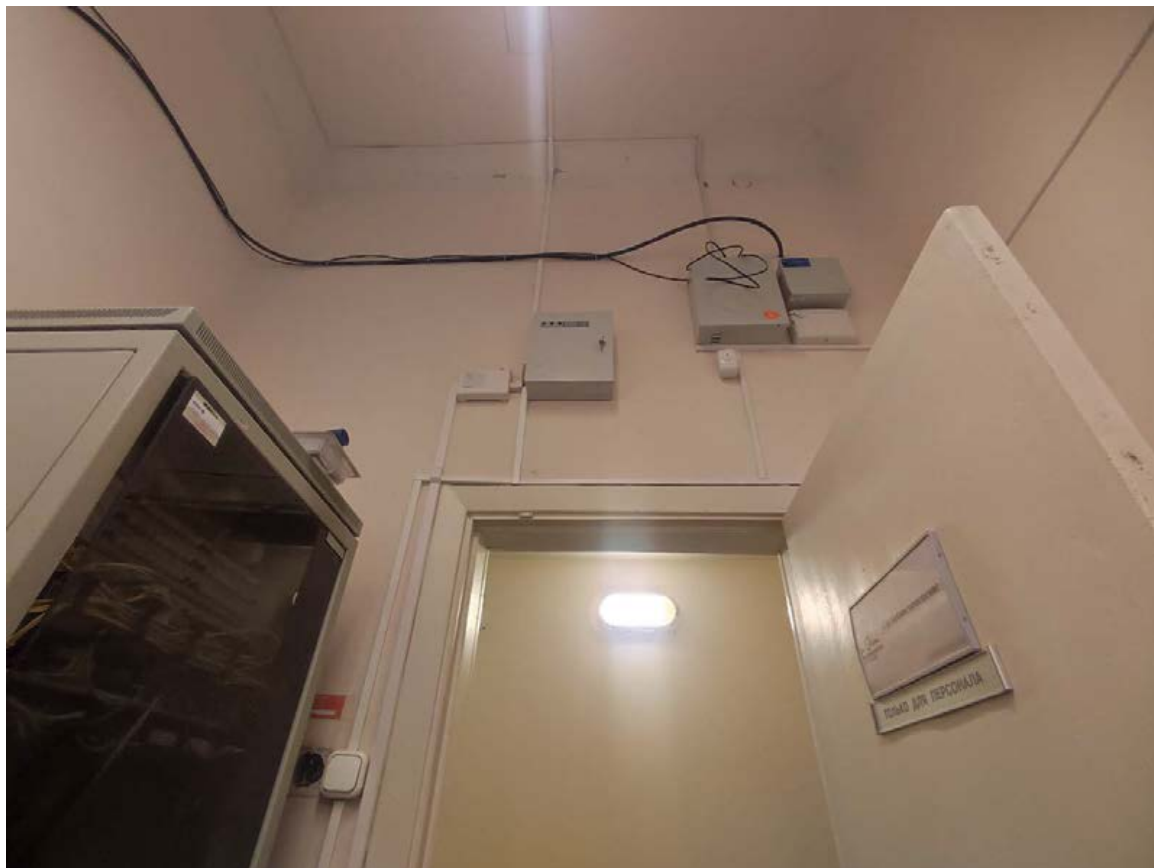
Фото №5 Интерьер пом. 10.
