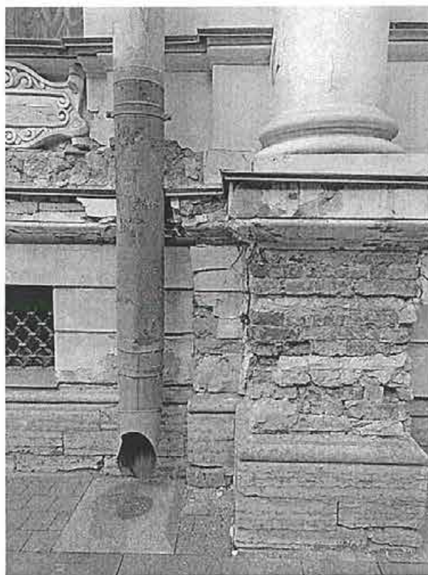
2. Вид на северный фасад объекта культурного наследия, биопоражения из-за деформации элемента водосточной трубы
