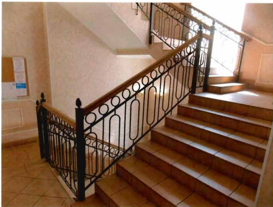
12. Трехмаршевая лестница служебного корпуса (дата съемки 23.05.2022).
