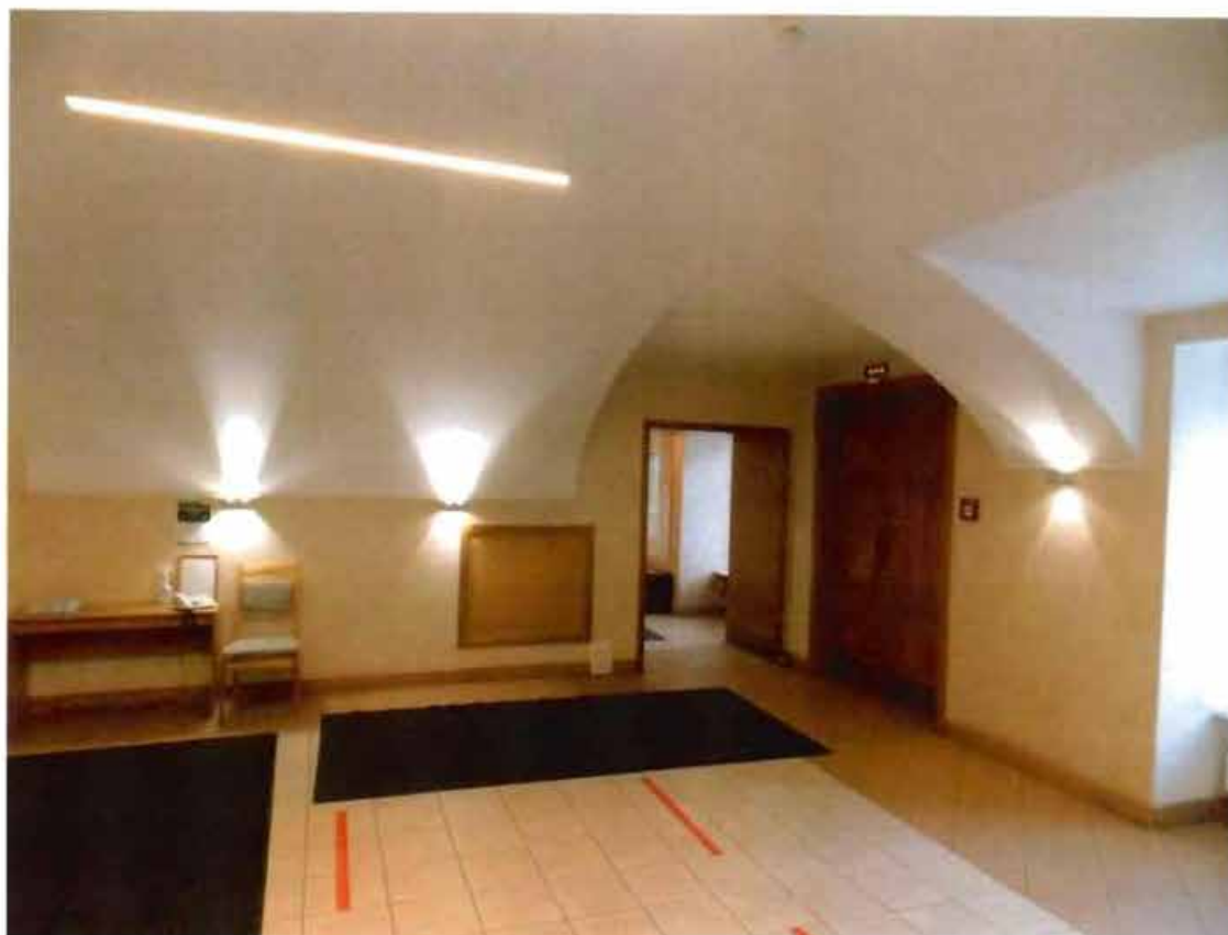
10. Помещение музея «Гознака». Сомкнутый с распалубками свод (дата съемки 23.05.2022).
