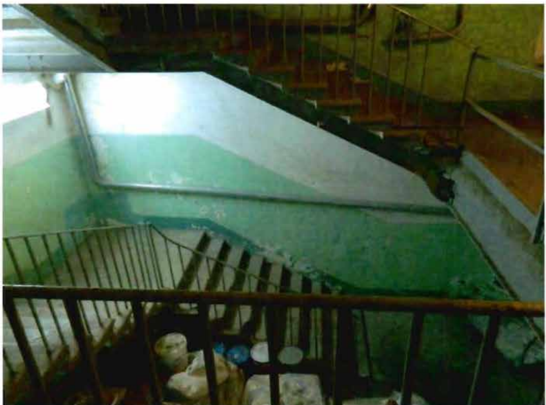
27. Трехмаршевая лестница в северной части корпуса 2.
