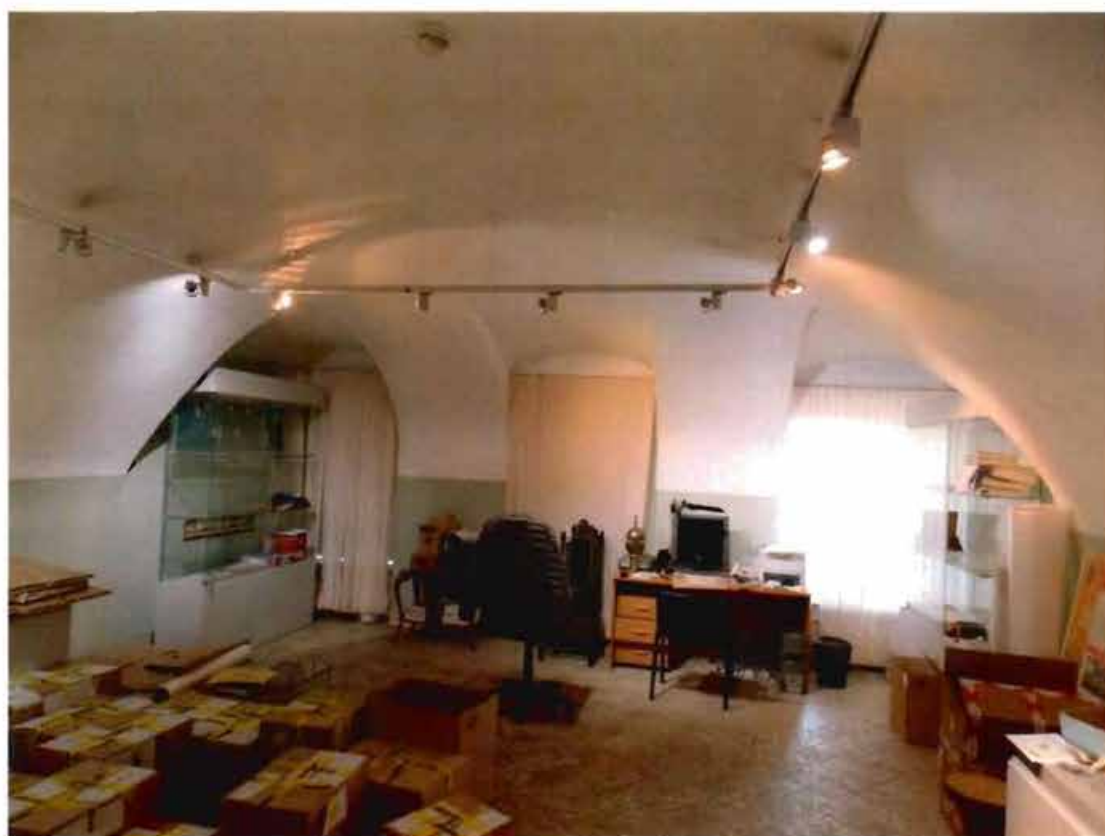
10. Помещение музея «Гознака». Сомкнутый с распалубками свод (дата съемки 23.05.2022).
