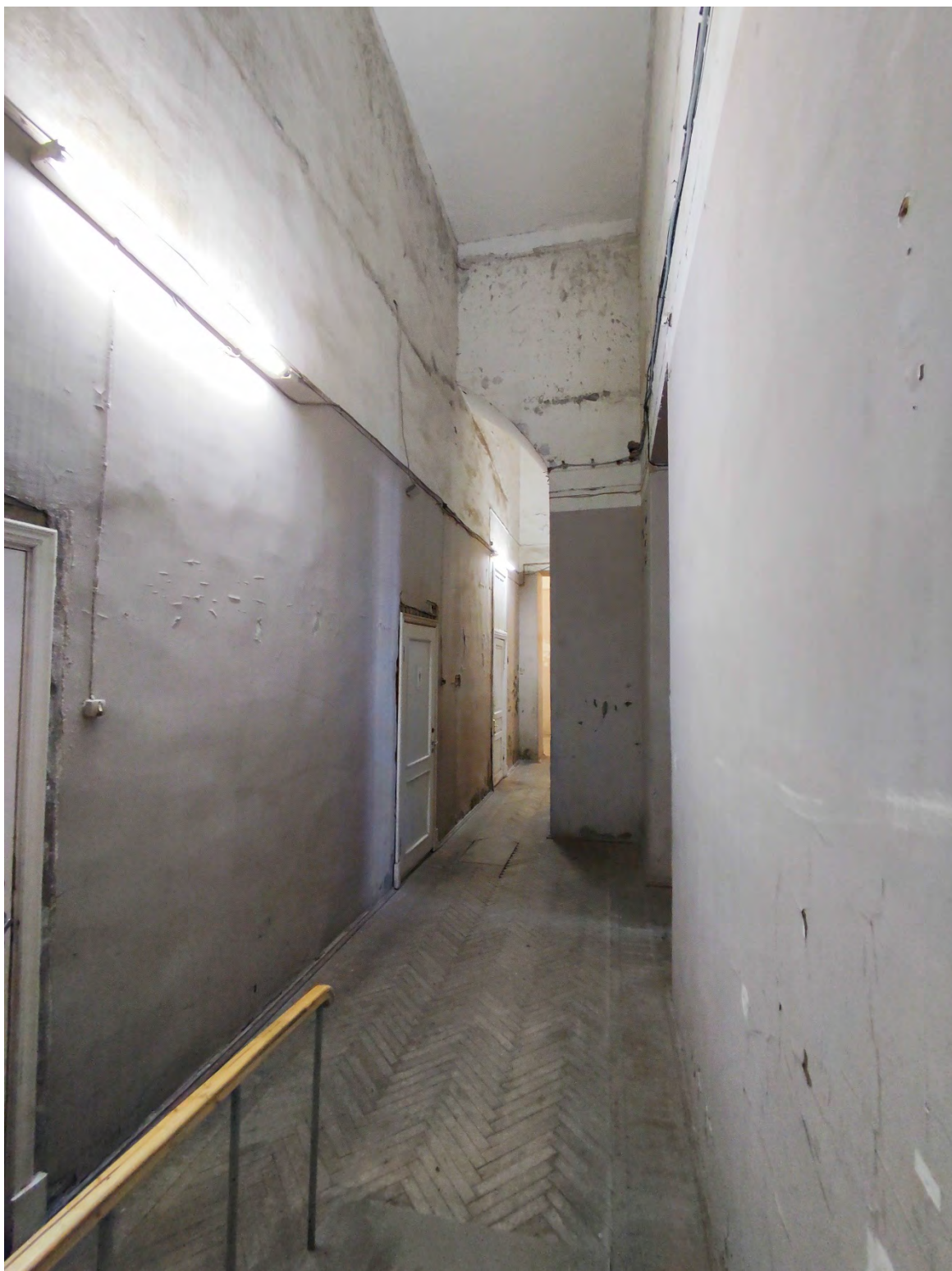
33. Коридор в северной части Камер-юнгферских комнат Фото 2021 г.
