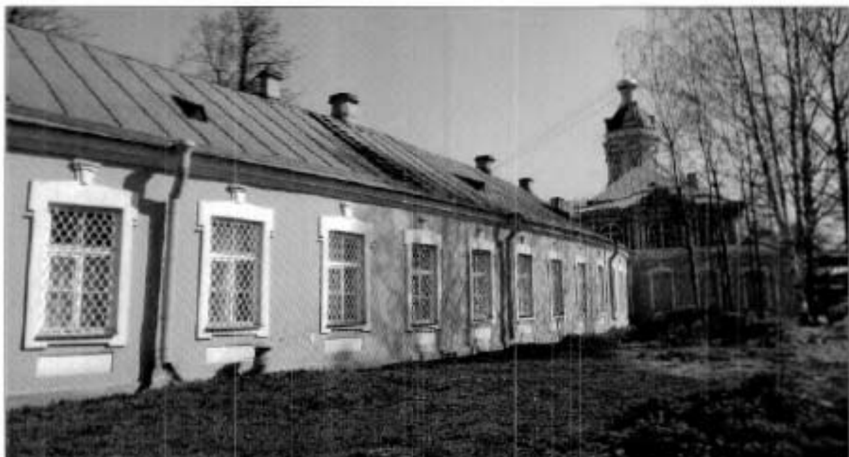
5. Южный фасад. Восточная часть задняя. Вид с юго-запада.
