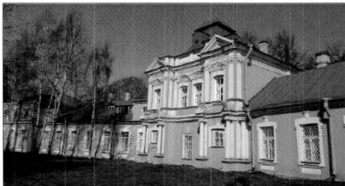
4. Южный фасад. Башенный объем. Вид с юго-востока.
