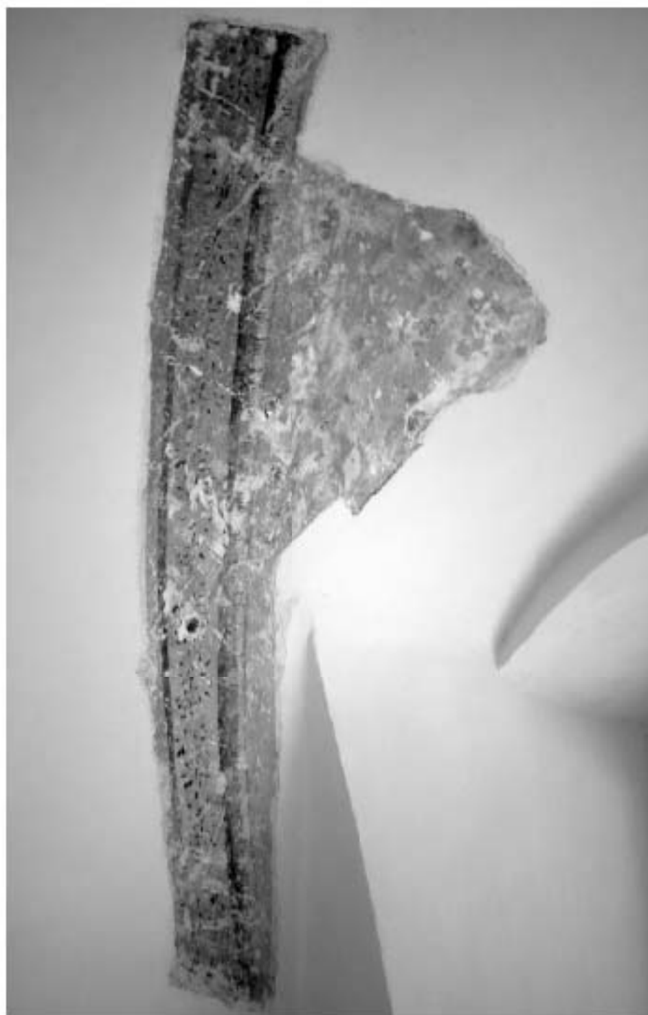
Фото 24. ОКН федерального значения «Корпус семинарский с южными воротами главного двора» (г. Санкт-Петербург, набережная реки Монастырки, дом 1, лит. Г). Первый этаж. Помещение 3-Н (43). Фрагмент расчисток. Съёмка 08.11.2021 г.
