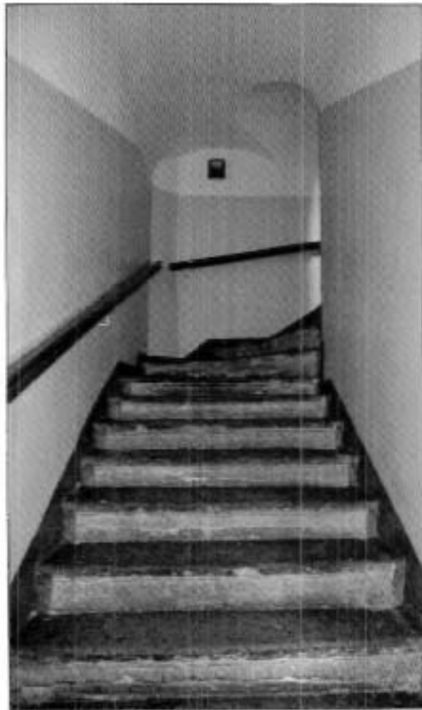
8. Лестница в западной части здания.
