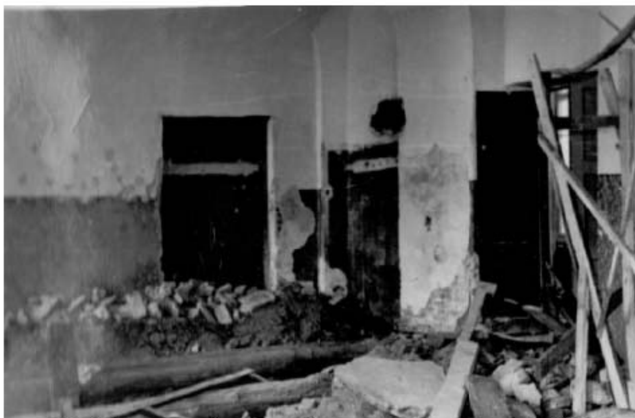
Илл.31. Помещение в одноэтажном флигеле в процессе реконструкции. 1960.
