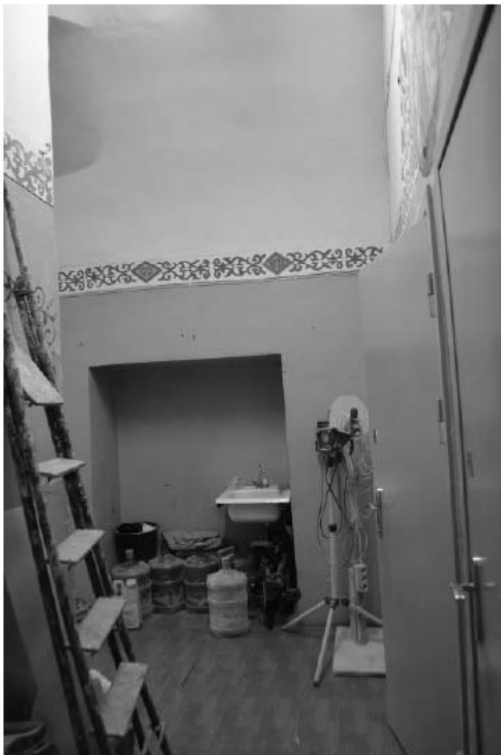
Фото 21. ОКН федерального значения «Корпус семинарский с южными воротами главного двора» (г. Санкт-Петербург, набережная реки Монастырки, дом 1, лит. Г). Первый этаж. Помещение 3-Н (44). Съёмка 08.11.2021 г.
