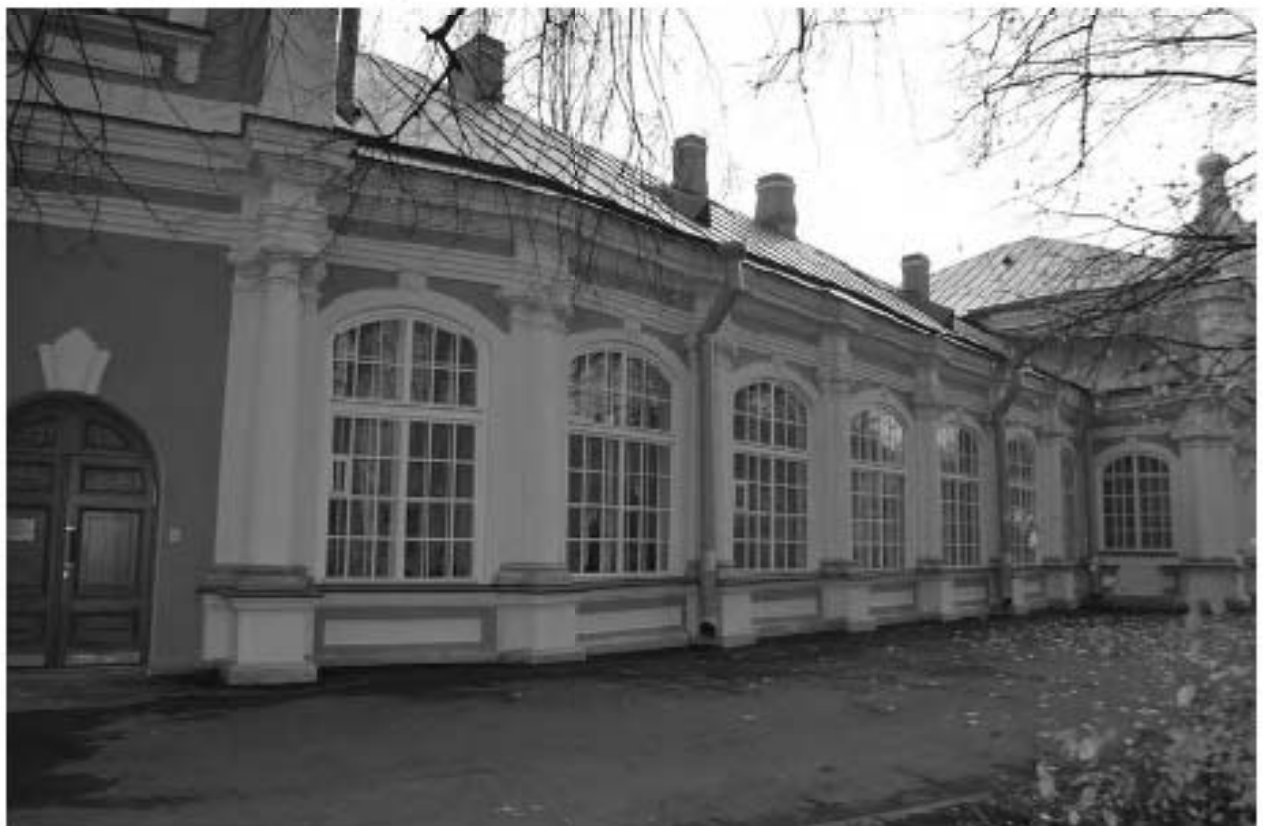
Фото 07. ОКН федерального значения «Корпус семинарский с южными воротами главного двора» (г. Санкт-Петербург, набережная реки Монастырки, дом 1, лит. Г). Северо-западный фасад. Крыша. Фрагмент. Съёмка 08.11.2021 г.
