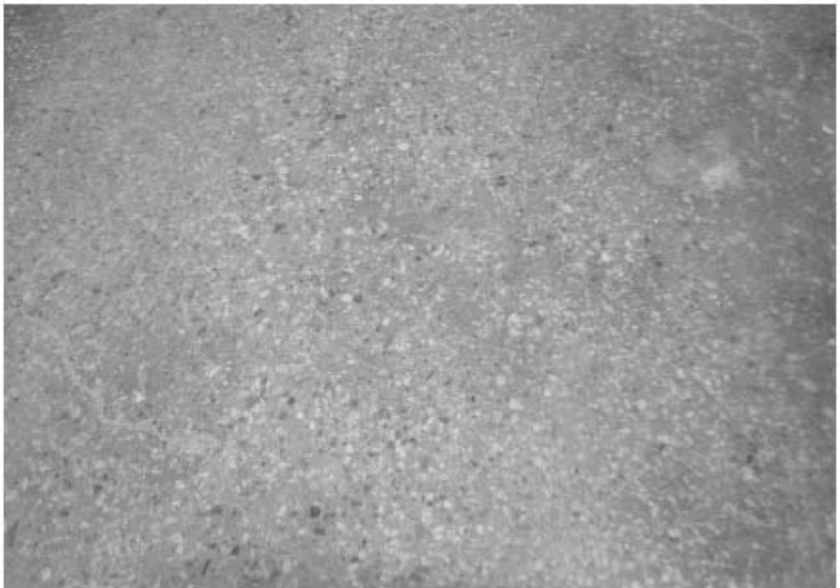
Фото 12. ОКН федерального значения «Корпус семинарский с южными воротами главного двора» (г. Санкт-Петербург, набережная реки Монастырки, дом 1, лит. Г). Первый этаж. Галерея первого этажа. Облицовка пола. Съёмка 08.11.2021 г.
