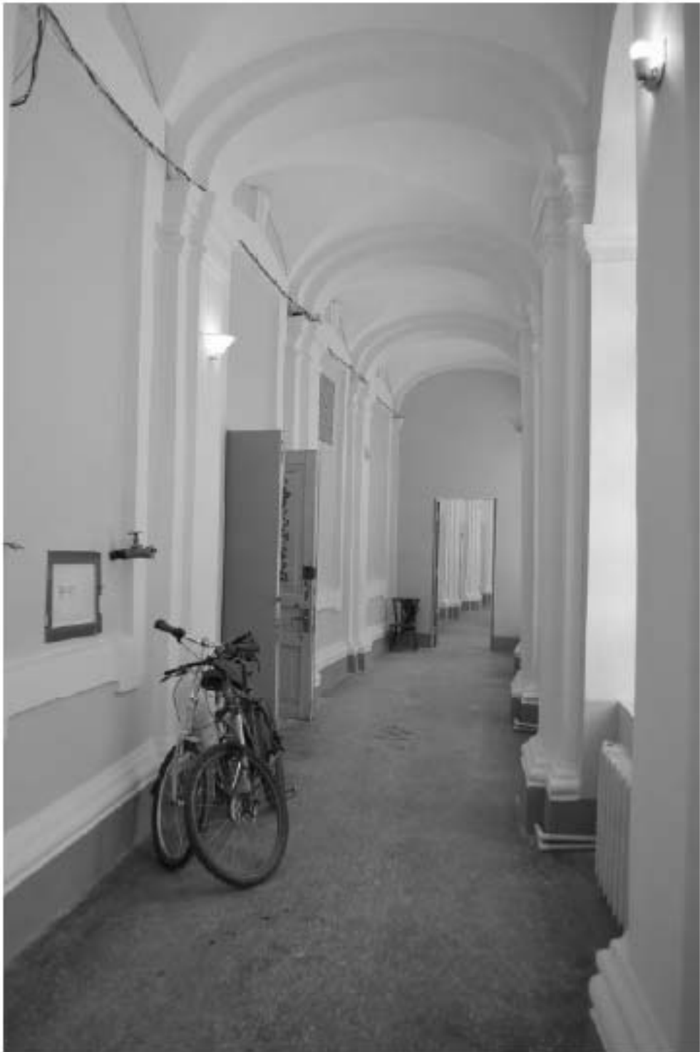
Фото 10. ОКН федерального значения «Корпус семинарский с южными воротами главного двора» (г. Санкт-Петербург, набережная реки Монастырки, дом 1, лит. Г). Первый этаж. Галерея первого этажа. Съёмка 08.11.2021 г.
