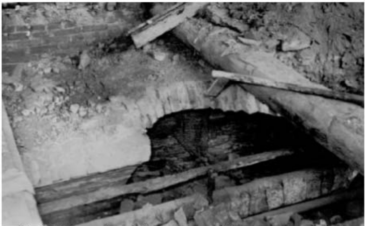
Илл. 30. Разборка свода над подвалом в восточной одноэтажном флигеле. 1960.
