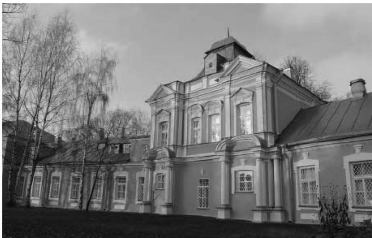
Фото 02. ОКН федерального значения «Корпус семинарский с южными воротами главного двора» (г. Санкт-Петербург, набережная реки Монастырки, дом 1, лит. Г). Юго-восточный фасад. Крыша. Фрагмент. Съёмка 08.11.2021 г.
