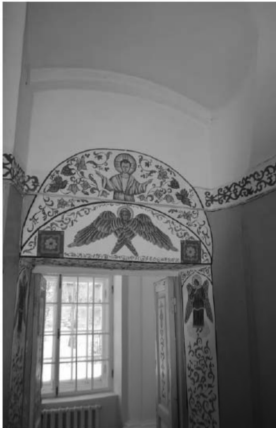
Фото 20. ОКН федерального значения «Корпус семинарский с южными воротами главного двора» (г. Санкт-Петербург, набережная реки Монастырки, дом 1, лит. Г). Первый этаж. Помещение 3-Н (45). Съёмка 08.11.2021 г.
