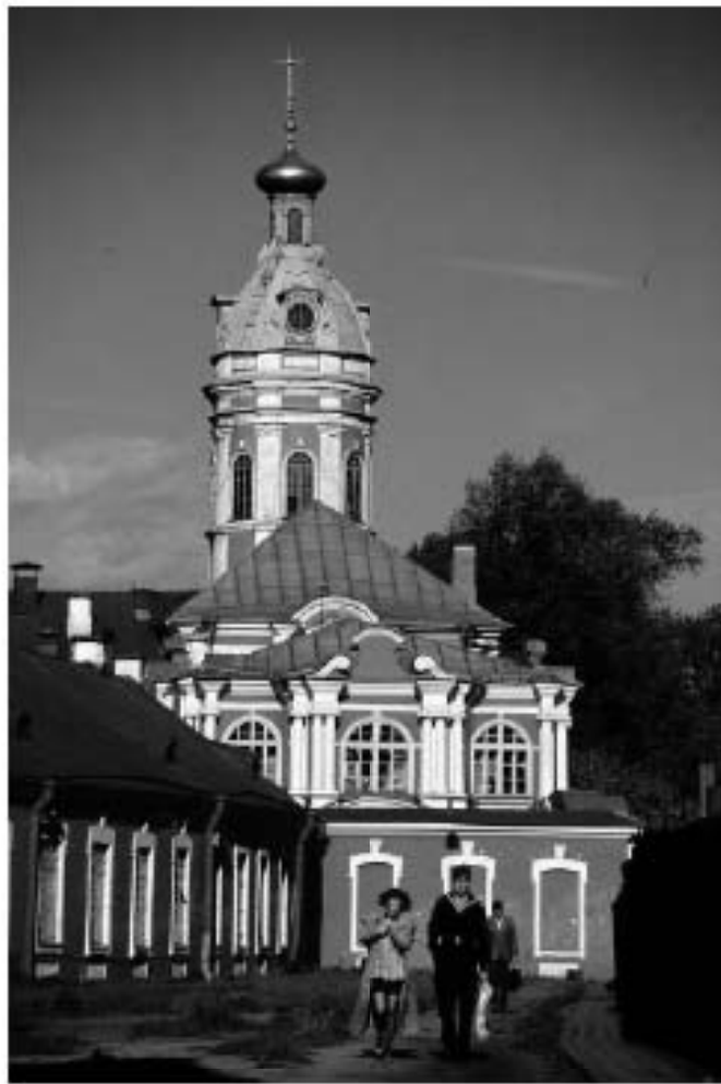
Илл.23. Восточная часть Семинарского корпуса. Вид с «училищного» двора. 1990 (?).
