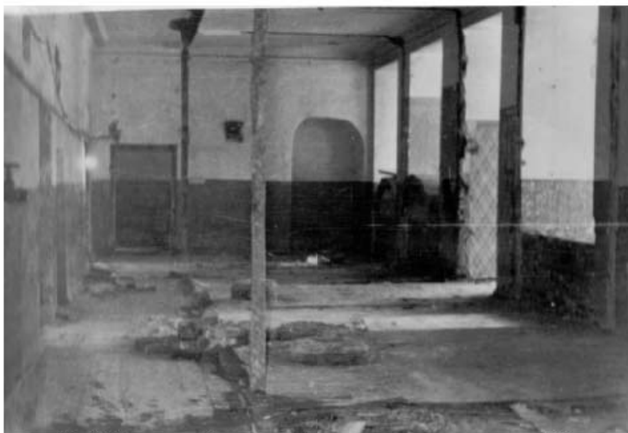
Илл.32. Помещение в двухэтажном флигеле в процессе реконструкции. 1960.
