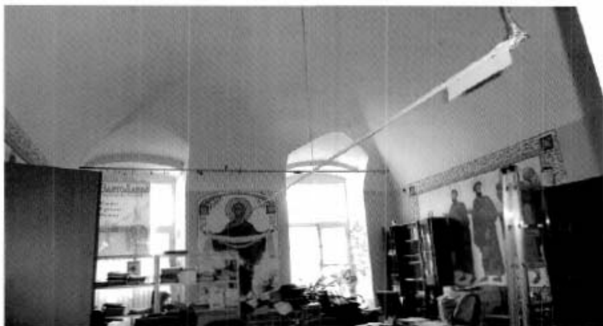
10. Сводчатые перекрытия в уровне первого этажа.
