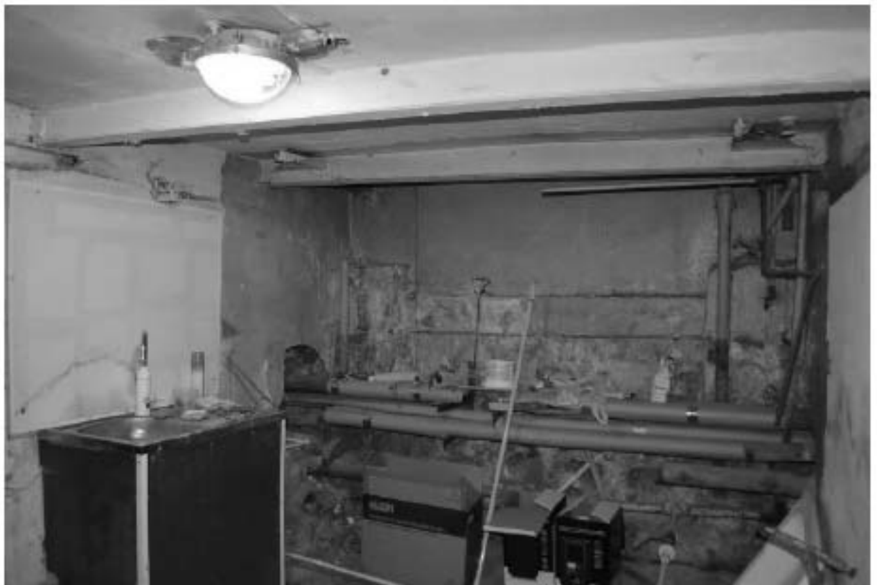
Фото 64. ОКН федерального значения «Корпус семинарский с южными воротами главного двора» (г. Санкт-Петербург, набережная реки Монастырки, дом 1, лит. Г). Подвал. Помещение в осях Б-Г/18-22. Съёмка 08.11.2021 г.
