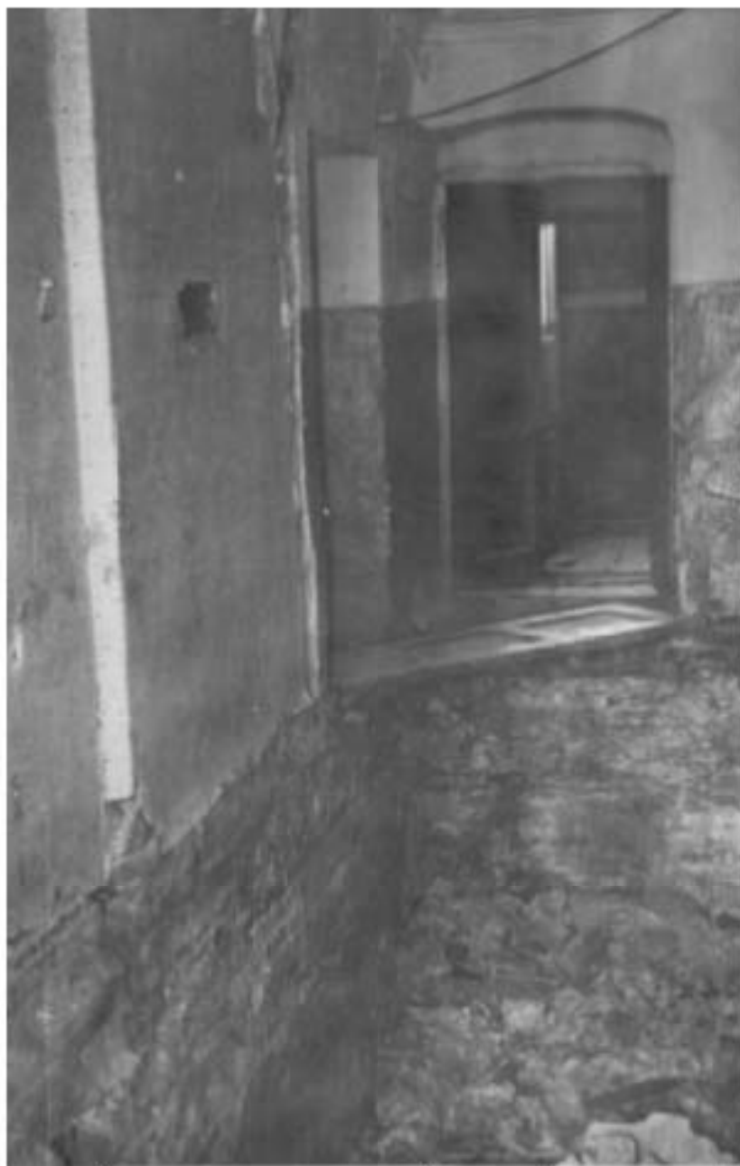
Илл.33. Переустройство лестницы на второй этаж в двухэтажном флигеле. 1960.
