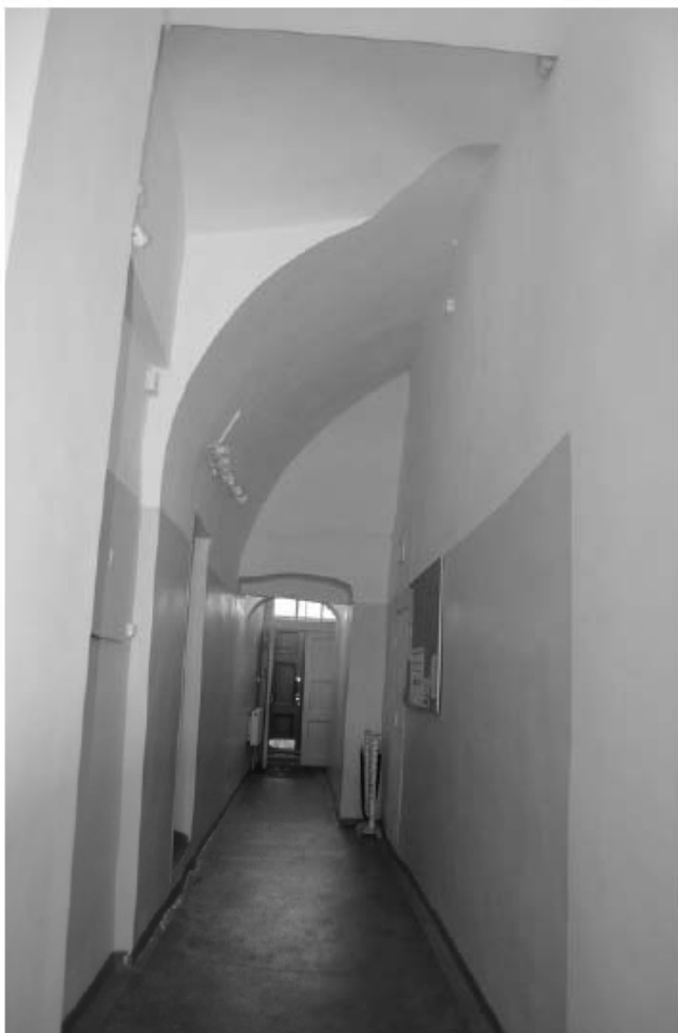
Фото 39. ОКН федерального значения «Корпус семинарский с южными воротами главного двора» (г. Санкт-Петербург, набережная реки Монастырки, дом 1, лит. Г). Первый этаж. Помещение 3-Н (12). Съёмка 08.11.2021 г.
