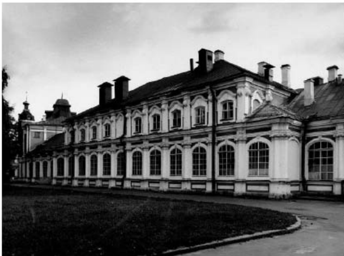
Илл. 22. Двухэтажный флигель Семинарского корпуса. Вид с лаврского двора. 1983.
