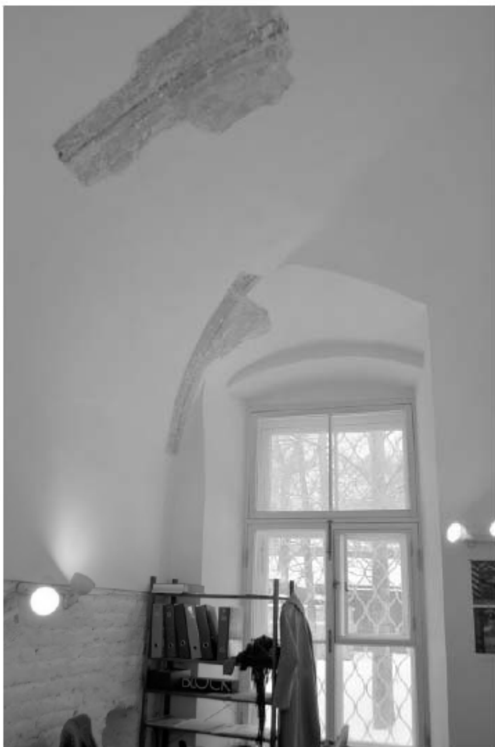
Фото 22. ОКН федерального значения «Корпус семинарский с южными воротами главного двора» (г. Санкт-Петербург, набережная реки Монастырки, дом 1, лит. Г). Первый этаж. Помещение 3-Н (43). Съёмка 08.11.2021 г.
