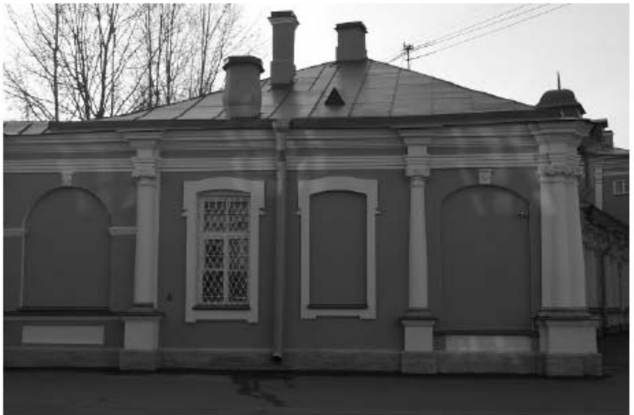
Фото 06. ОКН федерального значения «Корпус семинарский с южными воротами главного двора» (г. Санкт-Петербург, набережная реки Монастырки, дом 1, лит. Г). Северо-восточный фасад. Крыша. Фрагмент. Съёмка 08.11.2021 г.
