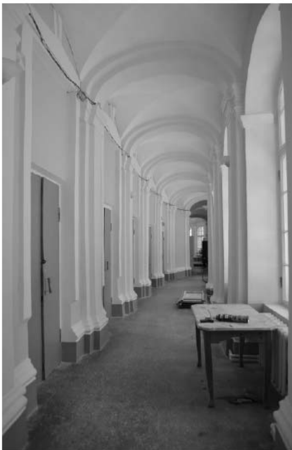
Фото 32. ОКН федерального значения «Корпус семинарский с южными воротами главного двора» (г. Санкт-Петербург, набережная реки Монаяьрки, дом 1, лит. Г). Галерея первого этажа. Съёмка 08.11.2021 г.
