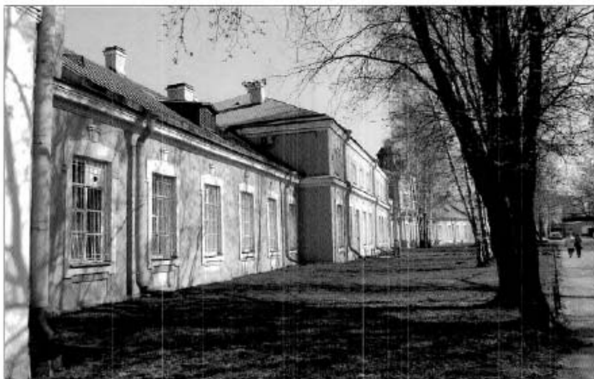
3. Общий вид с юго-запада.
