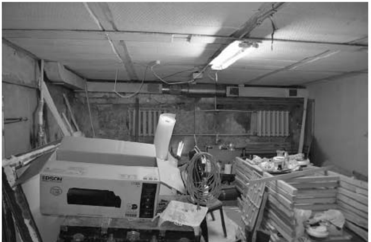
Фото 63. ОКН федерального значения «Корпус семинарский с южными воротами главного двора» (г. Санкт-Петербург, набережная реки Монастырки, дом 1, лит. Г). Подвал. Помещение в осях Б-Г/18-22. Съёмка 08.11.2021 г.
