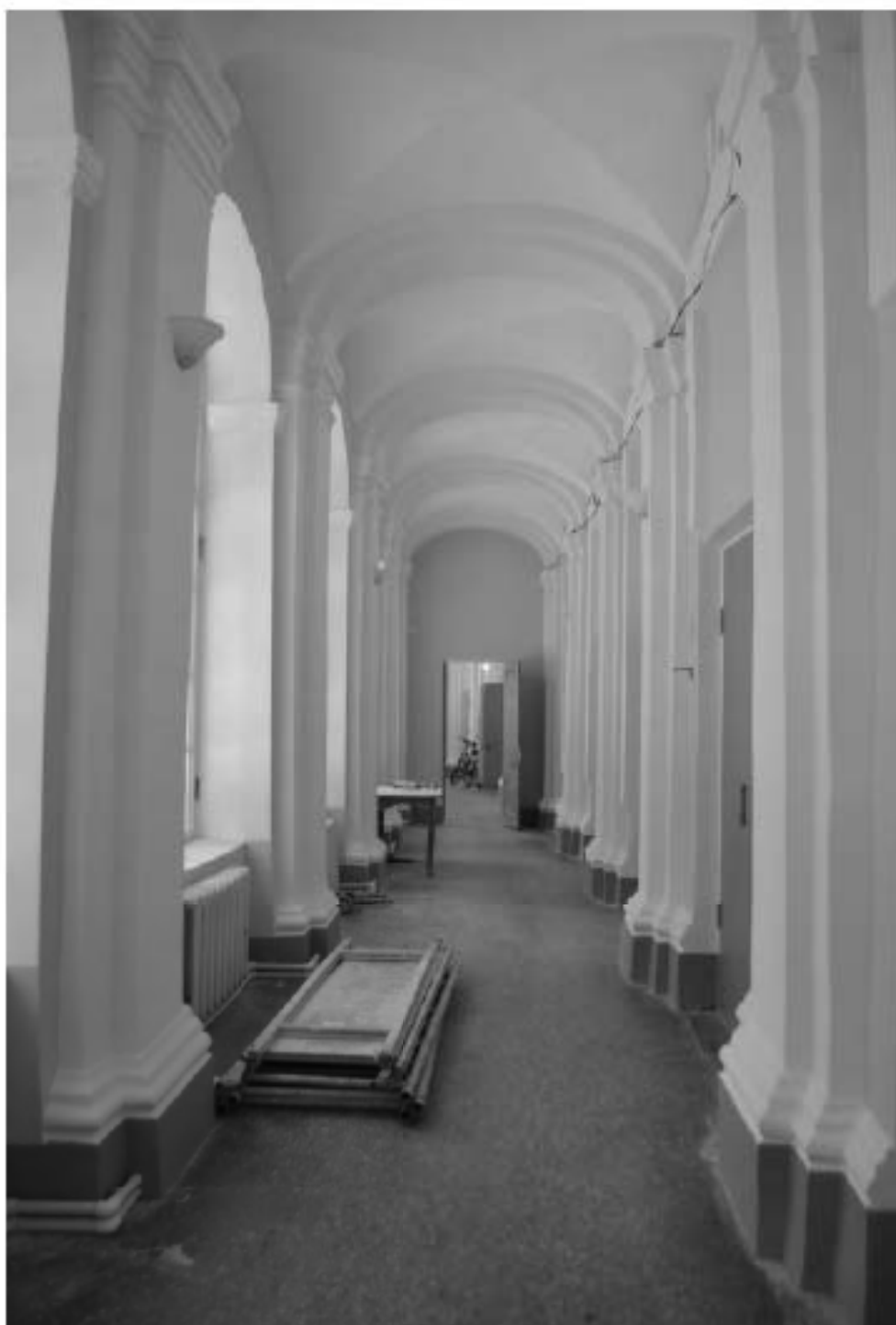
Фото 11. ОКН федерального значения «Корпус семинарский с южными воротами главного двора» (г. Санкт-Петербург, набережная реки Монастырки, дом 1, лит. Г). Первый этаж. Галерея первого этажа. Съёмка 08.11.2021 г.
