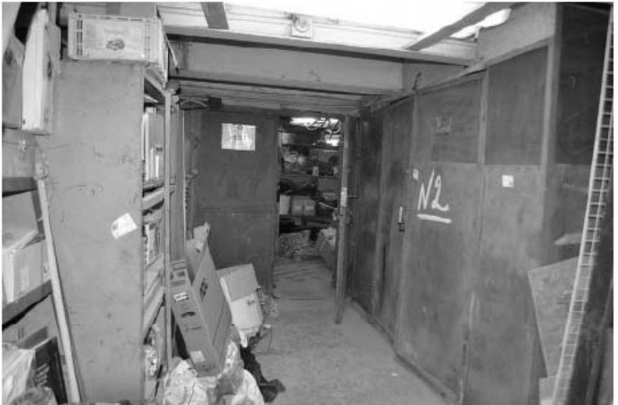
Фото 56. ОКН федерального значения «Корпус семинарский с южными воротами главного двора» (г. Санкт-Петербург, набережная реки Могаытырки, дом 1, лит. Г). Подвал. Помещение в осях В-Г/4-6. Съёмка 08.11.2021 г.
