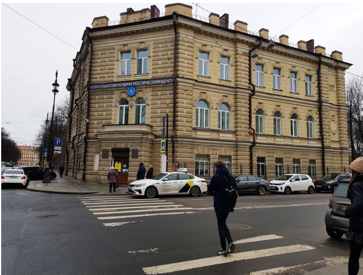
1. Общий вид северного и западного фасадов выявленного объекта культурного наследия «Амбулаторный корпус».
