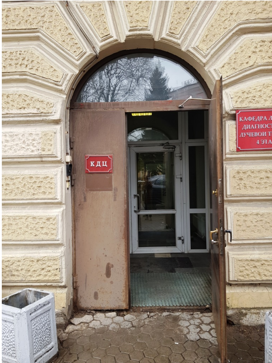
7. Вход в здание (со стороны дворового фасада).
