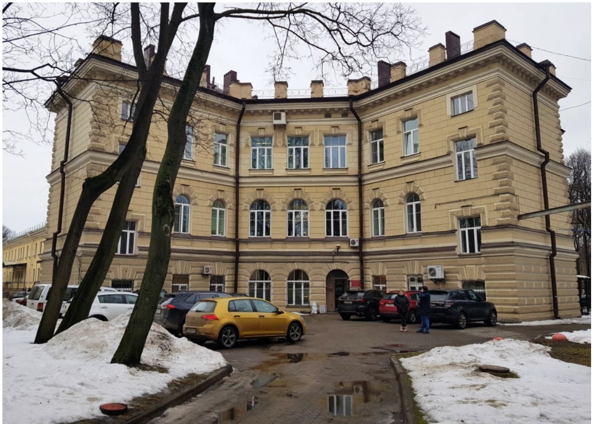
6. Дворовый фасад выявленного объекта культурного наследия «Амбулаторный корпус».
