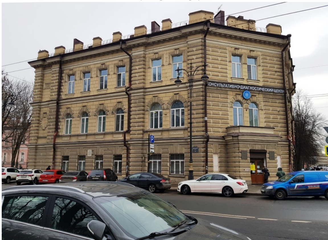
2. Северный фасад выявленного объекта культурного наследия «Амбулаторный корпус».
