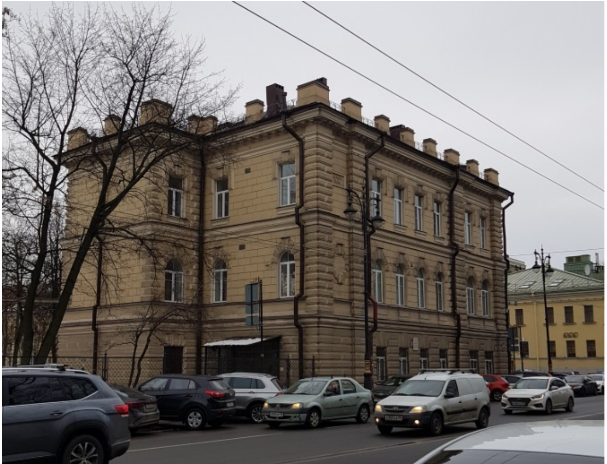
3. Северный и восточный фасады выявленного объекта культурного наследия «Амбулаторный корпус».
