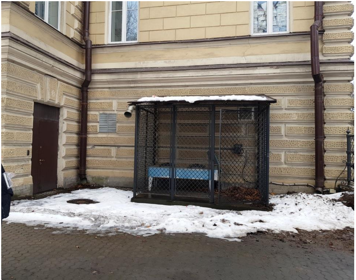
5. Фрагмент восточного фасада выявленного объекта культурного наследия «Амбулаторный корпус».
