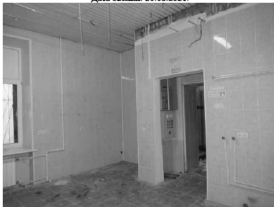
Фото 17. ОКН «Лечебница А.Л. Эбермана». Главное здание по адресу: СПб, г. Пушкин, Московское шоссе, д. 7. Помещение 1.9. Общий вид. Дата съёмки: 20.08.2021.
