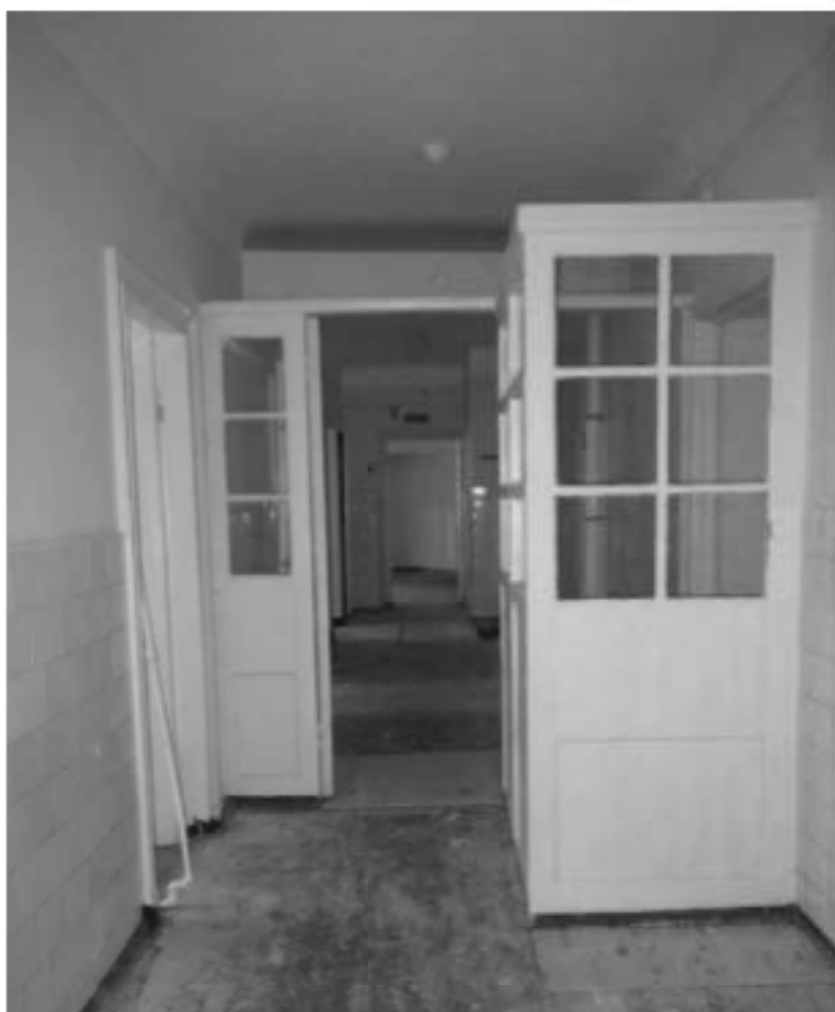
Фото 32. ОКН «Лечебница А.Л. Эбермана». Главное здание по адресу: СПб, г. Пушкин, Московское шоссе, д. 7. Помещение 2.7. Общий вид. Дата съёмки: 20.08.2021.
