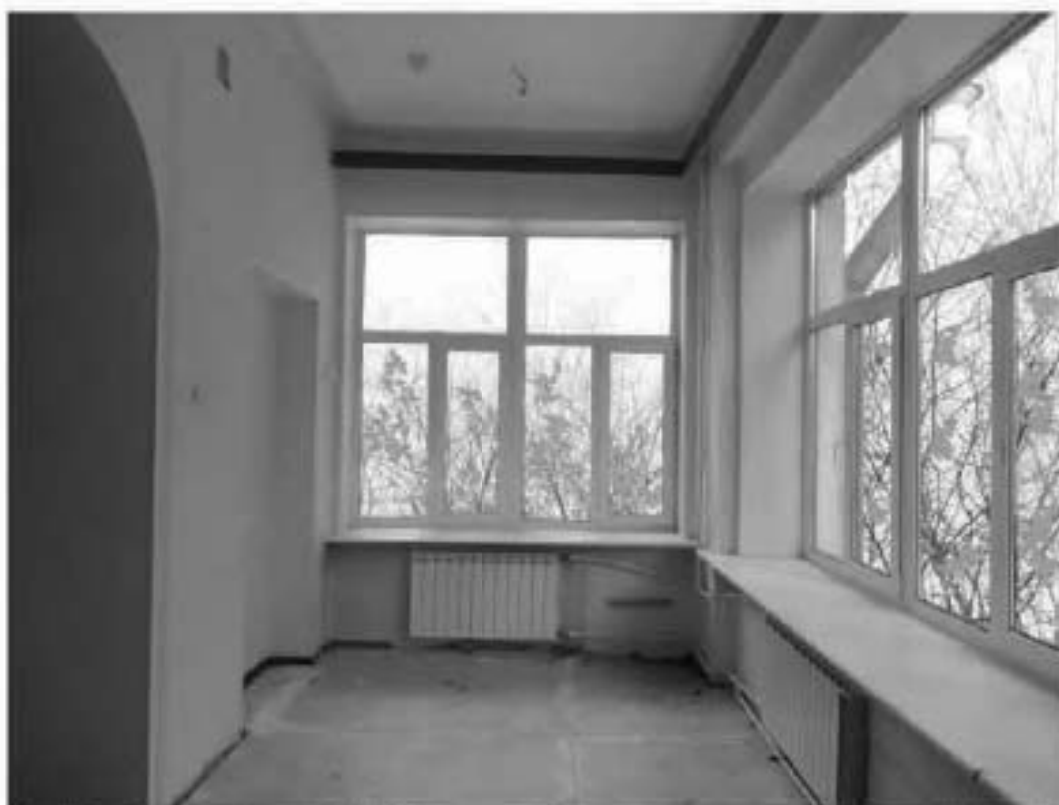
Фото 28. ОКН «Лечебница А.Л. Эбермана». Главное здание по адресу: СПб, г. Пушкин, Московское шоссе, д. 7. Помещение 2.2. Общий вид. Дата съёмки: 20.08.2021.
