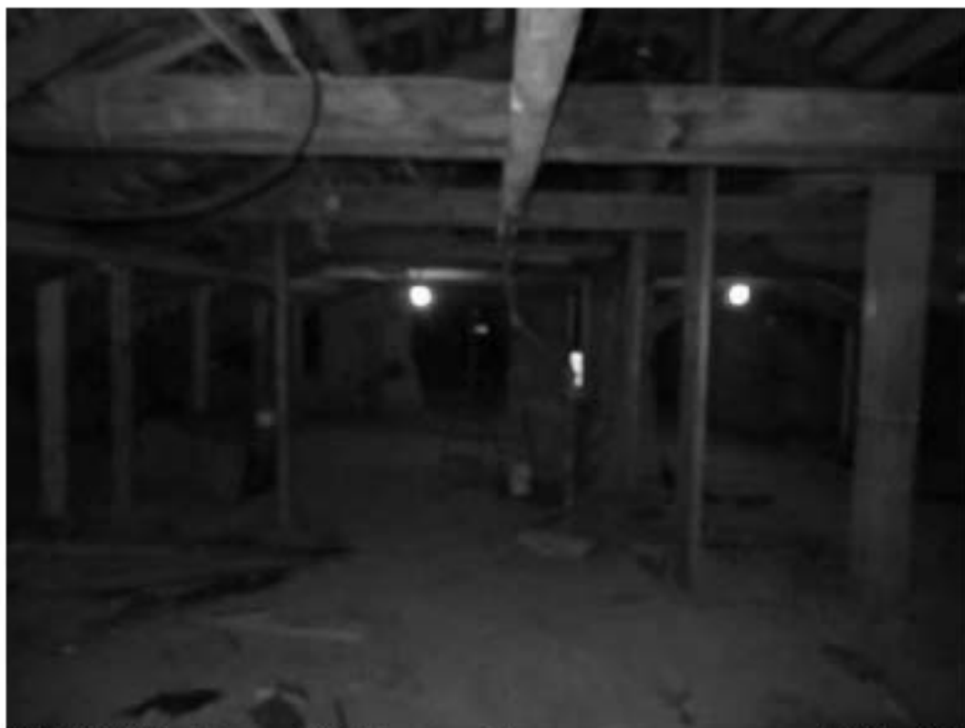
Фото 36. ОКН «Лечебница А.Л. Эбермана». Главное здание по адресу: СПб, г. Пушкин, Московское шоссе, д. 7. Помещение мансарды. Стропильные конструкции. Дата съёмки: 20.08.2021.
