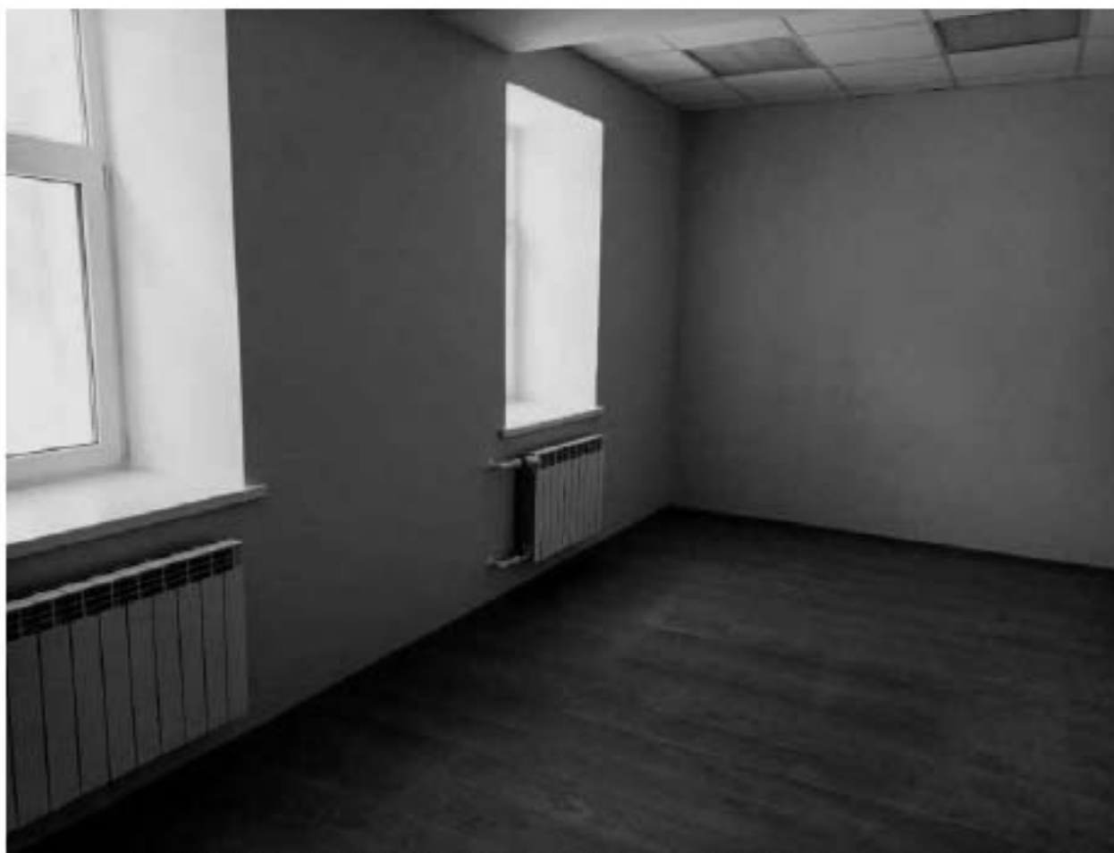
6. ОКН «Лечебница А.Л. Эбермана». Служебный флигель по адресу: СПб, г. Пушкин, Московское шоссе, д. 9, литера А. Помещение 2.1. Дата съёмки: 20.08.2021
