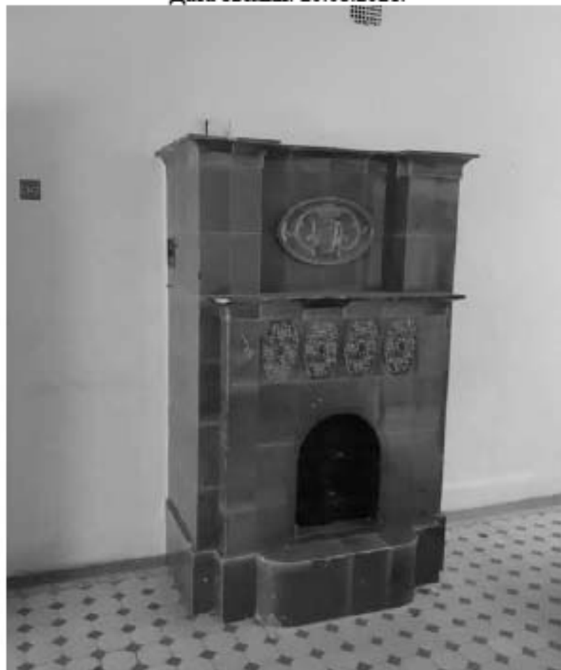
Фото 2. ОКН «Лечебница А.Л. Эбермана». Главное здание по адресу: СПб, г. Пушкин, Московское шоссе, д. 7. Помещение 1.1. Печь. Дата съёмки: 20.08.2021.
