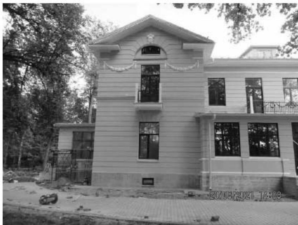
5. ОКН «Лечебница А.Л. Эбермана». Главное здание по адресу: СПб, г. Пушкин, Московское шоссе, д. 7. Юго-западный фасад. Общий вид. Дата съёмки: 20.08.2021.
