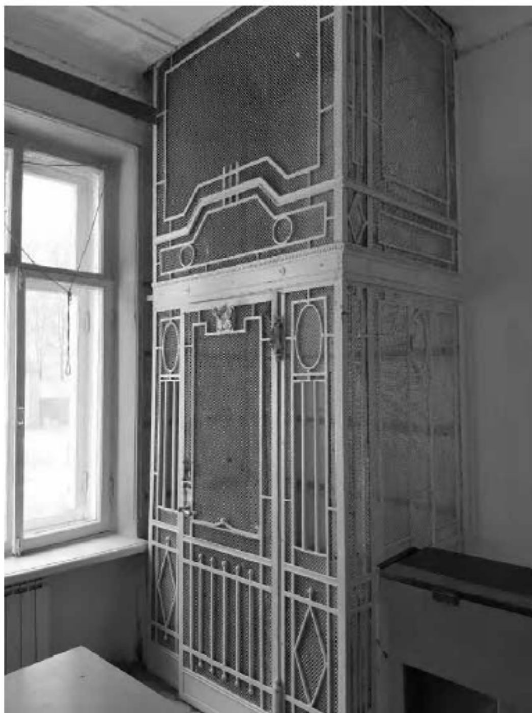
Фото 3. ОКН «Лечебница А.Л. Эбермана». Главное здание по адресу: СПб, г. Пушкин, Московское шоссе, д. 7. Помещение 1.1. Металлическое орнаментированное в характере модерна ограждение лифтовой шахты. Дата съёмки: 20.08.2021.
