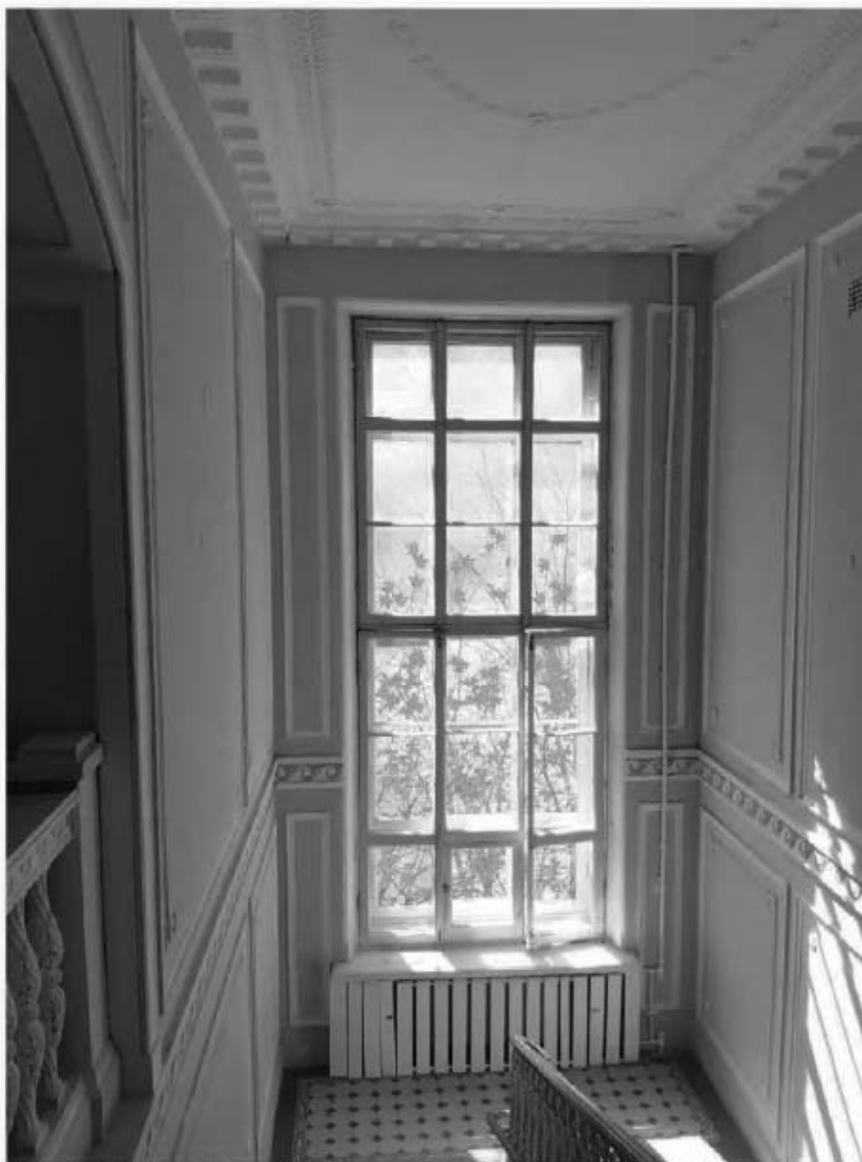
Фото 25. ОКН «Лечебница А.Л. Эбермана». Главное здание по адресу: СПб, г. Пушкин, Московское шоссе, д. 7. Помещение Л-1. Парадная лестница. Дата съёмки: 20.08.2021.
