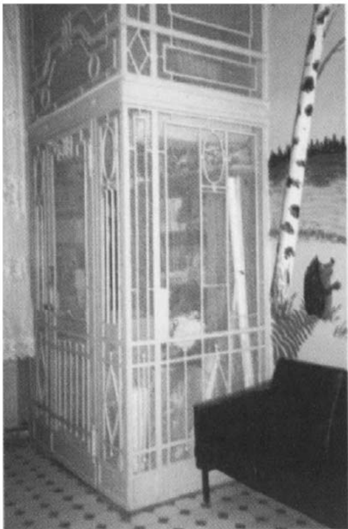
Ил. 40. Ограждение шахты лифта, 2004.
