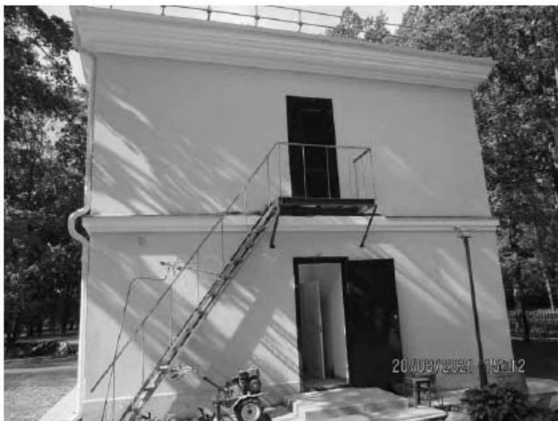
14. ОКН «Лечебница А.Л. Эбермана». Служебный флигель по адресу: СПб, г. Пушкин, Московское шоссе, д.9. Юго-восточный фасад. Общий вид. Дата съёмки: 20.08.2021.
