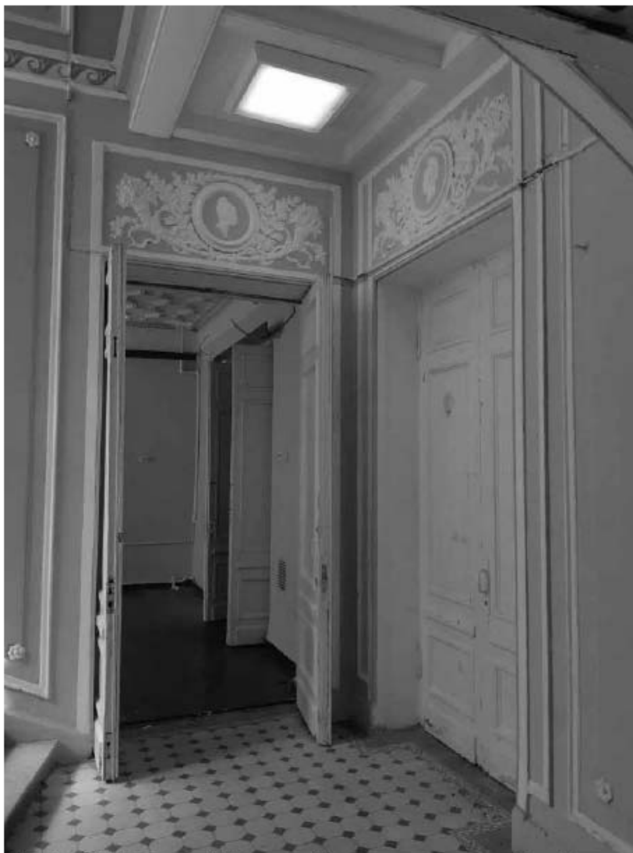
Фото 15. ОКН «Лечебница А.Л. Эбермана». Главное здание по адресу: СПб, г. Пушкин, Московское шоссе, д. 7. Помещение 1.19. Лепные десюдепорты над дверными проемами 1-го этажа лестничной площадки. Дата съёмки: 20.08.2021.
