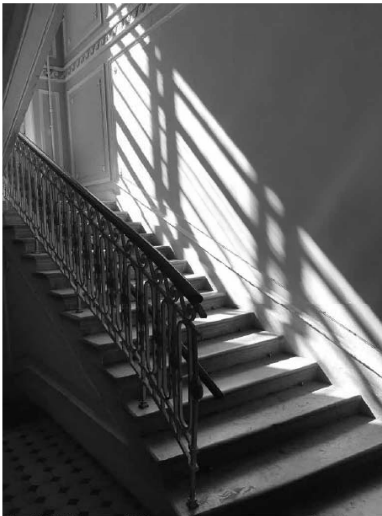
Фото 14. ОКН «Лечебница А.Л. Эбермана». Главное здание по адресу: СПб, г. Пушкин, Московское шоссе, д. 7. Помещение 1.19. Парадная лестница. Дата съёмки: 20.08.2021.
