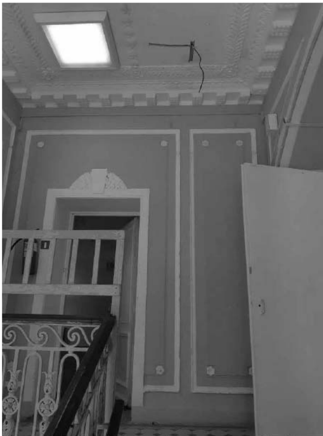
Фото 24. ОКН «Лечебница А.Л. Эбермана». Главное здание по адресу: СПб, г. Пушкин, Московское шоссе, д. 7. Помещение Л-1. Парадная лестница. Дата съёмки: 20.08.2021.
