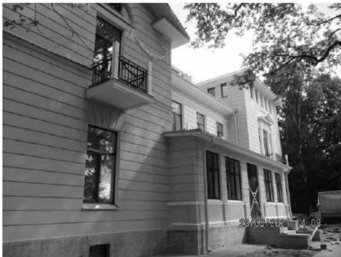
6. ОКН «Лечебница А.Л. Эбермана». Главное здание по адресу: СПб, г. Пушкин, Московское шоссе, д. 7. Юго-западный фасад. Общий вид. Дата съёмки: 20.08.2021.
