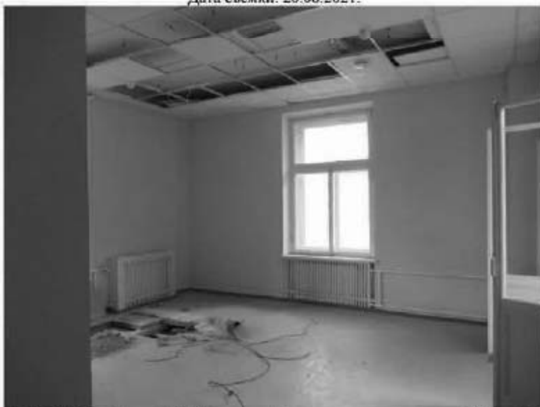
Фото 29. ОКН «Лечебница А.Л. Эбермана». Главное здание по адресу: СПб, г. Пушкин, Московское шоссе, д. 7. Помещение 2.12. Общий вид. Дата съёмки: 20.08.2021.
