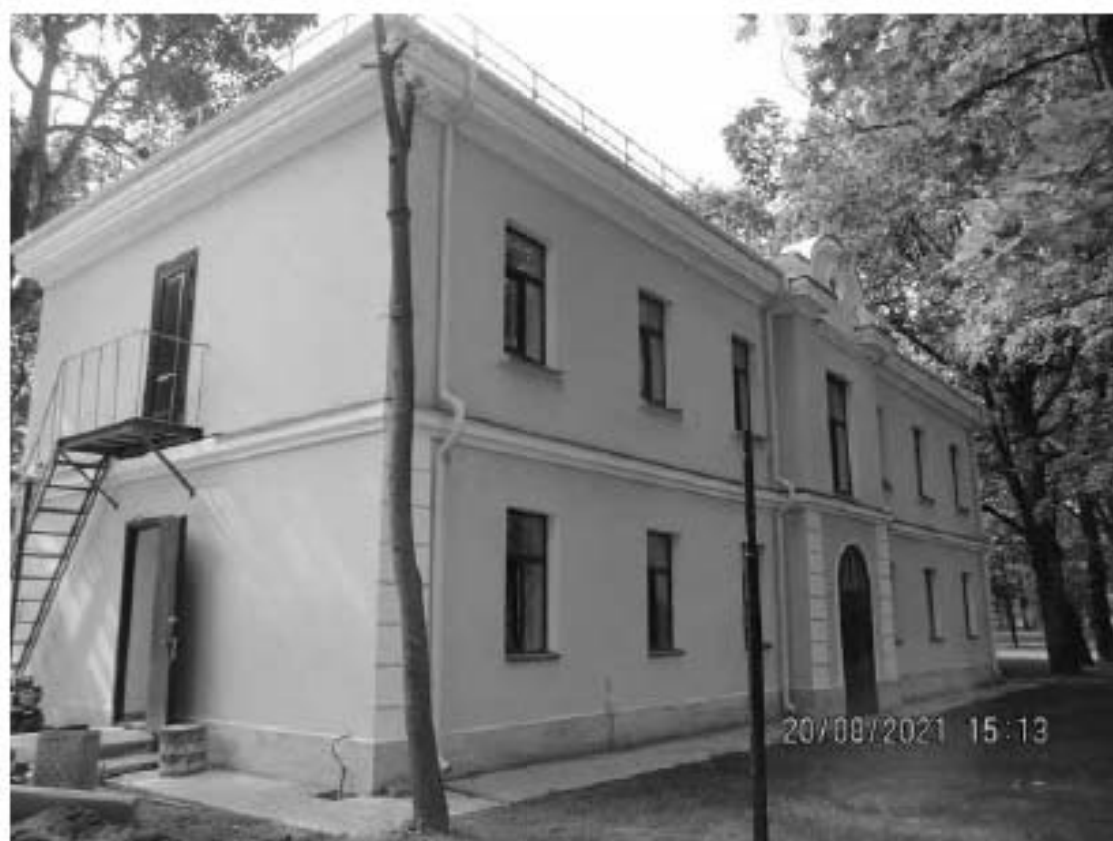
15. ОКН «Лечебница А.Л. Эбермана». Служебный флигель по адресу: СПб, г. Пушкин, Московское шоссе, д.9. Северо-восточный фасад. Общий вид. Дата съёмки: 20.08.2021.
