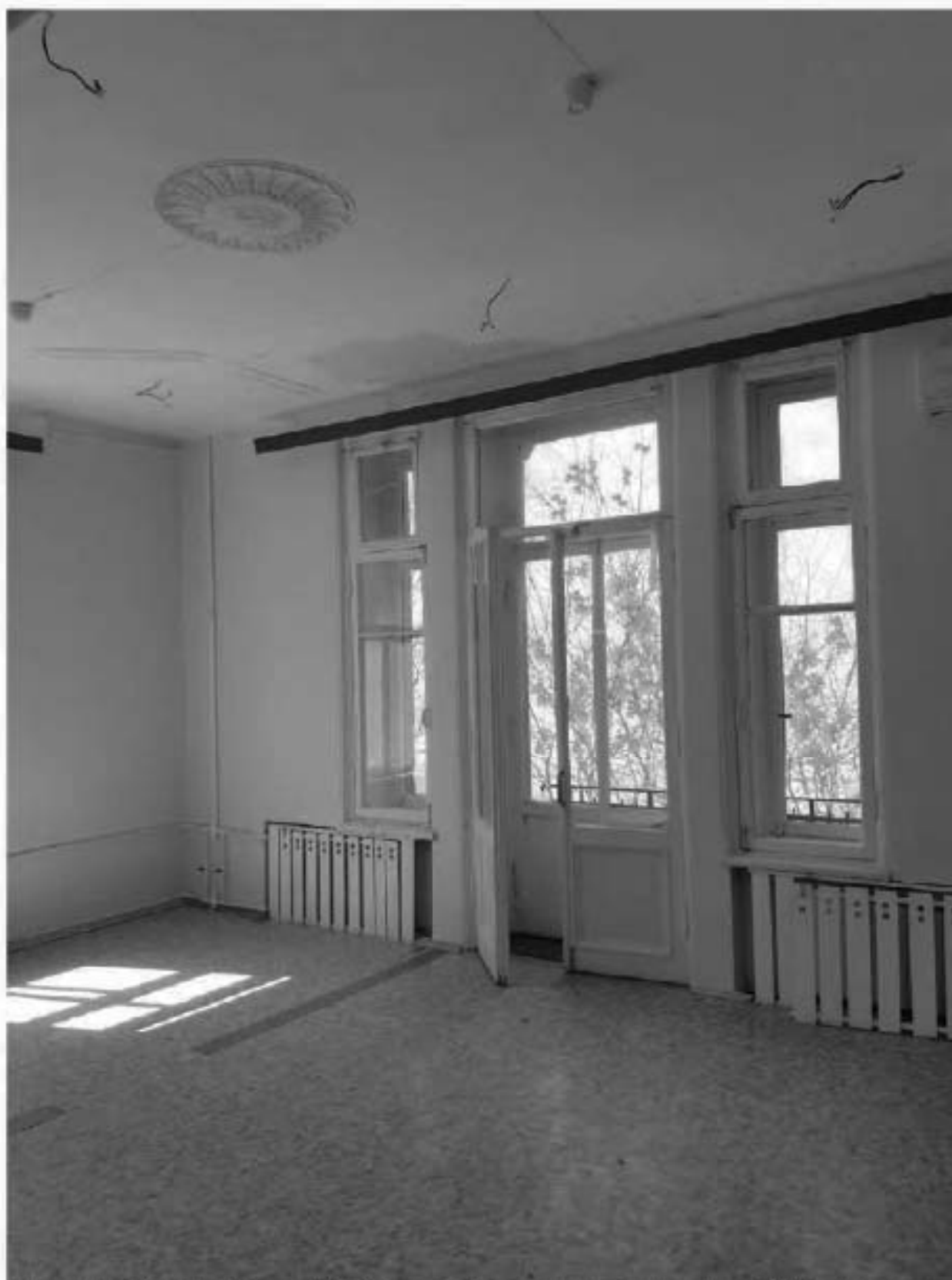
Фото 31. ОКН «Лечебница А.Л. Эбермана». Главное здание по адресу: СПб, г. Пушкин, Московское шоссе, д. 7. Помещение 2.19. Общий вид. Дата съёмки: 20.08.2021.
