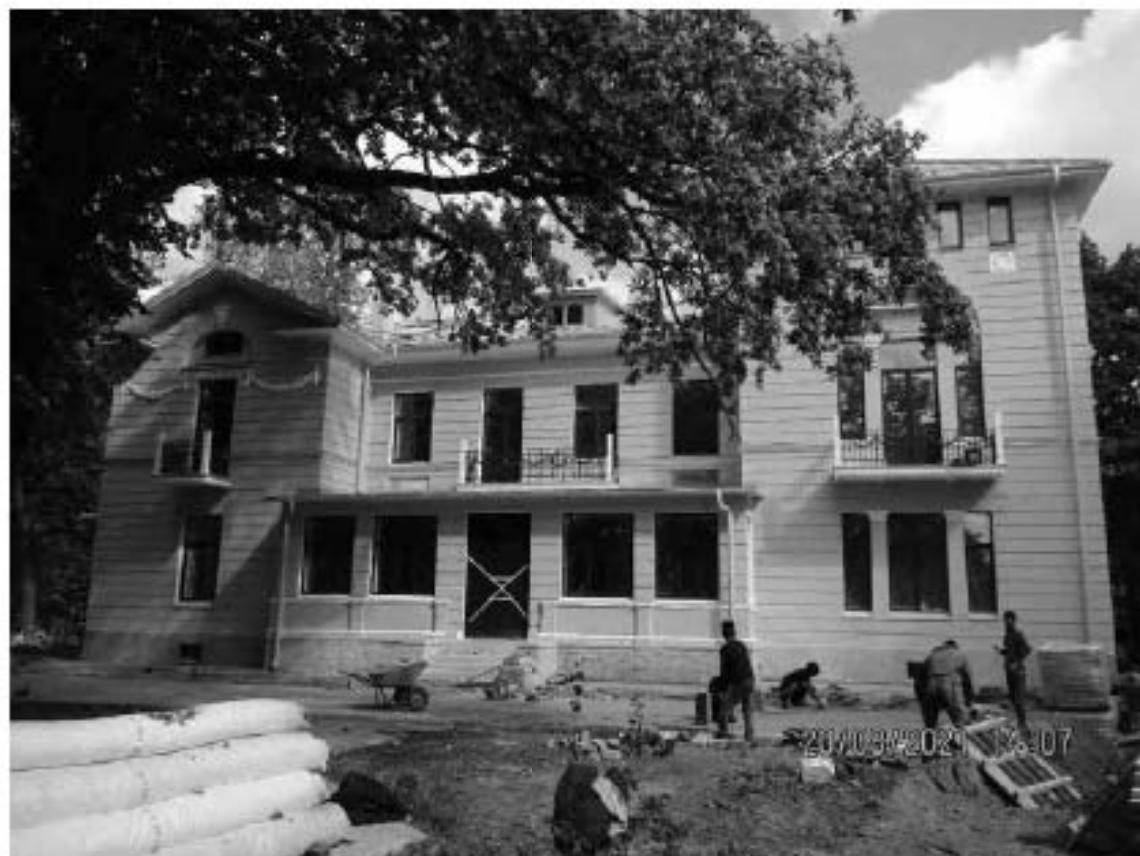
4. ОКН «Лечебница А.Л. Эбермана». Главное здание по адресу: СПб, г. Пушкин, Московское шоссе, д. 7. Юго-западный фасад. Общий вид. Дата съёмки: 20.08.2021.
