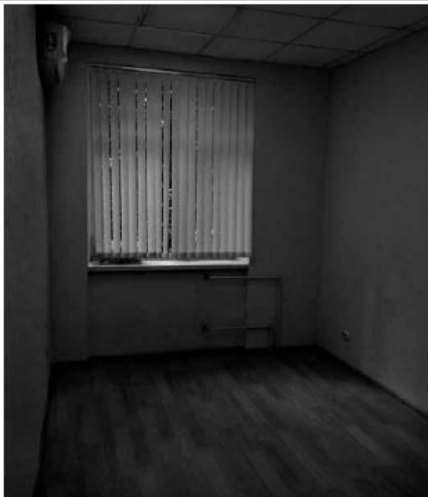
3. ОКН «Лечебница А.Л. Эбермана». Служебный флигель по адресу: СПб, г. Пушкин, Московское шоссе, д. 9, литера А. Помещение 1.12. Дата съёмки: 20.08.2021
