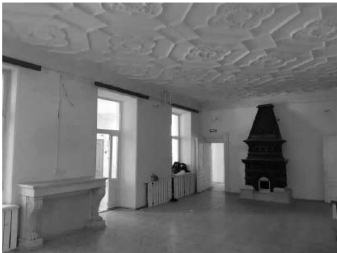
Фото 6. ОКН «Лечебница А.Л. Эбермана». Главное здание по адресу: СПб, г. Пушкин, Московское шоссе, д. 7. Помещение 1.12. Общий вид. Дата съёмки: 20.08.2021.
