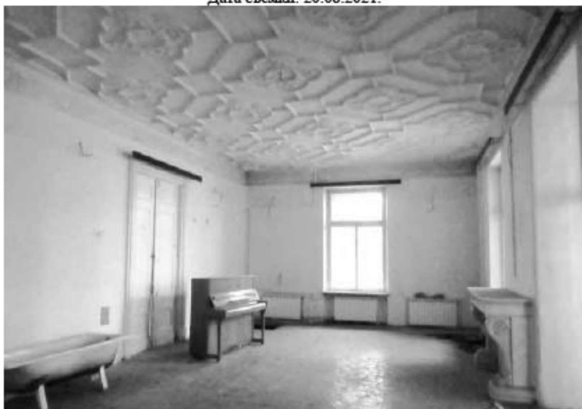
Фото 5. ОКН «Лечебница А.Л. Эбермана». Главное здание по адресу: СПб, г. Пушкин, Московское шоссе, д. 7. Помещение 1.12. Общий вид. Дата съёмки: 20.08.2021.
