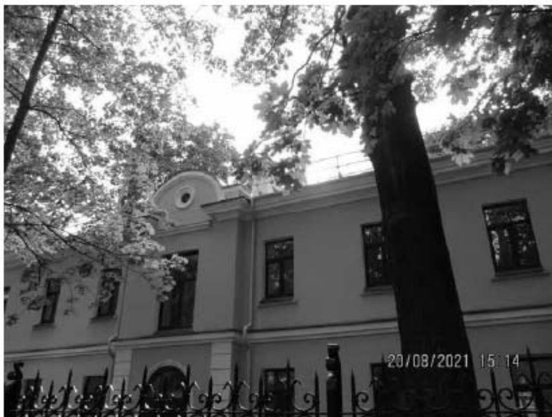
16. ОКН «Лечебница А.Л. Эбермана». Служебный флигель по адресу: СПб, г. Пушкин, Московское шоссе, д.9. Северо-восточный фасад. Общий вид. Дата съёмки: 20.08.2021.
