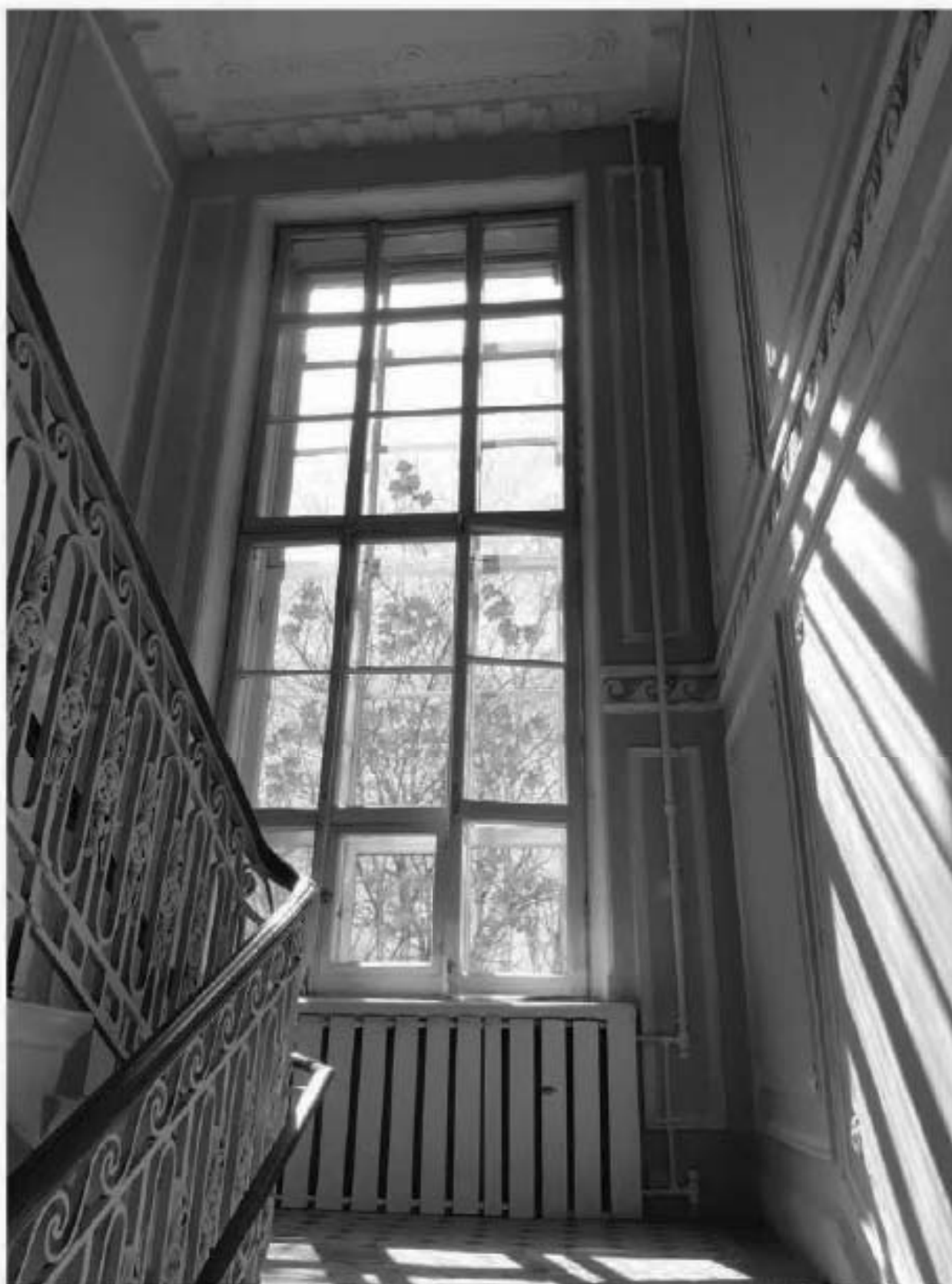
Фото 22. ОКН «Лечебница А.Л. Эбермана». Главное здание по адресу: СПб, г. Пушкин, Московское шоссе, д. 7. Помещение Л-1. Парадная лестница. Дата съёмки: 20.08.2021.
