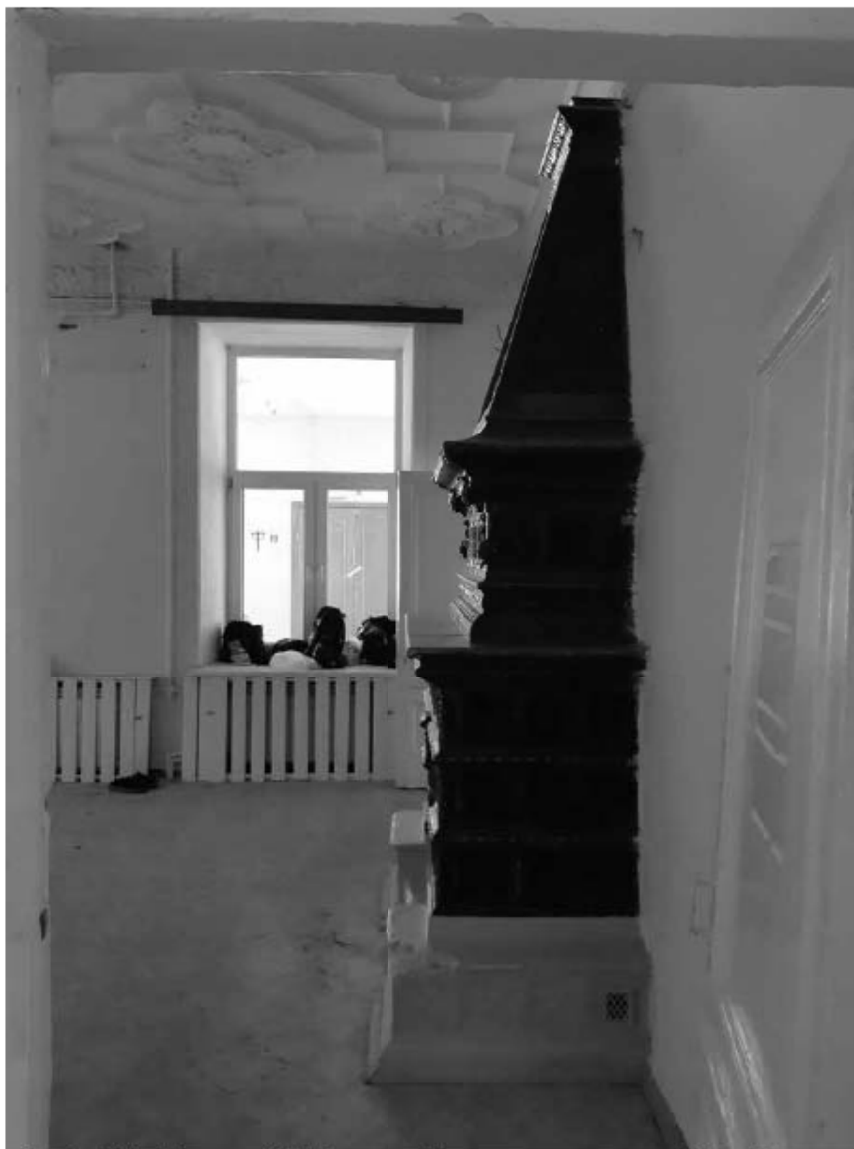
Фото 9. ОКН «Лечебница А.Л. Эбермана». Главное здание по адресу: СПб, г. Пушкин, Московское шоссе, д. 7. Помещение 1.12. Печь. Дата съёмки: 20.08.2021.
