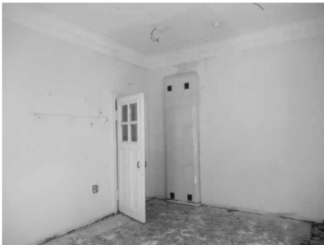
Фото 30. ОКН «Лечебница А.Л. Эбермана». Главное здание по адресу: СПб, г. Пушкин, Московское шоссе, д. 7. Помещение 2.16. Общий вид. Дата съёмки: 20.08.2021.
