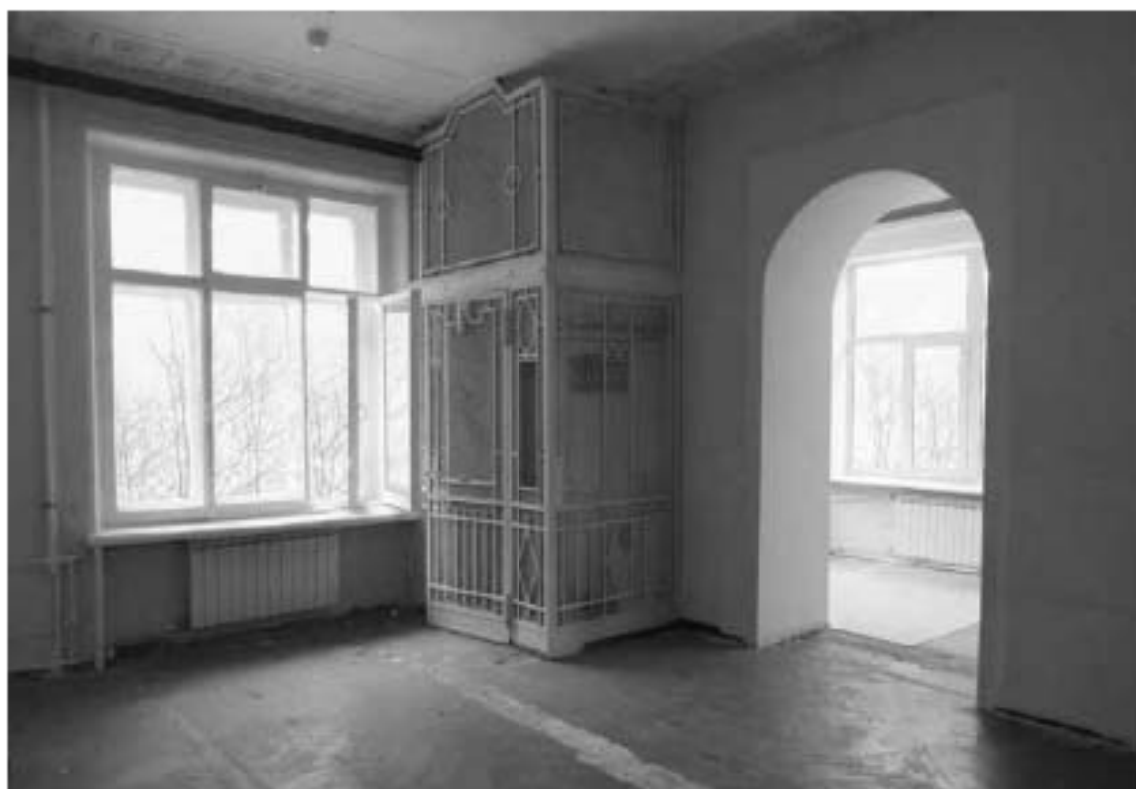
Фото 4. ОКН «Лечебница А.Л. Эбермана». Главное здание по адресу: СПб, г. Пушкин, Московское шоссе, д. 7. Помещение 1.1. Общий вид. Дата съёмки: 20.08.2021.
