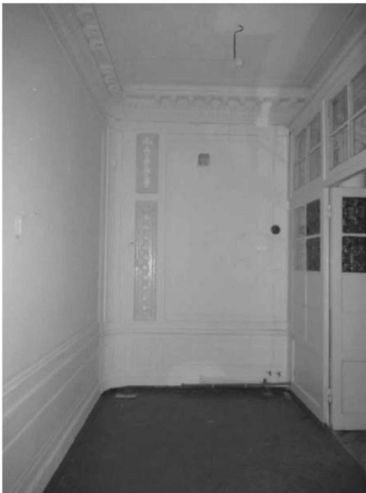
Фото 11. ОКН «Лечебница А.Л. Эбермана». Главное здание по адресу: СПб, г. Пушкин, Московское шоссе, д. 7. Помещение 1.13. Общий вид. Дата съёмки: 20.08.2021.
