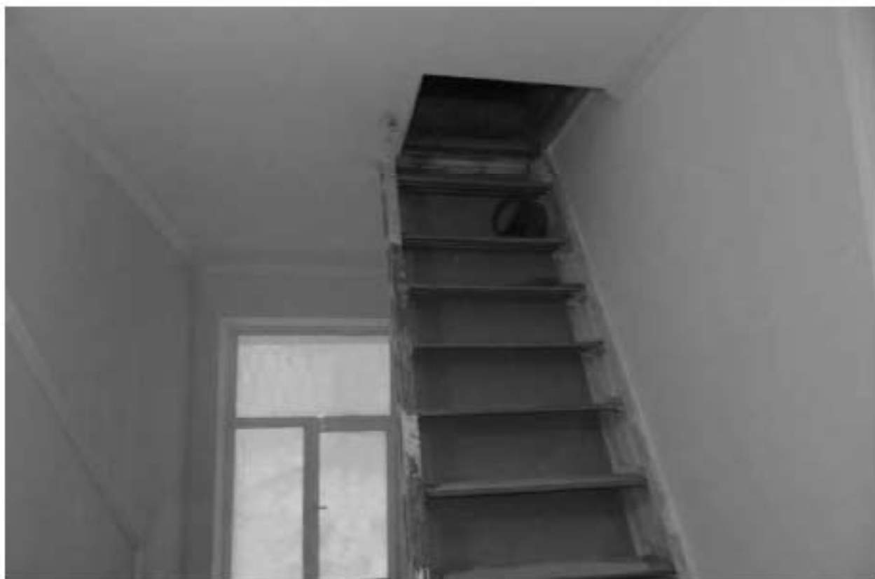
8. ОКН «Лечебница А.Л. Эбермана». Служебный флигель по адресу: СПб, г. Пушкин, Московское шоссе, д. 9, литера А. Помещение Л-4. Дата съёмки: 20.08.2021
