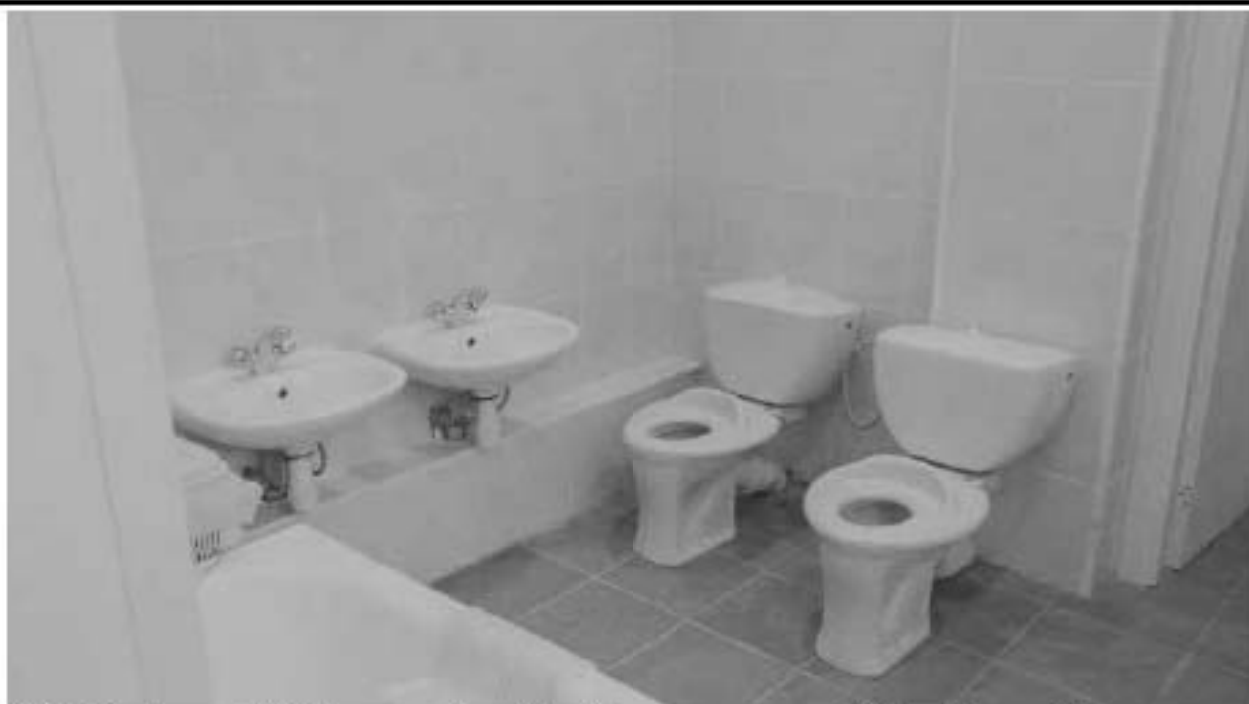
7. ОКН «Лечебница А.Л. Эбермана». Служебный флигель по адресу: СПб, г. Пушкин, Московское шоссе, д. 9, литера А. Помещение 2.4. Дата съёмки: 20.08.2021
