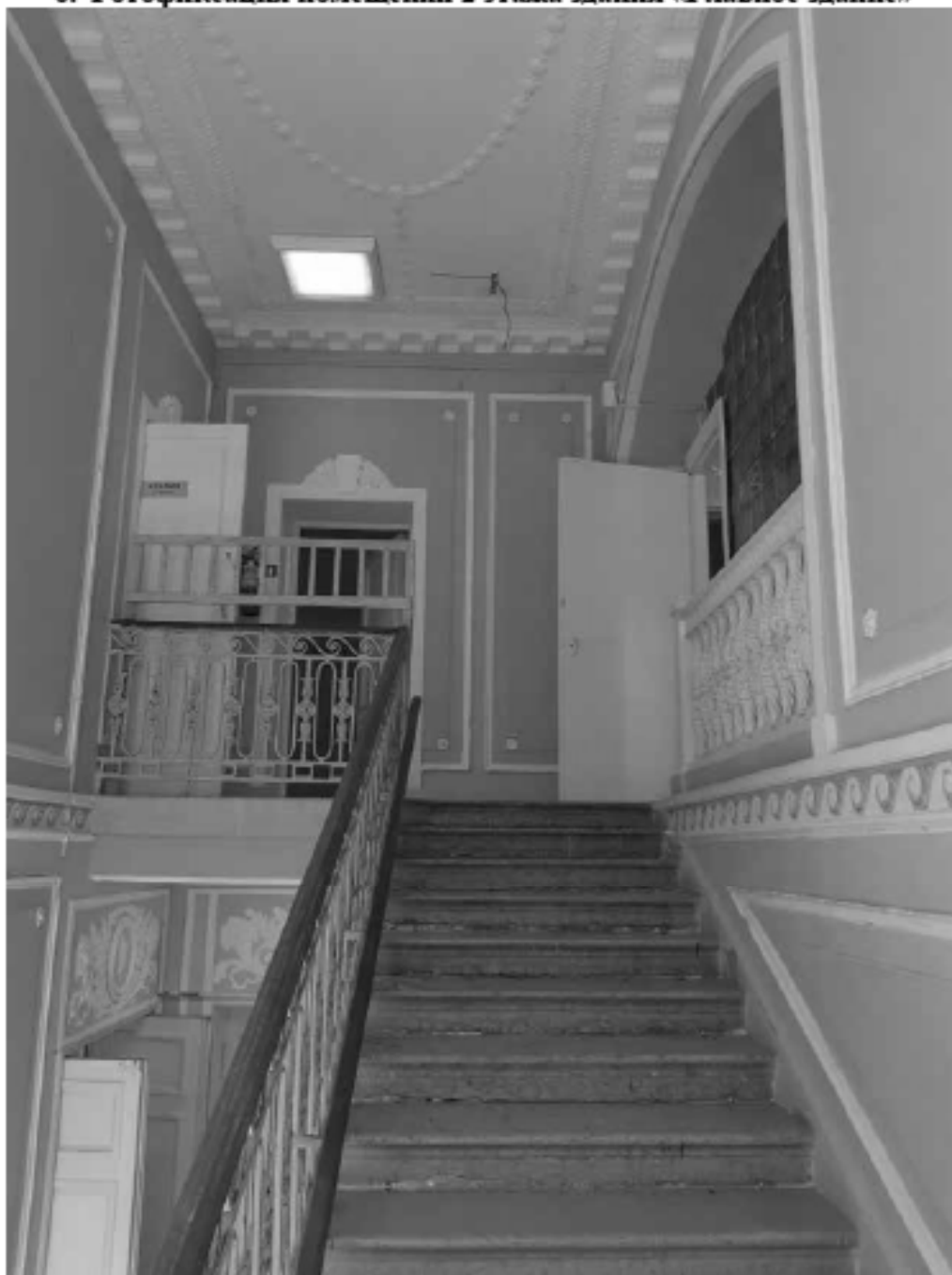
Фото 23. ОКН «Лечебница А.Л. Эбермана». Главное здание по адресу: СПб, г. Пушкин, Московское шоссе, д. 7. Помещение Л-1. Парадная лестница. Дата съёмки: 20.08.2021.
