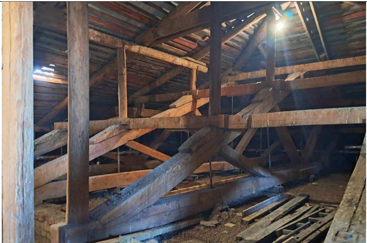
Фото № 25. Объект культурного наследия регионального значения «Здание института «ЛенНИИпроект» и жилой дом», расположенный по адресу: Санкт-Петербург, Троицкая площадь П.С. д. 3, литер А. Мансарда здания института «ЛенНИИпроект». Фрагмент конструкции стропильной системы. Дата съёмки: 29.09.2025г.
