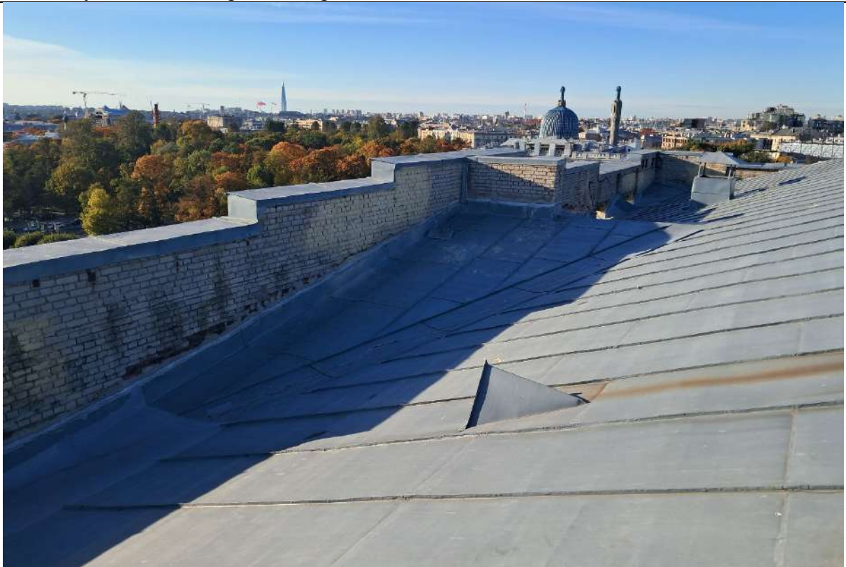
Фото № 36. Объект культурного наследия регионального значения «Здание института “ЛенНИИпроект” и жилой дом», расположенный по адресу: Санкт-Петербург, Троицкая площадь П.С. д. 3, литер А. Фрагмент крыши здания института «ЛенНИИпроект». Фрагмент аттиковой стенки со ступенчатым навершием. Дата съёмки: 29.09.2025г.
