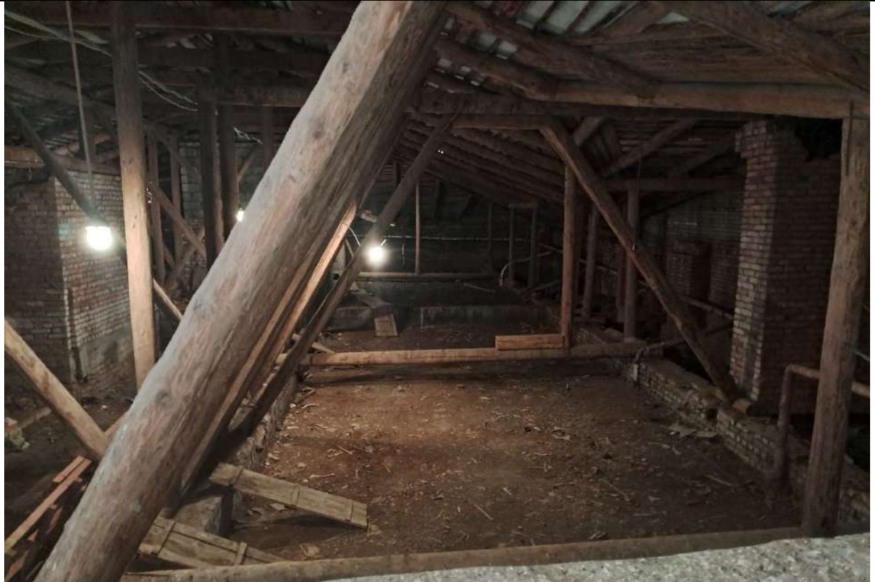
Фото № 12. Объект культурного наследия регионального значения «Здание института «ЛенНИИпроект» и жилой дом», расположенный по адресу: Санкт-Петербург, Троицкая площадь П.С. д. 3, литер А. Мансарда здания института «ЛенНИИпроект». Фрагмент конструкции стропильной системы. Дата съёмки: 29.09.2025г.
