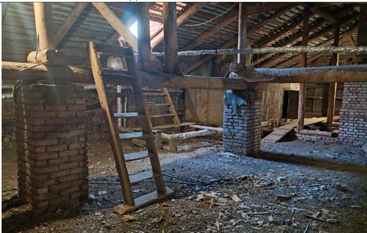
Фото № 23. Объект культурного наследия регионального значения «Здание института «ЛенНИИпроект» и жилой дом», расположенный по адресу: Санкт-Петербург, Троицкая площадь П.С. д. 3, литер А. Мансарда здания института «ЛенНИИпроект». Фрагмент конструкции стропильной системы. Дата съёмки: 29.09.2025г.
