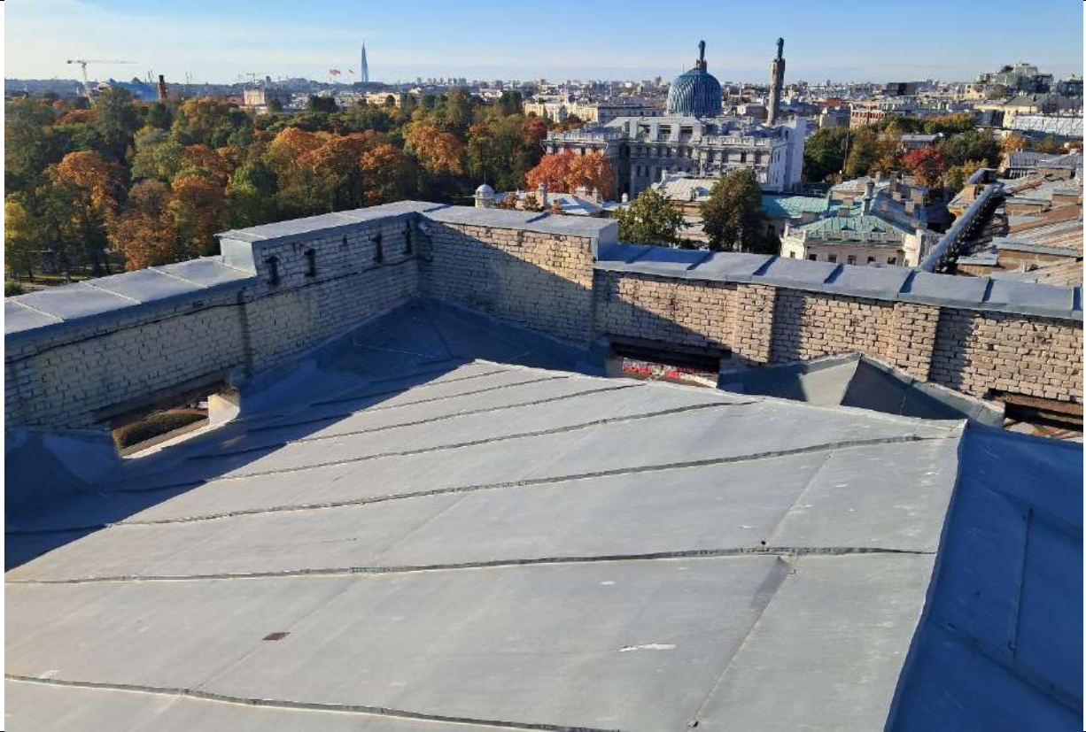
Фото № 29. Объект культурного наследия регионального значения «Здание института «ЛенНИИпроект» и жилой дом», расположенный по адресу: Санкт-Петербург, Троицкая площадь П.С. д. 3, литер А. Фрагмент крыши здания института «ЛенНИИпроект». Фрагмент аттиковой стенки со ступенчатым навершием. Дата съёмки: 29.09.2025г.
