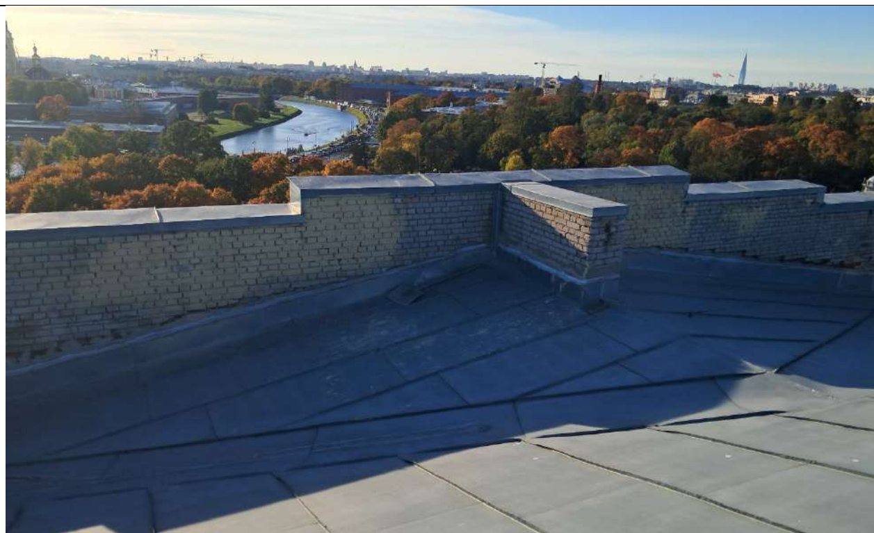
Фото № 41. Объект культурного наследия регионального значения «Здание института «ЛенНИИпроект» и жилой дом», расположенный по адресу: Санкт-Петербург, Троицкая площадь П.С. д. 3, литер А. Фрагмент крыши здания института «ЛенНИИпроект». Фрагмент аттиковой стенки со ступенчатым навершием. Дата съёмки: 29.09.2025г.
