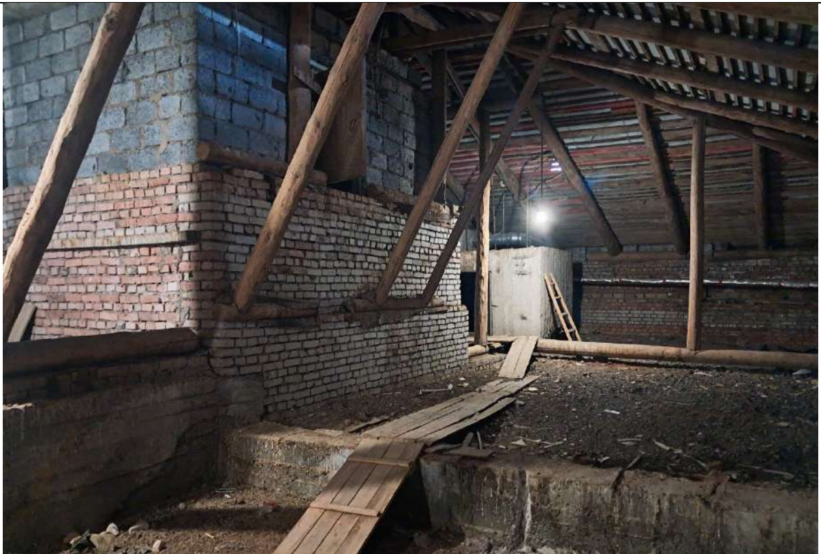
Фото № 14. Объект культурного наследия регионального значения «Здание института “ЛенНИИпроект” и жилой дом», расположенный по адресу: Санкт-Петербург, Троицкая площадь П.С. д. 3, литер А. Мансарда здания института «ЛенНИИпроект». Фрагмент конструкции стропильной системы. Дата съёмки: 29.09.2025г.
