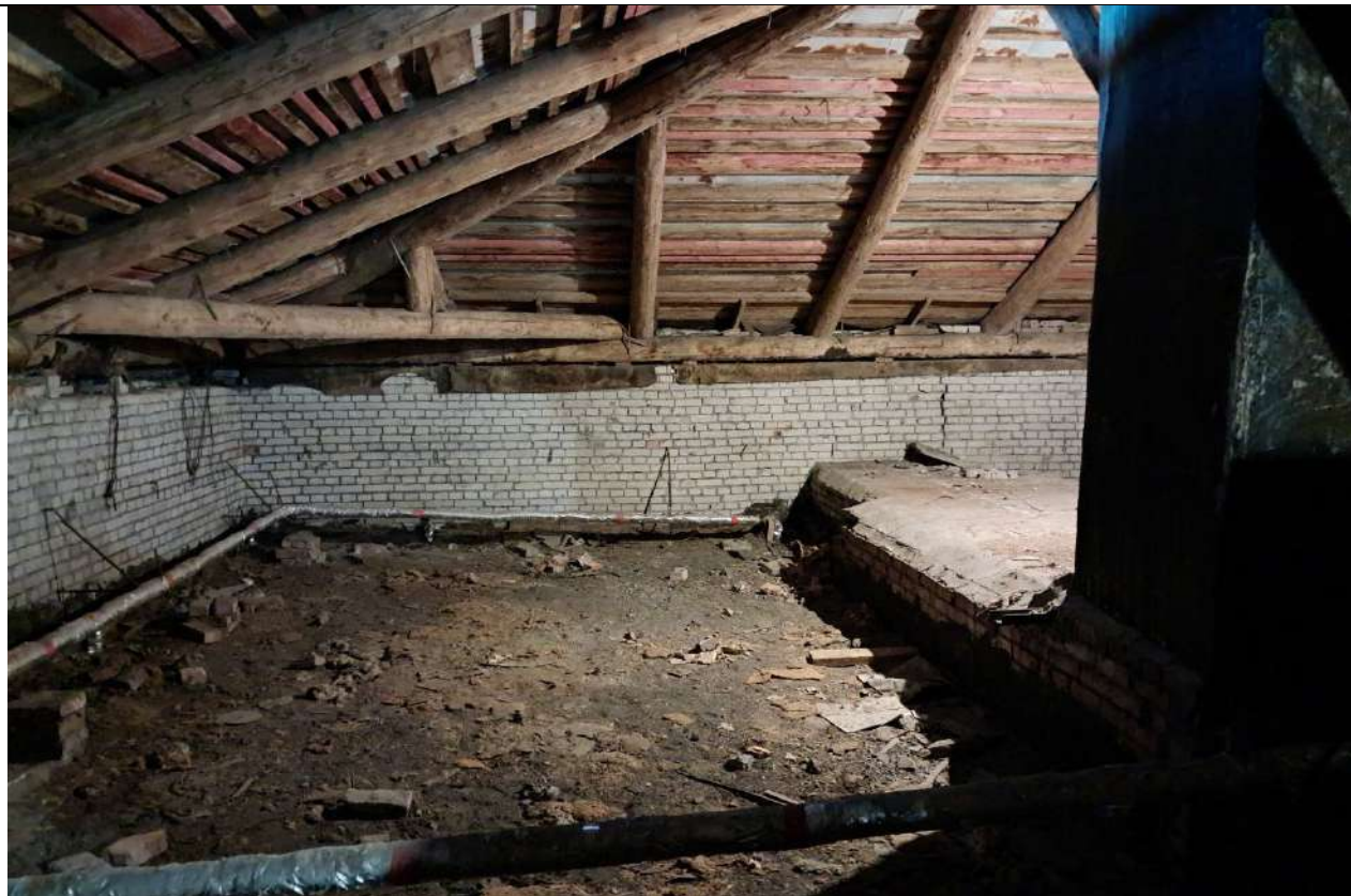
Фото № 22. Объект культурного наследия регионального значения «Здание института «ЛенНИИпроект» и жилой дом», расположенный по адресу: Санкт-Петербург, Троицкая площадь П.С. д. 3, литер А. Мансарда здания института «ЛенНИИпроект». Фрагмент конструкции стропильной системы. Дата съёмки: 29.09.2025г.
