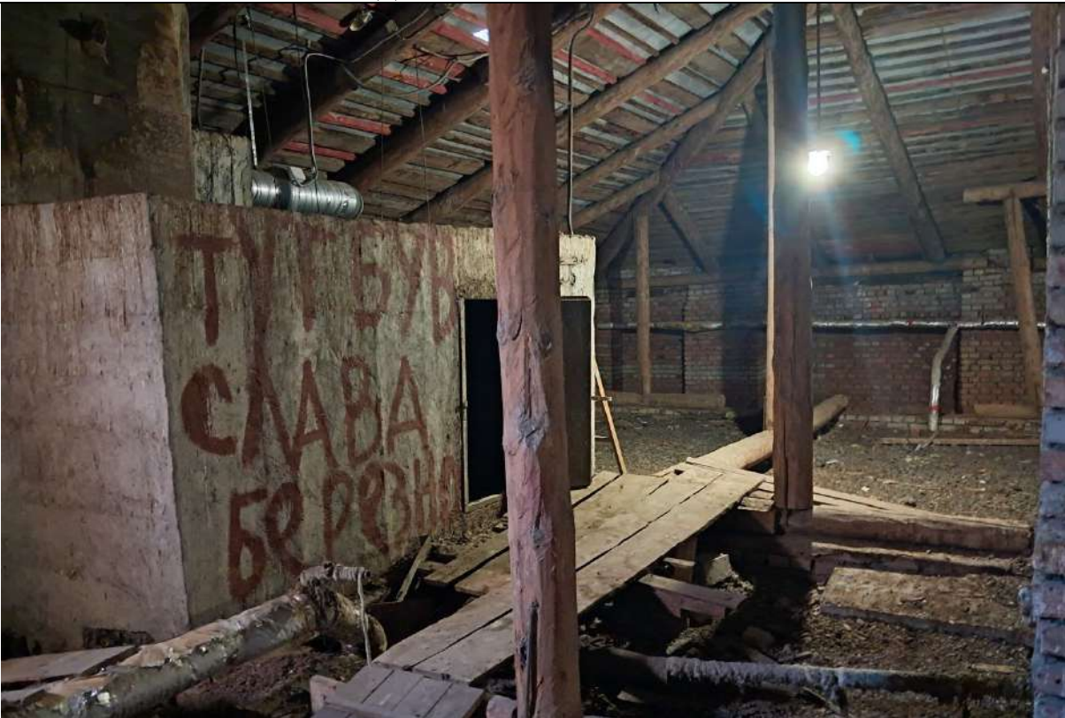
Фото № 19. Объект культурного наследия регионального значения «Здание института «ЛенНИИпроект» и жилой дом», расположенный по адресу: Санкт-Петербург, Троицкая площадь П.С. д. 3, литер А. Мансарда здания института «ЛенНИИпроект». Фрагмент конструкции стропильной системы. Дата съёмки: 29.09.2025г.
