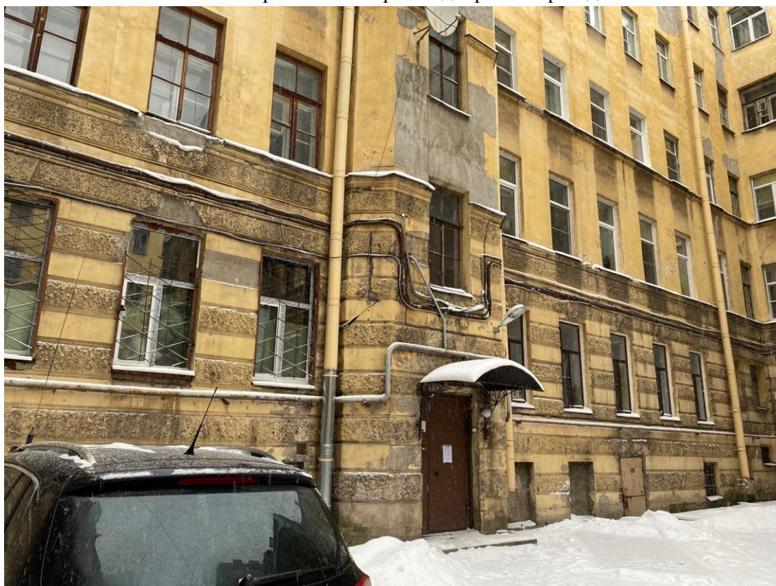
12. Фрагмент северного дворового фасада
