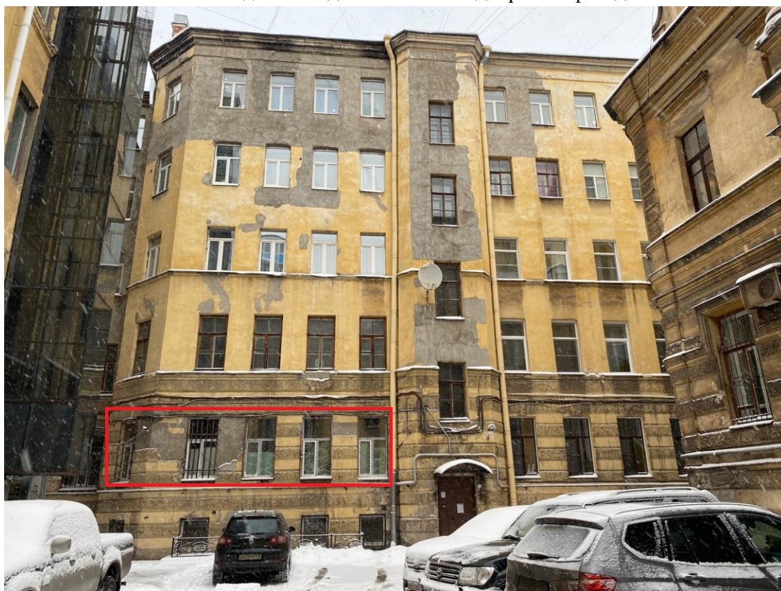
8. Северный дворовой фасад
