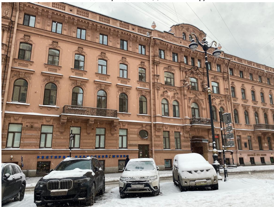
2. Западный фасад ОКН «Дом М.Б.Баструевой»
