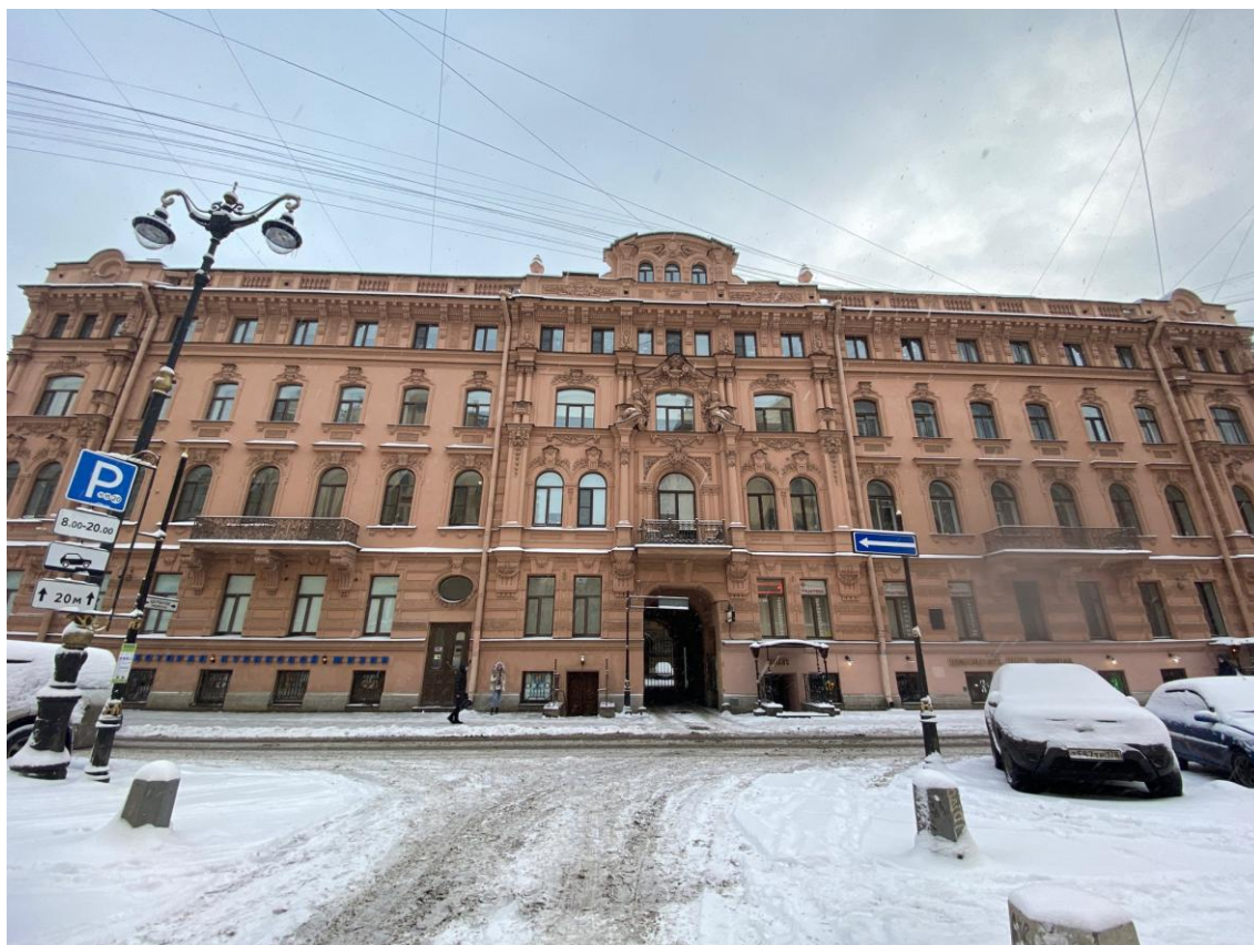
1. Западный фасад ОКН «Дом М.Б.Баструевой»
