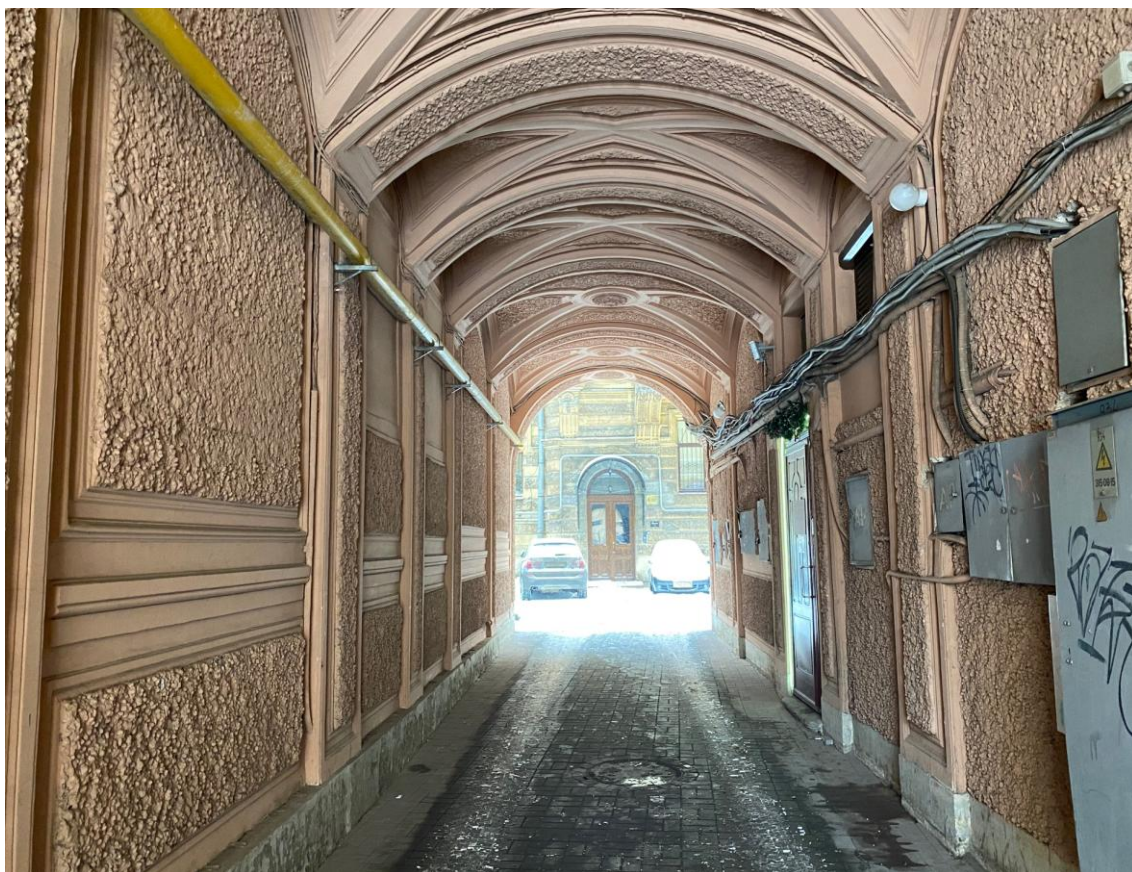
5. Арочный проезд на сторону двора
