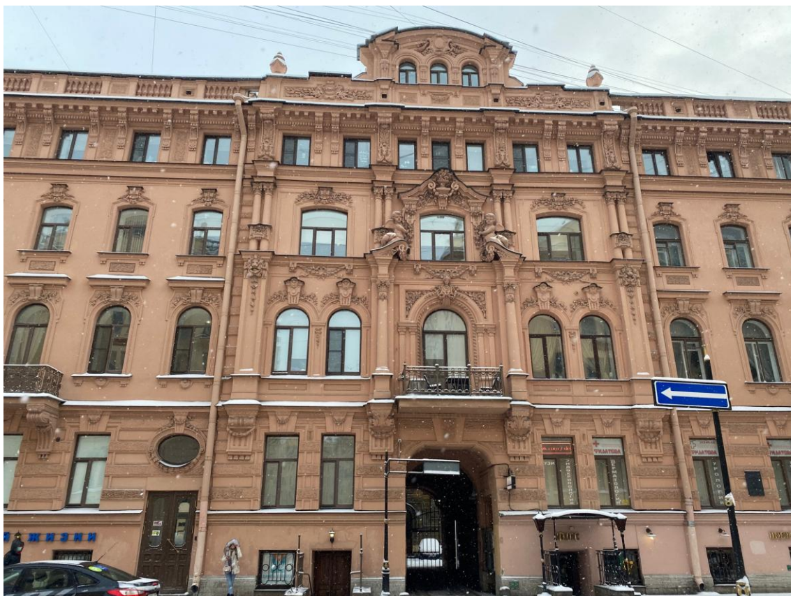
3. Западный фасад ОКН «Дом М.Б.Баструевой»
