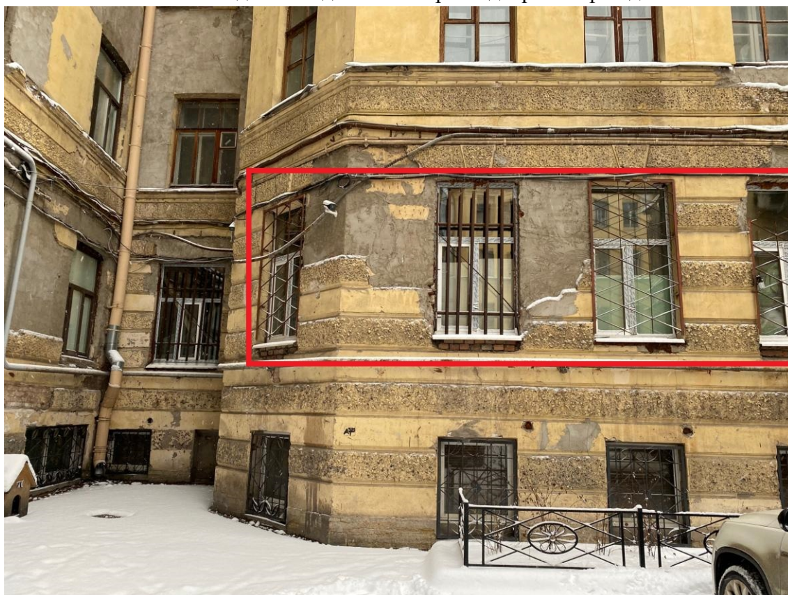
10. Фрагмент северного дворового фасада
