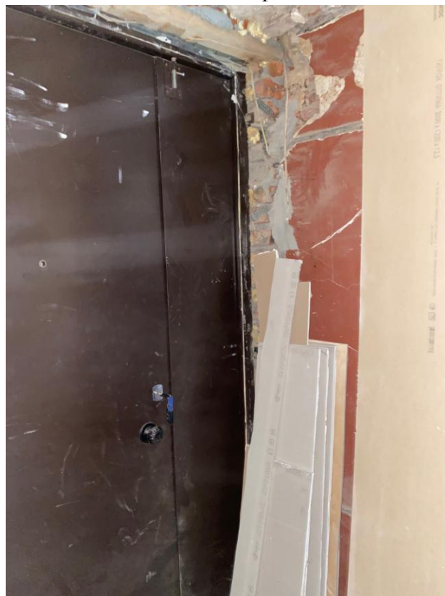
16. Входная дверь в кв. №58
