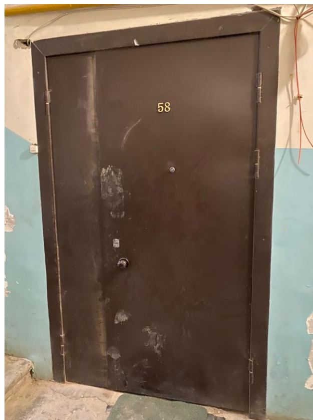
14. Входная дверь в кв. №58
