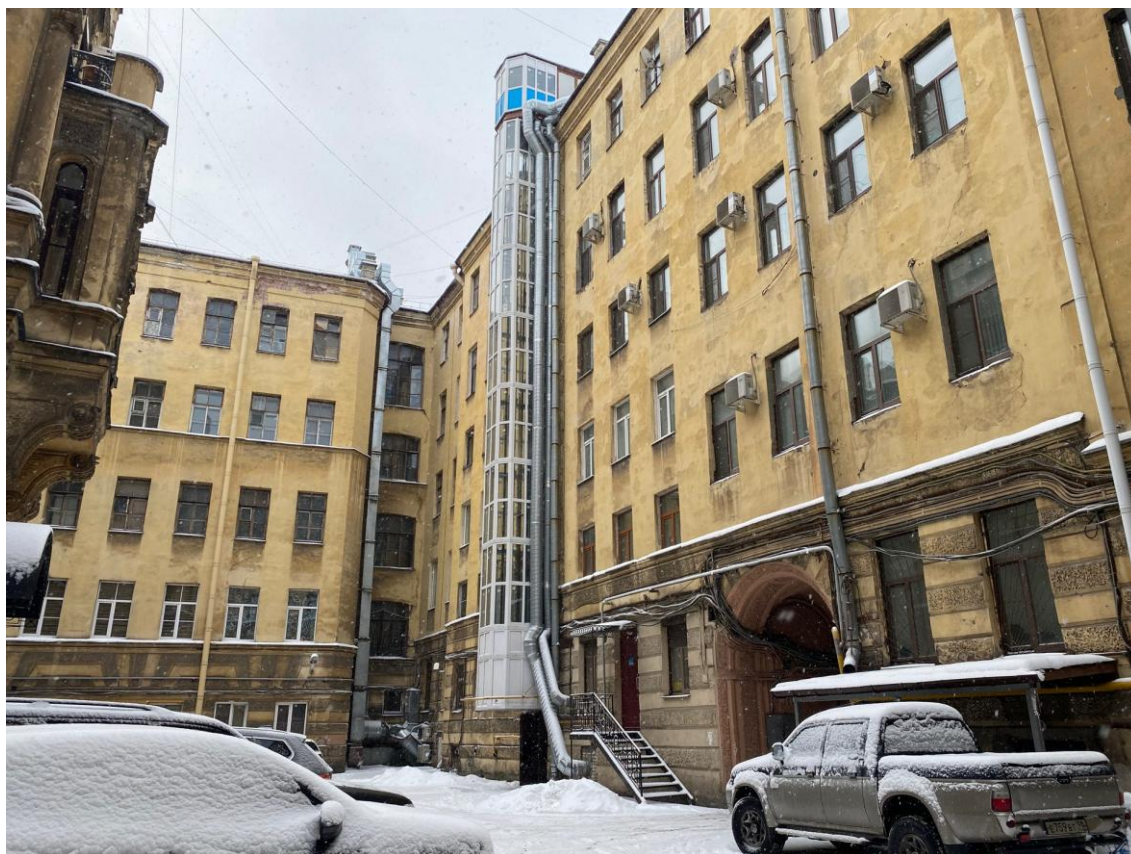
7. Вид на западный и южный дворовые фасады
