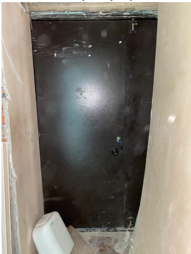
15. Входная дверь в кв. №58
