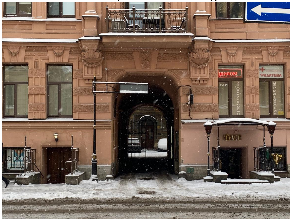
4. Западный фасад ОКН «Дом М.Б.Баструевой»
