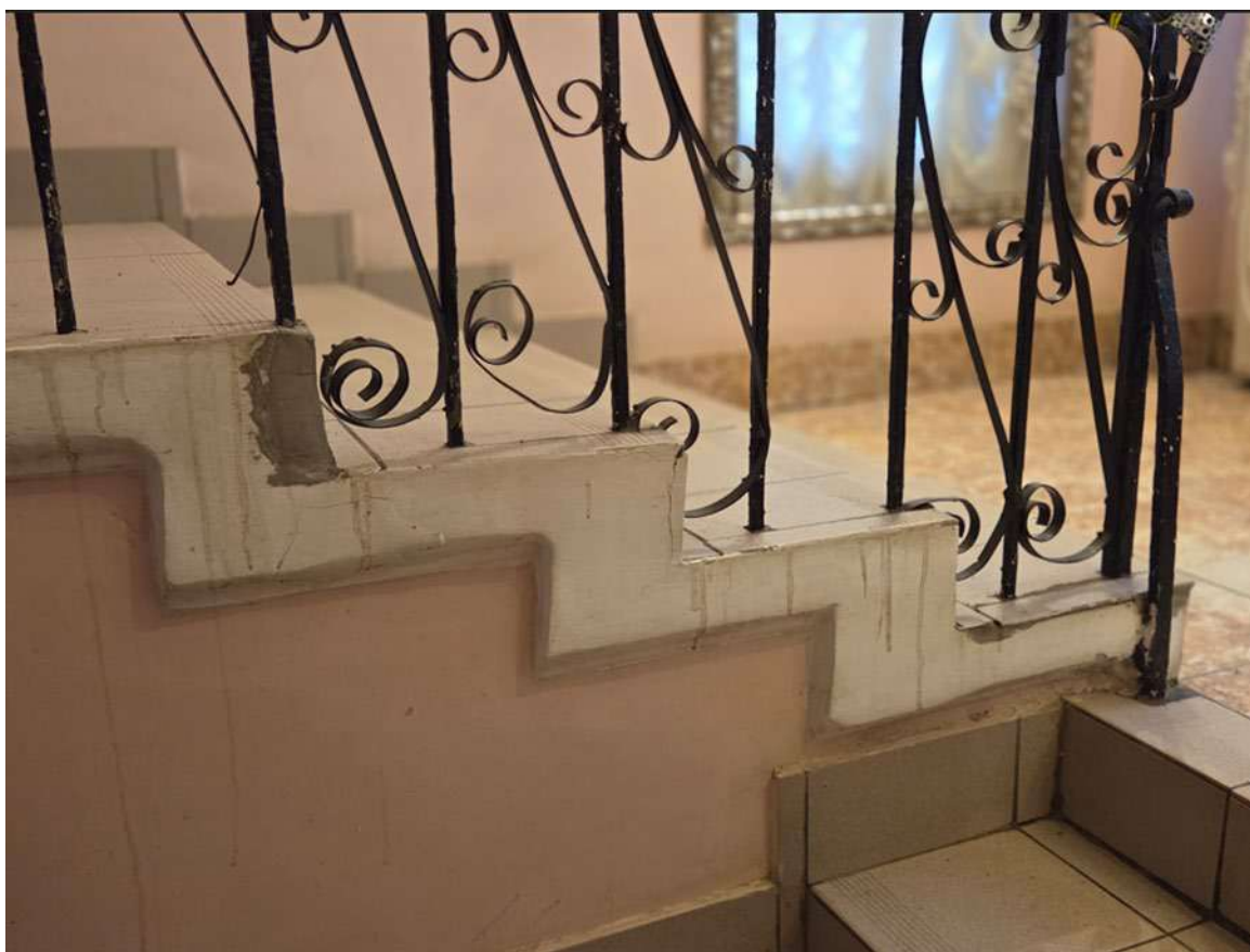
32. ОКНРЗ «Городской дом начальных училищ им. М. Г. Петрова». Фрагмент лестницы. Ступени, вмонтированные в стену. Дата съемки 08.12.2025г.
