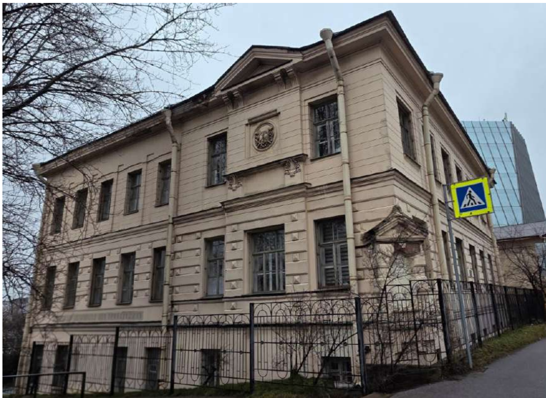
13. ОКНРЗ «Городской дом начальных училищ им. М. Г. Петрова». Вид с юга. Раскреповка южного фасада, завершенная треугольным фронтоном. Дата съемки 08.12.2025г.
