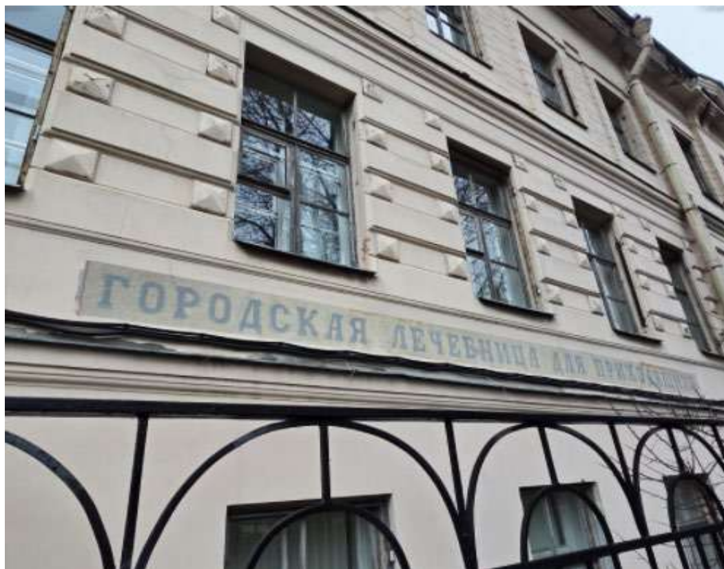
10. ОКНРЗ «Городской дом начальных училищ им. М. Г. Петрова». Фрагмент южного фасада. «Камни с алмазной гранью». Надпись на фризе первого этажа «Городская лечебница для проходящих» (материал - декоративные штукатурные растворы). Дата съемки 08.12.2025г.
