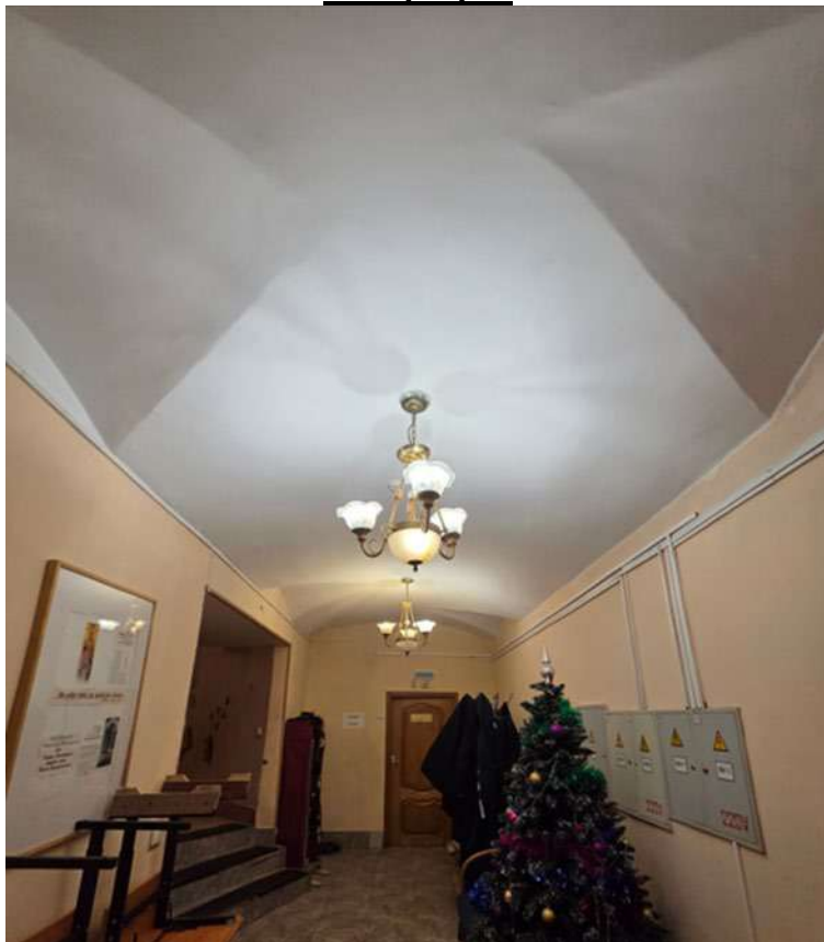
27. ОКНРЗ «Городской дом начальных училищ им. М. Г. Петрова». Коридор 1-го этажа здания. Своды с распалубками. Дата съемки 08.12.2025г.
