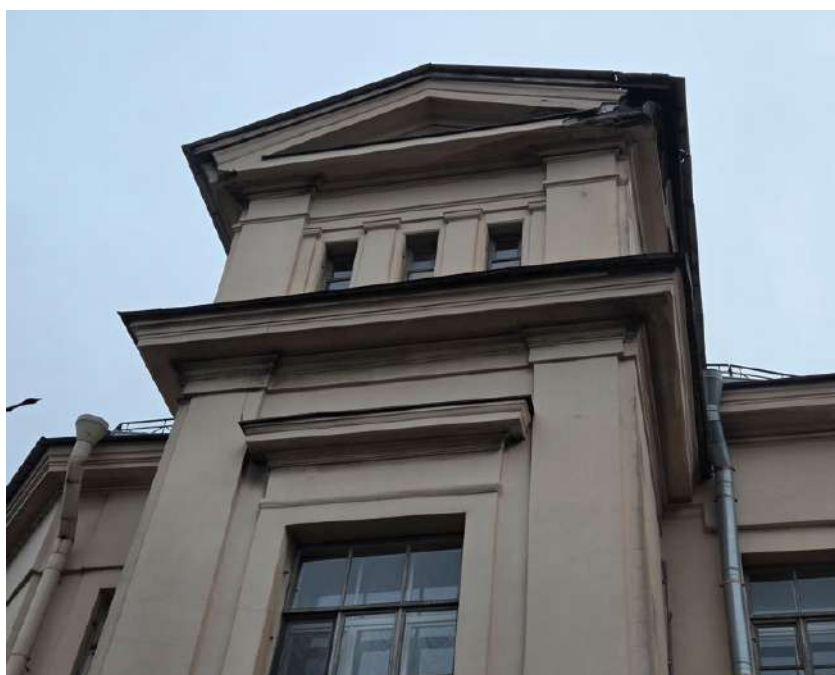
4. ОКНРЗ «Городской дом начальных училищ им. М. Г. Петрова». Фрагмент ризолита: треугольный фронтон; пилястры в межоконных простенках 3-го этажа, угловые пилястры во 2-м и 3-м этажах. Дата съемки 08.12.2025г.
