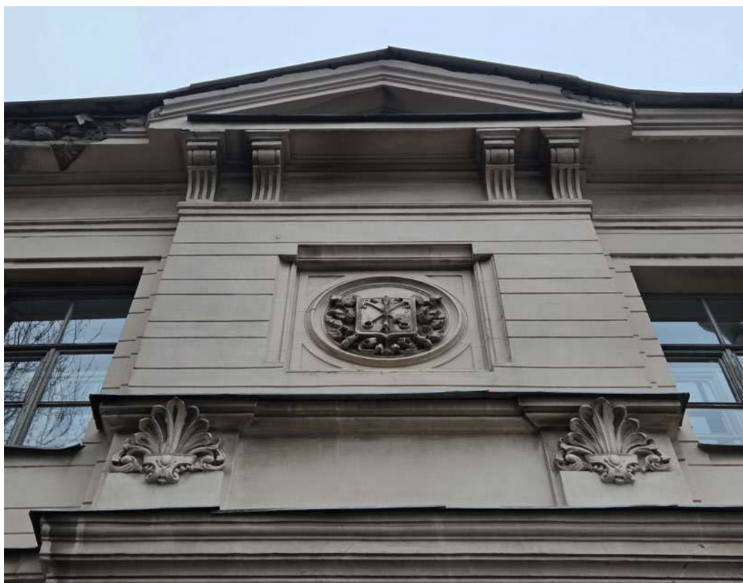
14. ОКНРЗ «Городской дом начальных училищ им. М. Г. Петрова». Фрагмент южного фасада. Треугольный фронтон на стилизованных кронштейнах, профилированный раскрепованный карниз со стилизованными лепными рокайлями. Дата съемки 08.12.2025г.
