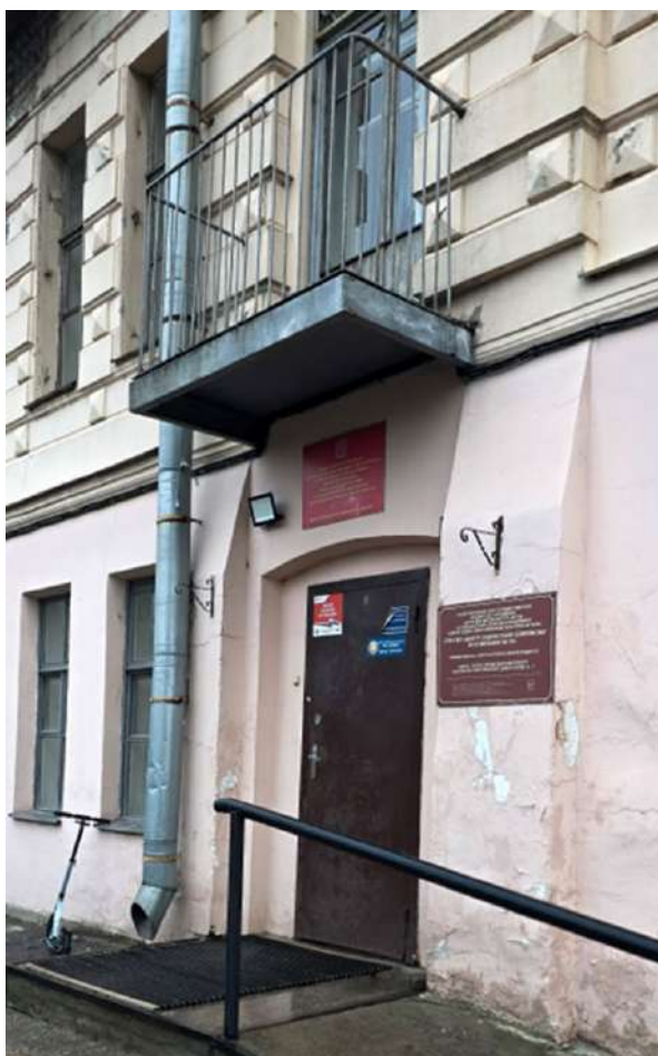
8. ОКНРЗ «Городской дом начальных училищ им. М. Г. Петрова». Фрагмент западного фасада. Главный вход. Лопатки по сторонам от дверного проема. Дата съемки 08.12.2025г.
