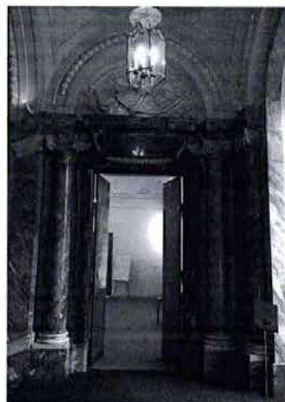
дверные проемы балконные в арочных проемах, двери двустворчатые, с филенками в нижних частях створок и остеклением в верхних, остекленные полуциркулярные фрамуги; наличники, обрамляющие арочные проемы из серого мрамора, над средней дверью лепная композиция; лепные филенки в простенках окон;
