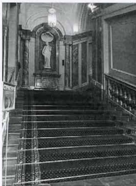
перила в виде балюстрады из серого мрамора, состоящей из четырехгранных устоев, между которыми расположены балясины квадратного сечения, верхняя доска серого мрамора, широкая с профилированными гребнями, перила в нишах стен;
