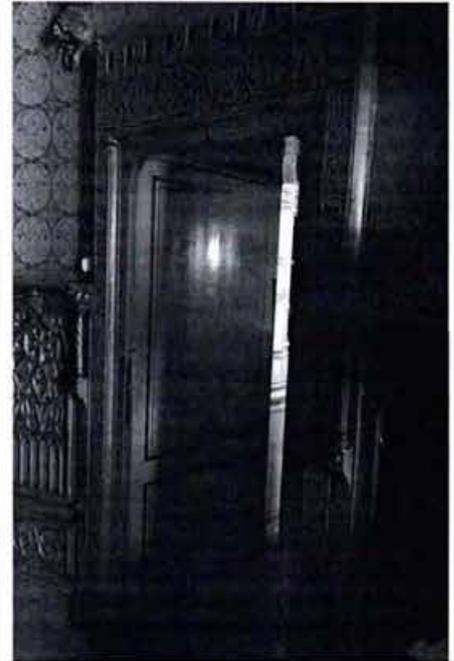
дверь двустворчатая с тамбуром, расположенном в арочном проеме, створки резные на две филенки каждая, нижняя филенка аналогична филенкам панели стены, верхняя с резьбой в виде арочек и сложного готического узора, фрамуга одна со сквозной резьбой, вторая глухая, в виде двух арок и треугольника; наличники в виде готической арки с горгульями;
