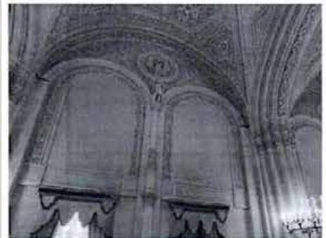
стены между пучков колонн двухъярусные, разделены по вертикали на две части лопаткой, к которой примыкает трехчетвертная канелированная колонна на высоком пьедестале со стилизованной капителью;
