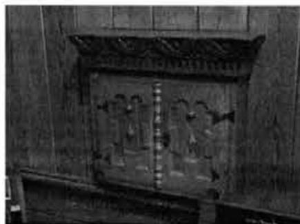
наличники дверей и окон дубовые, декорированные двумя рядами резьбы в виде витых жгутов и розеток; дверь одностворчатая, обшита узкими дубовыми планками, с большими коваными петлями в русском стиле\*;
