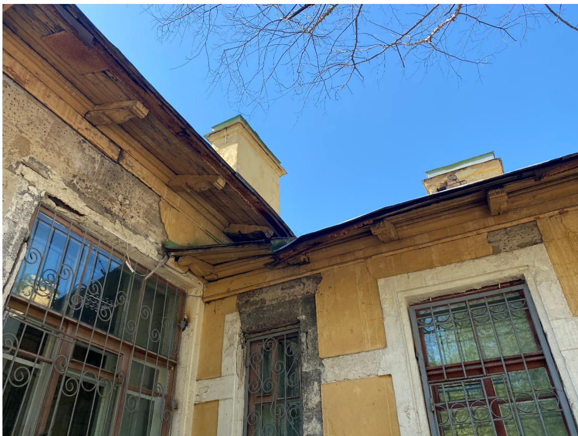
10. Фрагмент восточного фасада
