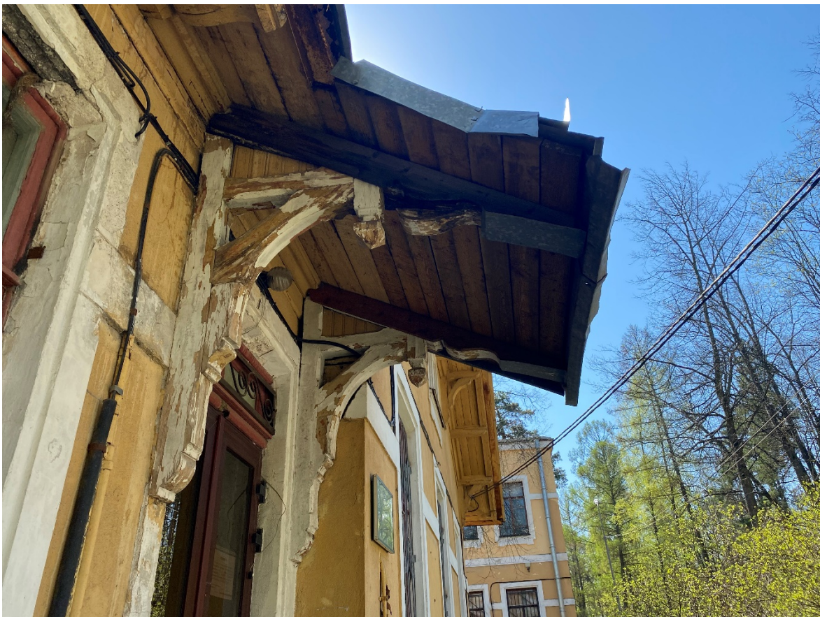
4. Козырек над дверным проемом на западном фасаде
