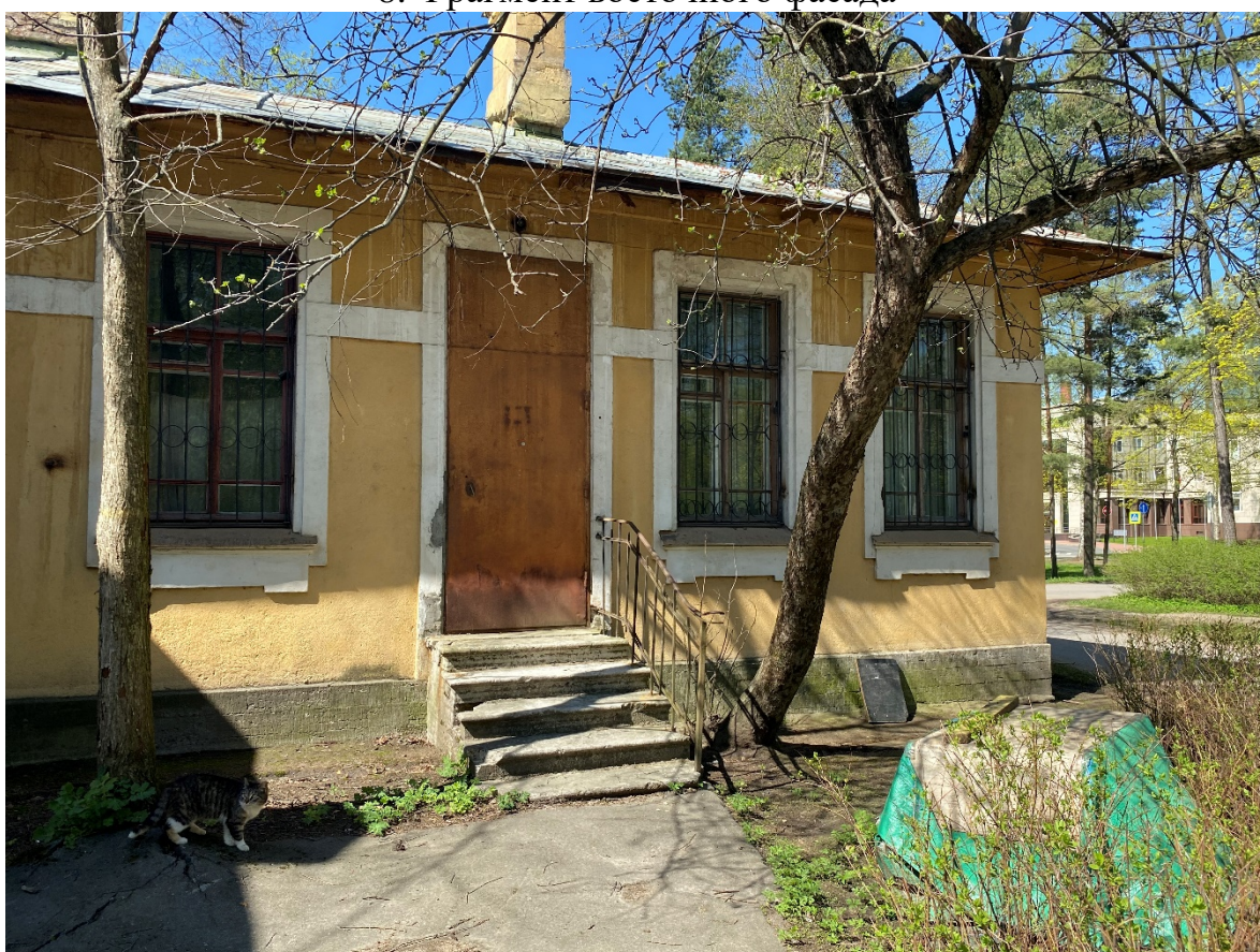
9. Фрагмент восточного фасада
