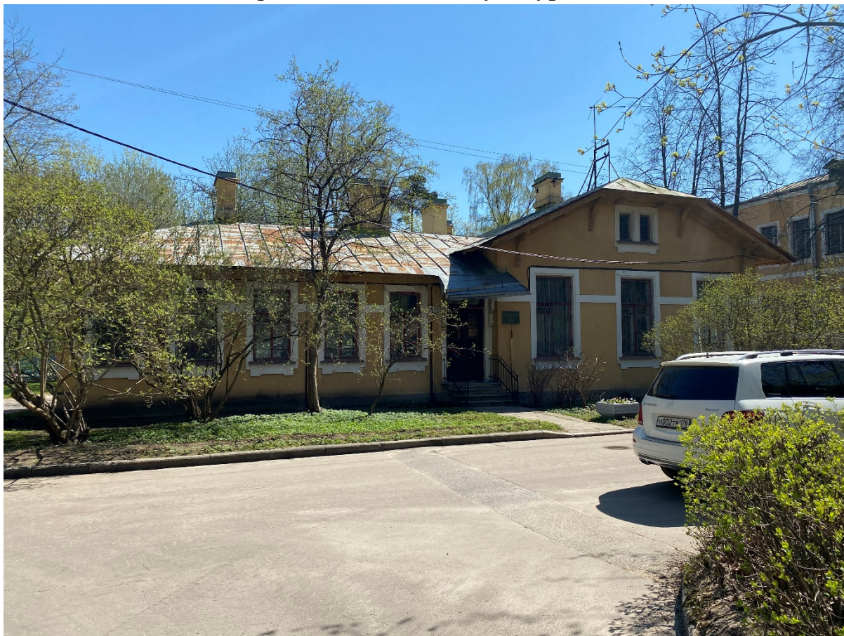
1. Вид на западный фасад
