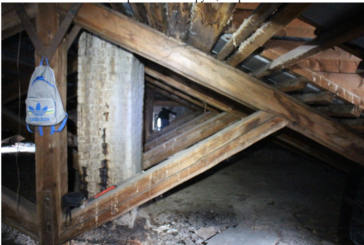
27. Общий вид крыши
