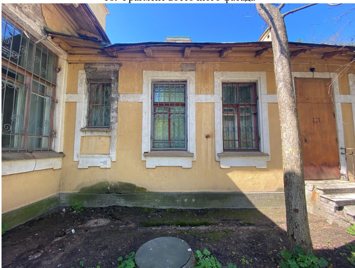
11. Фрагмент восточного фасада
