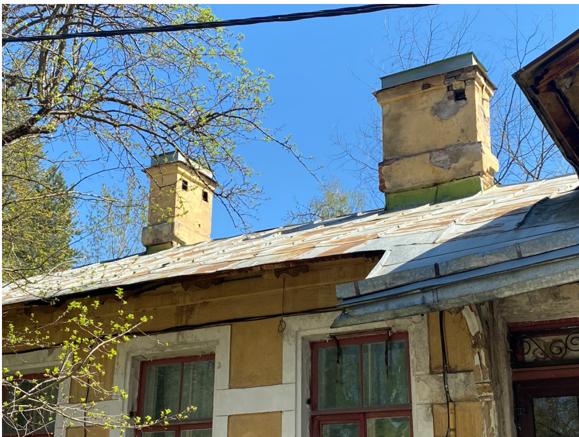
22. Кровля с востока
