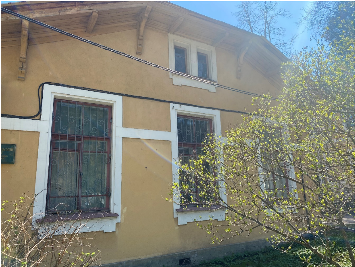
20. Фрагмент западного фасада
