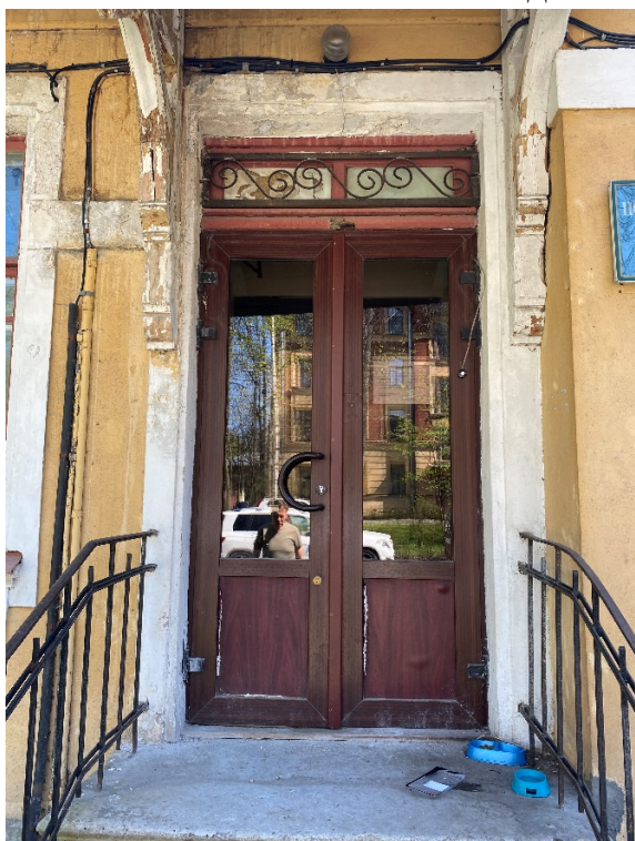
2. Дверной проем на западном фасаде
