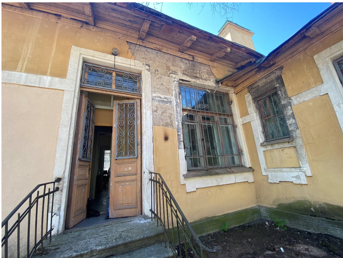
12. Фрагмент северо-восточного фасада
