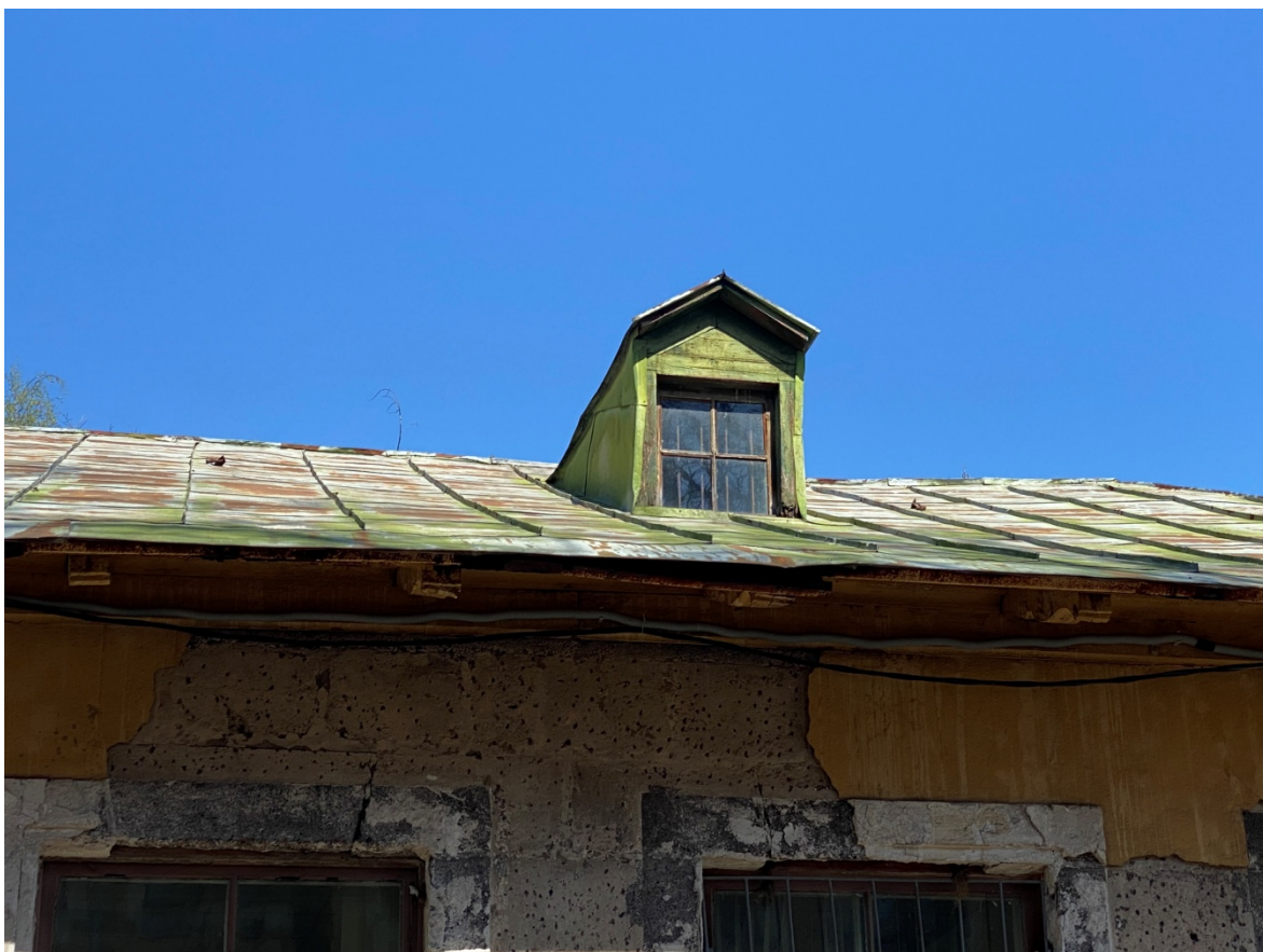
18. Фрагмент крыши, южная часть
