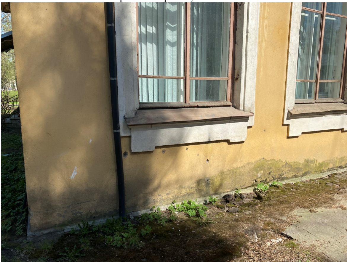
19. Фрагмент южного фасада
