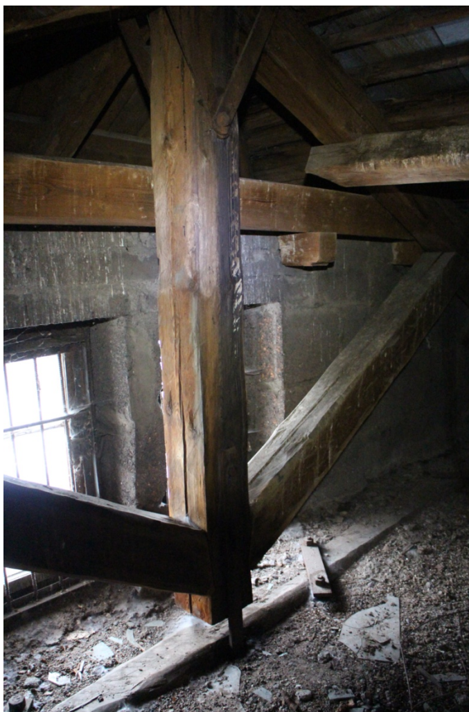
26. Фрагмент конструкций крыши
