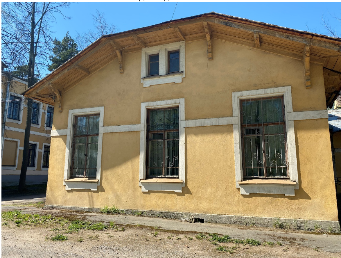
15. Фрагмент восточного фасада
