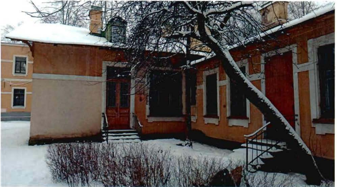
2. Вид на объект культурного наследия с северо-восточной стороны.
