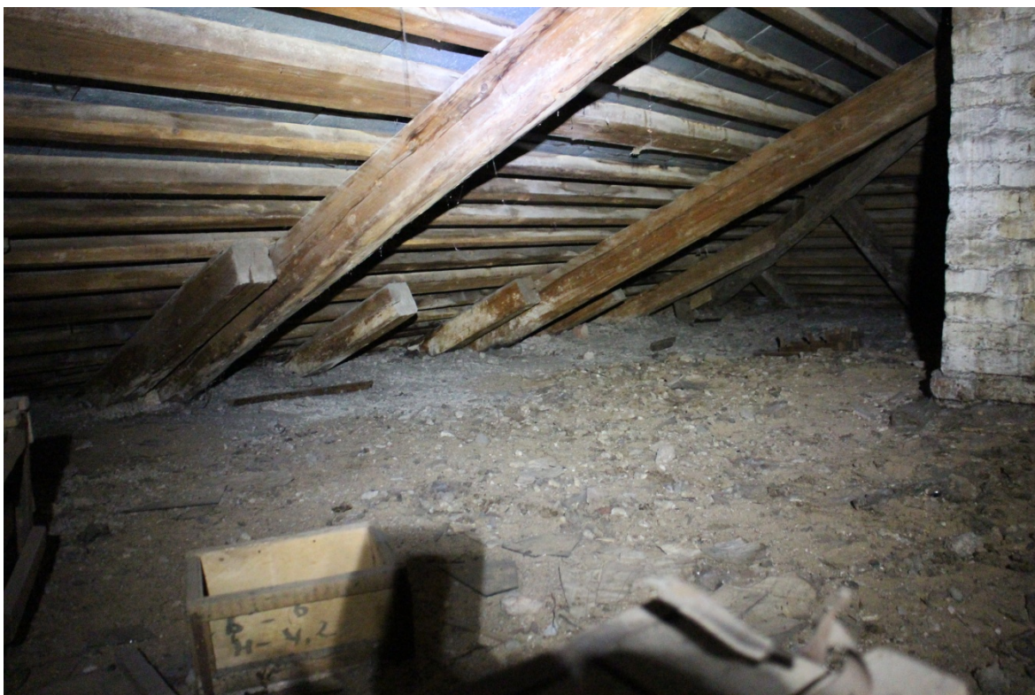
24. Фрагмент ската крыши
