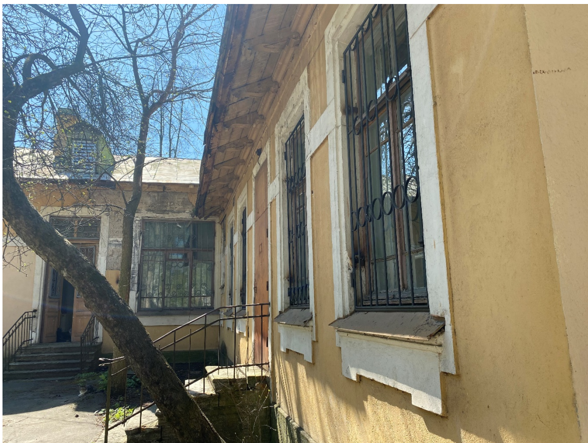
8. Фрагмент восточного фасада
