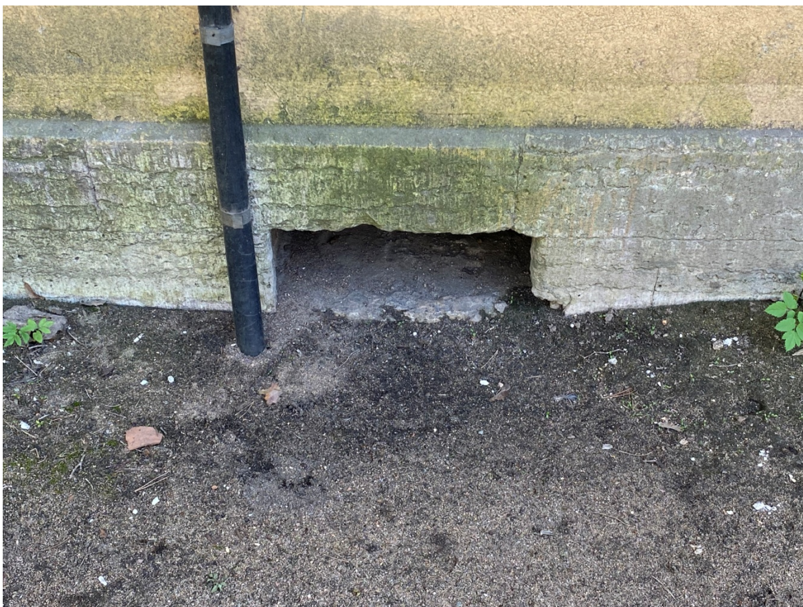
6. Проем в цоколе.
