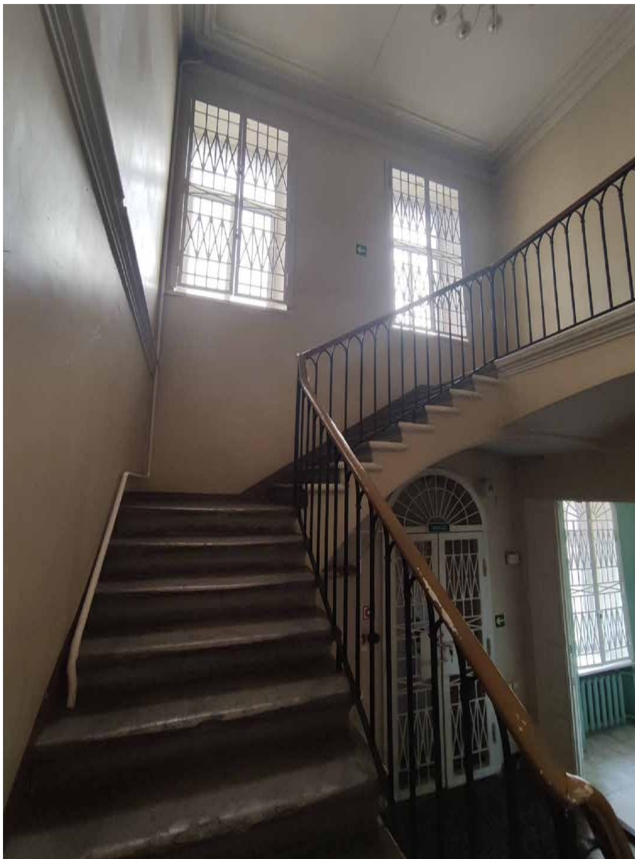
Фото 30. Объект культурного наследия регионального значения «Дом командира Уланского полка», расположенный по адресу: Санкт-Петербург, город Петергоф, Санкт-Петербургский проспект, дом 13/7. Общий вид пом. № 1-Н(24).
