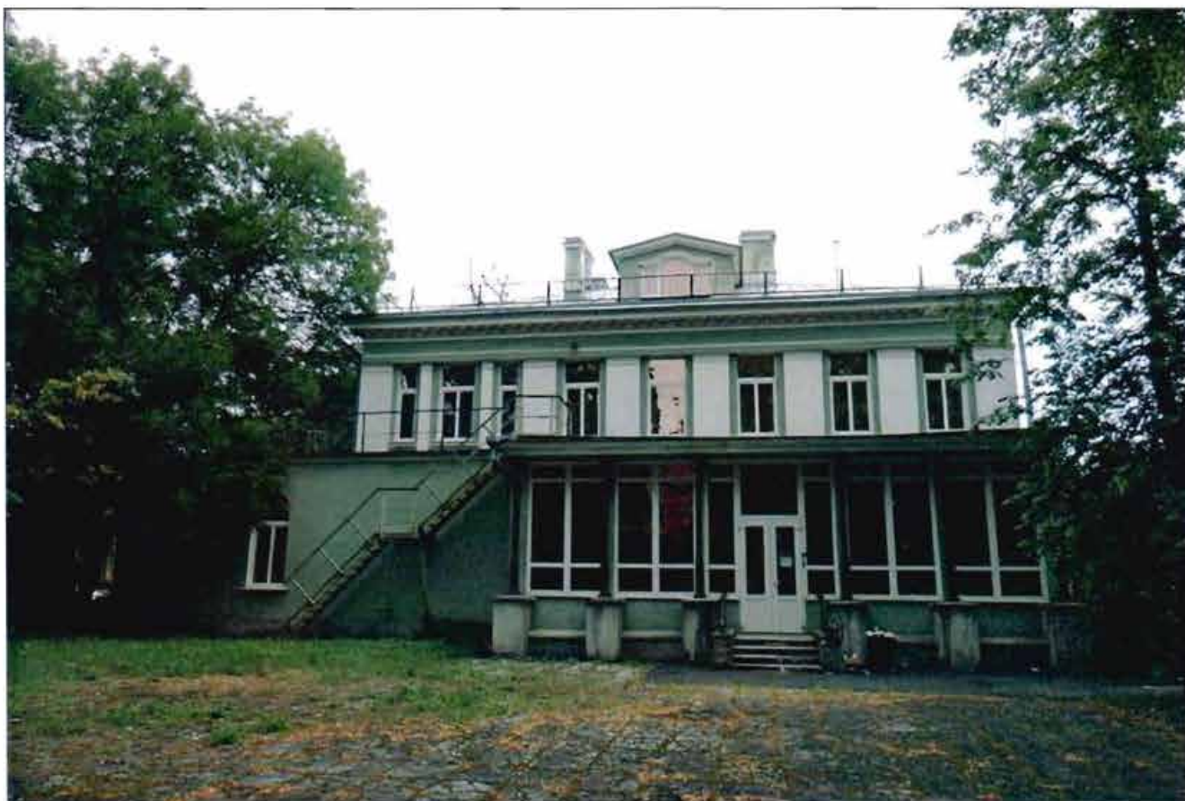
4. Западный фасад. Общий вид.
