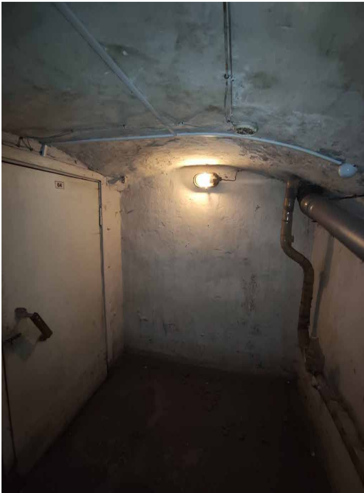
Фото 52 Объект культурного наследия регионального значения «Дом командира Уланского полка», расположенный по адресу: Санкт-Петербург, город Петергоф, Санкт-Петербургский проспект, дом 13/7. Общий вид пом. № 4-Н(1).
