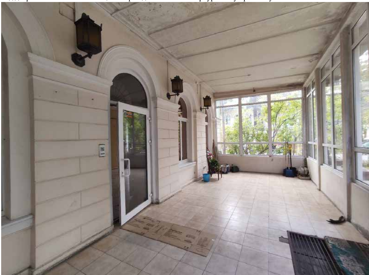
Фото 8. Объект культурного наследия регионального значения «Дом командира Уланского полка», расположенный по адресу: Санкт-Петербург, город Петергоф, Санкт-Петербургский проспект, дом 13/7. Общий вид пом. № 1-Н(1).
