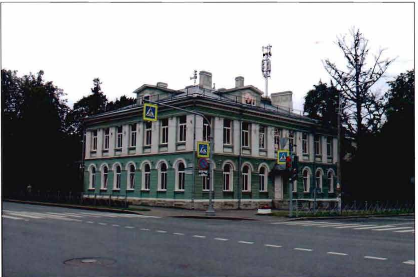
1. Общий вид с юго-востока.
