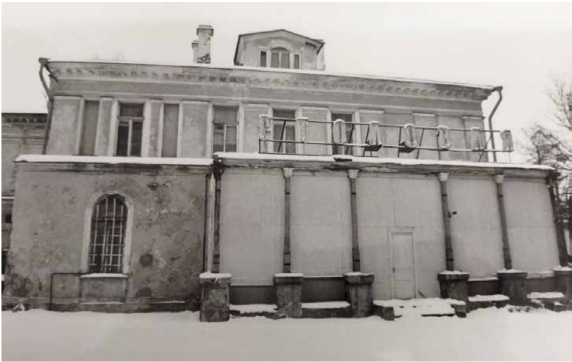
Иллюстрация 20. Дом командира Уланского полка. Западный фасад. Отдел систематизации, популяризации и хранения документированной информации об объектах культурного наследия КГИОП: - (203-Г-2) Н-4577/3 Проектная документация Банк «Петровский» г.Петродворец С.Петербургский пр. д.№ 13/7
