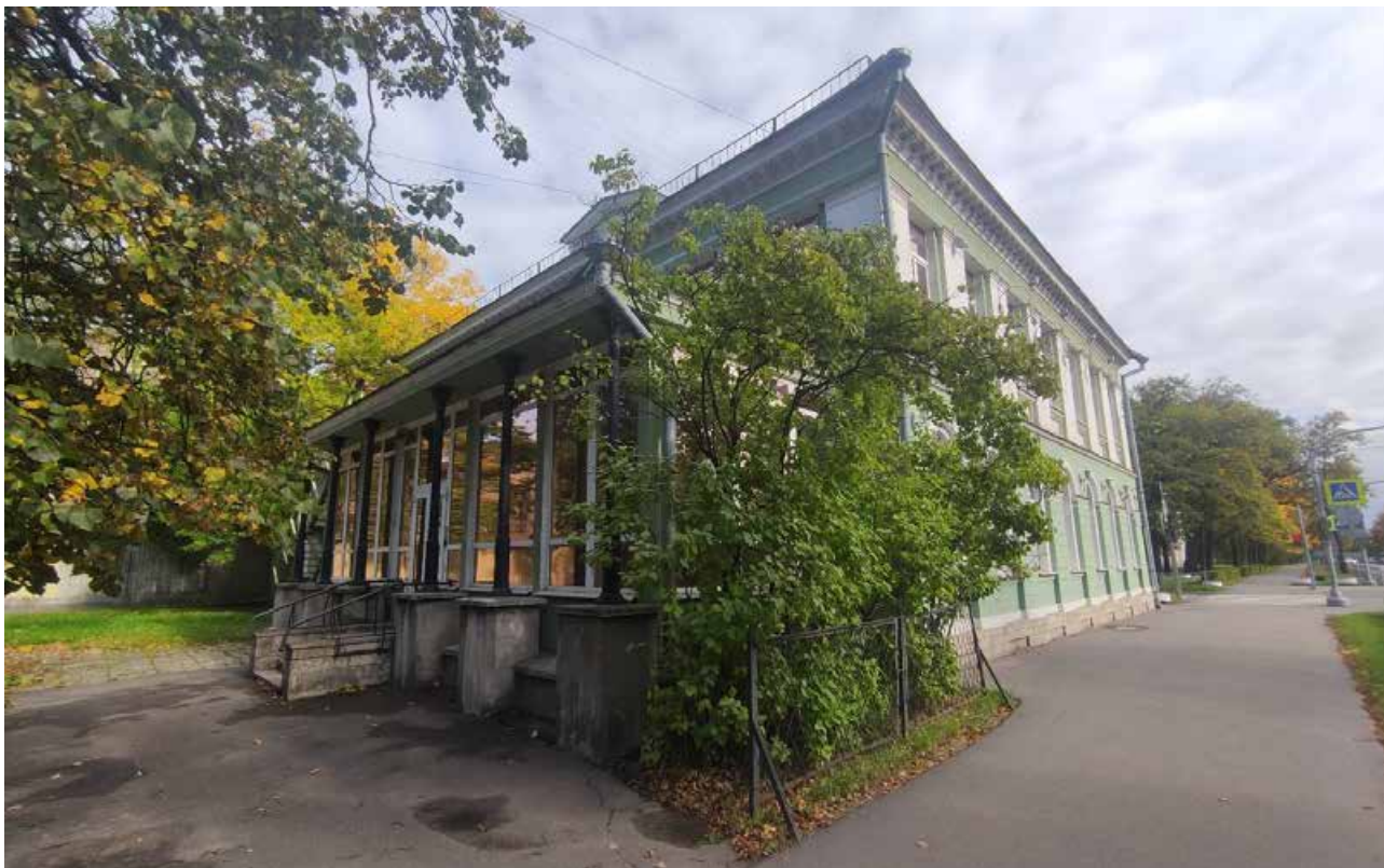
Фото 7. Объект культурного наследия регионального значения «Дом командира Уланского полка», расположенный по адресу: Санкт-Петербург, город Петергоф, Санкт-Петербургский проспект, дом 13/7. Общий вид дворового восточного и лицевого фасада по Санкт-Петербургскому проспекту.
