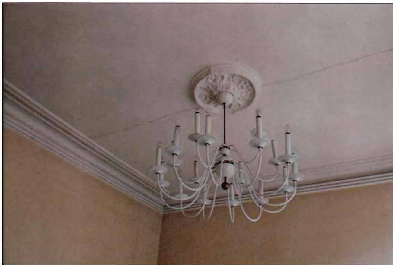
9. Интерьер. Фрагмент. Оформление потолка помещения лестницы.
