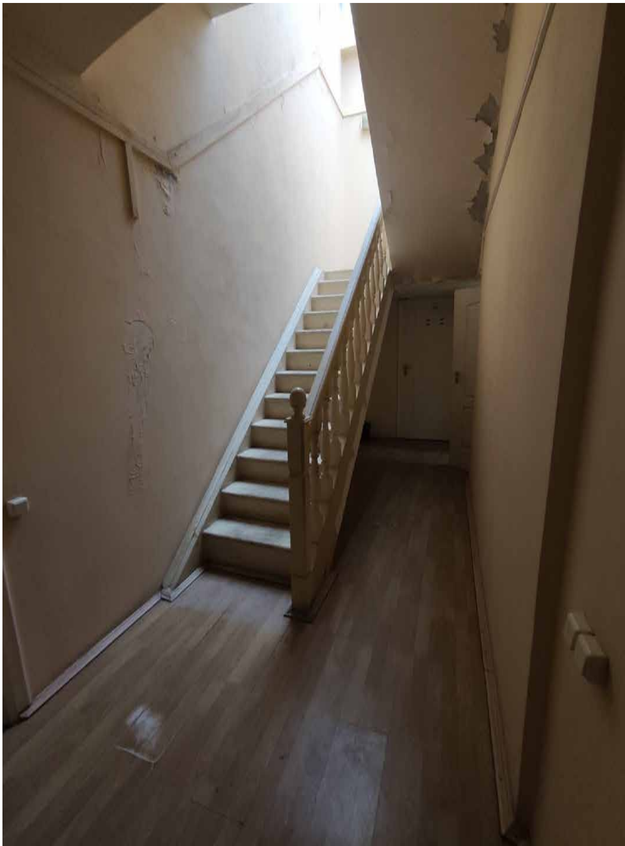
Фото 45. Объект культурного наследия регионального значения «Дом командира Уланского полка», расположенный по адресу: Санкт-Петербург, город Петергоф, Санкт-Петербургский проспект, дом 13/7. Общий вид пом. № 2-Н(1).
