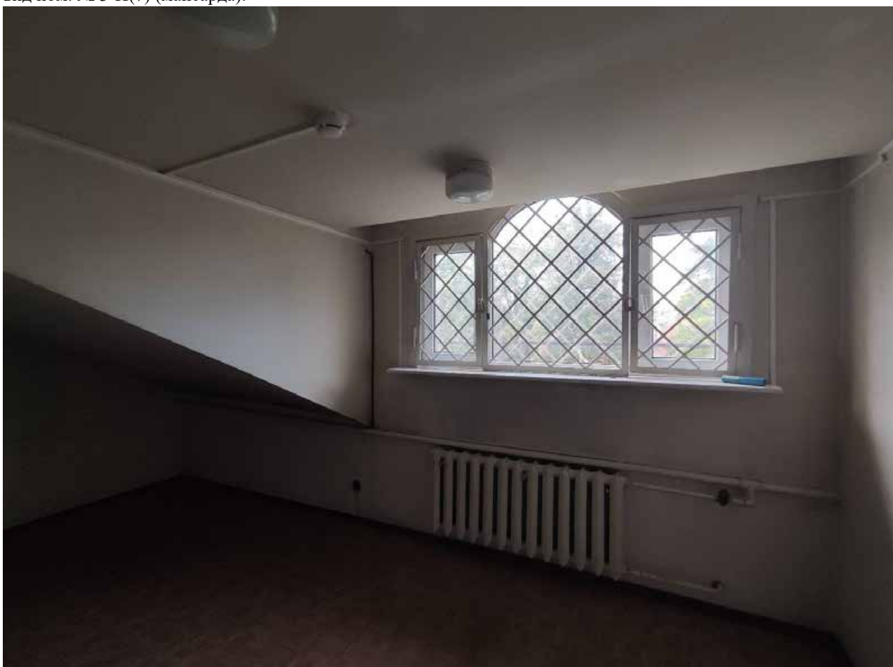
Фото 50 Объект культурного наследия регионального значения «Дом командира Уланского полка», расположенный по адресу: Санкт-Петербург, город Петергоф, Санкт-Петербургский проспект, дом 13/7. Общий вид пом. № 3-Н(8) (мансарда).
