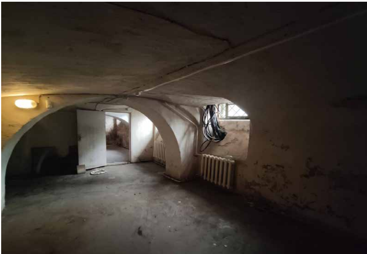
Фото 53 Объект культурного наследия регионального значения «Дом командира Уланского полка», расположенный по адресу: Санкт-Петербург, город Петергоф, Санкт-Петербургский проспект, дом 13/7. Общий вид пом. № 4-Н(4).
