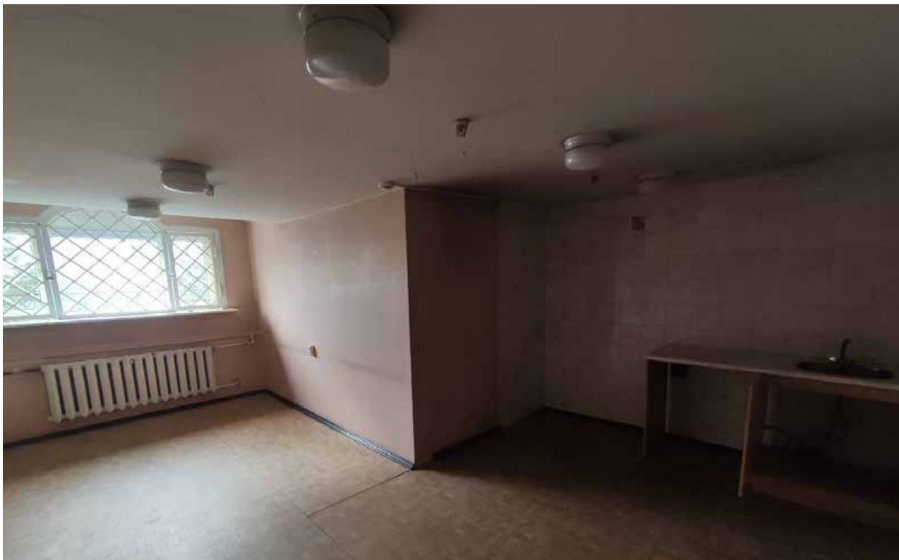
Фото 49. Объект культурного наследия регионального значения «Дом командира Уланского полка», расположенный по адресу: Санкт-Петербург, город Петергоф, Санкт-Петербургский проспект, дом 13/7. Общий вид пом. № 3-Н(7) (мансарда).
