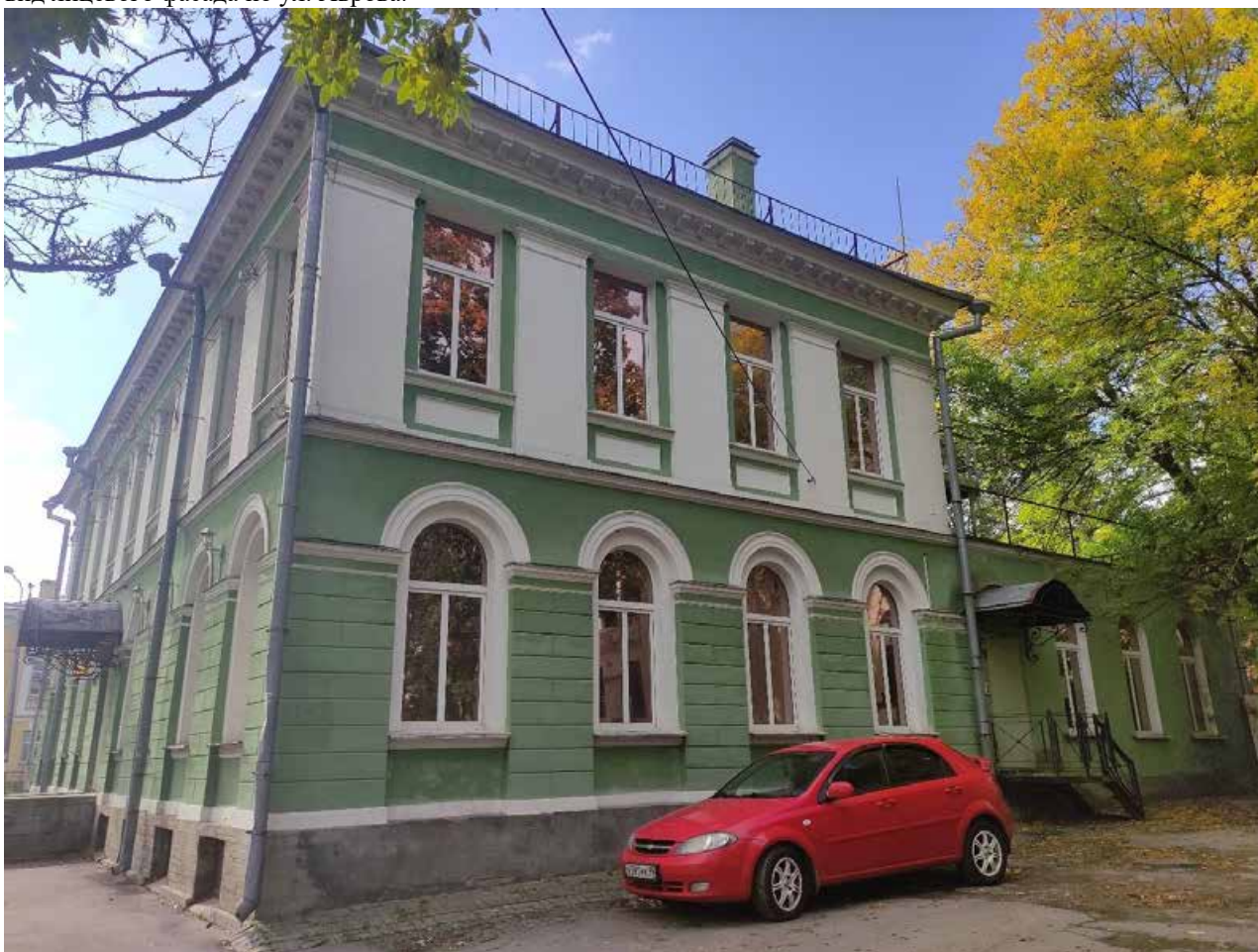
Фото 4. Объект культурного наследия регионального значения «Дом командира Уланского полка», расположенный по адресу: Санкт-Петербург, город Петергоф, Санкт-Петербургский проспект, дом 13/7. Общий вид дворового северного фасада.
