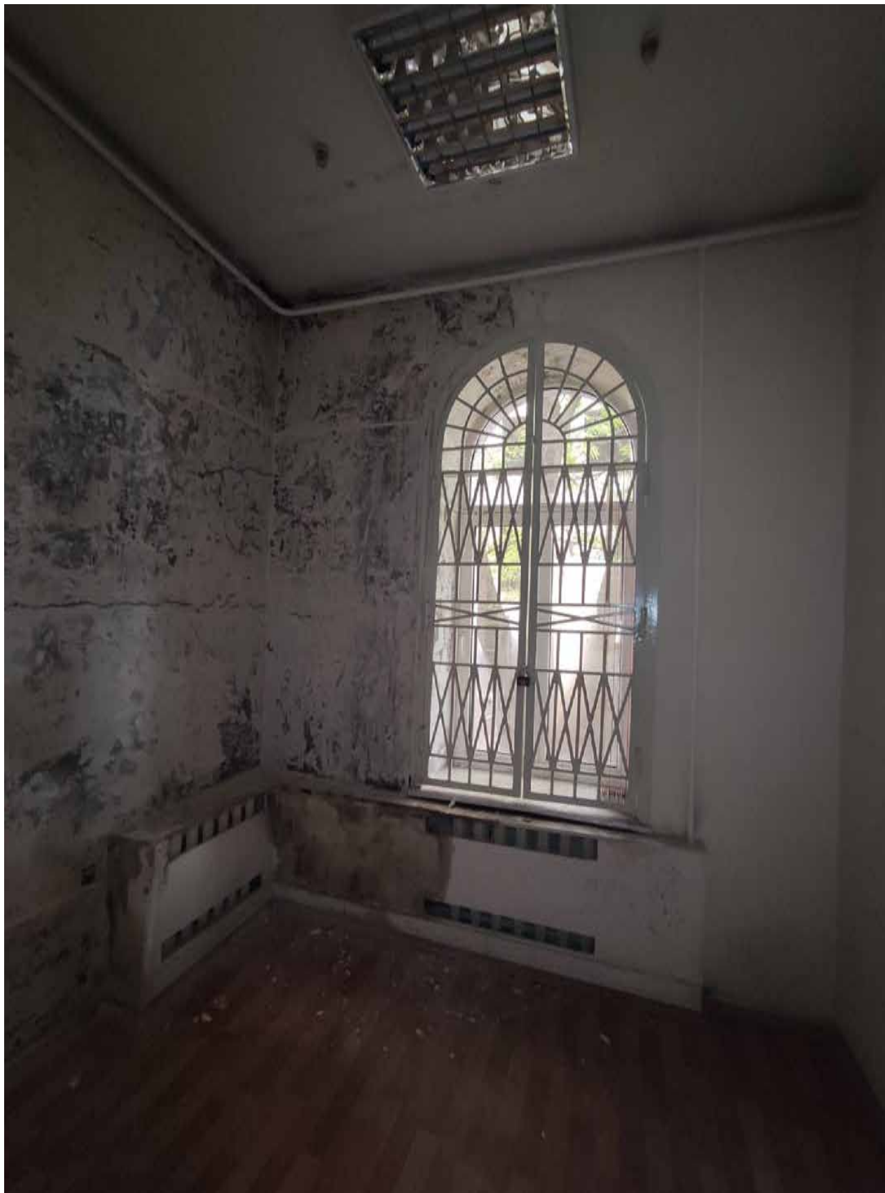
Фото 28. Объект культурного наследия регионального значения «Дом командира Уланского полка», расположенный по адресу: Санкт-Петербург, город Петергоф, Санкт-Петербургский проспект, дом 13/7. Общий вид пом. № 1-Н(9).
