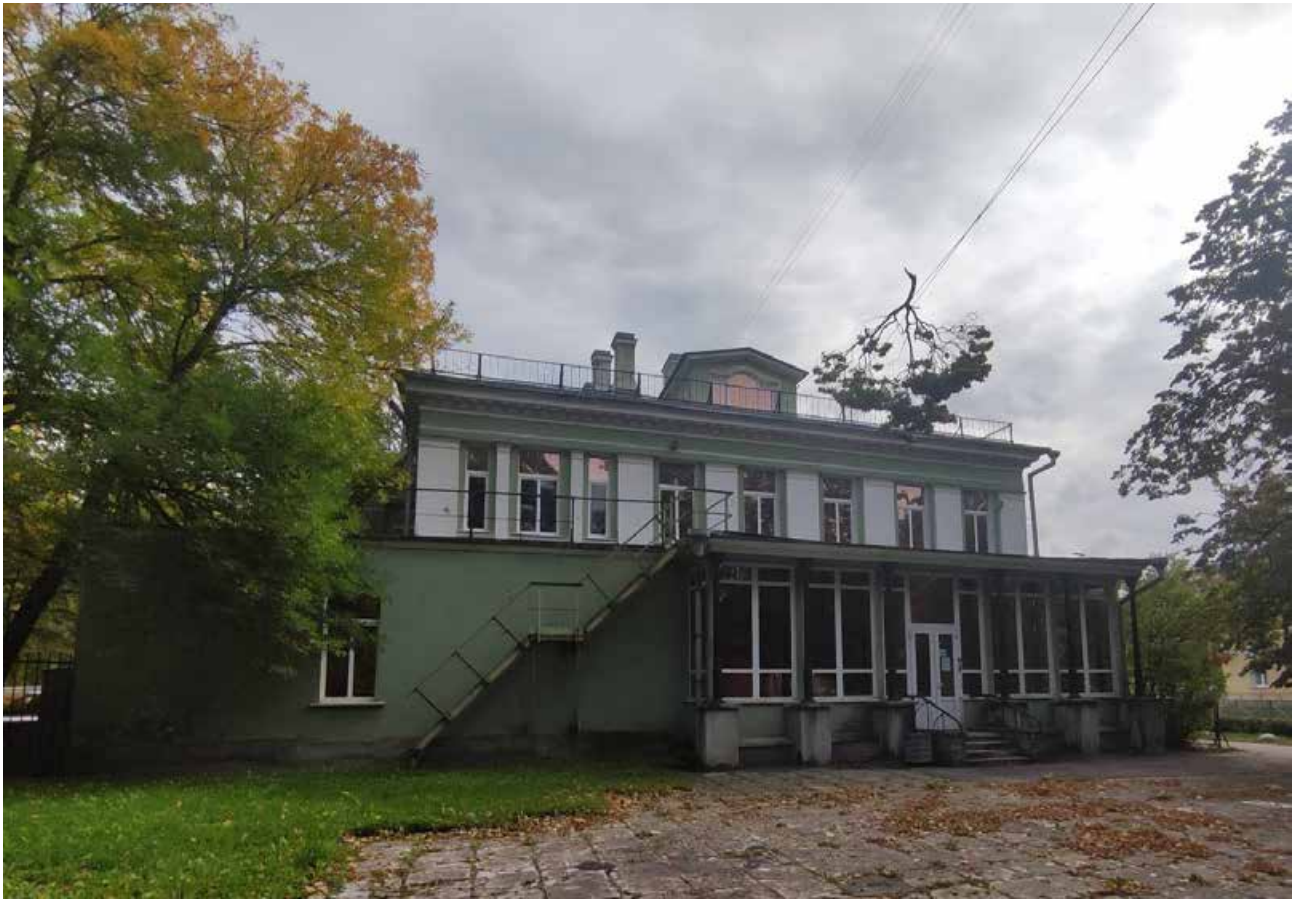
Фото 5. Объект культурного наследия регионального значения «Дом командира Уланского полка», расположенный по адресу: Санкт-Петербург, город Петергоф, Санкт-Петербургский проспект, дом 13/7. Общий вид дворового западного фасада.
