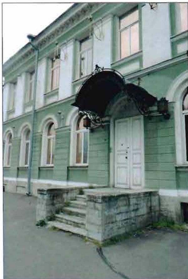
5. Восточный фасад. Фрагмент. Главный вход
