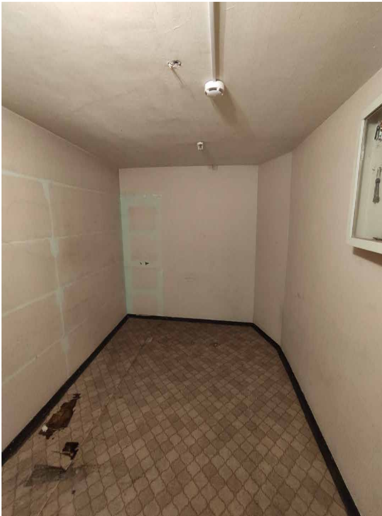
Фото 48. Объект культурного наследия регионального значения «Дом командира Уланского полка», расположенный по адресу: Санкт-Петербург, город Петергоф, Санкт-Петербургский проспект, дом 13/7. Общий вид пом. № 3-Н(1) (мансарда).
