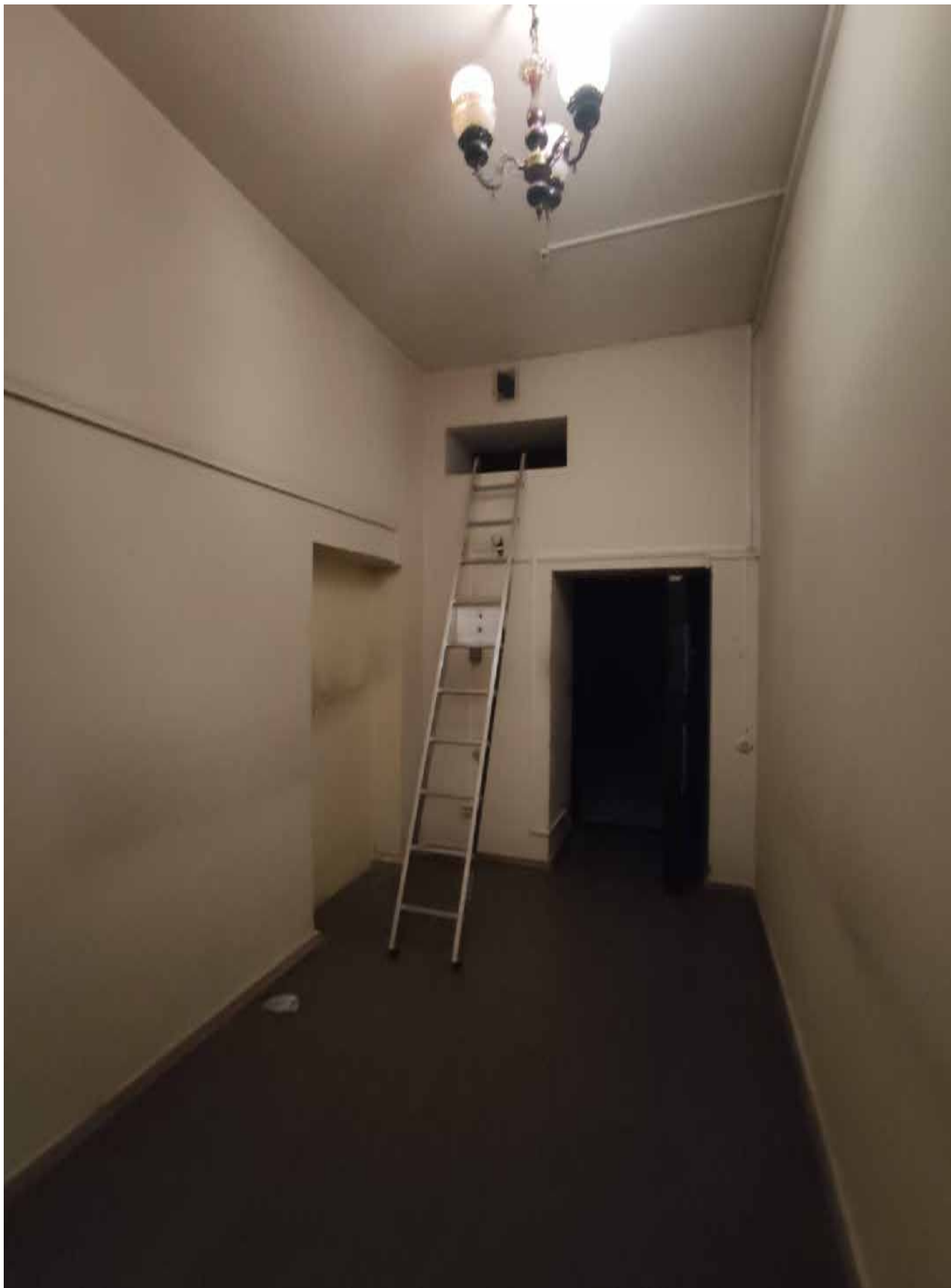
Фото 21. Объект культурного наследия регионального значения «Дом командира Уланского полка», расположенный по адресу: Санкт-Петербург, город Петергоф, Санкт-Петербургский проспект, дом 13/7. Общий вид пом. № 1-Н(15).
