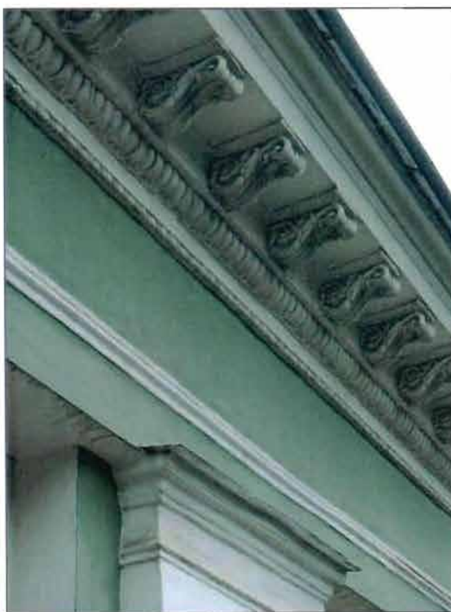
6. Западный фасад. Фрагмент. Венчающий карниз.
