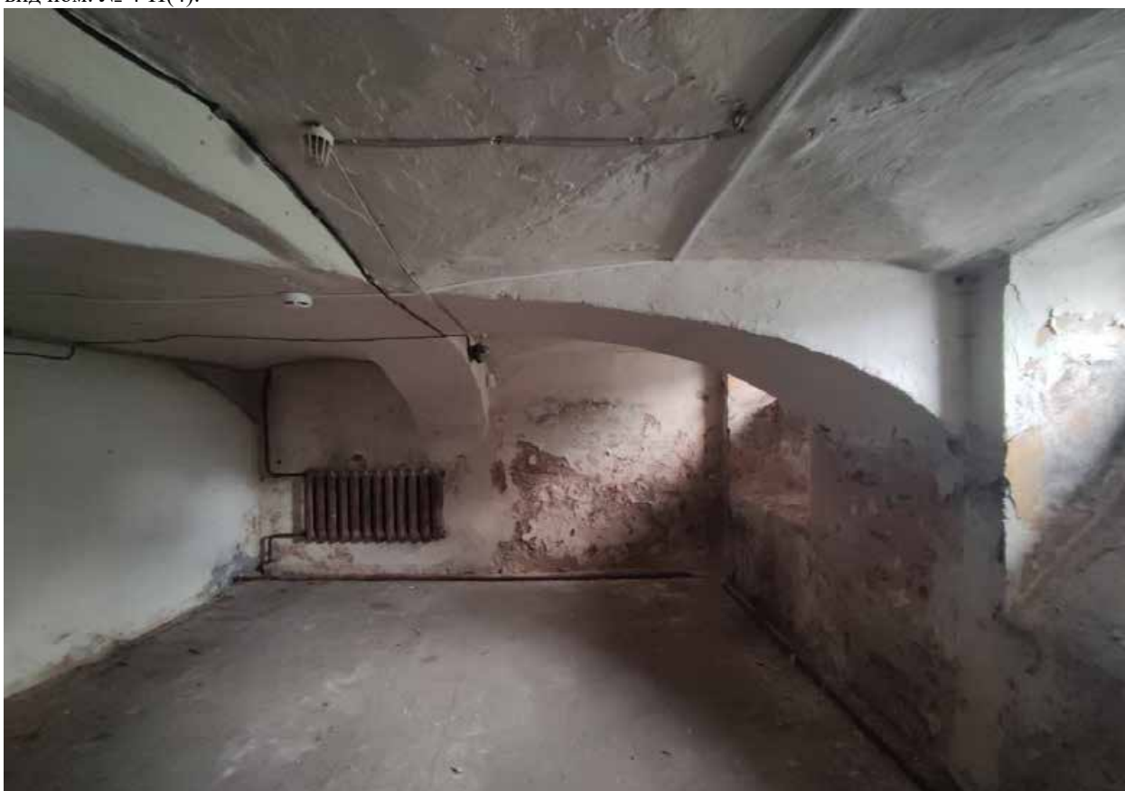
Фото 54. Объект культурного наследия регионального значения «Дом командира Уланского полка», расположенный по адресу: Санкт-Петербург, город Петергоф, Санкт-Петербургский проспект, дом 13/7. Общий вид пом. № 4-Н(3).
