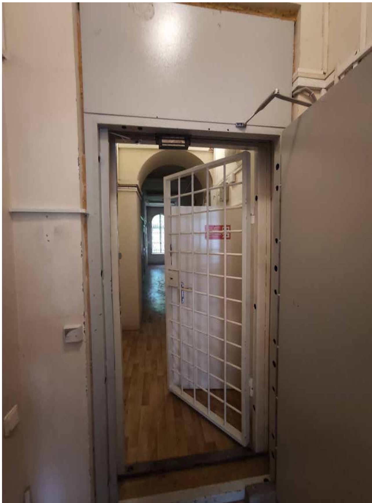
Фото 18. Объект культурного наследия регионального значения «Дом командира Уланского полка», расположенный по адресу: Санкт-Петербург, город Петергоф, Санкт-Петербургский проспект, дом 13/7. Общий вид пом. № 1-Н(6).
