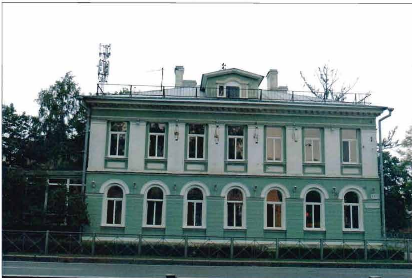
2. Южный фасад. Общий вид.
