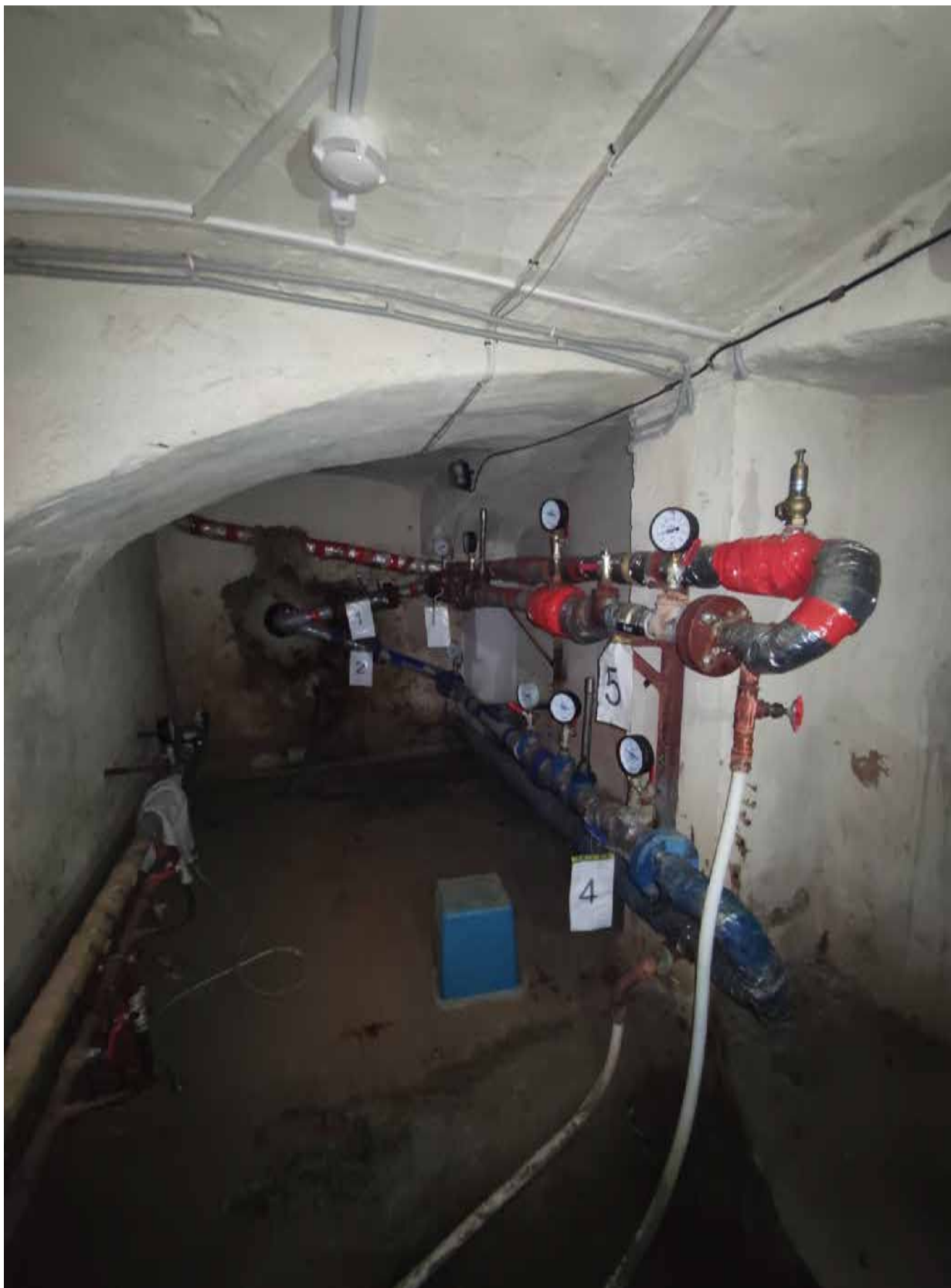
Фото 56. Объект культурного наследия регионального значения «Дом командира Уланского полка», расположенный по адресу: Санкт-Петербург, город Петергоф, Санкт-Петербургский проспект, дом 13/7. Общий вид пом. № 4-Н(2).
