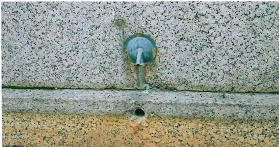
2. Водомет с медной накладкой и форсункой.
