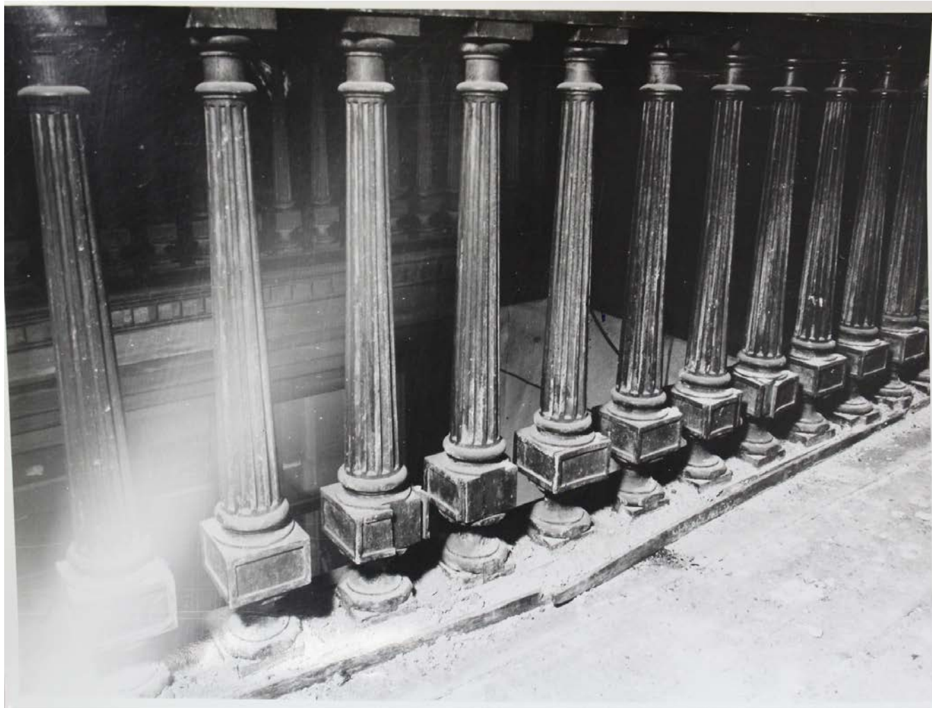
55. Особняк О.В. Серебряковой. Фотофиксация интерьеров до реставрации. Фрагмент балюстрады хор в Буфетной. 1981 г. // ЦГАНТД СПб. Ф. Р-488. Оп.314. Д. 133.
