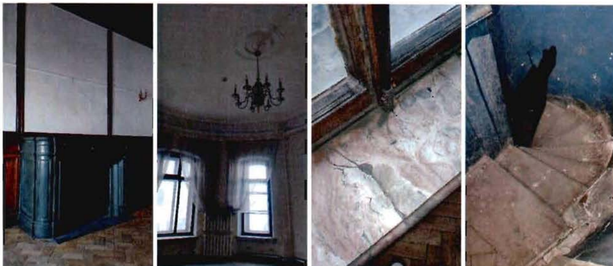
30, 31, 32, 33. Лестница ЗЛК объекта культурного наследия
