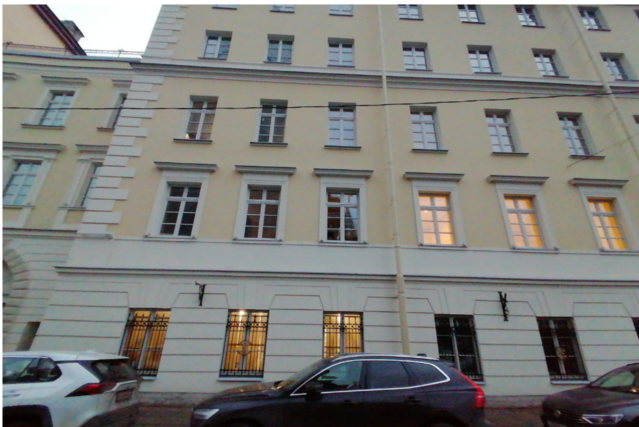
Фото 4. Общий вид объекта. Лицевой фасад со стороны наб. канала Грибоедова
