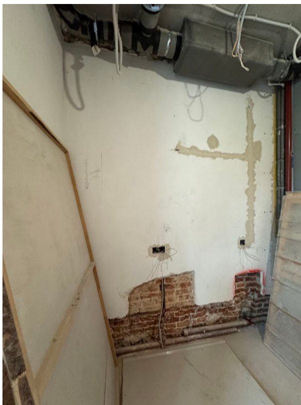
Фото 38. Общий вид на часть рассматриваемого помещения в границах объекта культурного наследия
