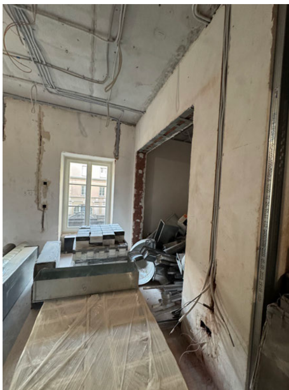
Фото 58. Общий вид на часть рассматриваемого помещения в границах объекта культурного наследия
