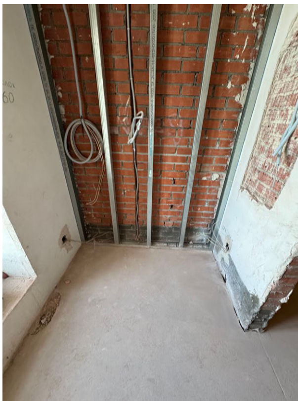
Фото 26. Общий вид на часть рассматриваемого помещения в границах объекта культурного наследия
