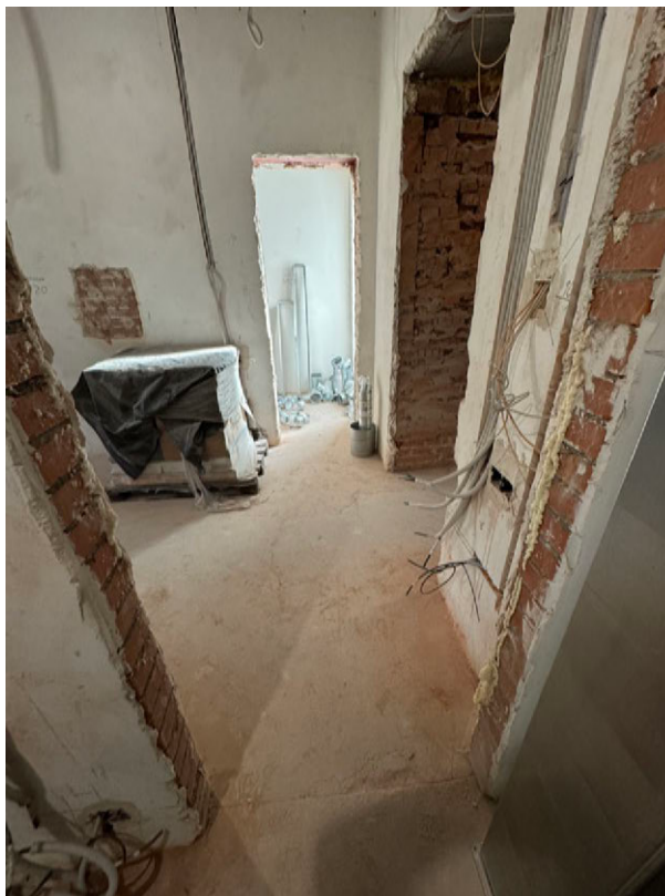
Фото 7. Общий вид на часть рассматриваемого помещения в границах объекта культурного наследия
