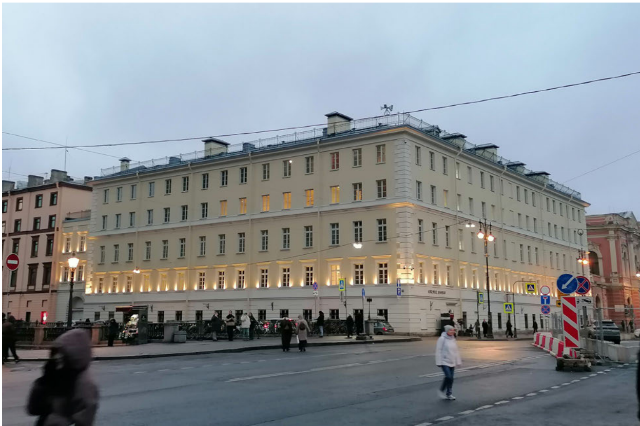
Фото 1. Общий вид объекта. Лицевой фасад со стороны Конюшенного моста.
