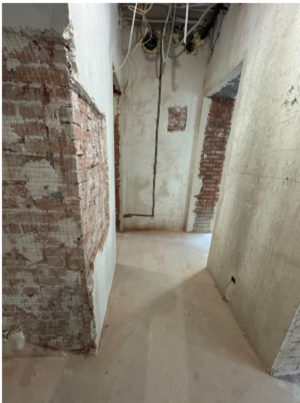
Фото 21. Общий вид на часть рассматриваемого помещения в границах объекта культурного наследия
