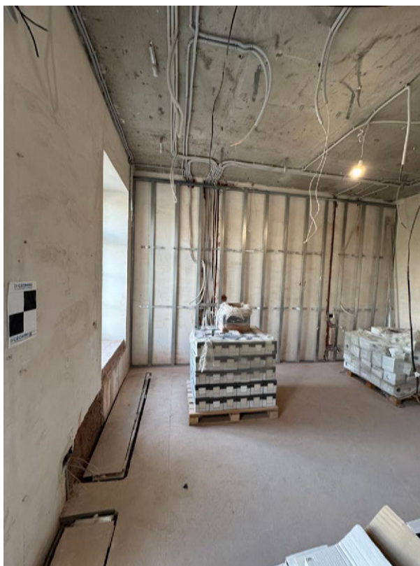
Фото 45. Общий вид на часть рассматриваемого помещения в границах объекта культурного наследия
