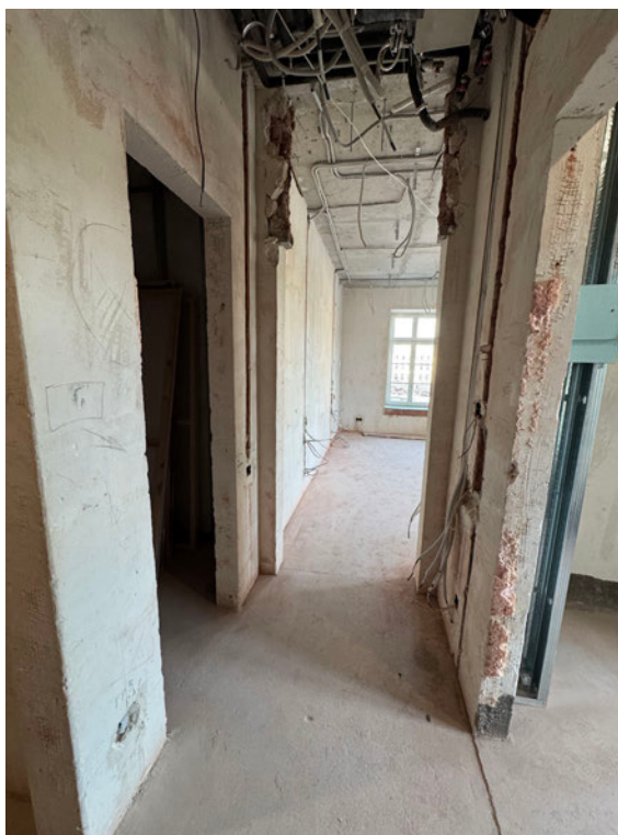
Фото 47. Общий вид на часть рассматриваемого помещения в границах объекта культурного наследия
