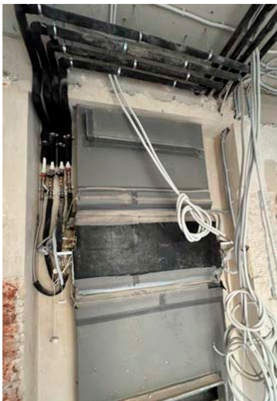
Фото 15. Общий вид на часть рассматриваемого помещения в границах объекта культурного наследия
