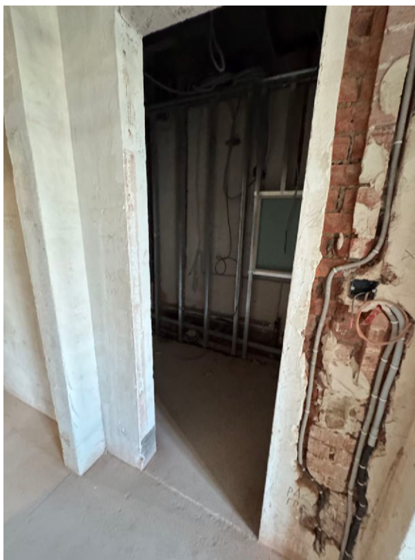
Фото 41. Общий вид на часть рассматриваемого помещения в границах объекта культурного наследия
