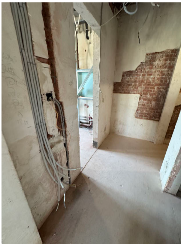
Фото 50. Общий вид на часть рассматриваемого помещения в границах объекта культурного наследия
