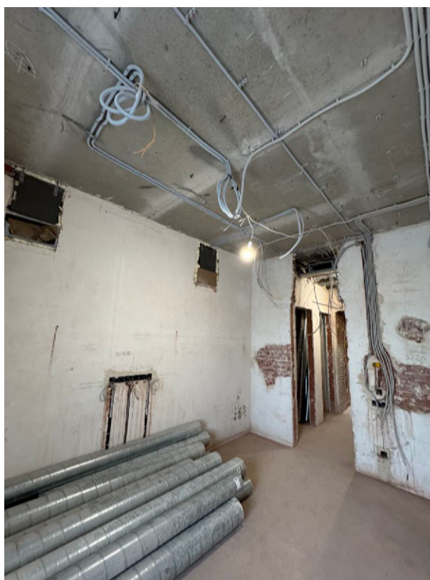
Фото 34. Общий вид на часть рассматриваемого помещения в границах объекта культурного наследия
