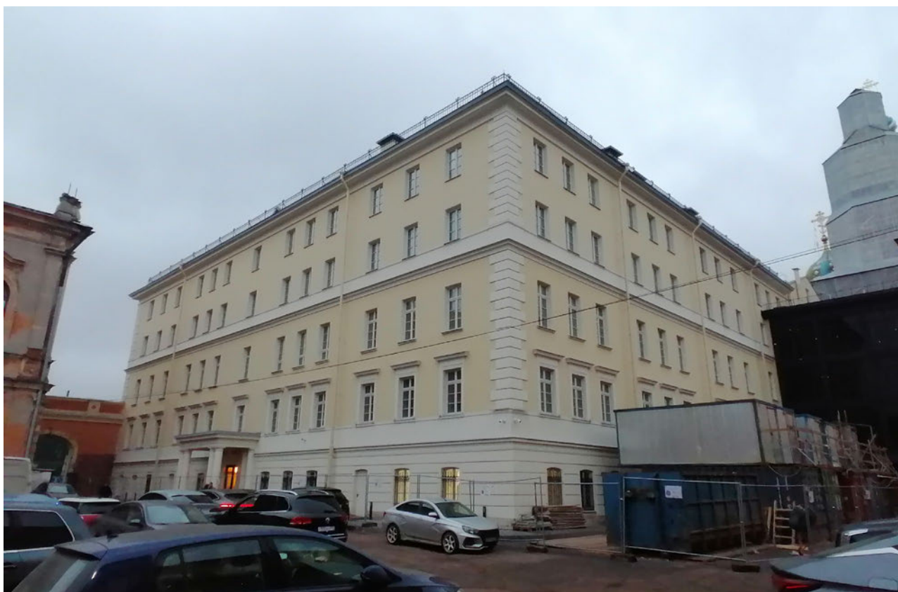
Фото 2. Общий вид объекта. Лицевой фасад со стороны двора.
