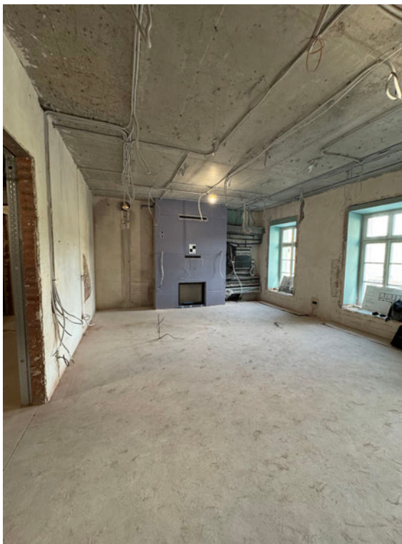
Фото 53. Общий вид на часть рассматриваемого помещения в границах объекта культурного наследия
