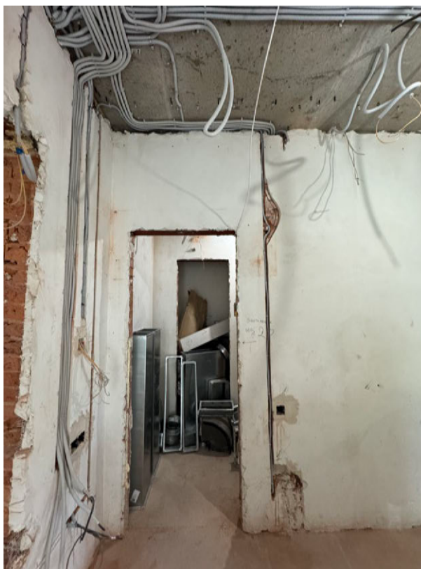
Фото 3. Общий вид на часть рассматриваемого помещения в границах объекта культурного наследия
