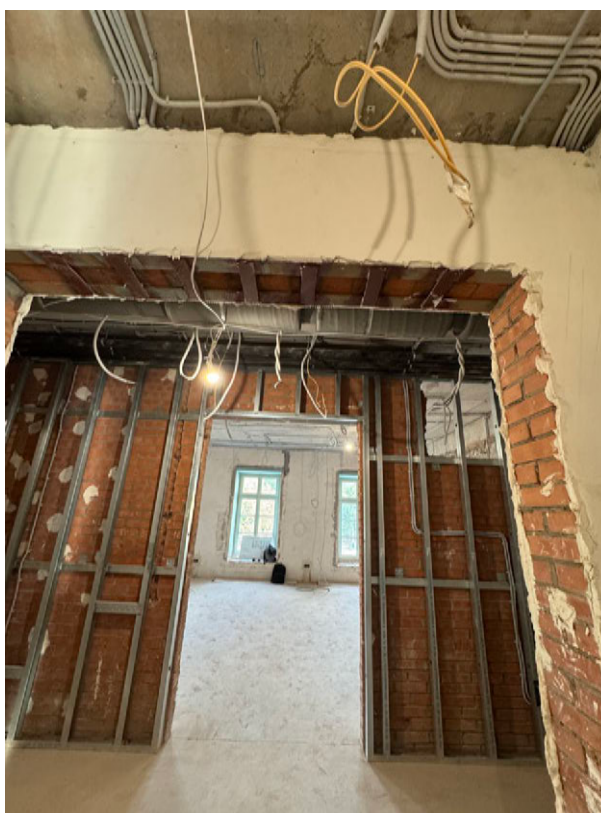
Фото 8. Общий вид на часть рассматриваемого помещения в границах объекта культурного наследия
