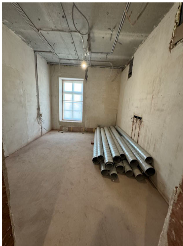
Фото 33. Общий вид на часть рассматриваемого помещения в границах объекта культурного наследия
