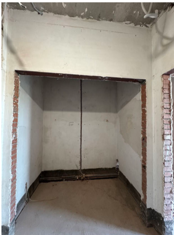
Фото 23. Общий вид на часть рассматриваемого помещения в границах объекта культурного наследия
