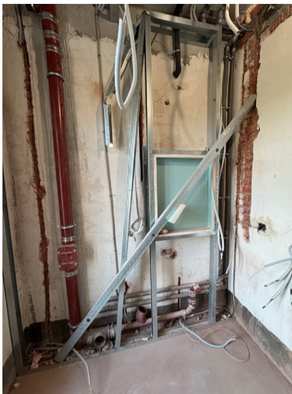
Фото 51. Общий вид на часть рассматриваемого помещения в границах объекта культурного наследия
