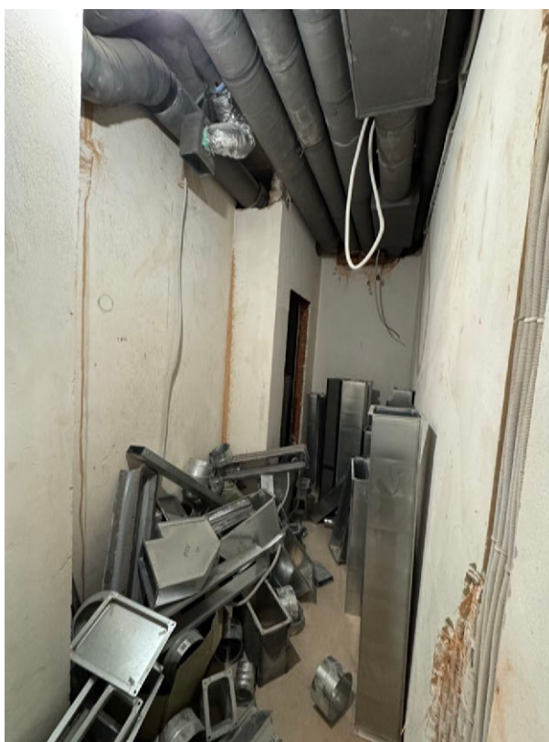
Фото 4. Общий вид на часть рассматриваемого помещения в границах объекта культурного наследия
