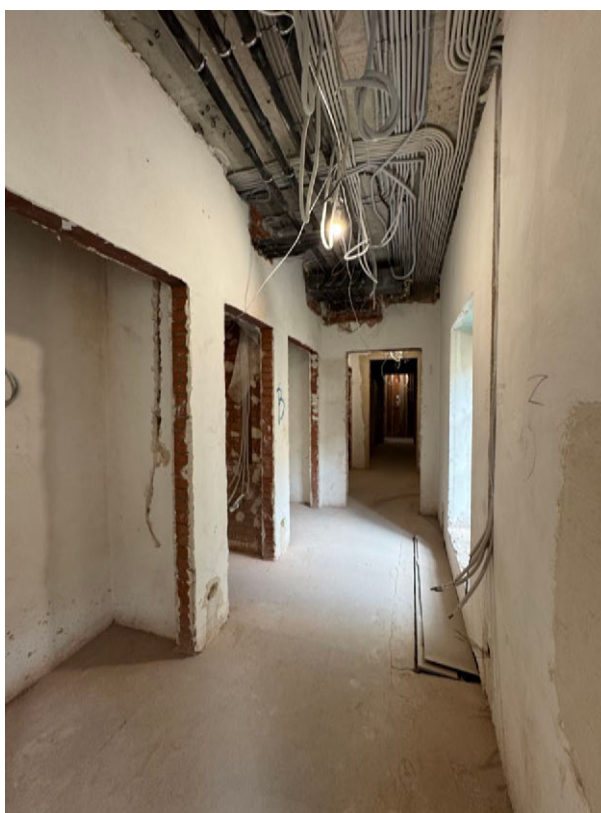
Фото 30. Общий вид на часть рассматриваемого помещения в границах объекта культурного наследия
