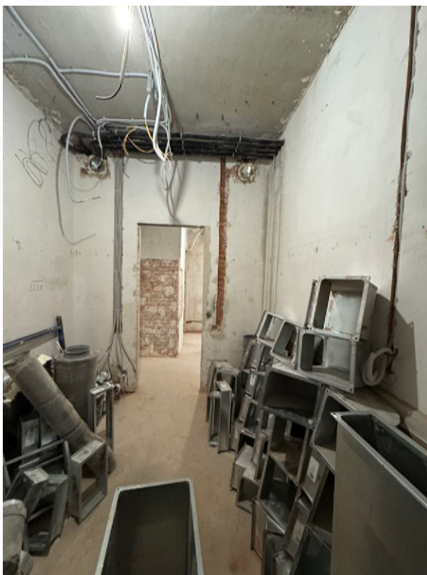
Фото 18. Общий вид на часть рассматриваемого помещения в границах объекта культурного наследия
