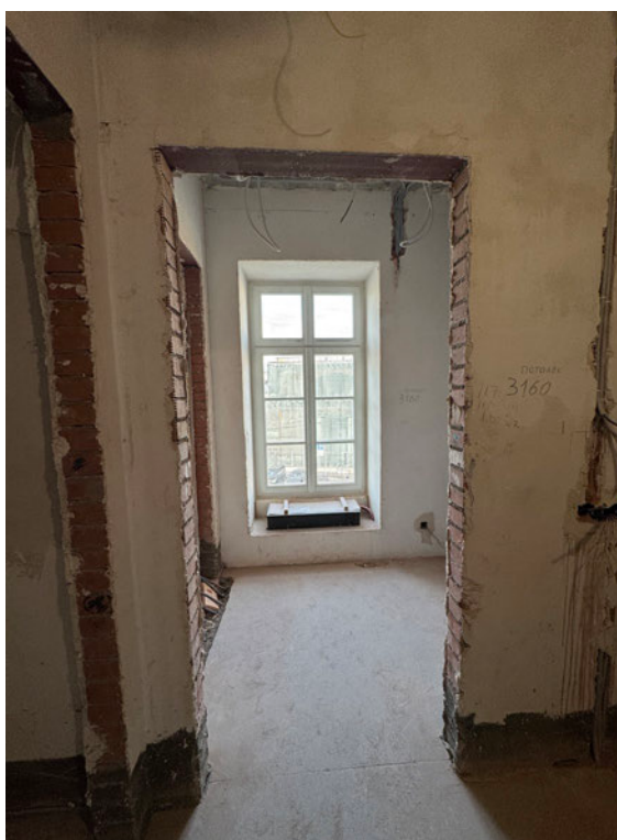
Фото 24. Общий вид на часть рассматриваемого помещения в границах объекта культурного наследия
