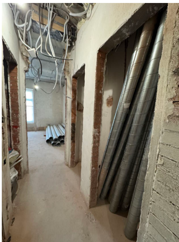
Фото 32. Общий вид на часть рассматриваемого помещения в границах объекта культурного наследия
