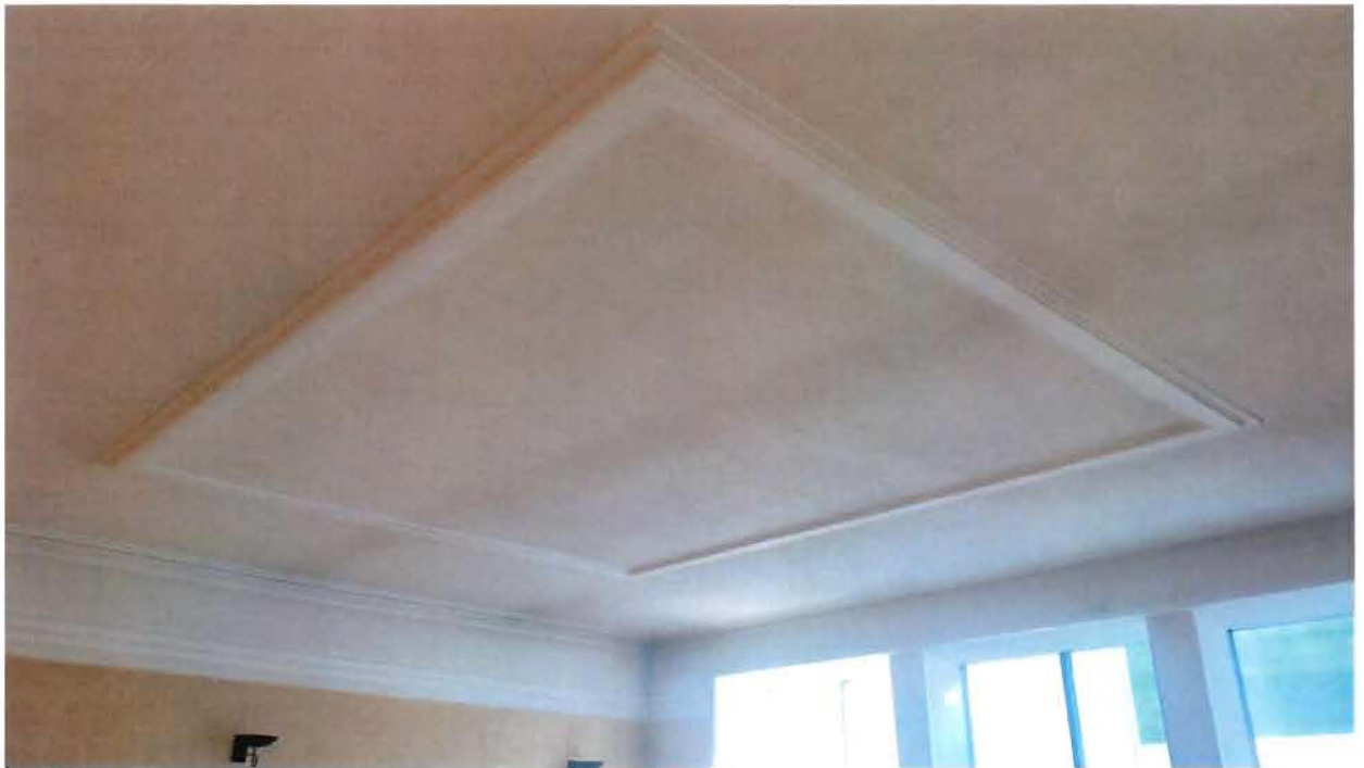
7. Профилированные тяги в оформлении потолка лестничной клетки (пом. 10-Н (67)).
