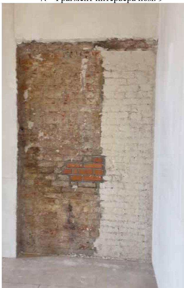
8. Фрагмент интерьера помещения 9, заложенный проем в помещение 13
