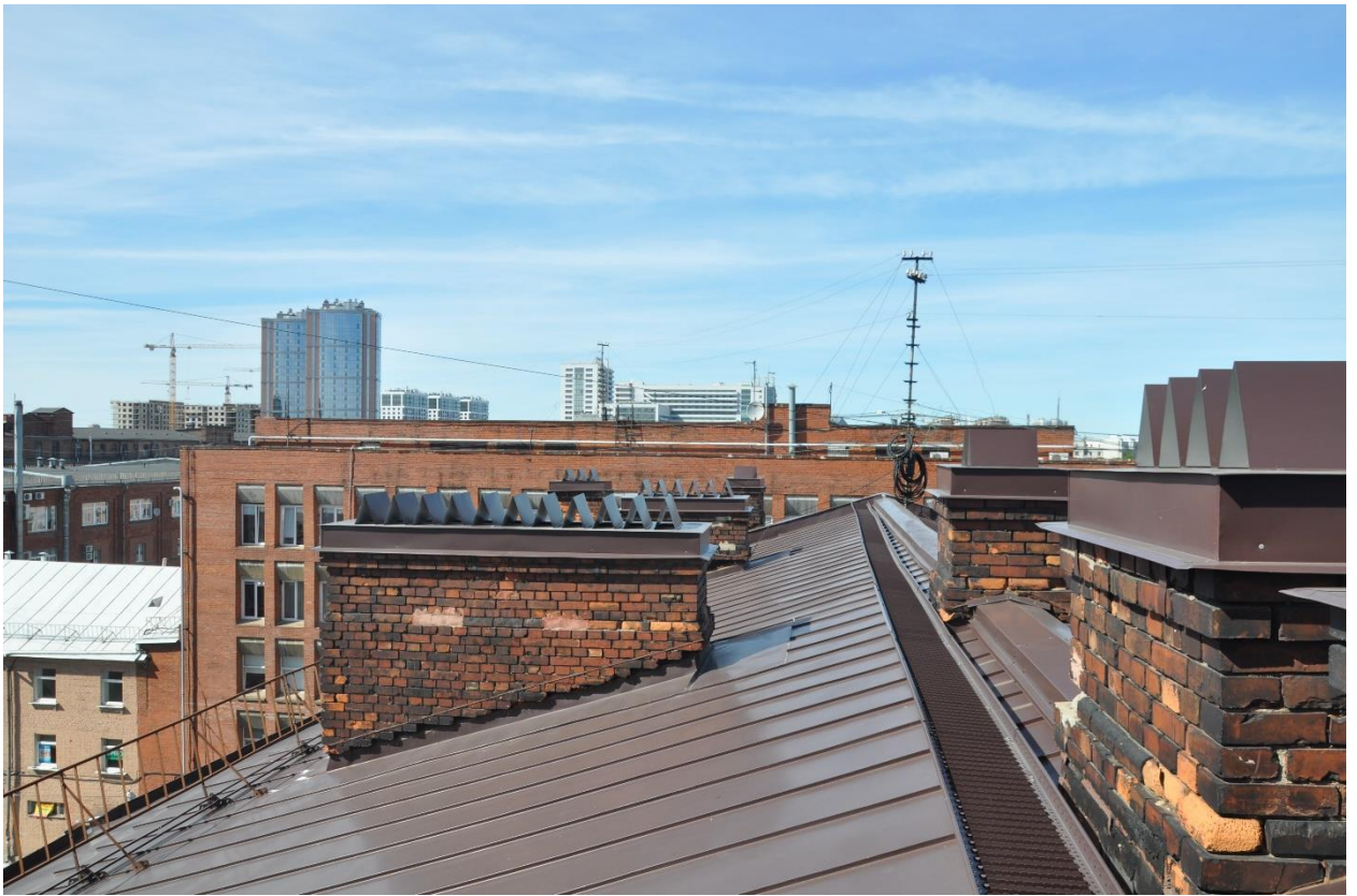
Фото 23. Вид с кровли на Заставскую улицу.
