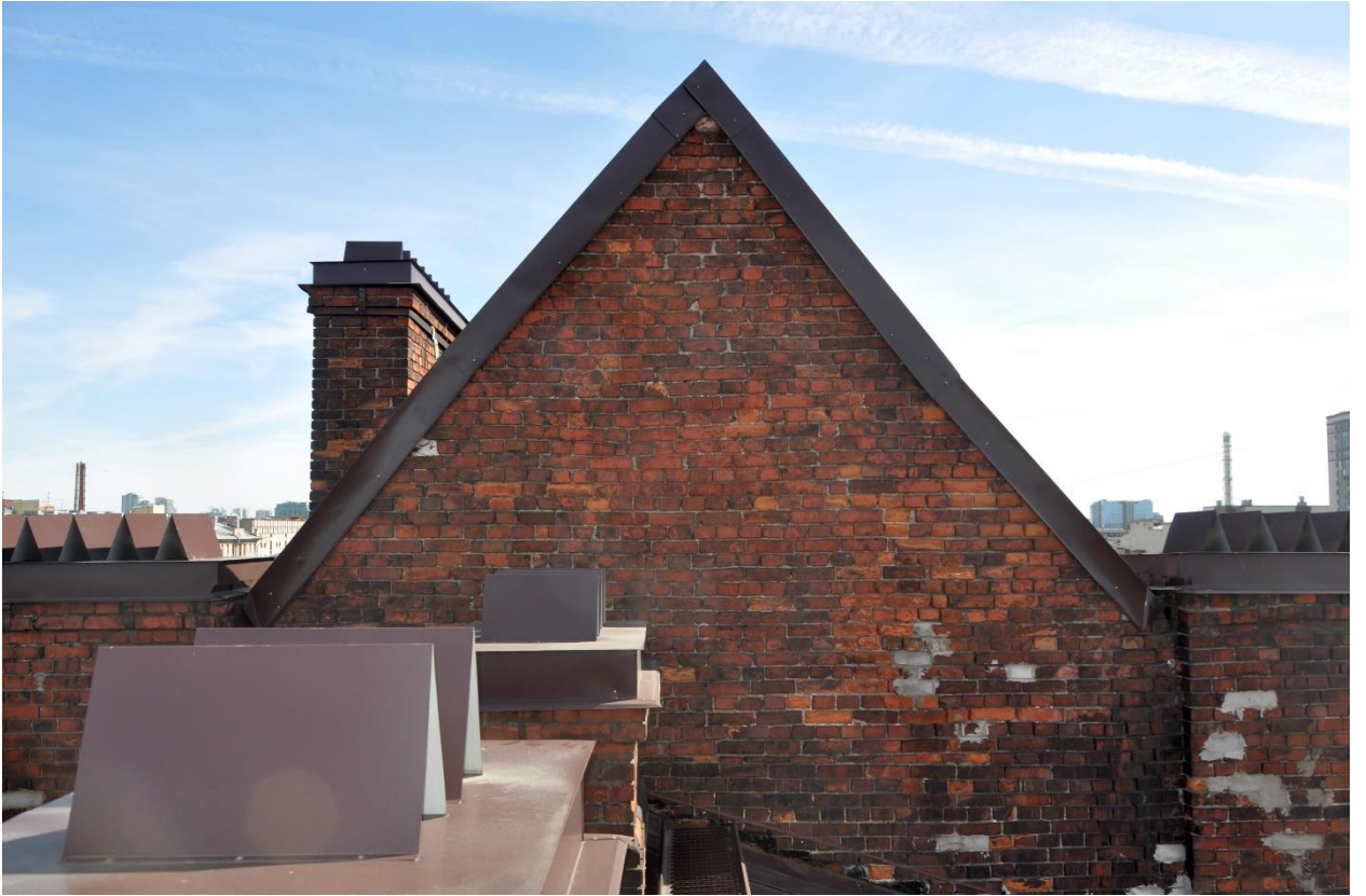
Фото 25. Вид с кровли на световой фонарь в осях «б-5».
