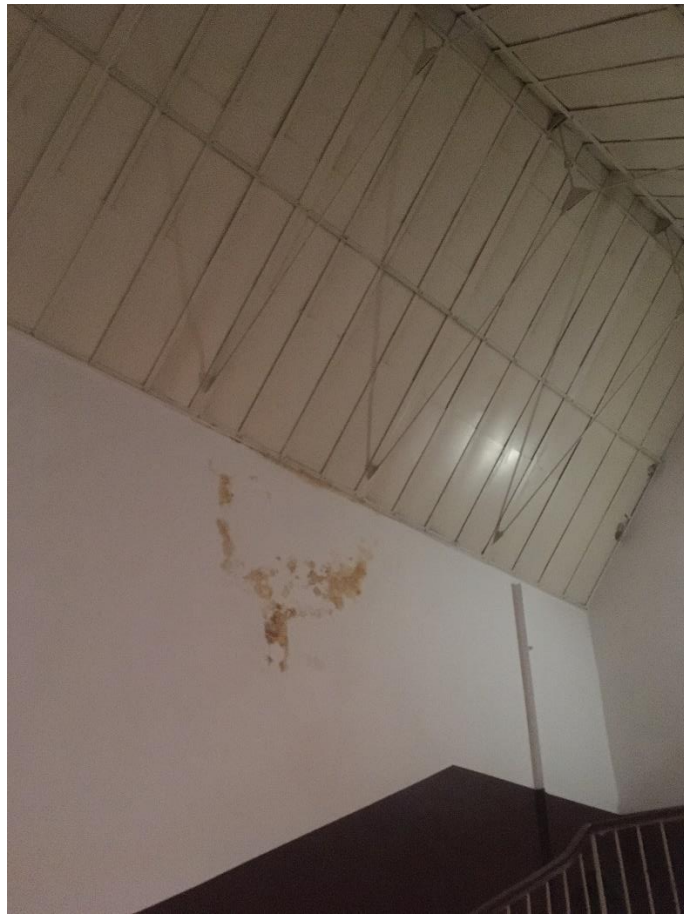
Фото 21. Световой фонарь в осях «4-3». Вид с лестницы.
