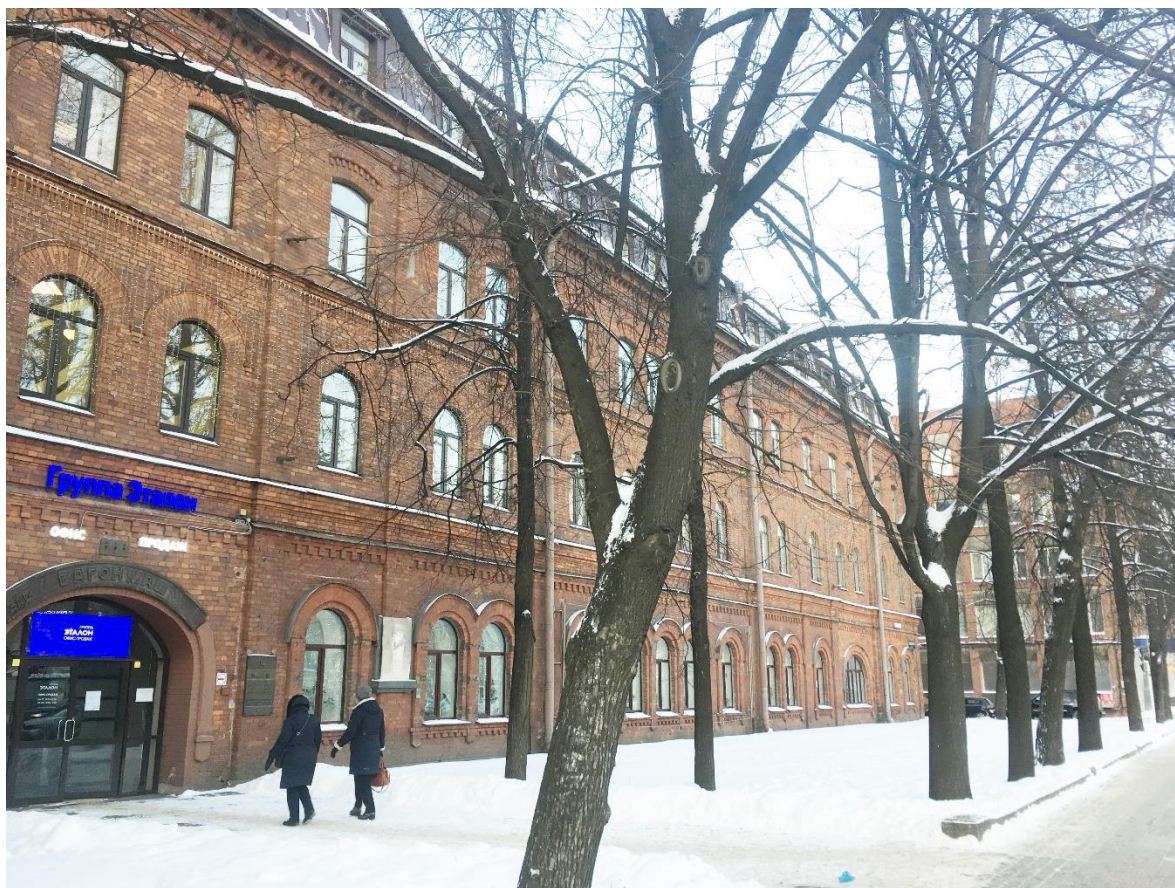
Фото 1. Лицевой фасад по Московскому проспекту. Общий вид по оси «А» в осях «2-8».
