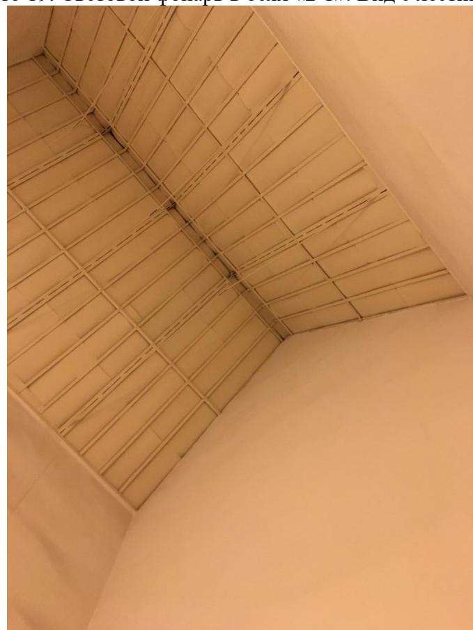
Фото 20. Световой фонарь в осях «2-1». Вид с лестницы.
