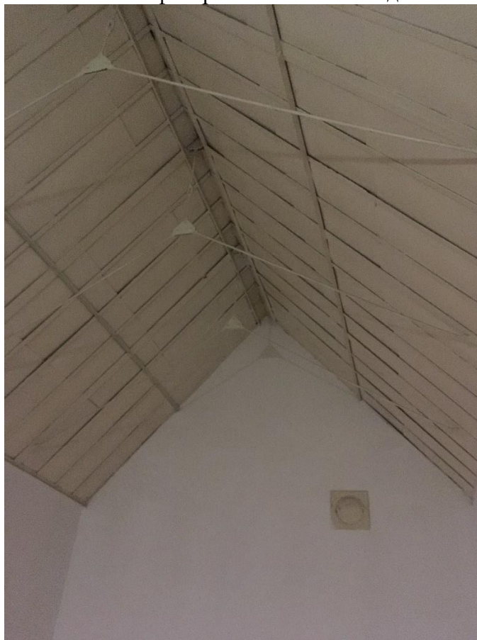
Фото 22. Световой фонарь в осях «4-3». Вид с лестницы.
