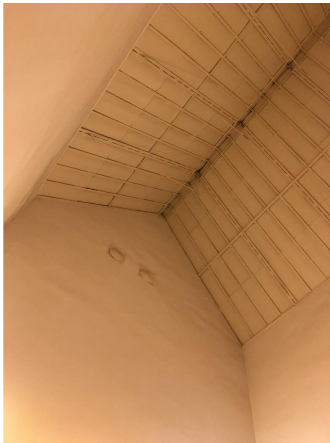
Фото 19. Световой фонарь в осях «2-1». Вид с лестницы.
