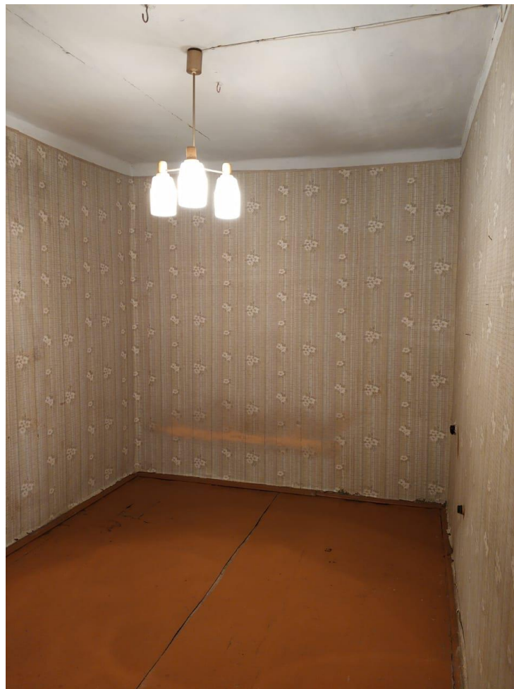
Фото 8. Помещение без окна (пом.4). Вид со стороны дверного проема.
