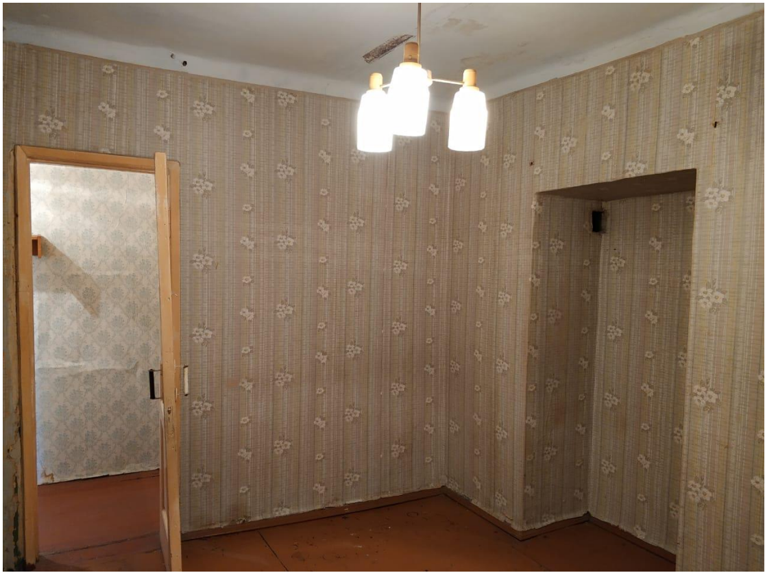
Фото 7. Помещение без окна (пом.4). Вид на нишу.
