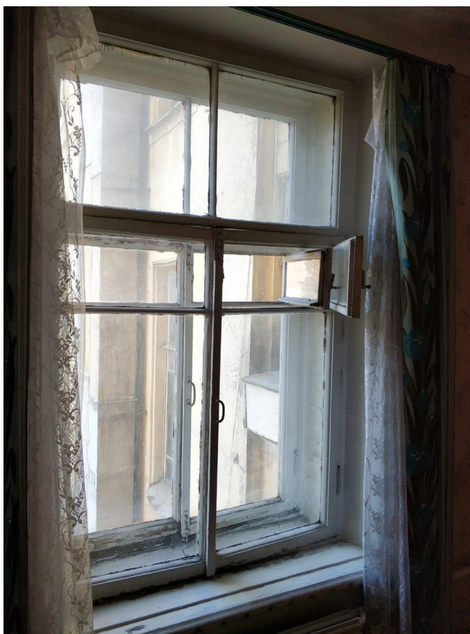
Фото 14. Окно жилой комнаты (пом.5)
