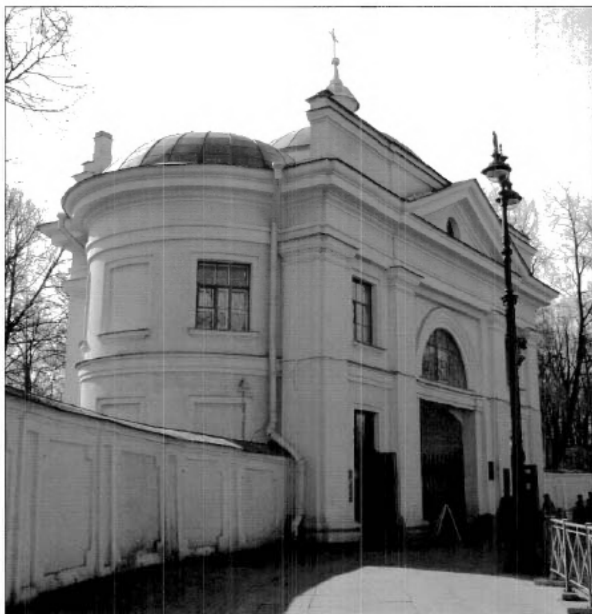
1. Общий вид с севера.
