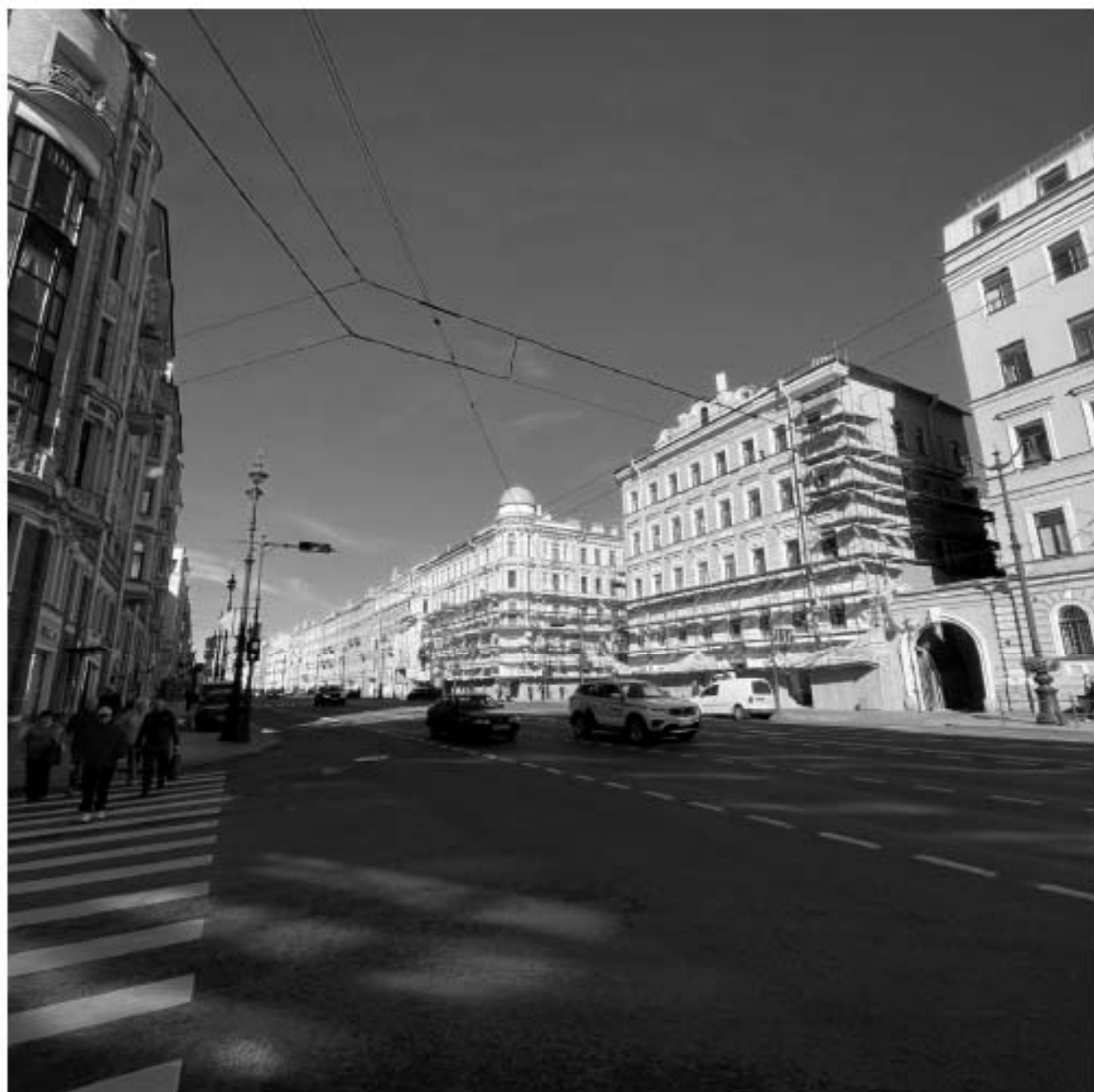
32. Вид вдоль трассы Невского пр. Фото: 24.09.2025.
