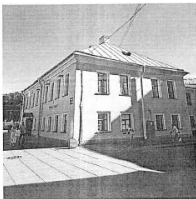
2. Общий вид лицевого фасада
