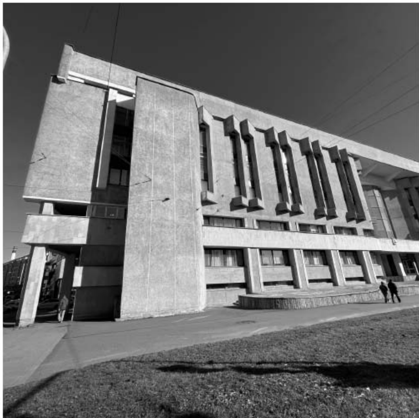
43. Окончание трассы у углового здания по Херсонской ул./Херсонский проезд, 2. Фото: 24.09.2025.
