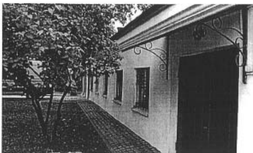
Фрагмент западного фасада
