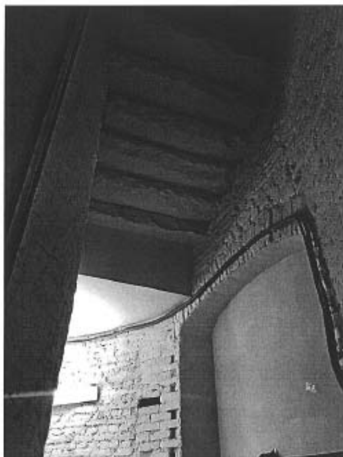
Фрагмент интерьеров. Помещение под лестницей
