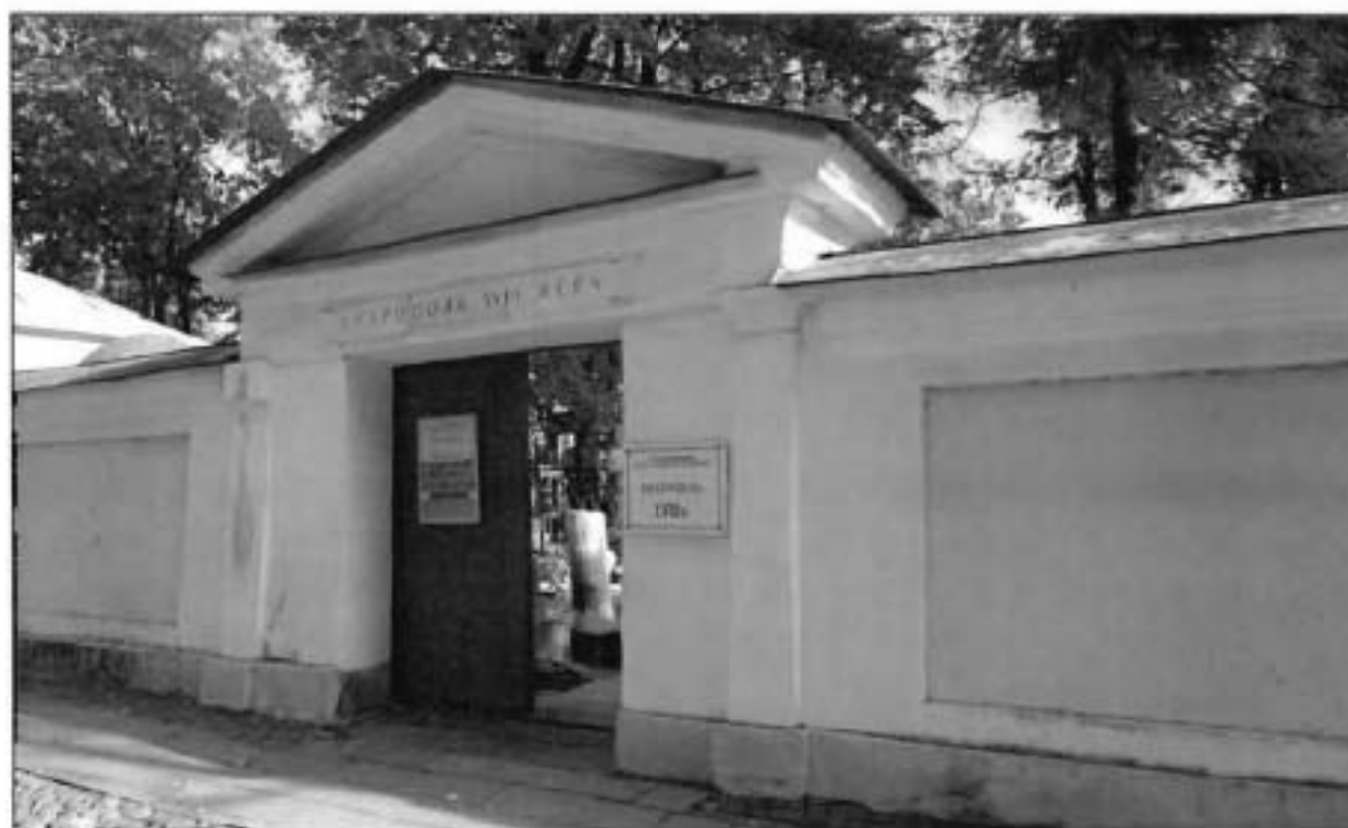
2. Западная часть ограды. Портал входа на Лазаревское кладбище. Вид с юга.
