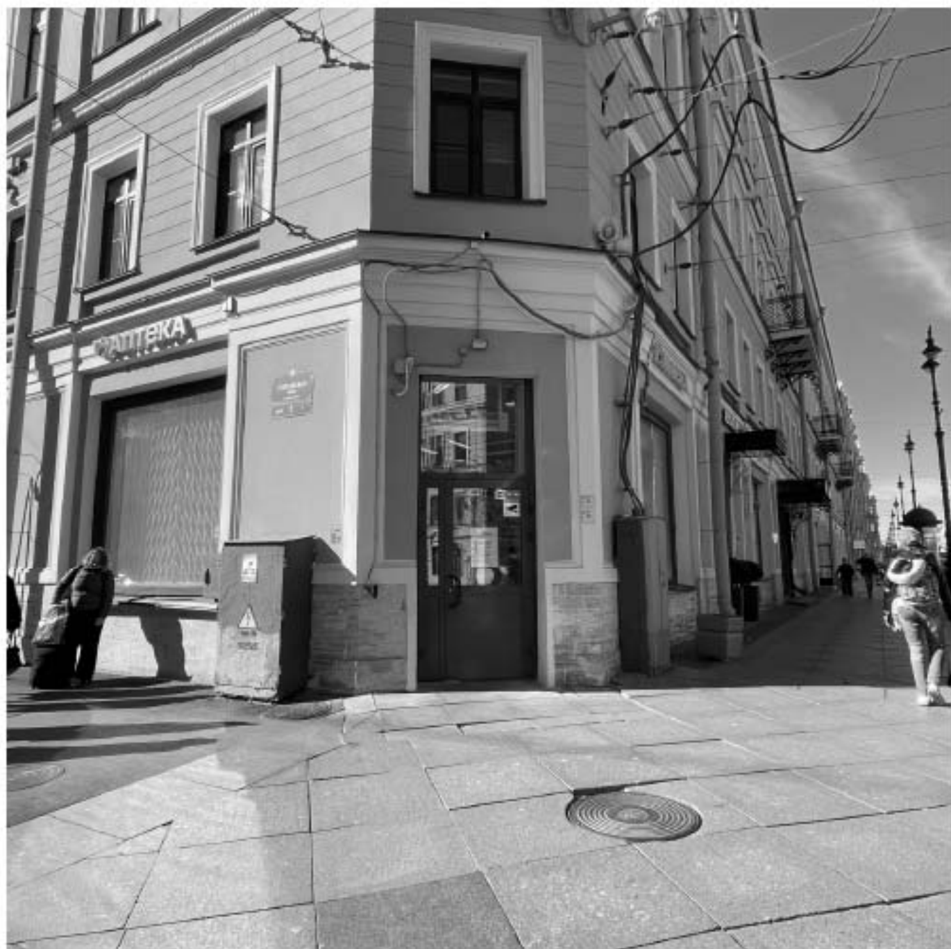
53. Конец трассы на доме по Полтавской ул.,3. Фото: 24.09.2025.
