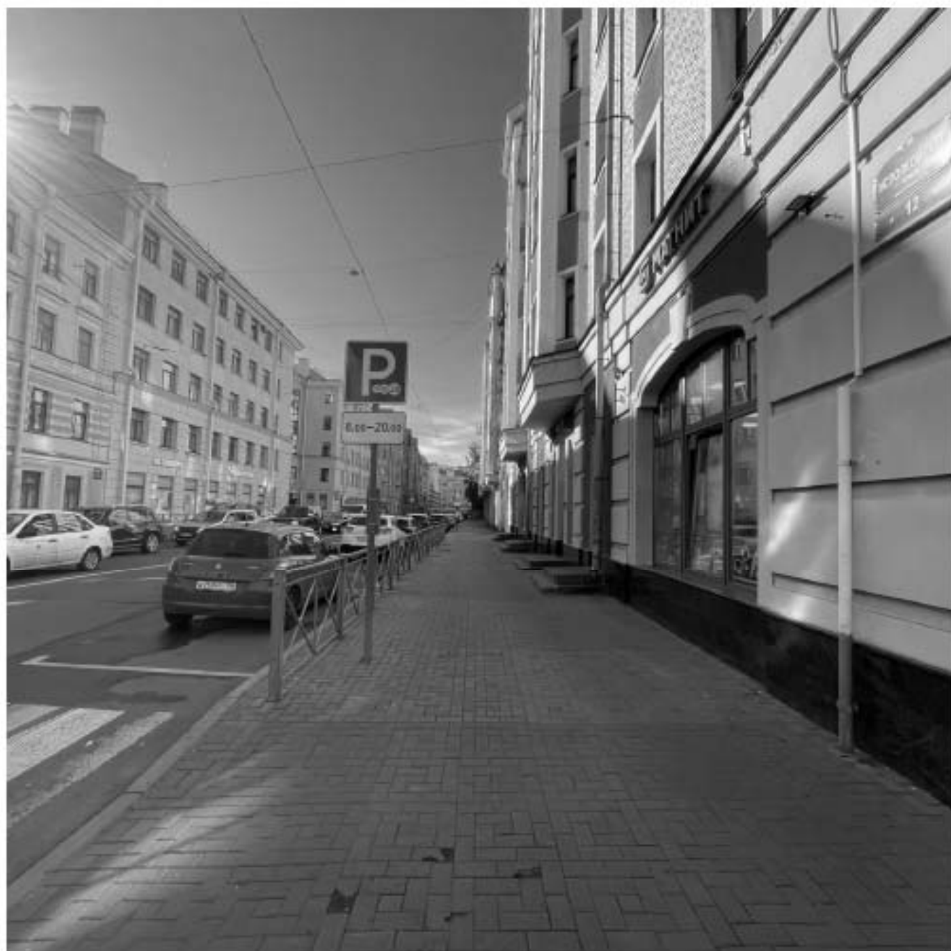
40. Вид вдоль трассы Исполкомской ул Фото: 24.09.2025.
