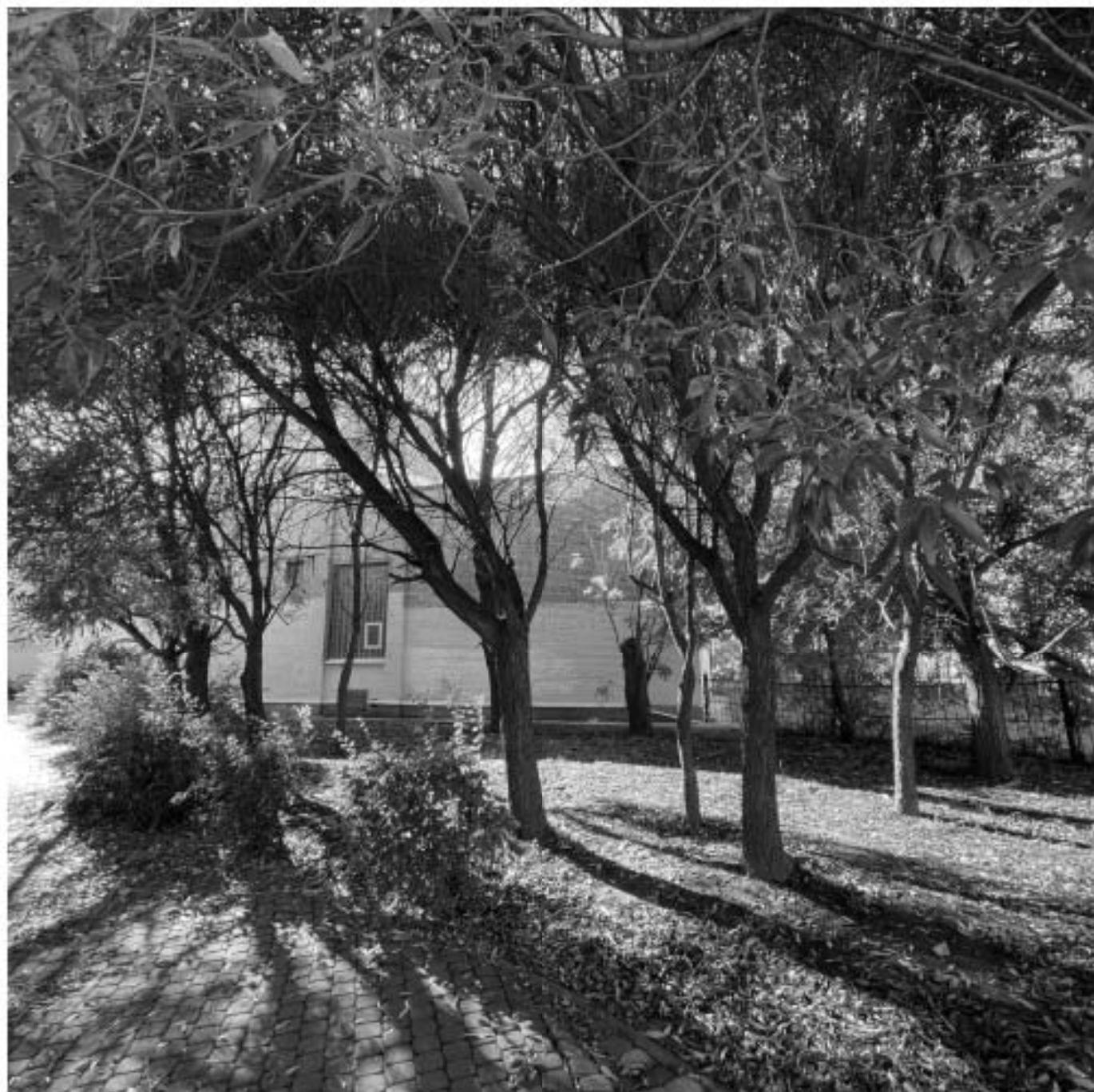
23. Вид на подстанцию №70. Фото: 24.09.2025.
