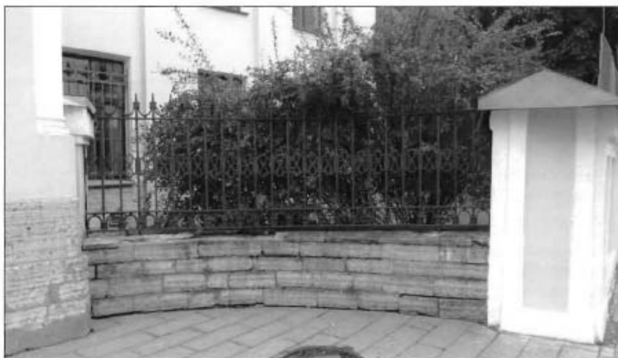
3. Объект культурного наследия. Южная часть ограды. Вид с севера.
