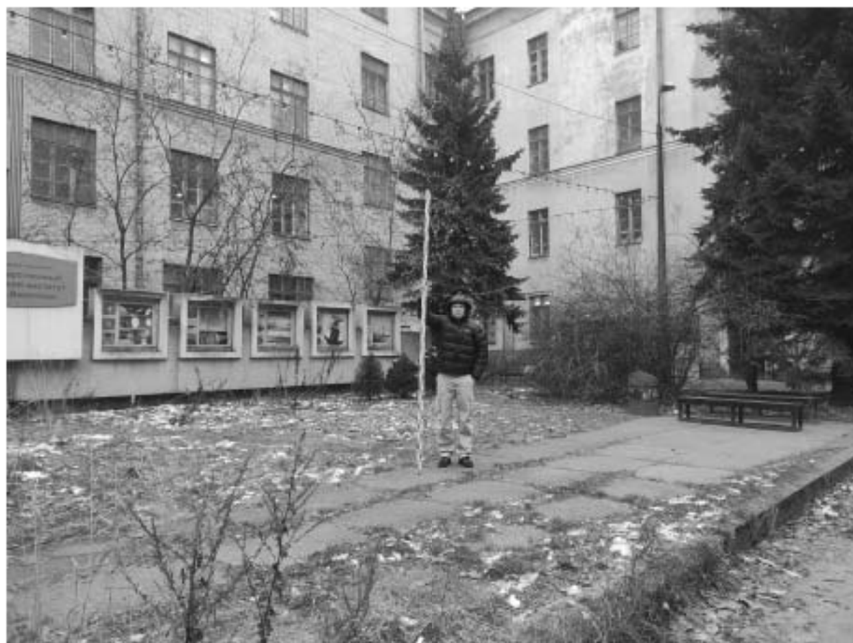
Рис. 23 Ущерб № 0650006304 Санкт-Петербург Курортная ВО. Состояние на момент сдачи работы. Даты съемки: 28.11.2025 г.
