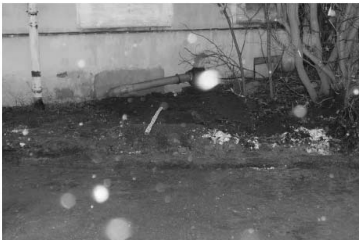
Рис. 35. Кадетская линия д. 5. корп. 2. Разведочный шурф после засыпки, вид с севера. Для масштаба использована нивелировочная рейка длиной 2 м
