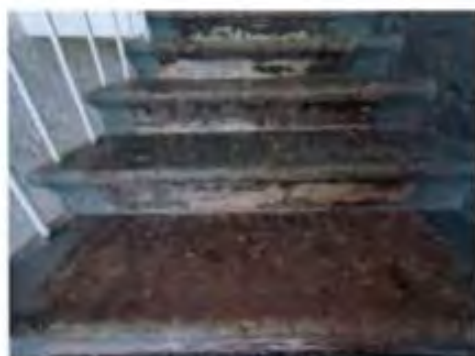
36. Ступени 2-ЛК. Сколы, трещины. (25.09.2023)
