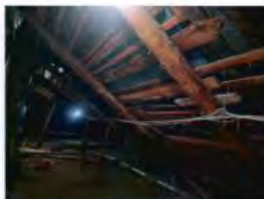
13. Фрагмент стропильной системы. Подпорки под стропилами. (25.09.2023)
