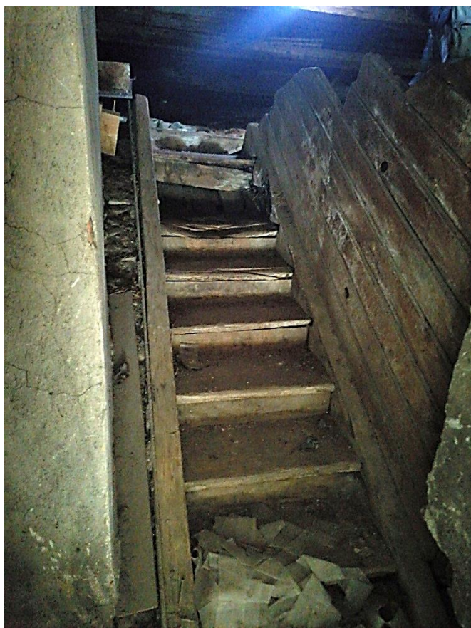
Илл.32. Деревянная лестница на чердак в части здания со стороны Полуостровского проспекта. 05.07.2021г.
