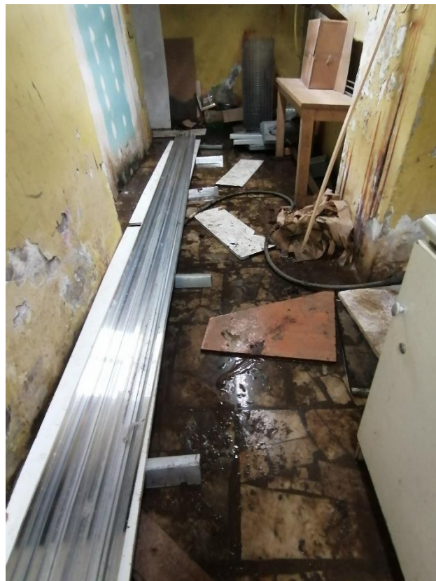
Илл.54. Подвал. Коридор (помещение №14) в части здания со стороны Кондратьевского проспекта. 05.07.2021г.
