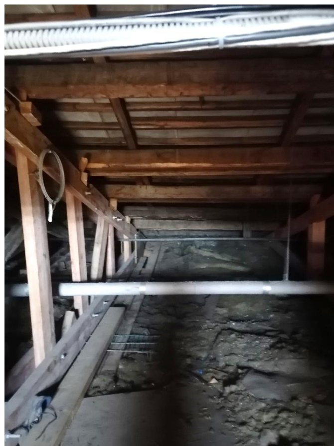
Илл.37. Фрагмент деревянных ферм чердачных перекрытий. 05.07.2021г.
