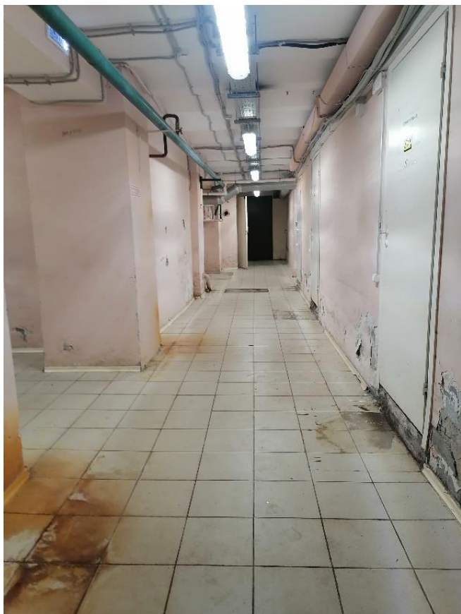
Илл.42. Подвал. Коридор (помещение №2) в части здания со стороны Полюстровского проспекта. 05.07.2021г.
