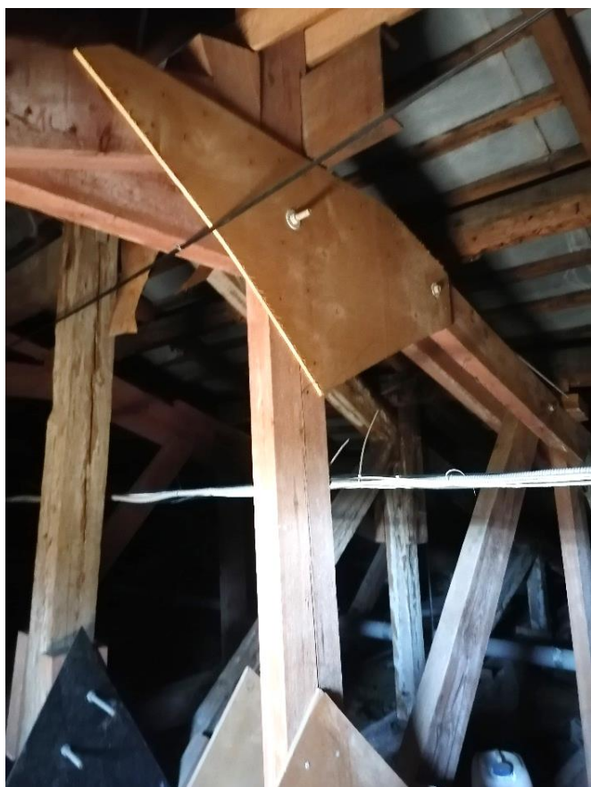
Илл.36. Фрагмент деревянных ферм чердачных перекрытий. 05.07.2021г.
