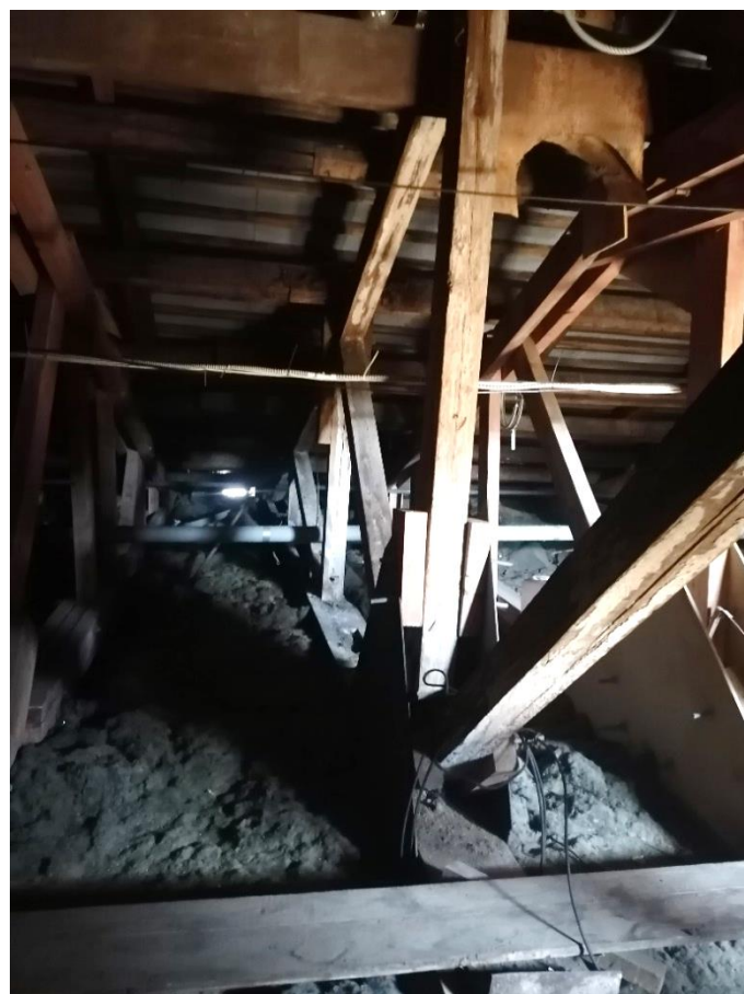
Илл.39. Фрагмент деревянных ферм чердачных перекрытий. 05.07.2021г.
