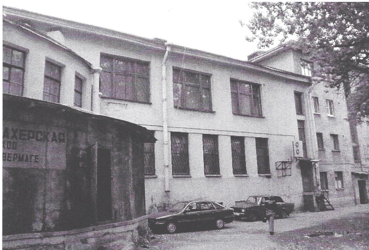
Илл.46. Дворовый фасад здания Калининского универмага. Техническое заключение по обследованию конструкций здания» 2005г. ООО «Воплощение».
