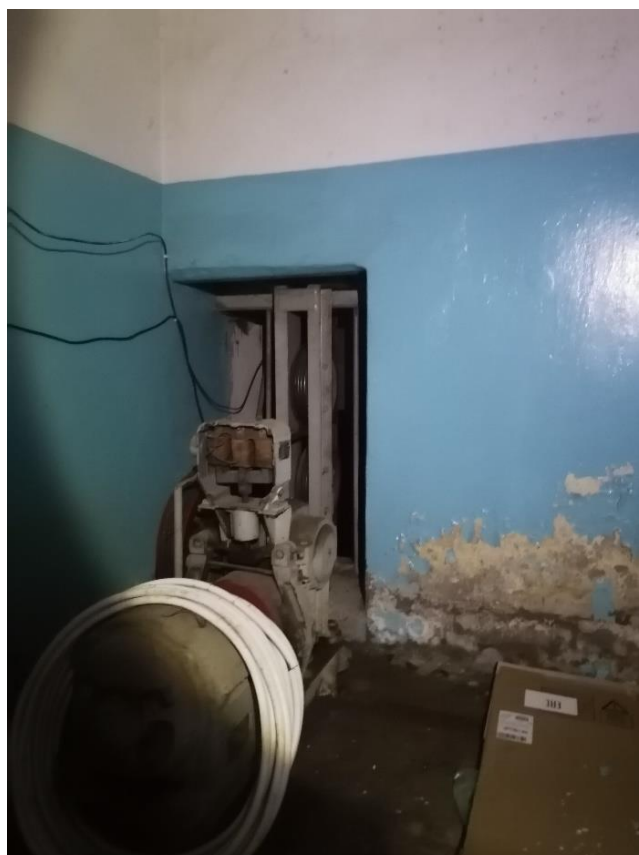
Илл.51. Подвал. Помещение №21 в части здания со стороны Кондратьевского проспекта. 05.07.2021г.
