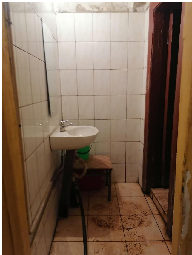
Илл.52. Подвал. Санузел. Помещение №31. 05.07.2021г.
