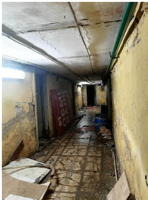
Илл.55. Подвал в жилое здание, примыкающее к зданию Калининского универмага со стороны Кондратьевского проспекта. 05.07.2021г.
