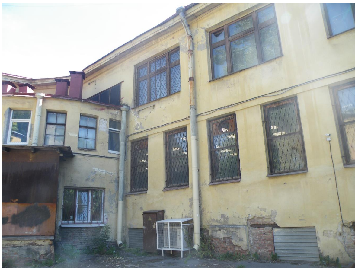
Илл.8.1. Дворовый фасад здания Калининского универмага. 05.07.2021г.
