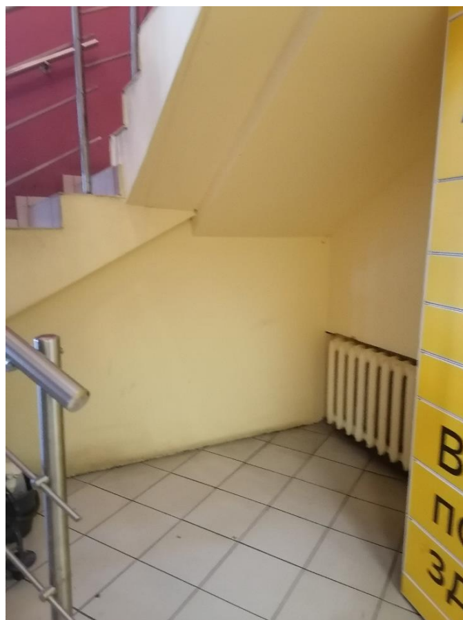
Илл.16. Подлестничное пространство (помещение №7). 05.07.2021г.
