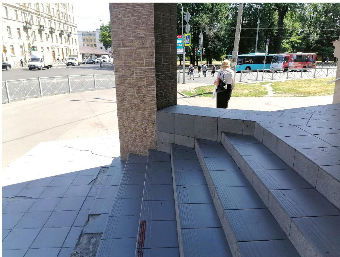
Илл.5. Крыльцо у центрального входа здания Калининского универмага. 05.07.2021г.
