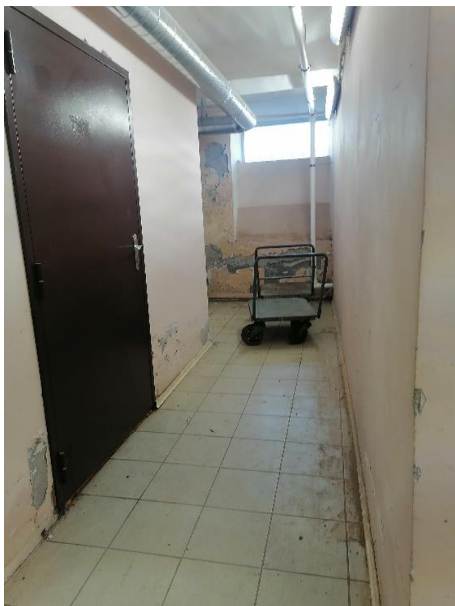
Илл.43. Подвал. Помещение №6 в части здания со стороны Полюстровского проспекта. 05.07.2021г.
