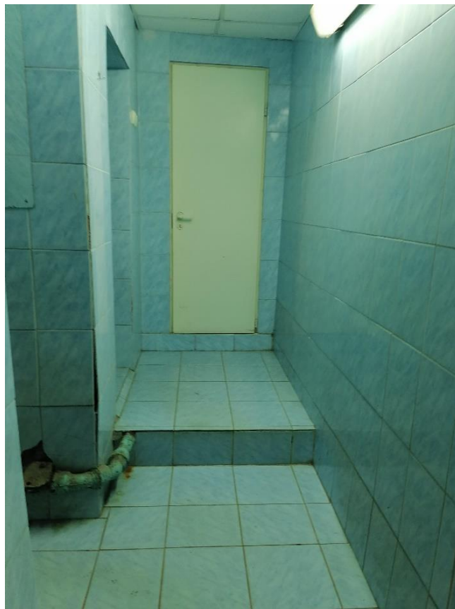
Илл.41. Подвал. Санузел. Помещение №39 рядом с входным коридором. 05.07.2021г.
