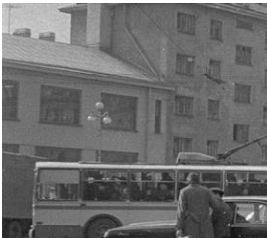
Илл.41.1. Фрагмент Калининского универмага с уже новой столяркой (витринные окна) без расстекловки. Пожар в к/т "Гигант". 1975 г. Источник: Из архива Владимира Фиглева. http://pastvu.com/1366437 .
