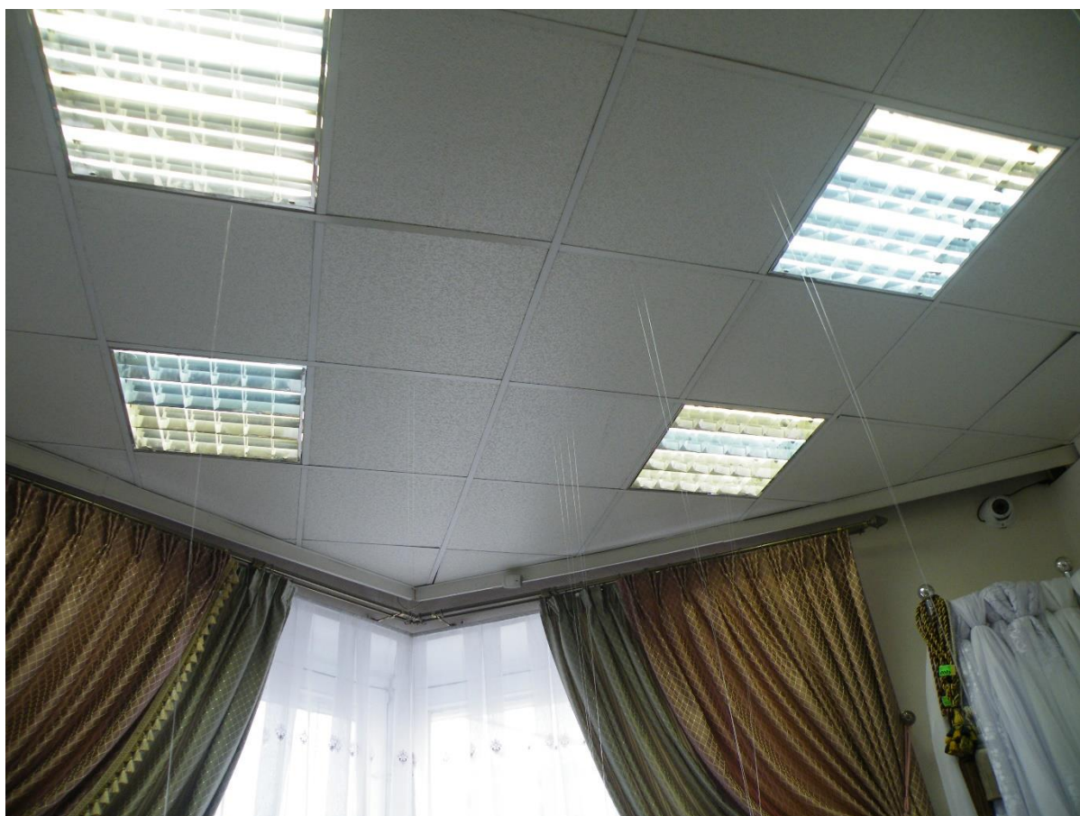
Илл.23. 2-ой этаж. Угловая часть помещения №5. Фрагмент. 05.07.2021г.
