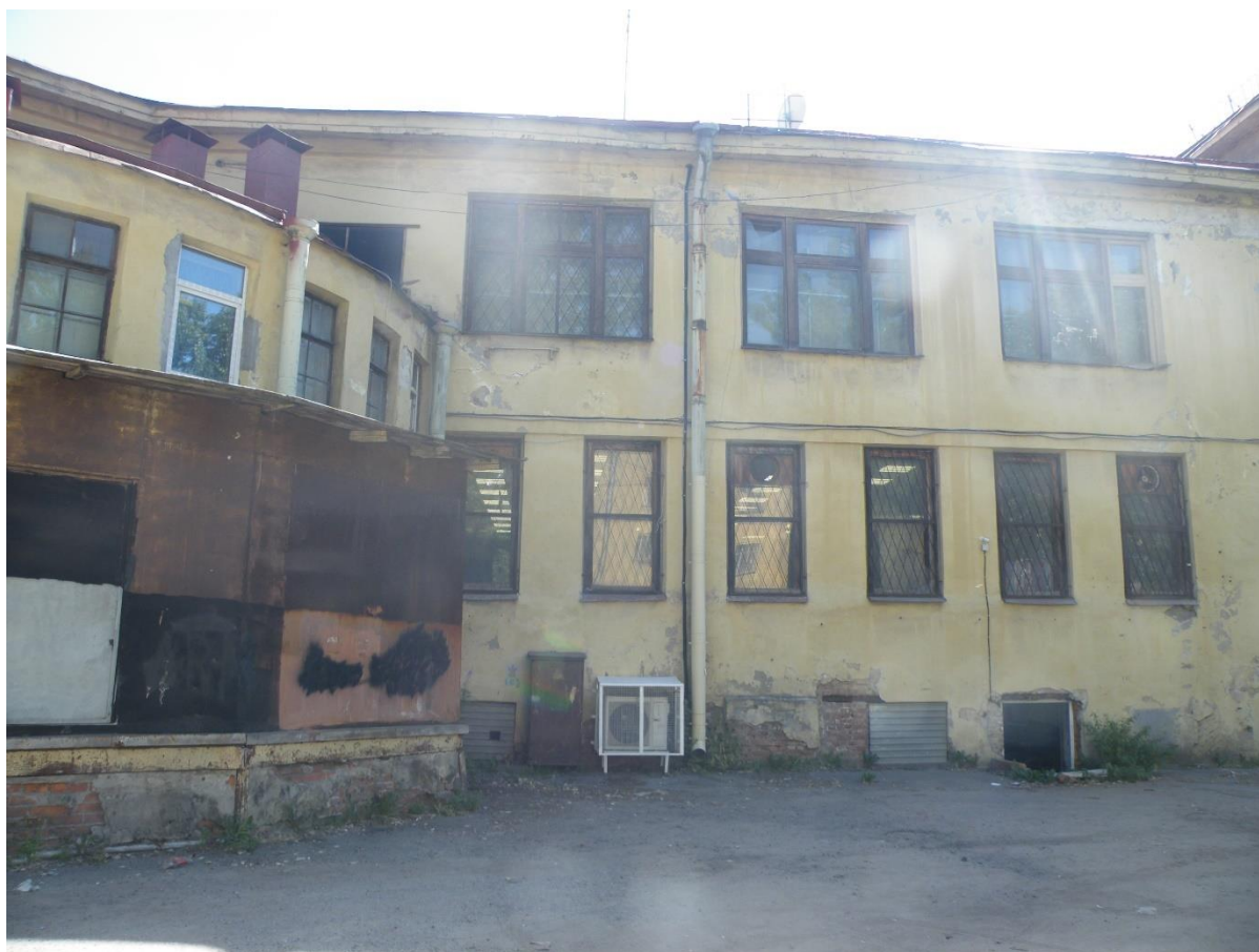
Илл.8. Дворовый фасад здания Калининского универмага. 05.07.2021г.
