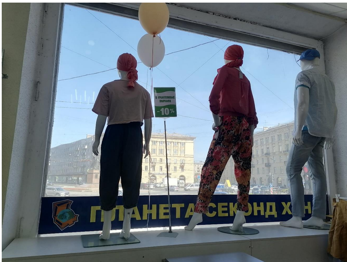
Илл.20. Оконный проем торгового зала (помещение 13) на 1-ом этаже. 05.07.2021г.
