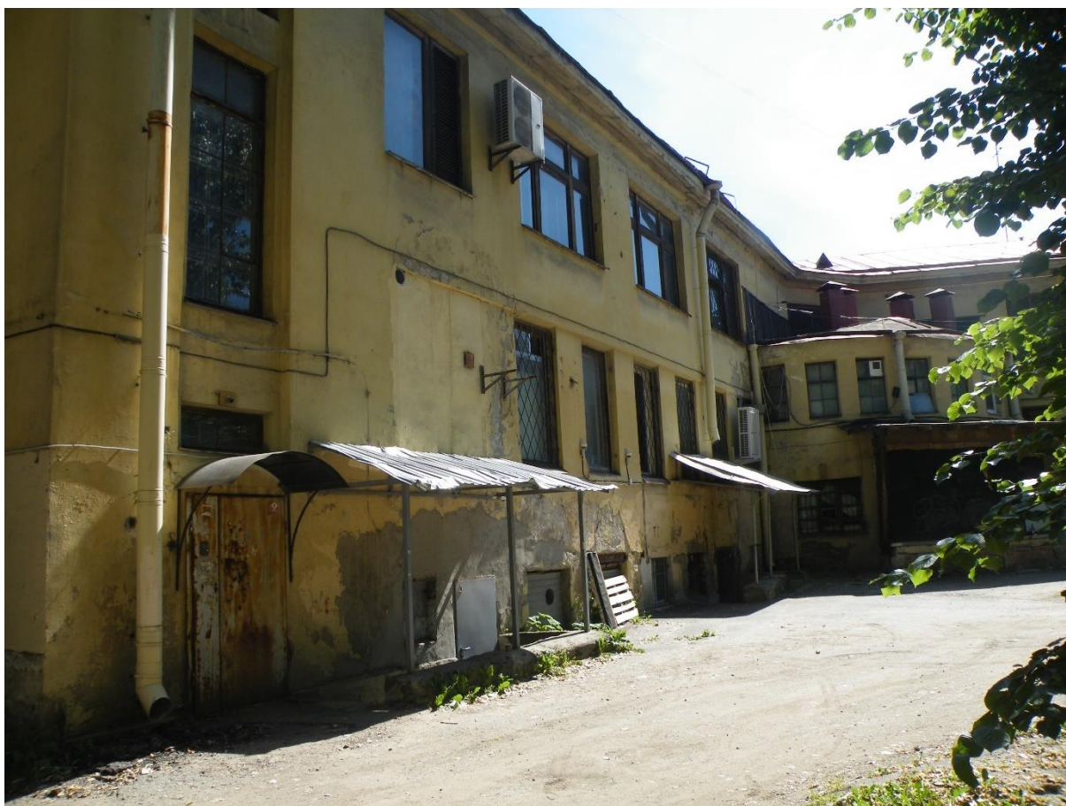
Илл.7. Дворовый фасад здания Калининского универмага. 05.07.2021г.
