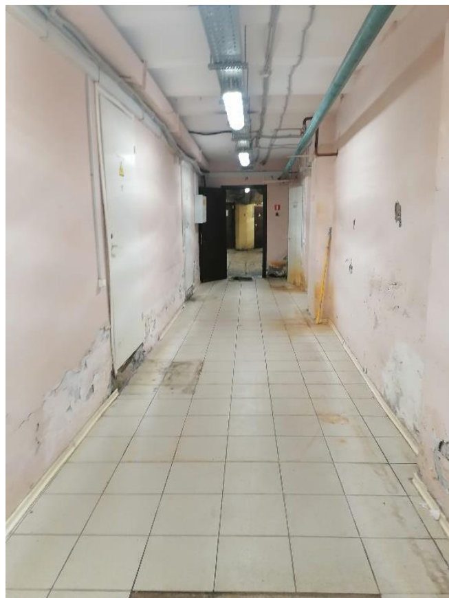
Илл.42.1. Подвал. Коридор (помещение №2) в части здания со стороны Полюстровского проспекта. 05.07.2021г.
