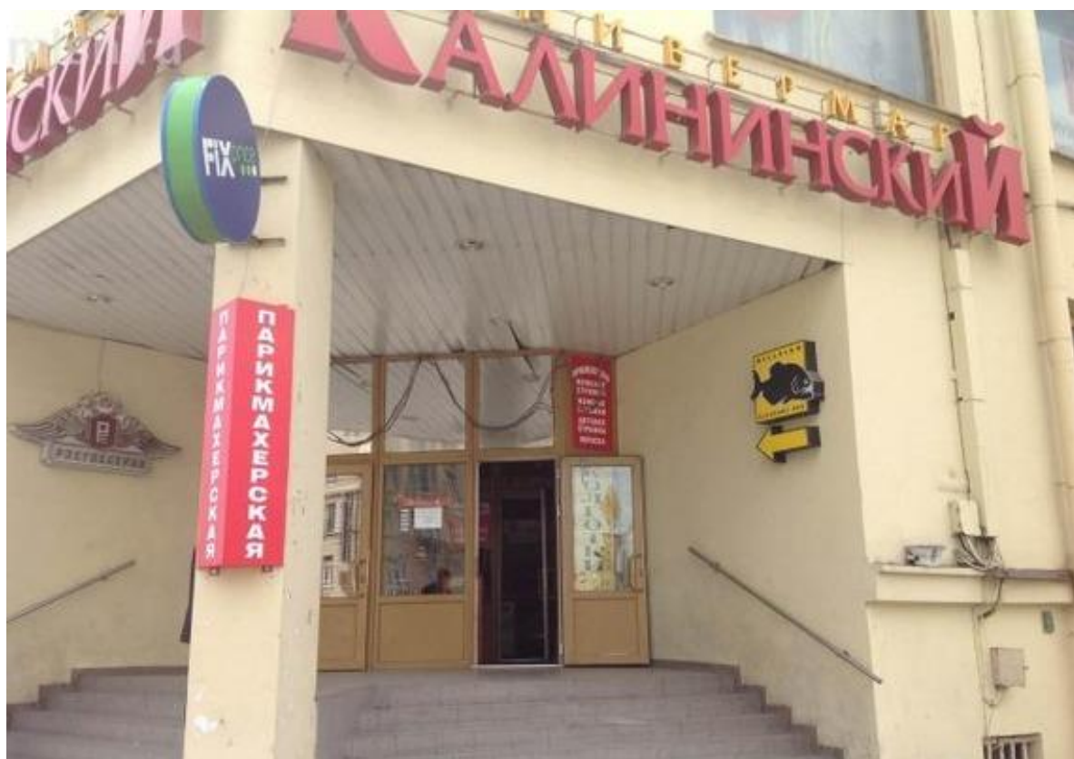
Илл.47. Вход в Калининский универмаг. Центральный пилон оштукатурен и не облицован плиткой. Период с 2013 по 2015гг.
