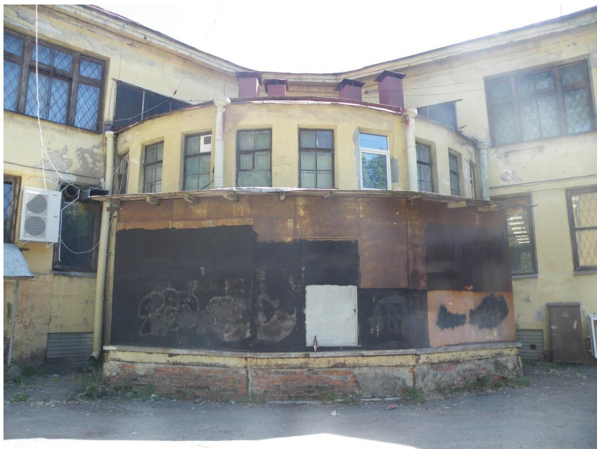
Илл.7.1. Дворовый фасад здания Калининского универмага. 05.07.2021г.
