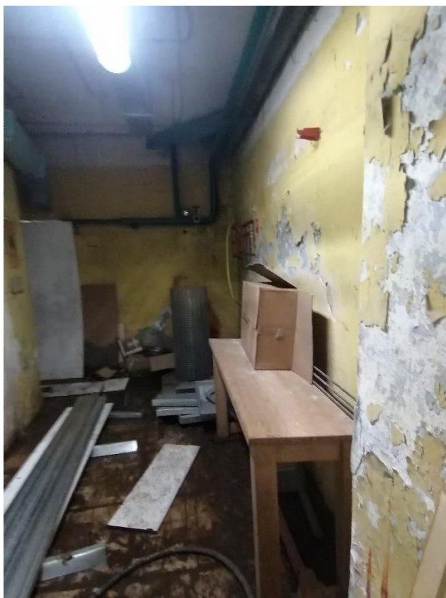
Илл.54.1. Подвал. Коридор (помещение №14) в части здания со стороны Кондратьевского проспекта. 05.07.2021г.
