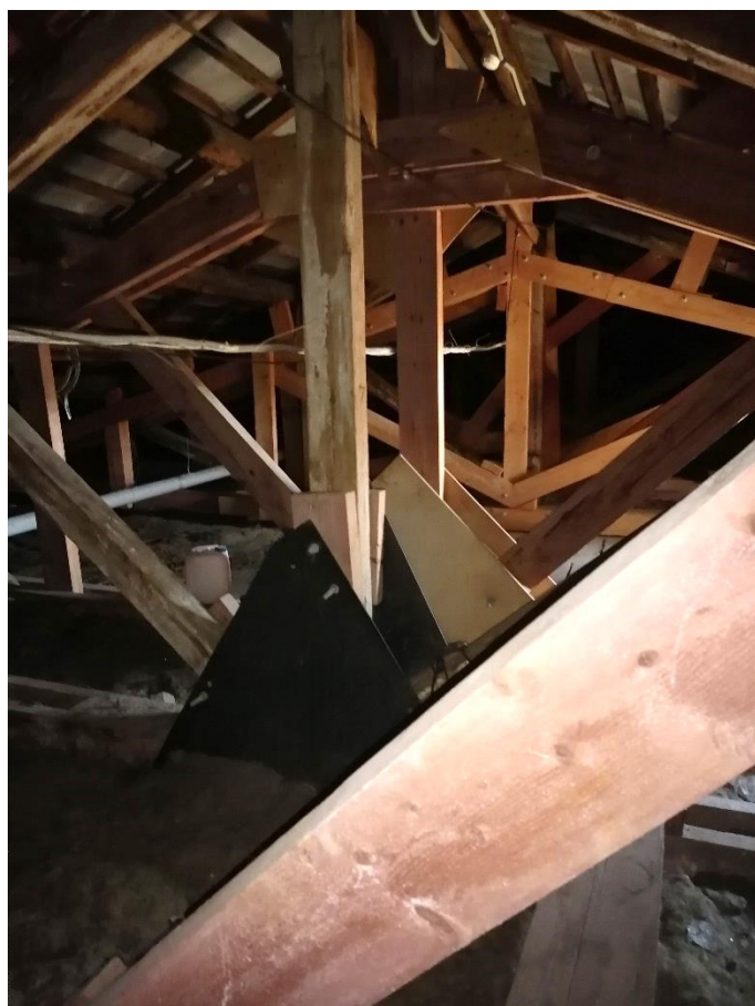
Илл.38. Фрагмент деревянных ферм чердачных перекрытий. 05.07.2021г.
