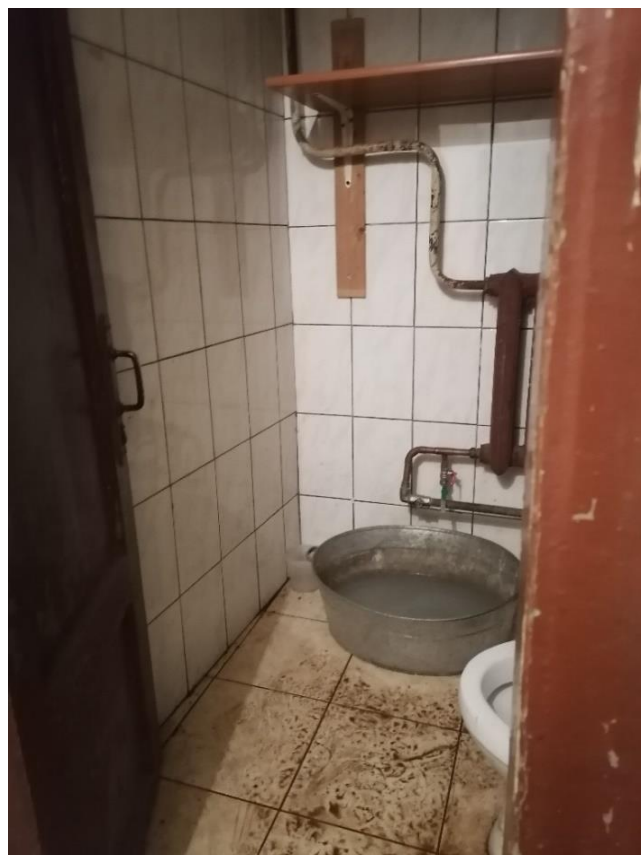
Илл.52.1. Санузел. Помещение №31. 05.07.2021г.
