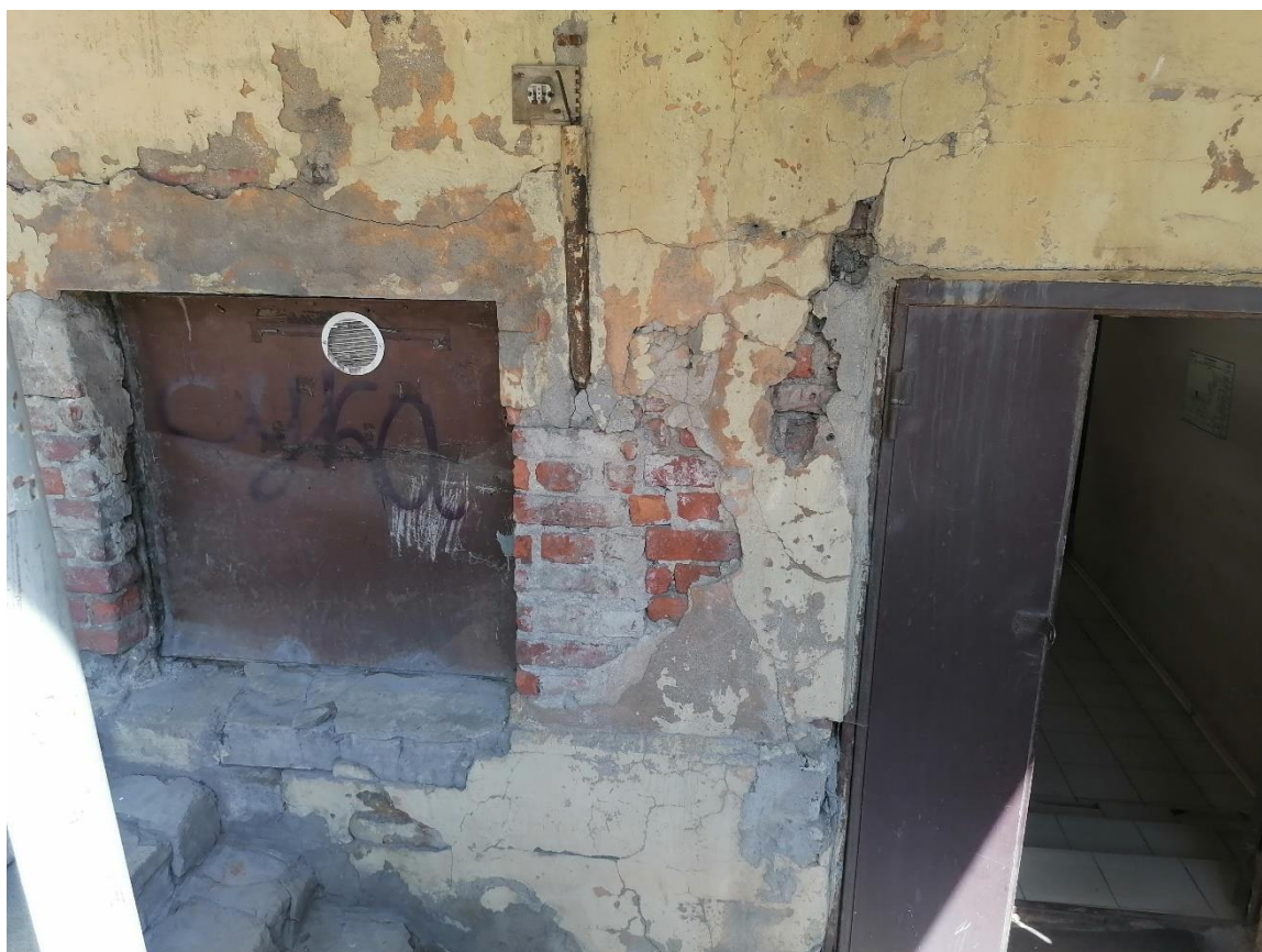
Илл.9. Прямок со стороны дворового фасада. Основной вход в подвал. 05.07.2021г.
