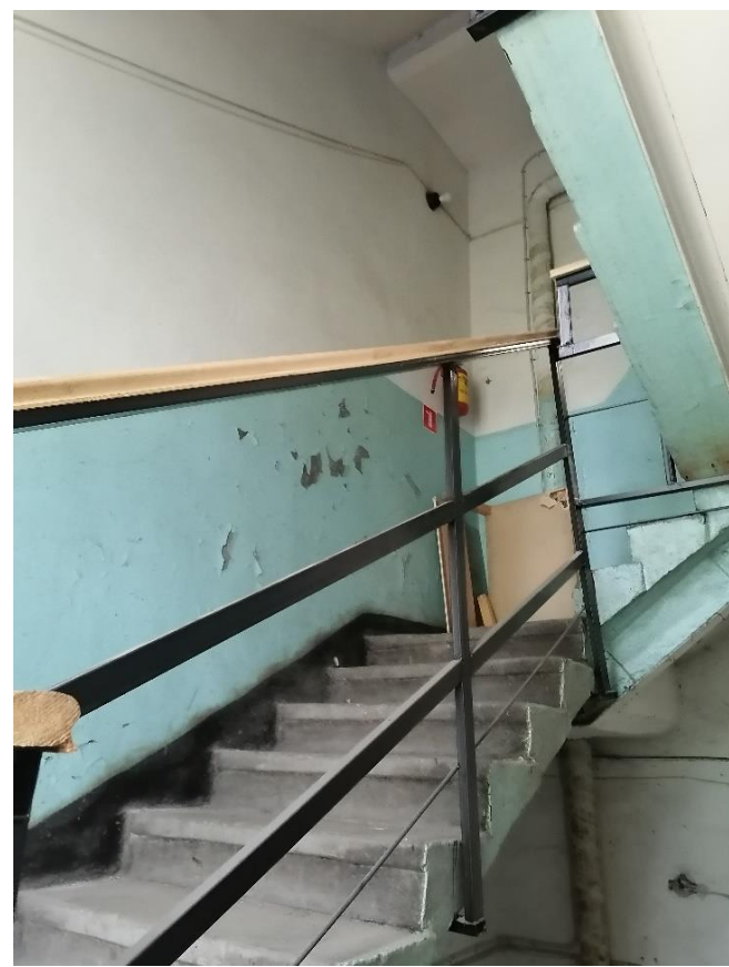
Илл.31. Лестничная клетка в части здания со стороны Полюстровского проспекта. Лестничный марш. 05.07.2021г.
