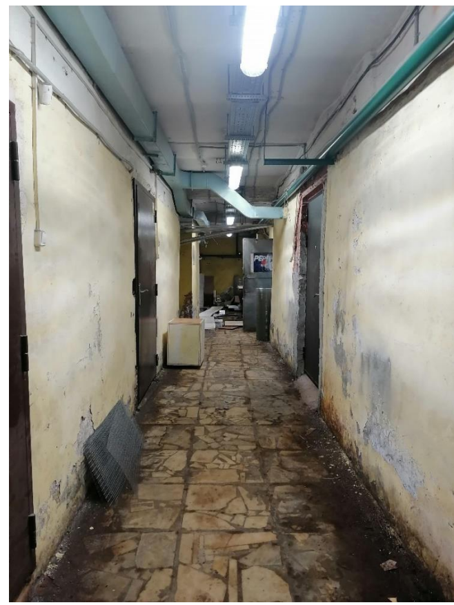
Илл.49. Подвал. Коридор (помещение №14) в части здания со стороны Кондратьевского проспекта. 05.07.2021г.
