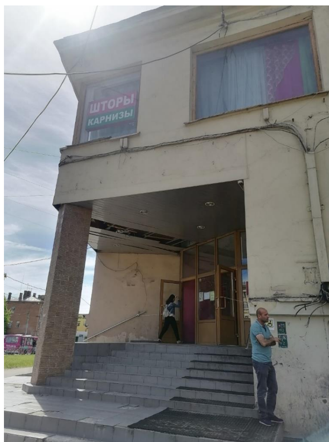
Илл.3. Фрагмент углового фасада здания Калининского универмага. 05.07.2021г.
