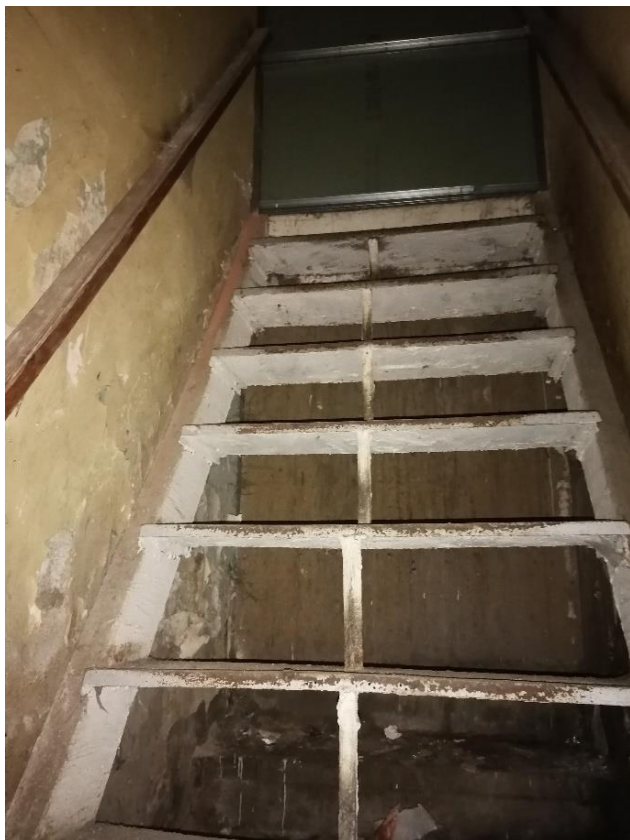
Илл.53. Лестница. Помещение №29. 05.07.2021г.
