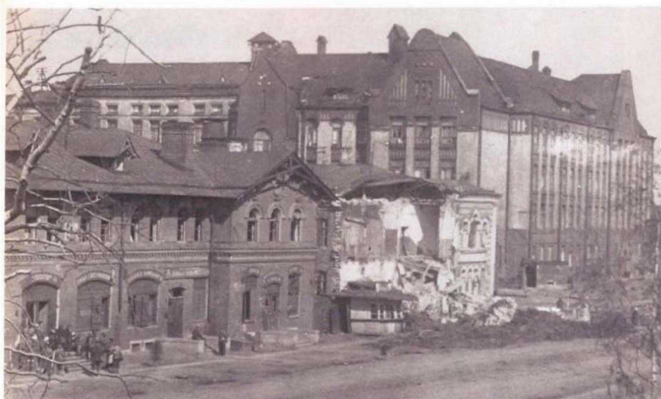
Фото 1942 г. Проспект Обуховской Обороны. Здание технической школы (слева -бывшее здание Общества потребителей, но центру - разрушенное здание бани Обуховского завода)
