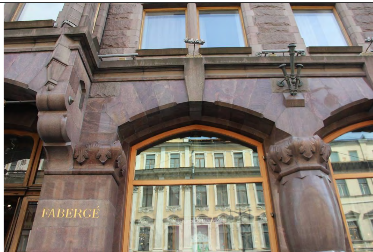
Лицевой фасад. Перемычки витринных окон.
