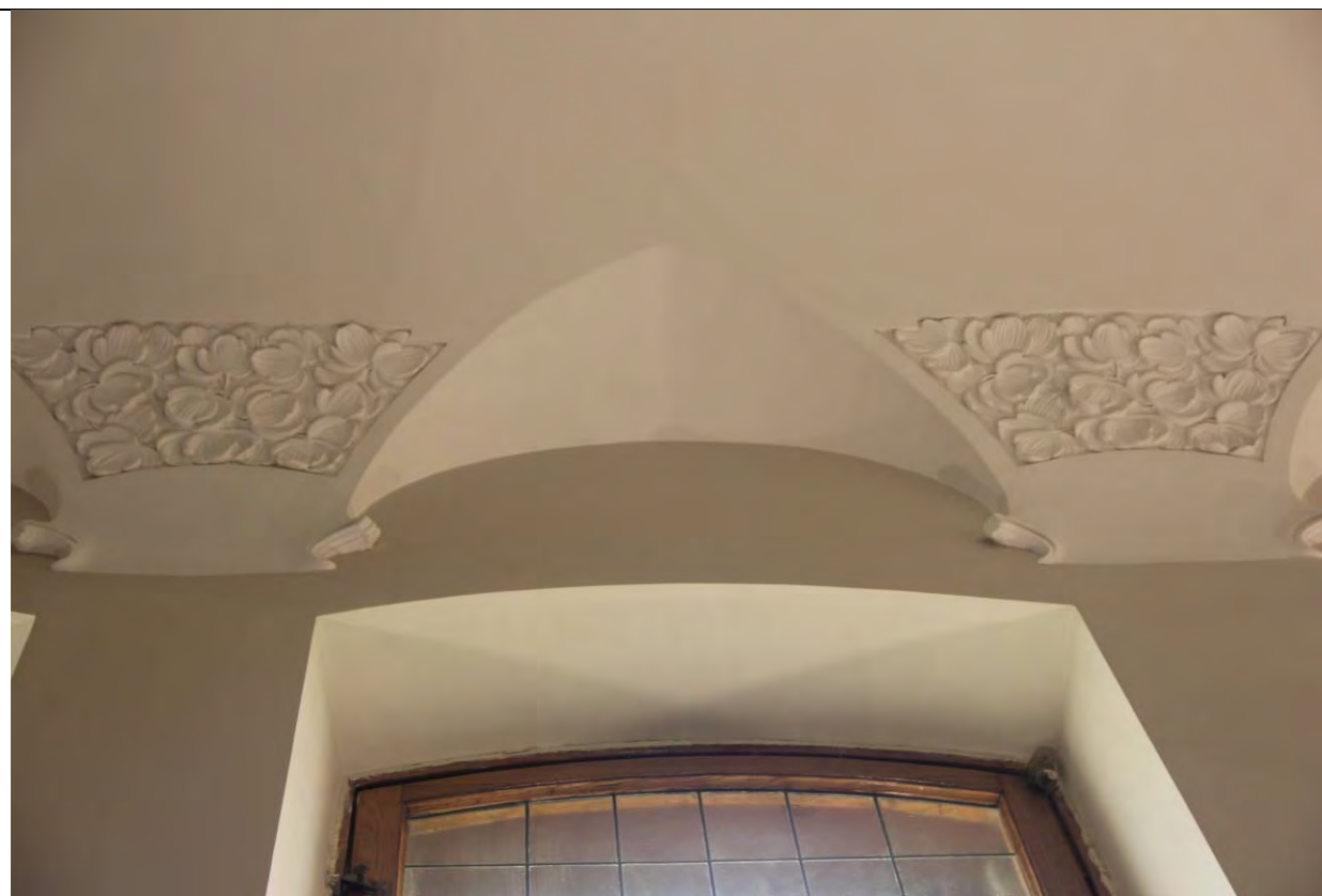
Парадная лестница. Распалубки над оконными проемами верхнего этажа. Лепной декор простенков.
