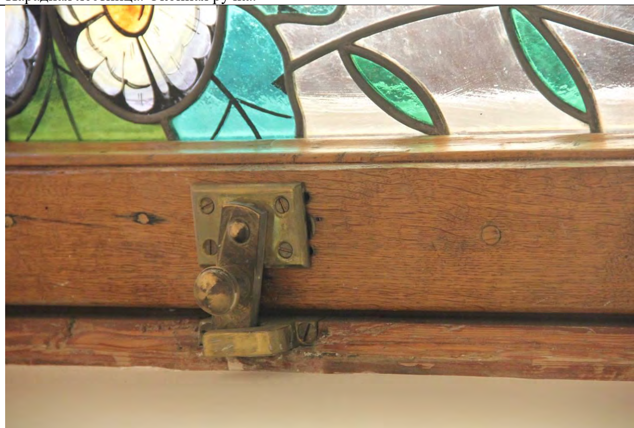
Парадная лестница. Оконная защелка.
