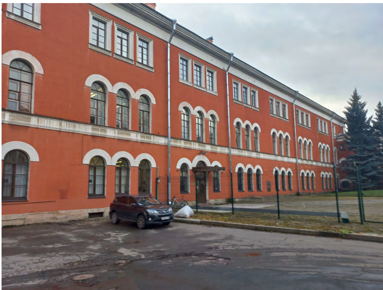
Фото 2. Дворовый фасад. Направление съемки – юго-запад.
