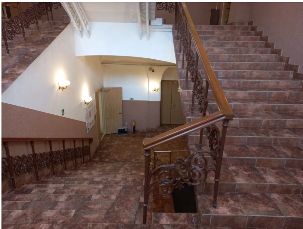
Вид с площадки между первым и вторым этажами.
