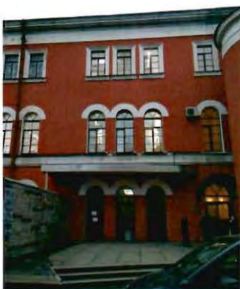
4. Входная группа северного фасада.
