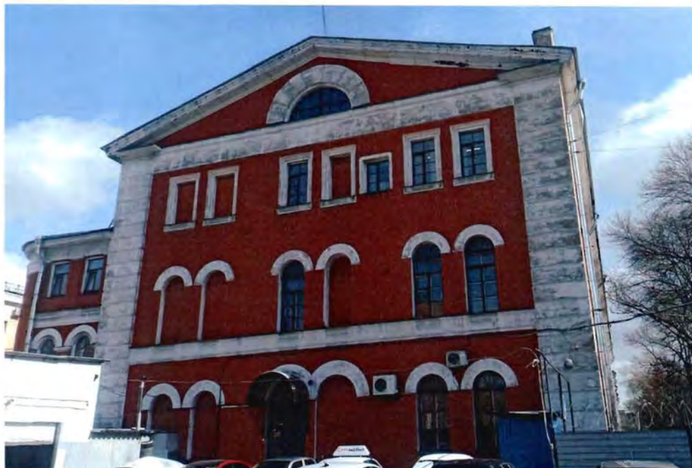
2. Вид на западный фасад объекта культурного наследия.
