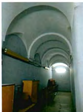
8. Коридор 1-го этажа.
