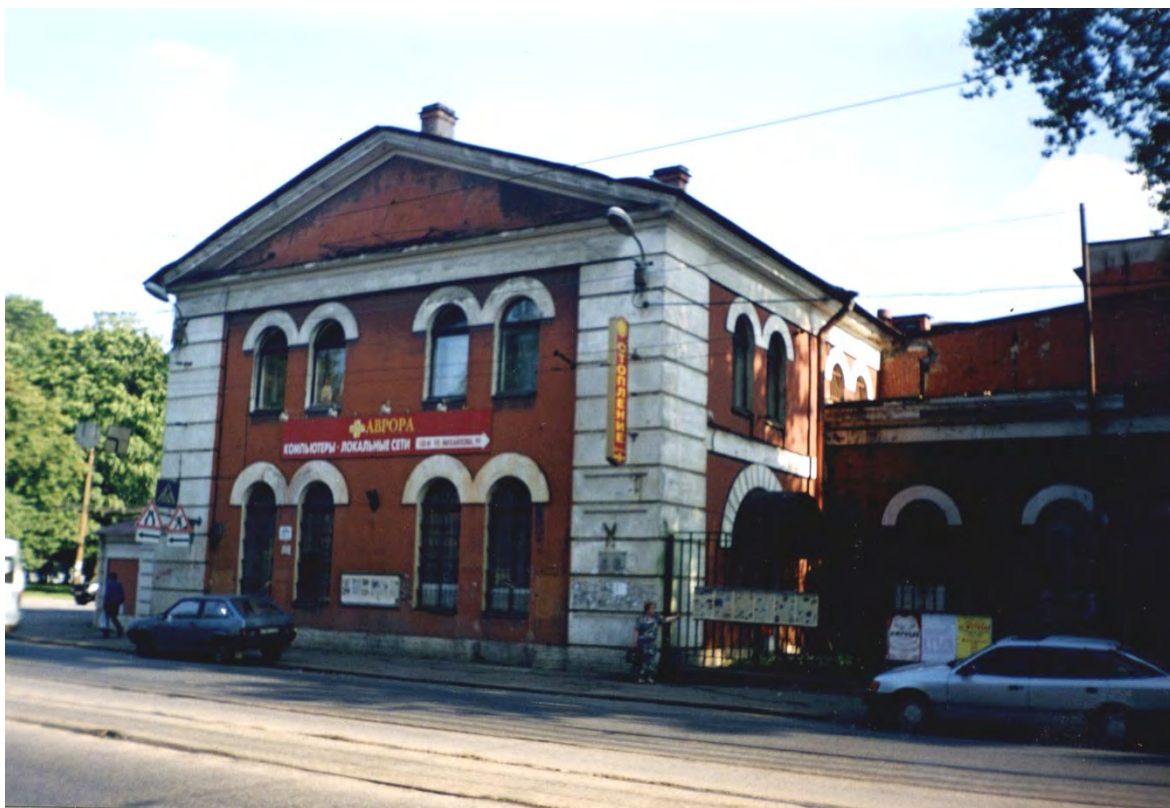
29. Арсенал. Вид с ул. Комсомола. Фото 2008 г. (28).
