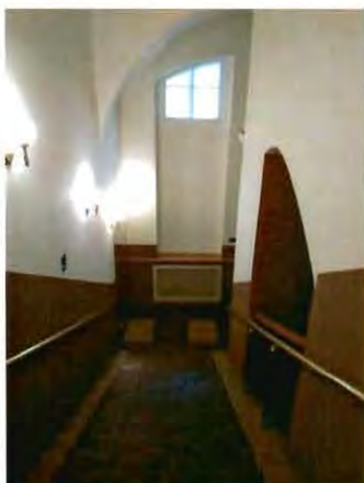
7. Лестница в западной части здания.
