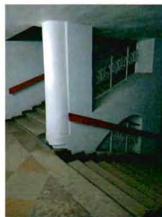
6. Лестница в центральной части здания.
