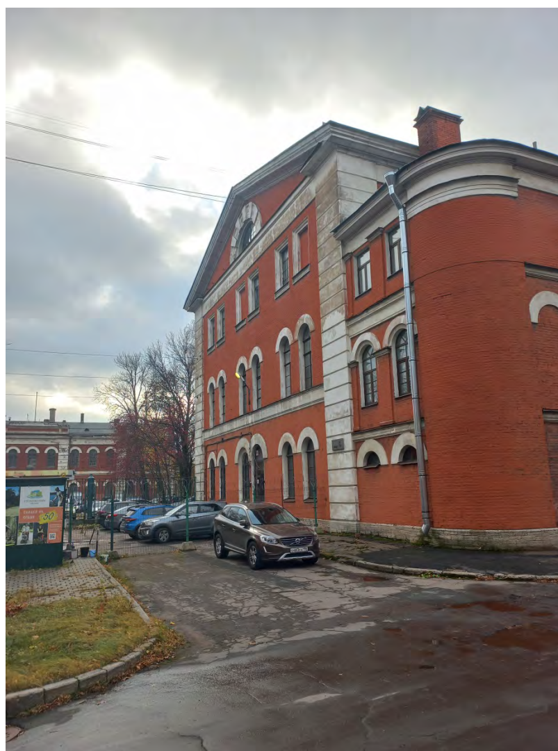
Фото 5. Дворовый и торцевой фасады. Направление съемки – юго-запад.
