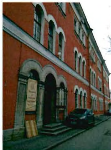
3. Входная группа южного фасада.
