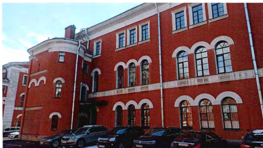
3. Вид на северный фасад объекта культурного наследия.
